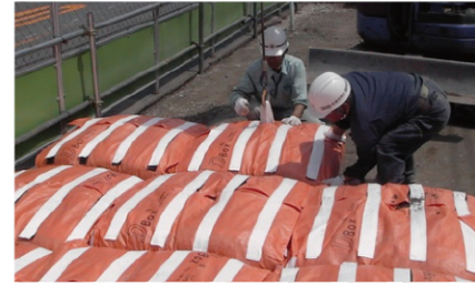
④ 敷設箇所までコンボで運搬し、設置する
