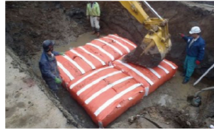
⑤ 敷設箇所にてコンボで加圧し地盤内に入らせる
