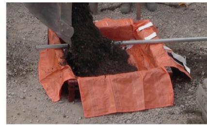
① D・Boxを専用枠にセットし、上部より中詰め材を投入する
