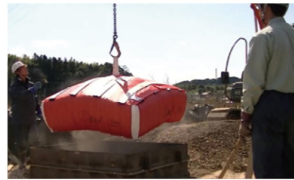
③ 製作後、コンボで吊り上げD・Boxを専用枠から外す
