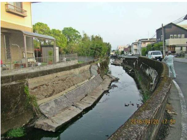
写真 4.3.47 妙見川左岸護岸の崩壊
