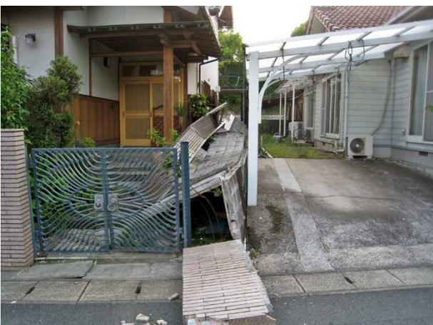
写真 4.4.36 ブロック塀の倒壊
