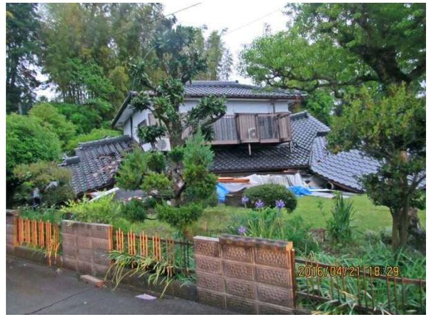
写真 4.4.23 瓦屋根 2 階建て家屋の倒壊
