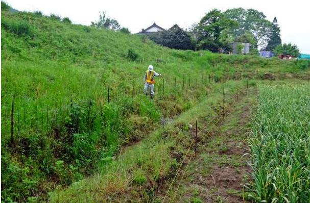
写真 4.6.26 法尻部の漏水（尾村ため池）
