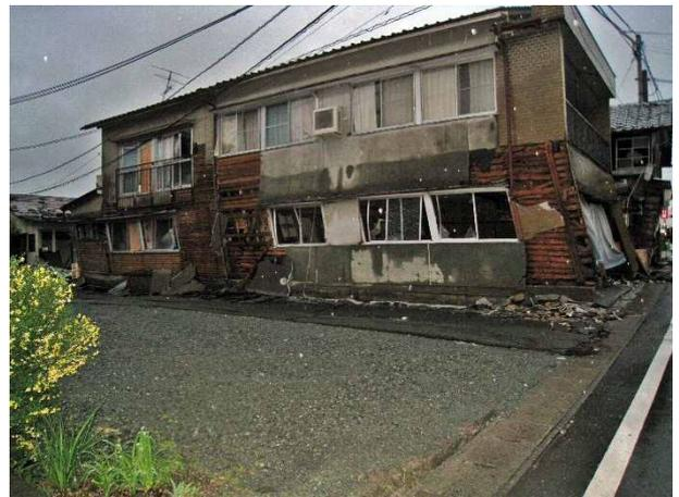
写真 4.4.27 2階建て建物の1階部分のせん断変形
