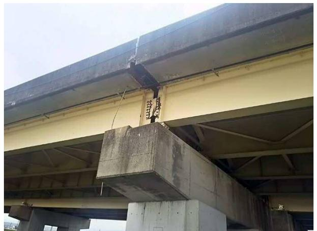
写真 4.1.76 落橋防止連結板の変状
