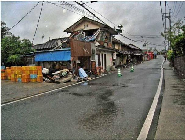
写真 4.4.26 2階建て建物の2階部分の変形
