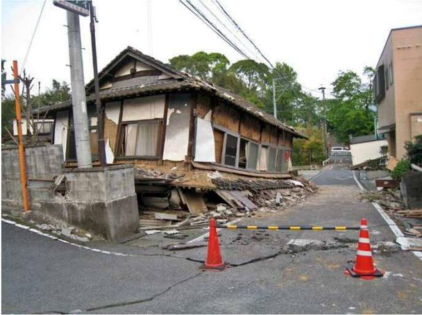
写真 4.4.6 1階が倒壊し2階だけが残った瓦屋根、土壁の古い家屋
