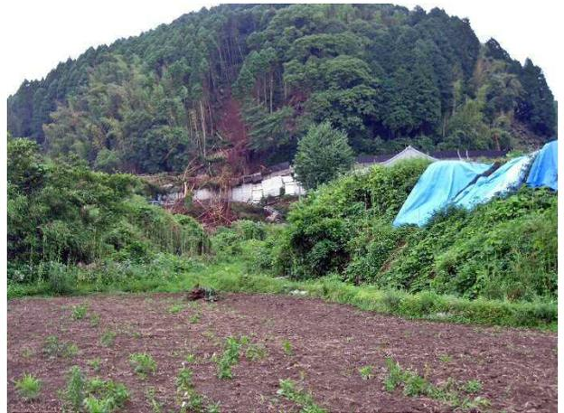
写真 1.4.12 同左 余震によって被害地点上部で斜面崩壊が発生している (地点 B) 6月21日撮影
