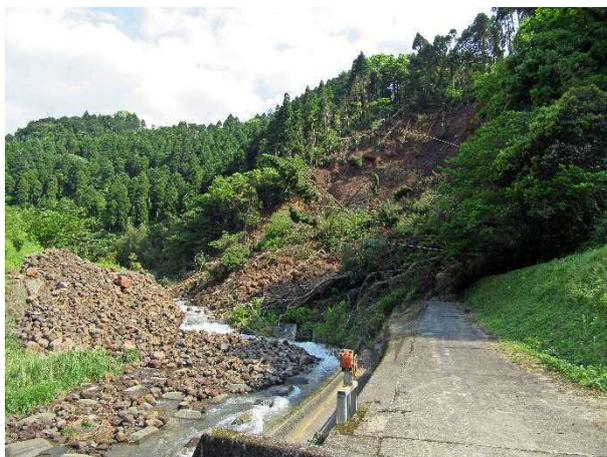
写真 1.4.13 断層近傍の斜面崩壊 (地点 B)
