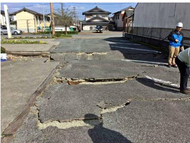
写真 4.7.13 水路と平行に生じた駐車場の地割れ・段差
