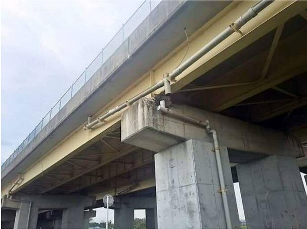
写真 4.1.71 排水管の損傷とずれ
