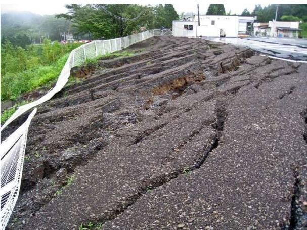
写真 4.5.8 崩壊斜面（黒川左岸）背後の地割れ
