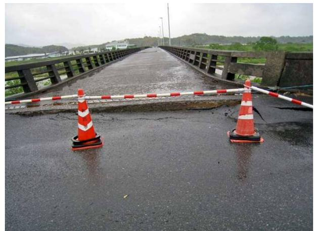
写真 4.1.47 右岸側の橋台背後地盤の沈下
