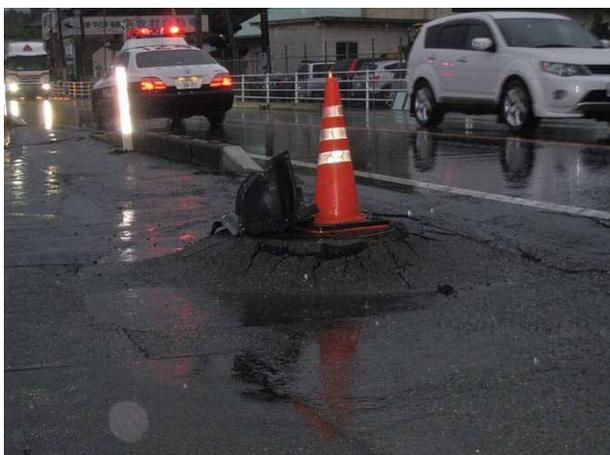
写真 4.7.43 下水道マンホールの浮き上がり
