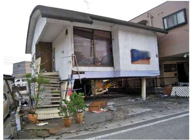
写真 4.4.9 一階のピロティ部分の柱が大きく変形し、倒壊寸前の建物
