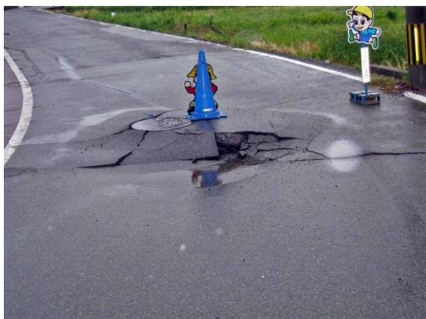
写真 4.7.40 下水道マンホールの浮き上がり
