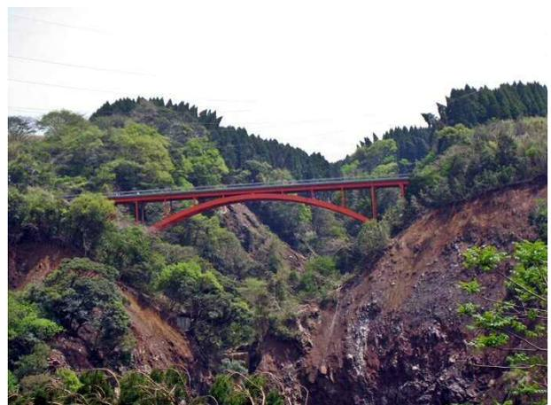
写真 4.5.19 国道 325 号南阿蘇橋兩岸の崩壊（濁川と黒川の合流部）
