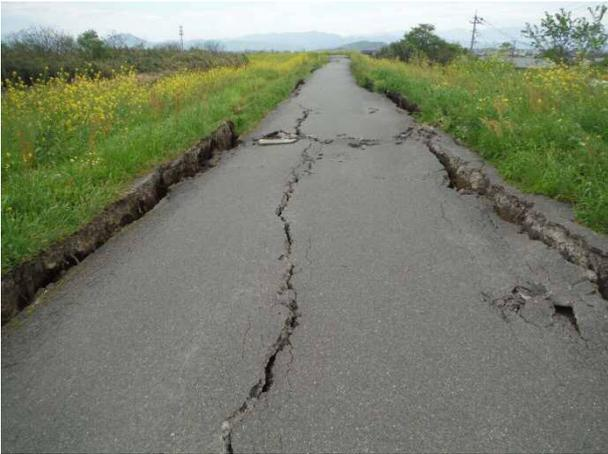
写真 4.3.27 被災⑤天端の沈下
