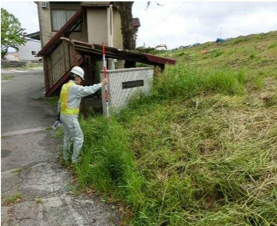
写真 4.3.23 被災③堤内地法尻のはらみ出し
