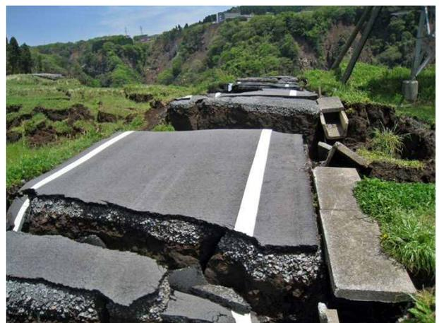
写真 4.5.17 鉄塔近傍の崩壊斜面方向に向かう道路の開口および段差
