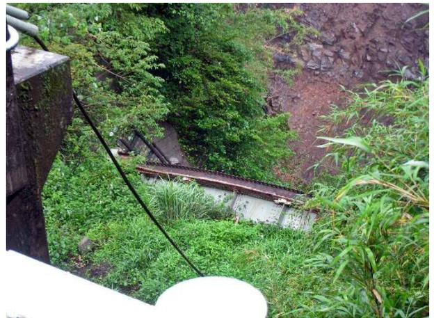
写真 4.1.22 落橋した東側の橋桁
