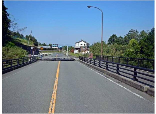
写真 4.1.33 橋桁の水平移動（西側橋台部）
