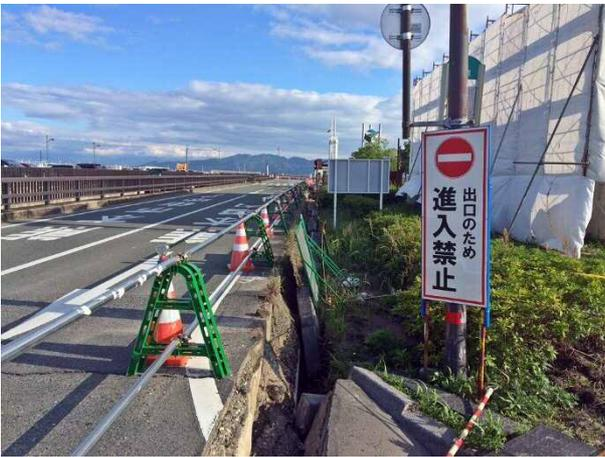
写真 4.2.4 護岸上の道路と背後のフェリーターミナル地盤の境で生じた段差
