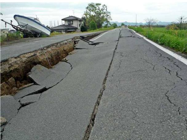
写真 4.3.19 被災②天端に生じた段差
