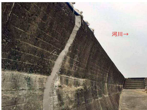
写真 4.3.1 コンクリート護岸に生じた段差
