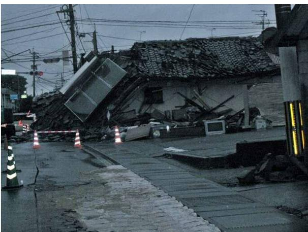
写真 4.4.28 県道 28 号木山交差点南側の 2 階建て建物の倒壊
