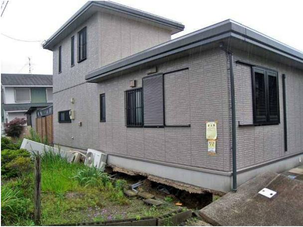
写真 4.7.33 周辺地盤が沈下して基礎が空いた家屋
