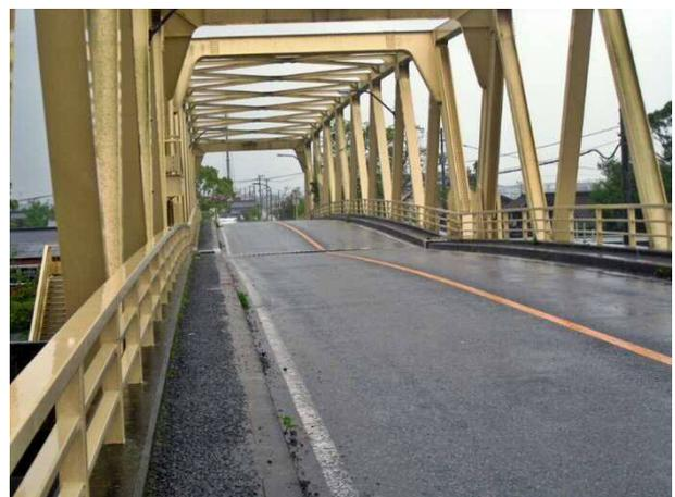
写真 4.1.50 中洲の橋脚上で見られた橋桁の沈下
