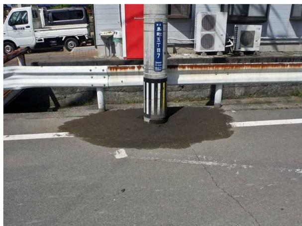
写真 4.7.42 電柱の沈下 (熊本市東区島町)
