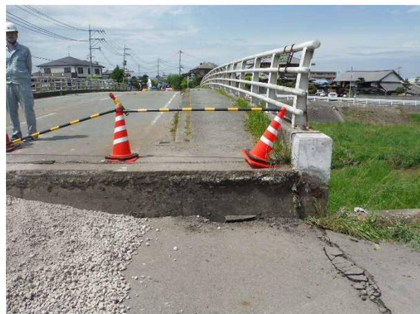
写真 4.3.52 橋台取付部の沈下(秋津川 上沼山津橋)
