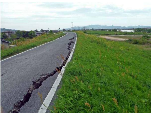
写真 4.3.25 被災④川表側法肩に生じた亀裂
