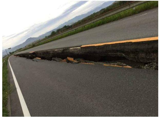
写真 4.3.30 被災④天端に生じた段差
