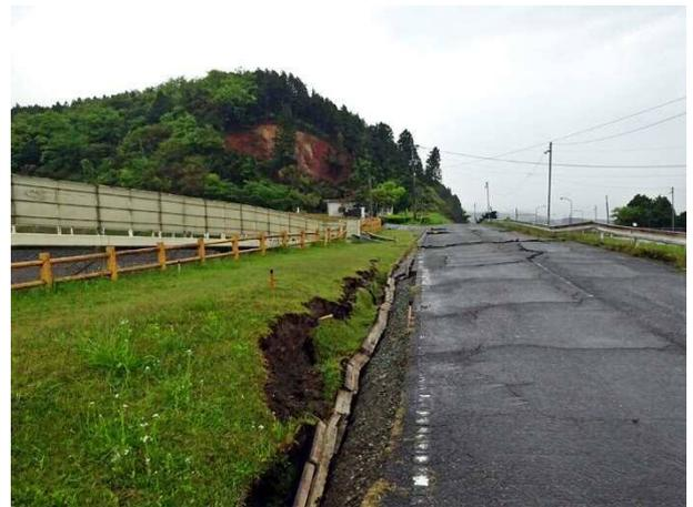
写真4.6.3 堤体天端の縦断クラックと沈下
