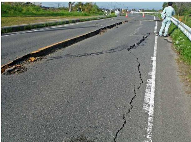
写真 4.3.37 前震後の被災状況
