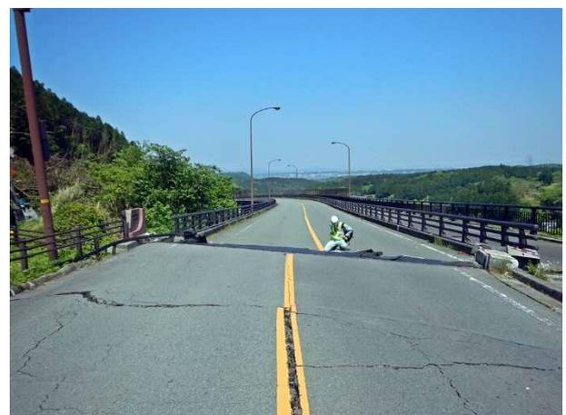
写真 4.1.31 橋桁は北 (右) 方向に移動している (東側橋台部)
