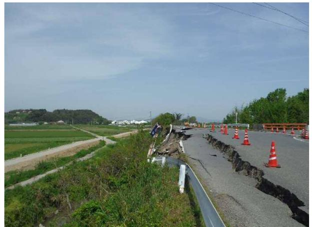
写真 4.3.36 被災⑨前震後の被災状況
