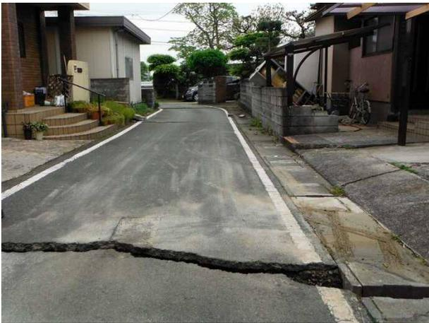
写真 4.7.35 道路に入った横断亀裂と段差
