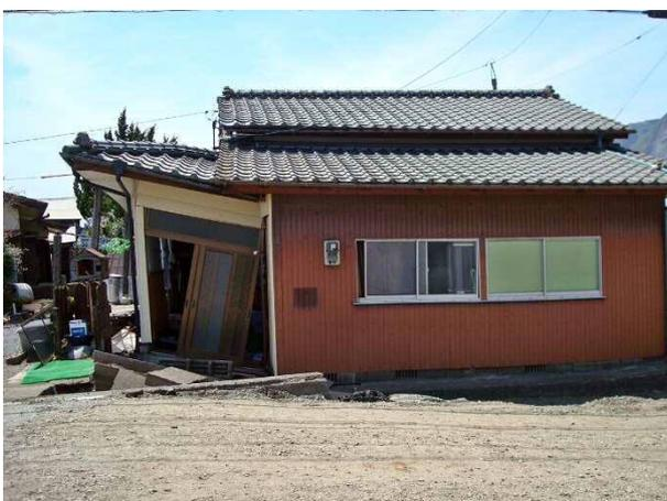
写真 4.5.52 南側の段差によって変形した家屋の玄関
