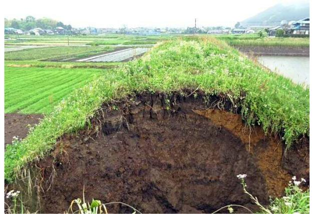
写真 4.6.15 破堤箇所の断面
