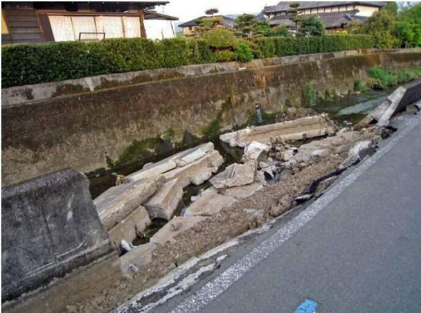
写真 4.3.45 妙見川右岸護岸の崩壊
