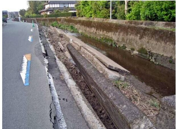
写真 4.3.46 妙見川右岸護岸の崩壊
