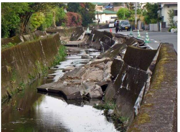
写真 4.3.50 妙見川の調査箇所最奥部からみた右岸護岸の被害状況
