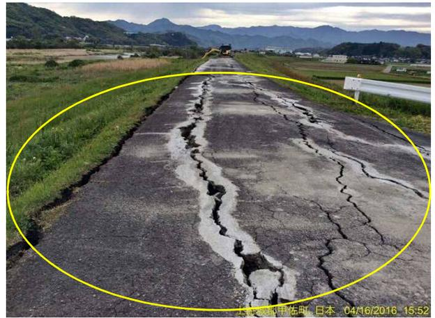
写真 4.3.34 被災⑧本震後の被災状況(クラックが進展)
