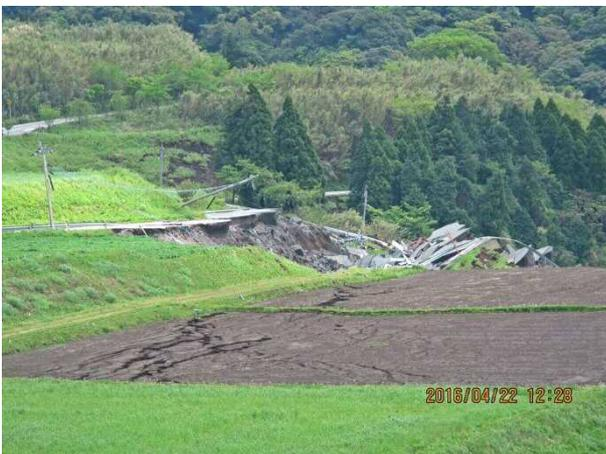
写真 4.5.23 法肩が崩壊した道路
