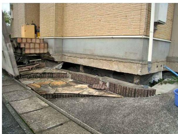
写真 4.7.32 同左近景。基礎となっている鉄管が見えている。
