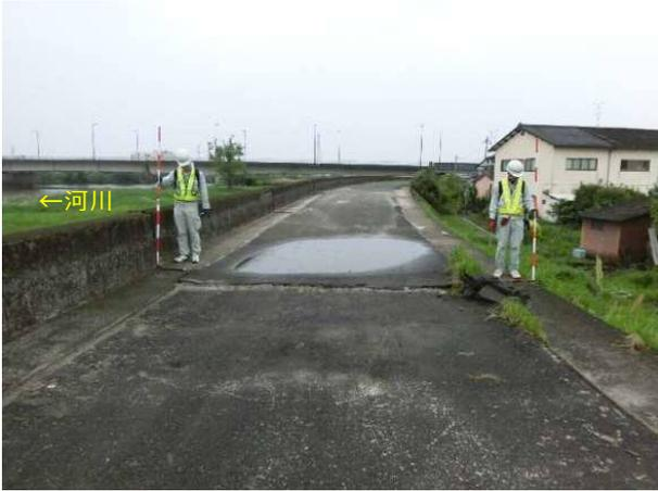
写真 4.3.11 被災②天端に生じた沈下
