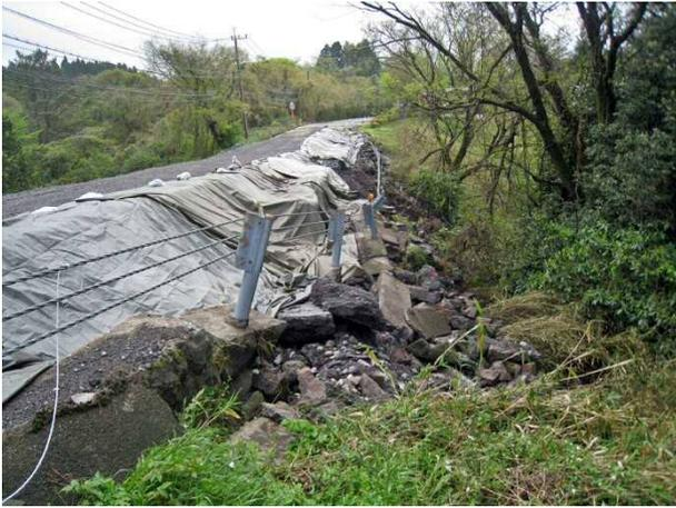
写真 4.1.6 沢部の盛土の崩壊（県道 298 号
