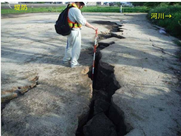
写真 4.3.13 被災③河川近傍の流動亀裂
