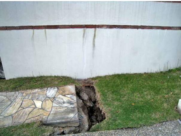
写真 4.4.12 建物周辺の盛土地盤に生じた大きな亀裂
