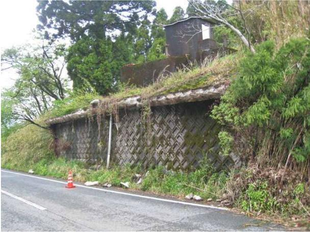
写真 4.1.11 ブロック積擁壁の上部の倒壊
