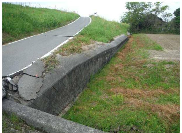
写真 4.3.18 被災②川裏法尻擁壁の傾斜
