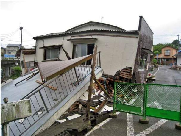
写真 4.4.8 2階部分だけが残った木造家屋。手前は2階建てに連なる平屋部分
