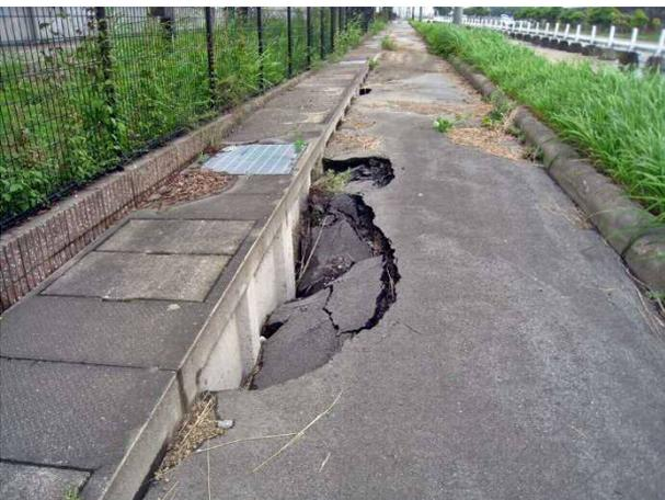
写真 4.2.18 歩道部の陥没
