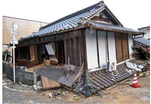
写真 4.4.7 Aゾーンの北角の2階建て家屋で1階部分が倒壊
