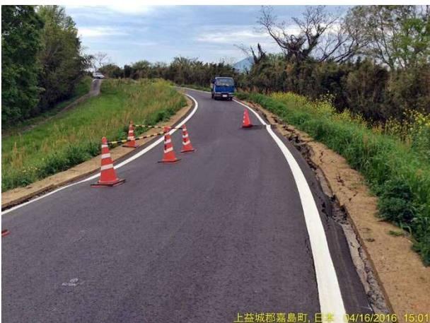
写真 4.3.31 被災⑦天端に生じた沈下
