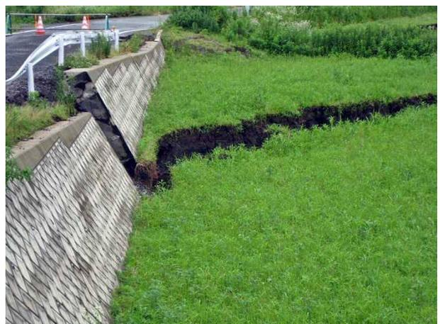
写真 4.5.58 河川堤防取付道路の擁壁と地盤のずれ
