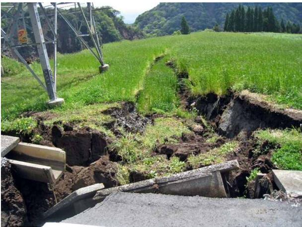
写真 4.5.16 鉄塔背後で崩壊斜面に平行に入った地割れ
