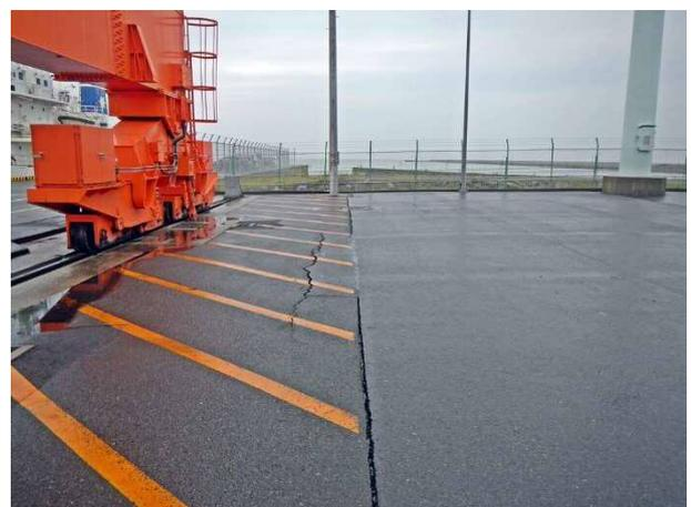
写真 4.2.13 クレーン近傍の路面のクラック (-7.5m 岸壁)
