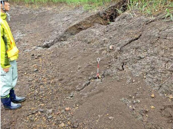
写真 4.6.18 破堤部近傍の横断亀裂
