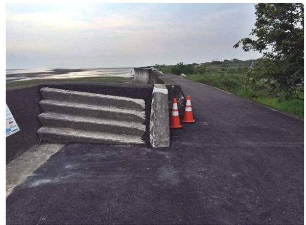
写真 4.3.2 沈下が生じたとみられる階段の補修状況
