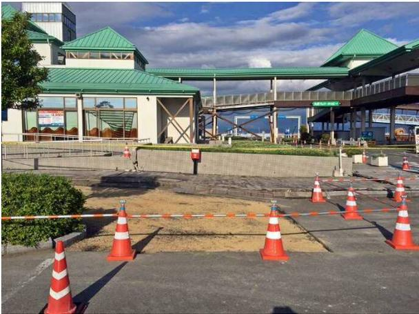
写真 4.2.8 フェリー待合所周辺地盤の沈下
