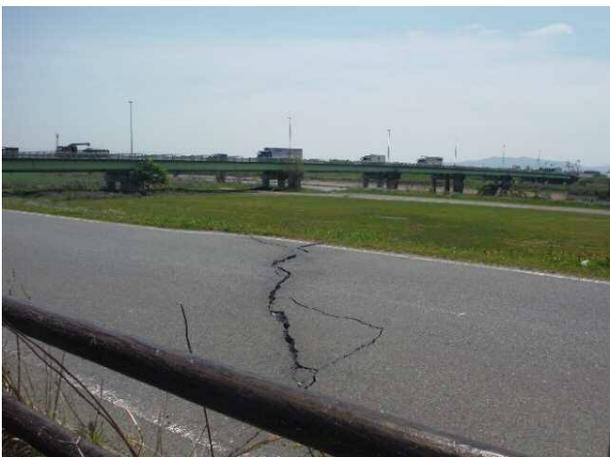
写真 4.3.5 堤防天端に生じた横断亀裂
