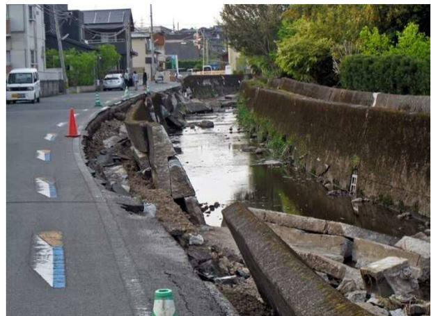
写真 4.3.44 妙見川右岸護岸の崩壊
