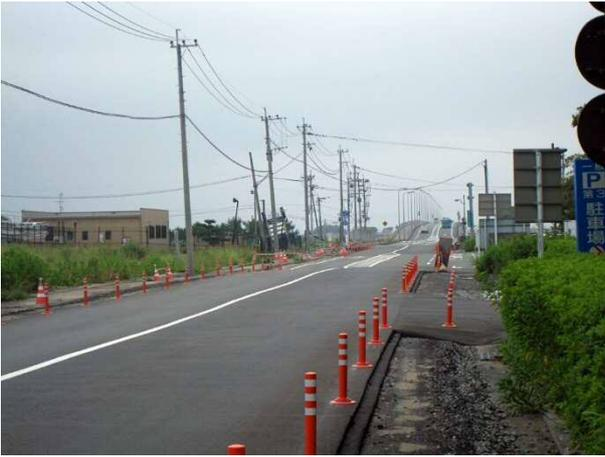
写真 4.2.2 熊本港大橋の背後地盤の沈下
