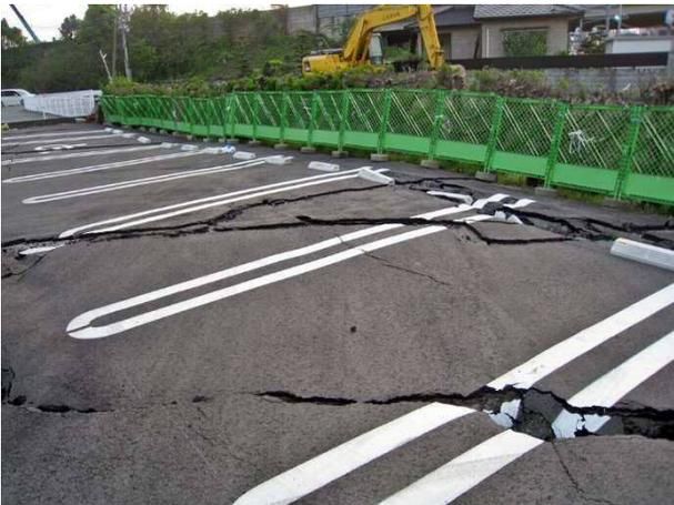
写真 4.4.34 妙見川護岸背後の地盤に現れた亀裂
