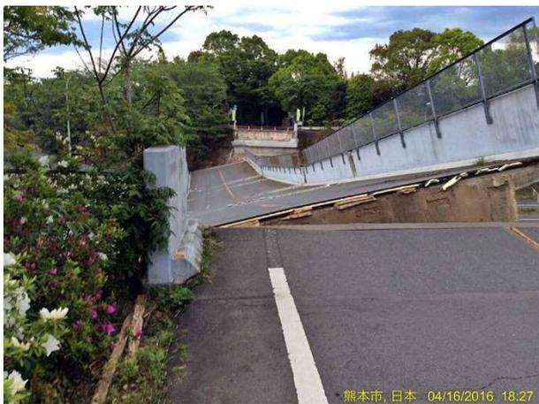
写真 4.1.58 上り線側より見た橋桁落下の様子
