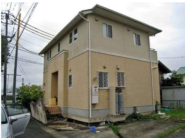
写真 4.7.31 地盤沈下によって基礎が空いた住宅
