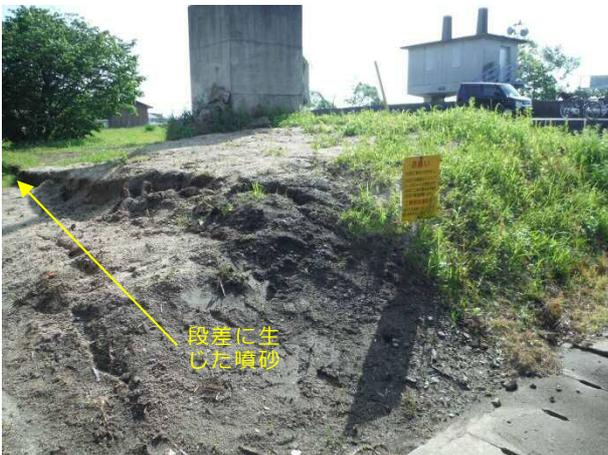
写真 4.3.9 被災①涵管の抜け上がりによる段差と噴砂
