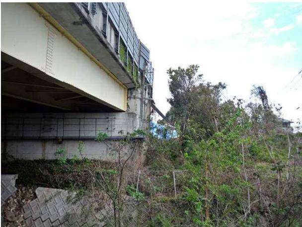
写真 4.1.3 道路法面崩壊部に続く橋台前面のブロック積護岸の被害
