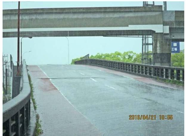
写真 4.1.62 路面に生じた微小な段差。上方は九州新幹線の高架橋
