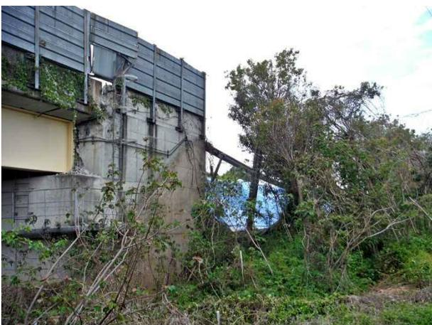
写真 4.1.4 秋津川の橋台に残る盛土の跡
