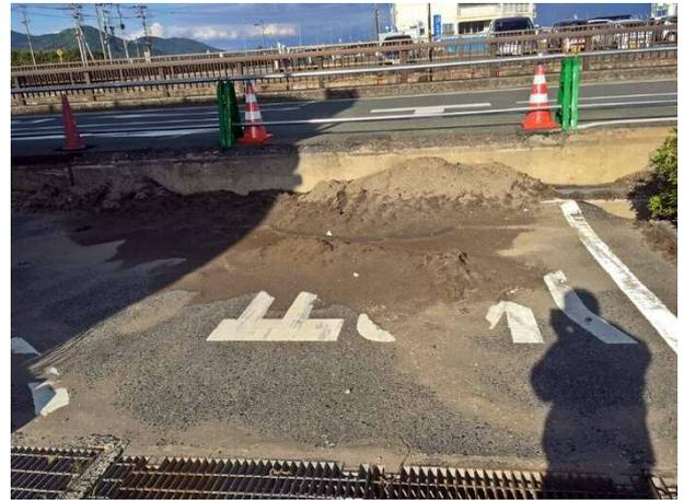
写真 4.2.5 護岸上の道路と直交する道路の境界で生じた大きな段差
