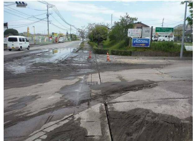
写真 4.7.46 本震（4/16 M7.3）による噴砂
