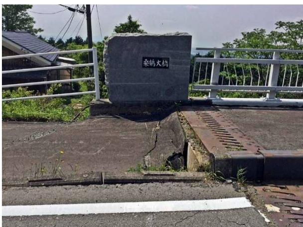
写真 4.1.66 西側橋台背後の小規模な段差
