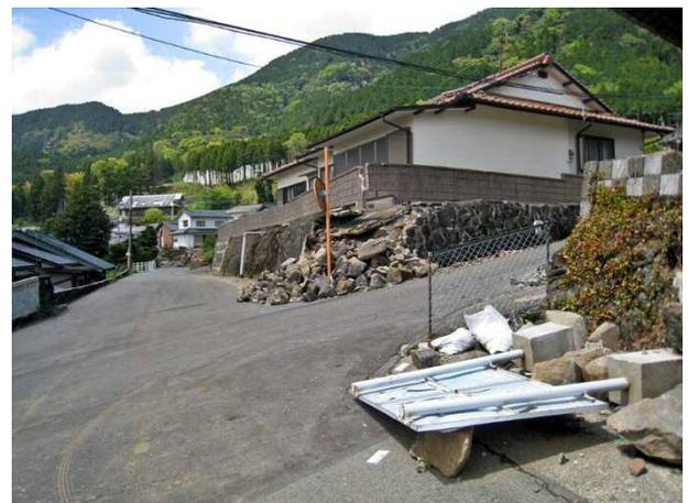
写真 4.4.56 石積擁壁の崩壊（南阿蘇村立野）
