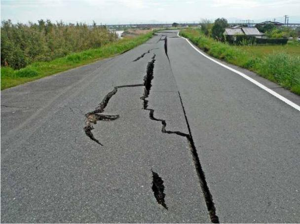
写真 4.3.15 被災①天端に生じた亀裂
