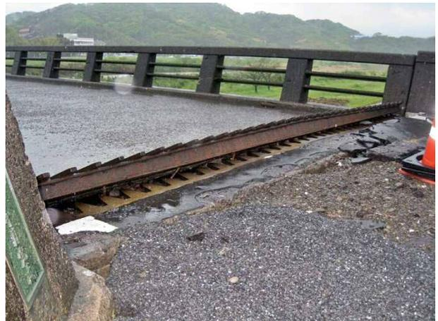
写真 4.1.45 押されるような形で盛り上がった左岸橋台の伸縮装置
