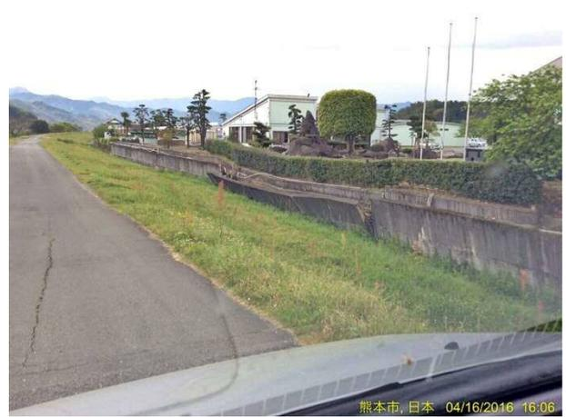
写真 4.4.57 緑川左岸田口橋付近の擁壁の変状
