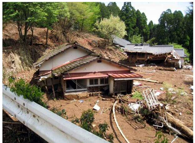
写真 4.5.31 崩壊土砂に埋まった末端部の家屋
