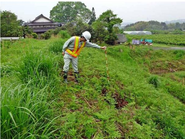
写真 4.6.24 法面の陥没 (尾村ため池)
