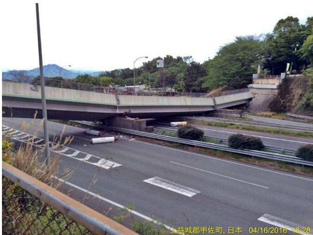
写真 4.1.56 跨道橋の倒壊の状況。支柱が散乱している
