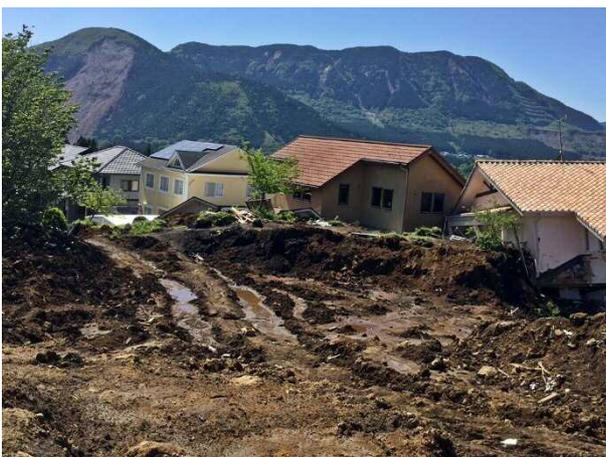
写真 4.5.28 崩壊土砂に襲われた高野台団地の家屋
