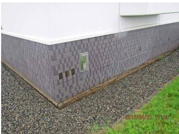
写真 4.7.41 下水道ポンプ場周辺地盤の沈下
