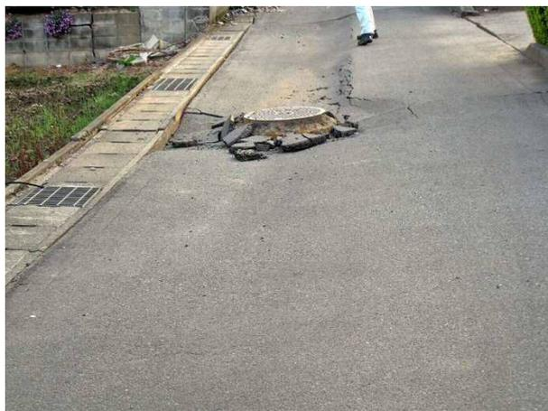
写真 4.7.44 下水道マンホールの浮き上がり
