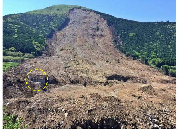
写真 4.1.20 阿蘇大橋東側からみた崩壊斜面。左側に橋脚跡が見える
