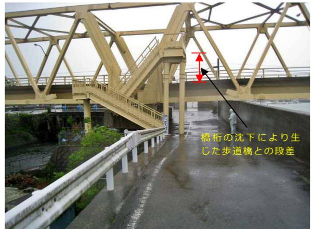
写真 4.1.54 橋桁の沈下のために橋に上がる歩道橋の間に生じた大きな段差
