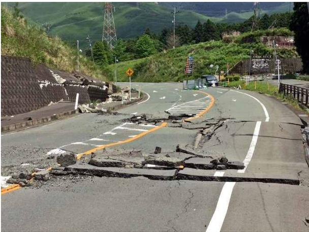
写真 4.6.2 大切畑ダム堤体の断層（右横ずれ）通過部
