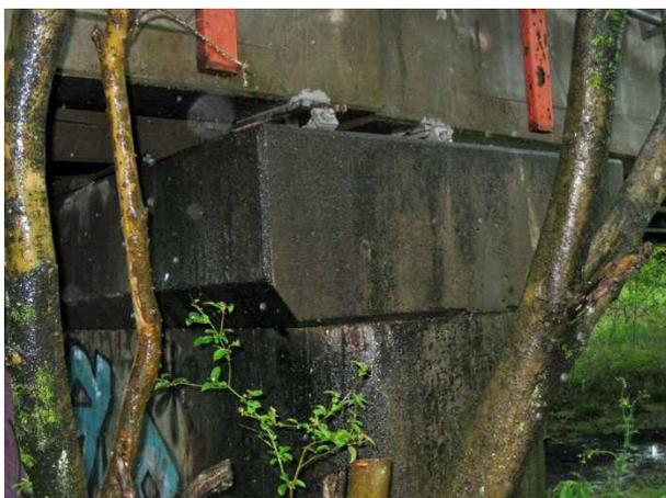
写真 4.1.41 支承の破損
