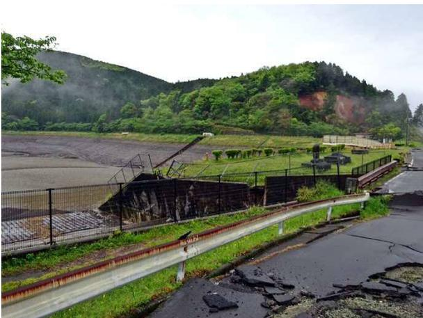
写真4.6.4 洪水吐壁の破損
