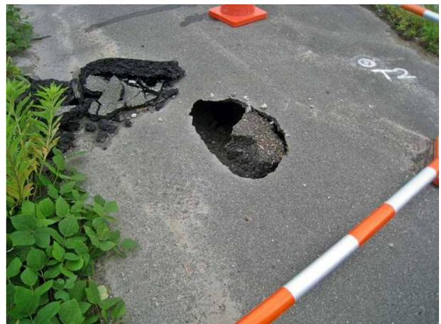
写真 4.2.19 歩道部の陥没
