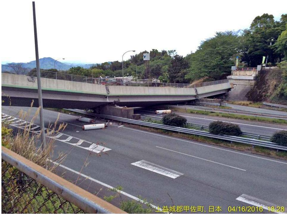
大切畑大橋の橋桁の沈下と水平移動（西原村小森）
