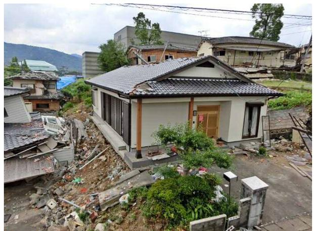
写真 4.4.19 段丘斜面上の平屋家屋基礎盛土の被害
