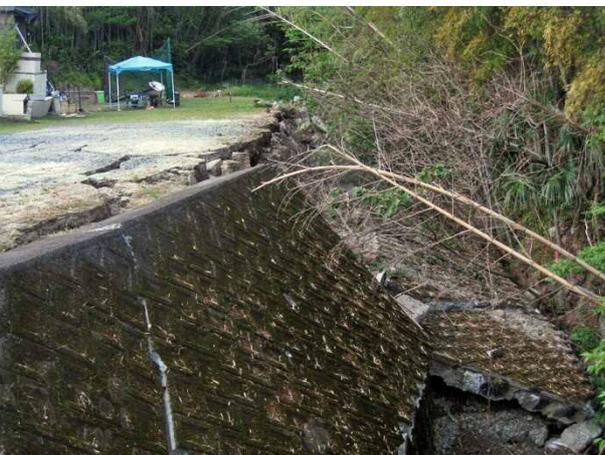
写真 4.4.14 被害建物の 10m ほど東側の河川護岸の崩壊
