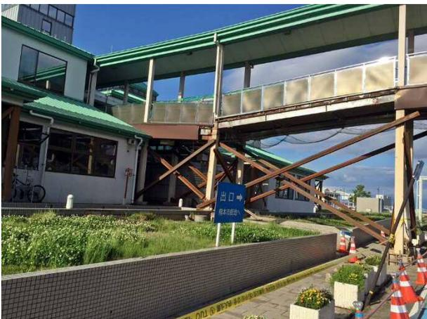
写真 4.2.10 フェリー専用通路の損傷
