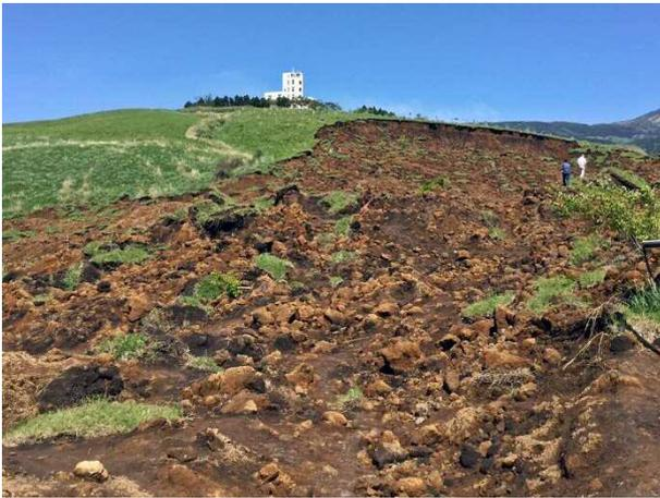
写真 4.5.26 南西斜面の崩壊。山頂の建物は京大火山研究センター
