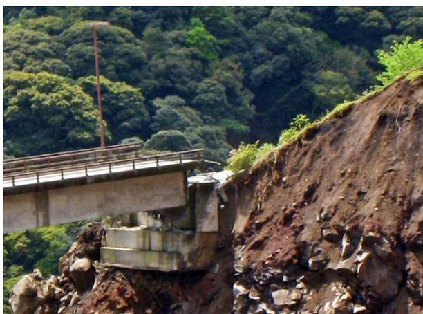
写真 4.1.25 阿蘇長陽大橋西側橋台部の沈下状況
