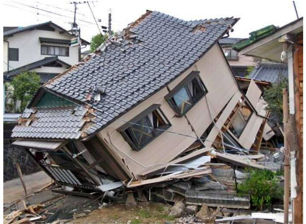
写真 4.4.5 同左 奥の平屋の家屋に増築する形で建てられた 2 階建て家屋が南側に転倒
