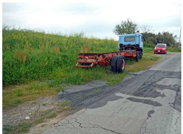
写真 4.3.20 被災②川裏法尻に生じた噴砂
