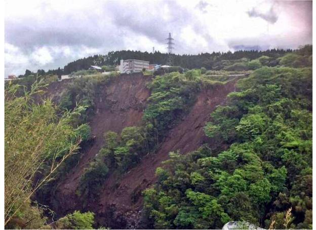
写真 4.5.5 黒川左岸（阿蘇大橋付近）の崩壊状況
