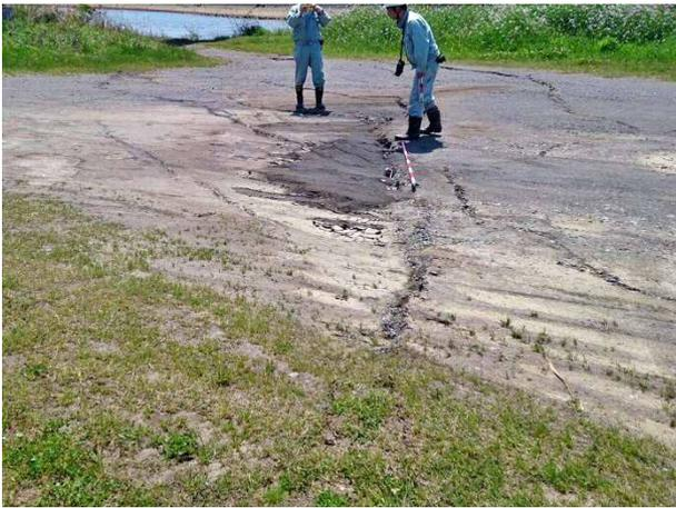
写真 4.3.7 河川近傍の流動亀裂と噴砂
