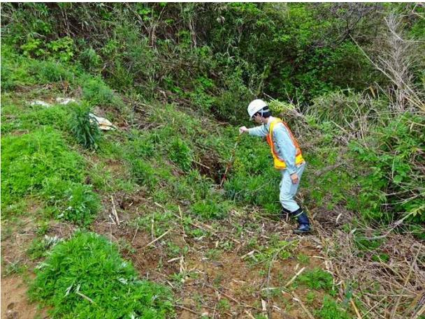
写真 4.6.28 外野第一ため池の陥没孔
