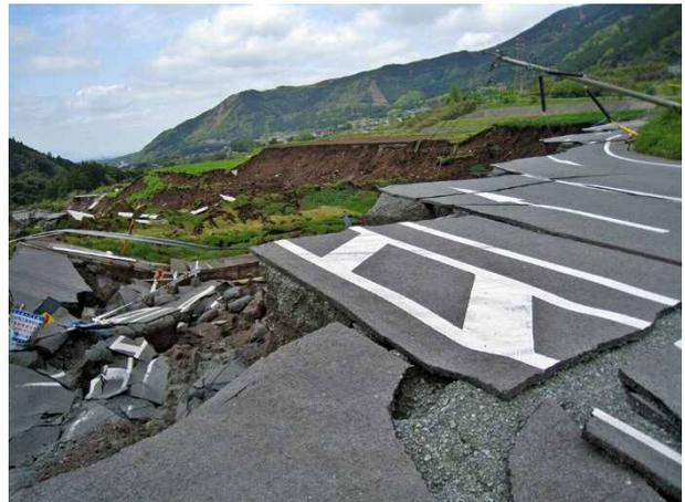
写真 4.5.22 地すべりの崩壊面と崩れた道路
