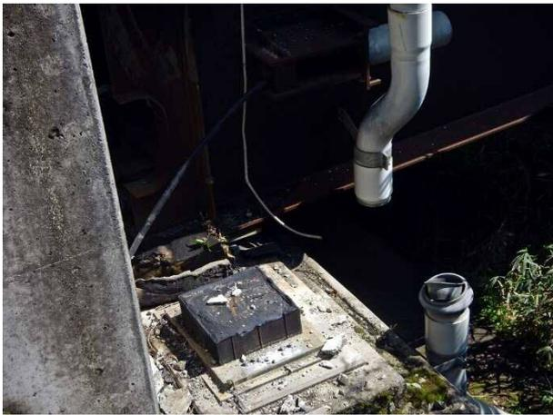
写真 4.1.34 積層ゴム支承の破壊（西側橋台部）
