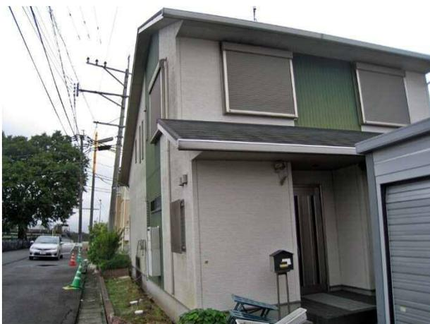
写真 4.7.29 木山川の護岸方向に傾斜した家屋
