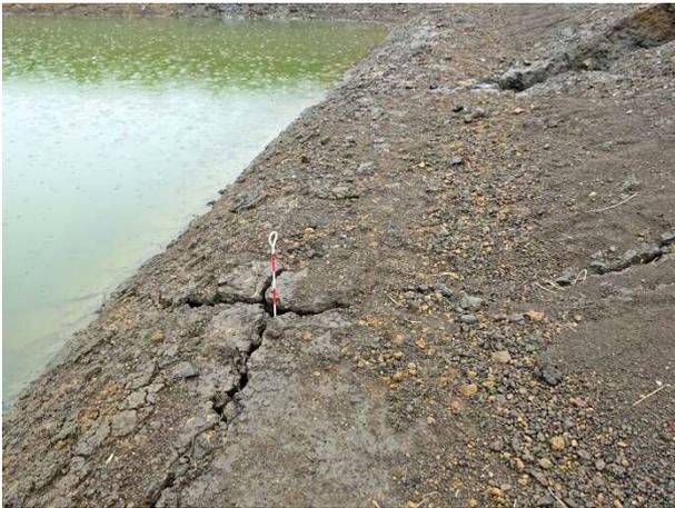
写真 4.6.20 破堤部近傍の縦断亀裂
