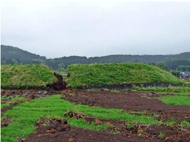
写真 4.6.14 下小森ため池の破堤箇所
