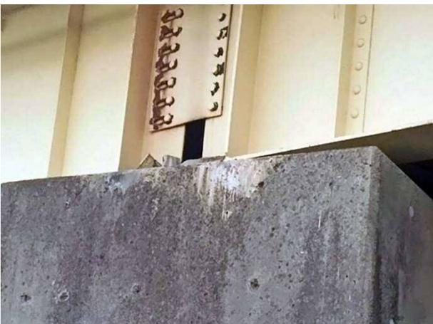
写真 4.1.75 落橋防止連結板に見られる橋桁の軸方向の移動
