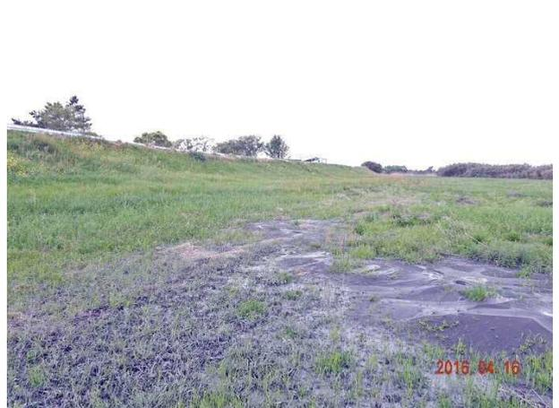
写真 4.3.24 被災③高水敷に生じた噴砂(東京電機大学石川先生提供)
