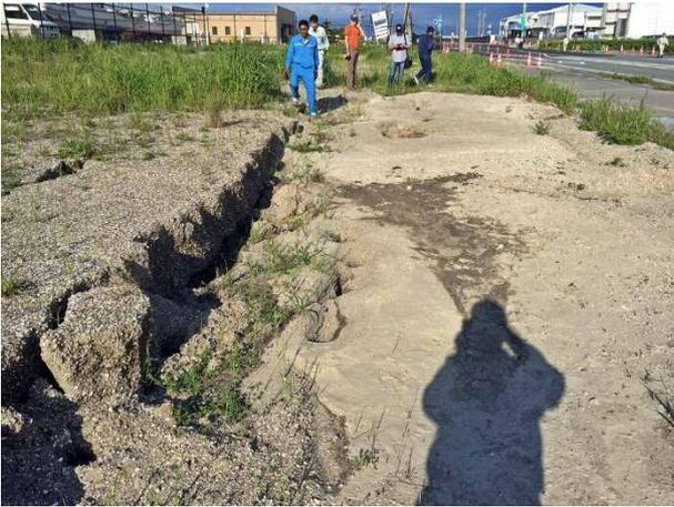
写真 4.2.14 交差点付近で生じた噴砂と亀裂・段差
