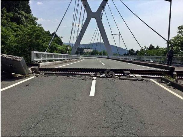
写真 4.1.68 橋梁東端部の水平移動並びに段差
