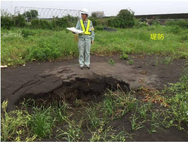
写真 4.3.3 堤内地に生じた大きな噴砂孔
