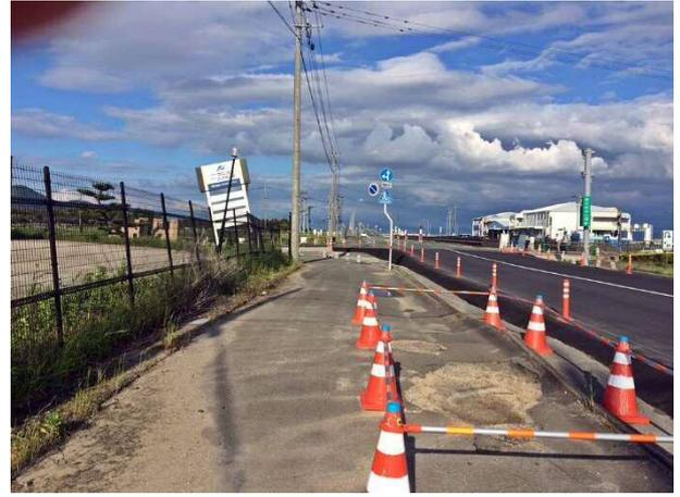
写真 4.2.3 歩道の沈下と案内板の傾斜
