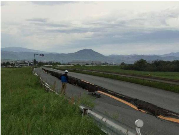
写真 4.3.29 被災⑥川裏側天端の沈下
