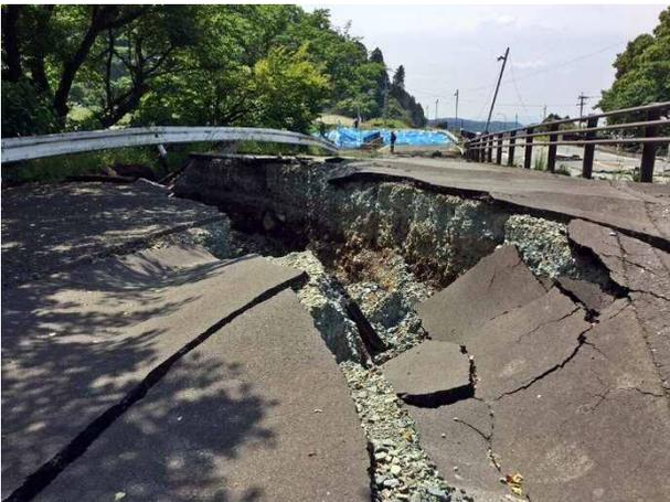
写真 4.6.8 側道に生じた大きな段差
