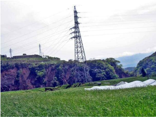
写真 4.5.14 崩壊した崖の突端部にある送電鉄塔
