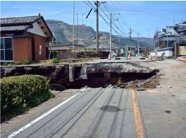
写真 4.5.48 県道 175 号を東西方向に切断した段差（北側）
