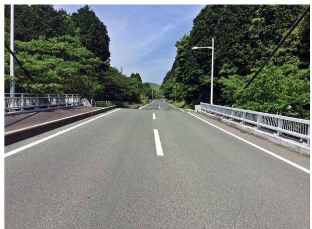
写真 4.1.67 東側橋台付近の状況。道路との段差とセンターラインのずれ
