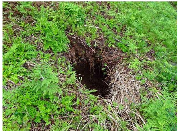
写真 4.6.25 法面の陥没 (尾村ため池)
