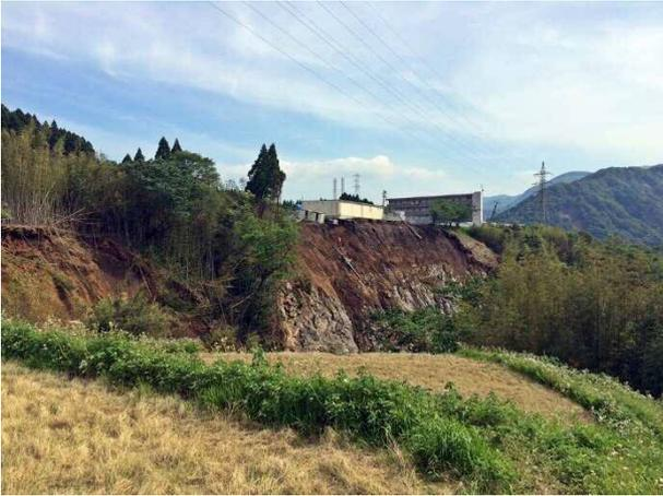
写真 4.5.4 阿蘇大橋近傍の黒川左岸の崩壊
