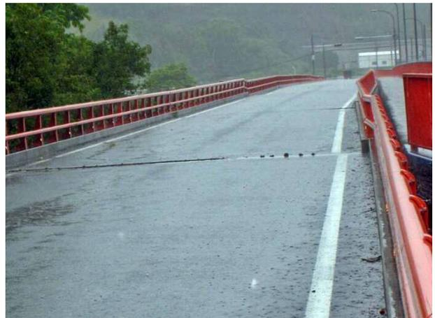
写真 4.1.40 乙女橋路面のずれ
