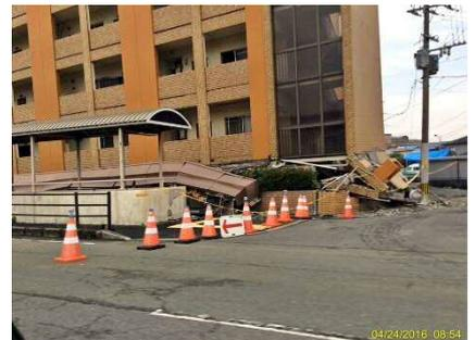
写真 4.4.43 同上層崩壊建築物の状況（左方、正面、右方から撮影）
