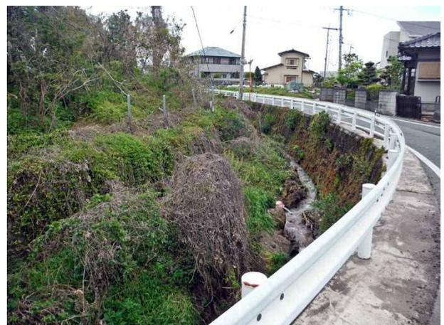
写真 4.1.5 盛土の崩壊・はらみ出しによって狭くなった河道
