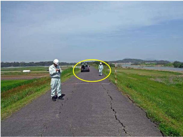
写真 4.3.33 被災⑧前震後の被災状況(天端のクラック)
