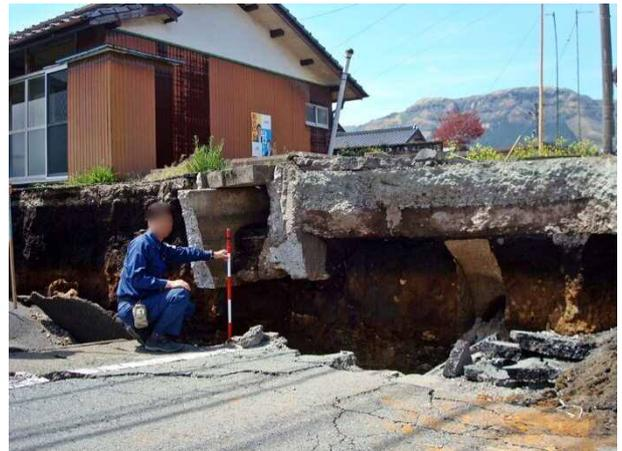
写真 4.5.49 同左 県道近景。鉛直変位量は約 1.5m
