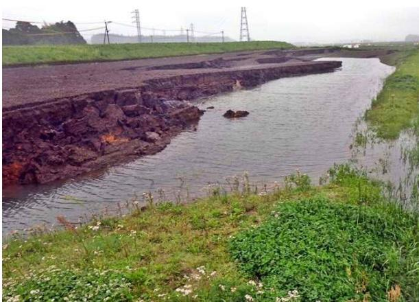
写真 4.5.62 2条の段差による陥没地形
