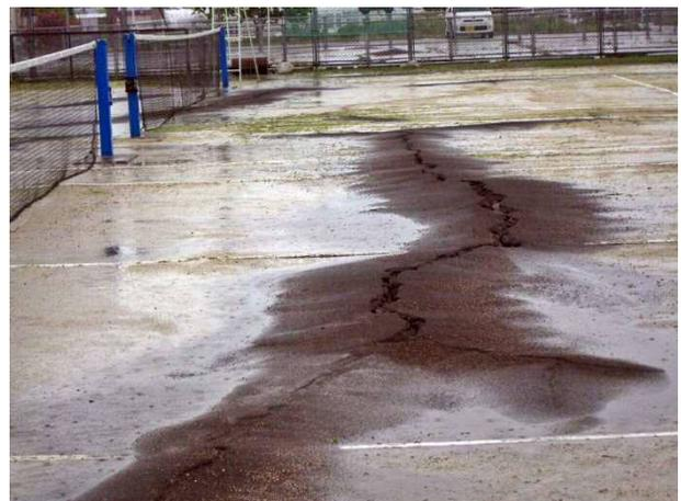
写真 4.7.20 同左 テニスコートの噴砂近景
