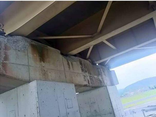
写真 4.1.73 支承の損傷と橋桁のずれ
