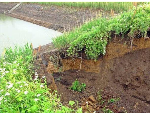
写真 4.6.16 破堤箇所の断面（前刃金構造）
