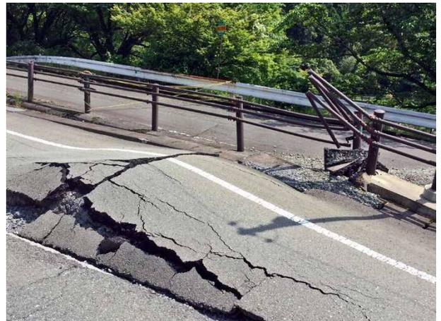
写真 4.6.9 断層通過による道路柵の折れ曲がり
