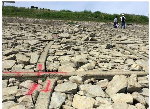
写真 4.6.11 堤体内法の敷石及び法枠の変状
