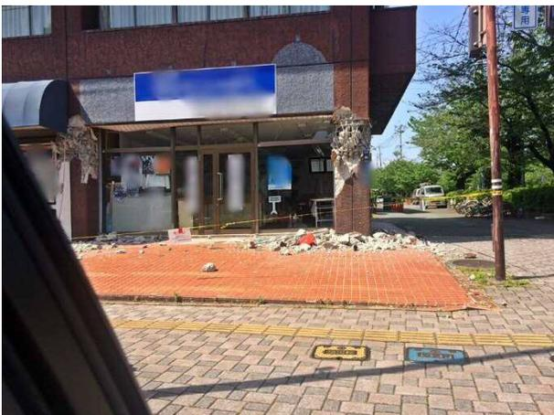
写真 4.4.44 南東側柱が大破した 4 階建て RC 建築物（熊本市東区錦ヶ丘）
