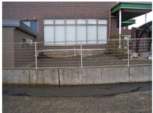
写真 4.7.10 同左近景 盛土と周辺地盤が大きく沈下している
