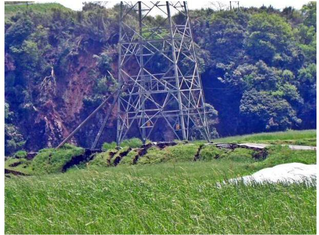
写真 4.5.15 同左近景。鉄塔の根元に地割れが見える
