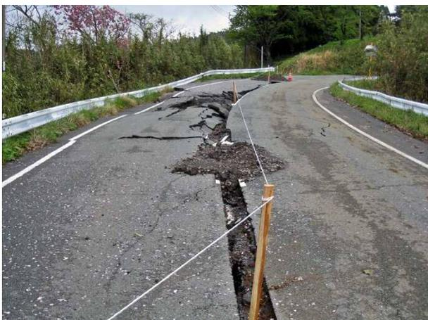
写真 4.1.9 道路センターラインの亀裂・開口
