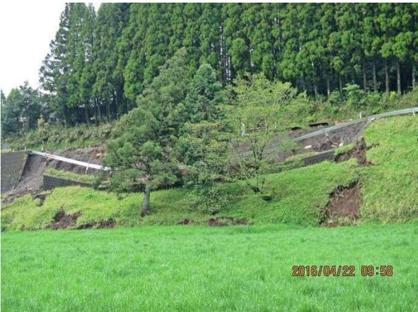
写真 4.1.13 腹付盛土道路の崩壊 (南阿蘇村
