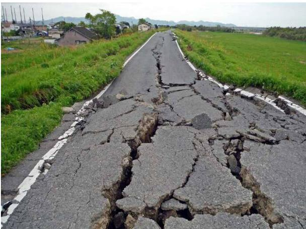
写真 4.3.17 被災②天端の崩壊
