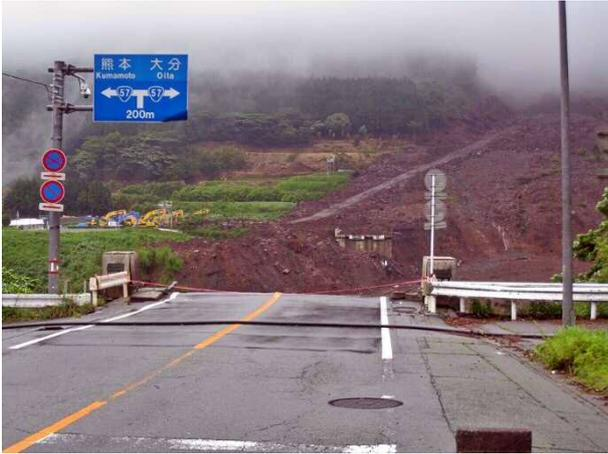
写真 4.1.19 阿蘇大橋の落橋によって寸断された国道 325 号
