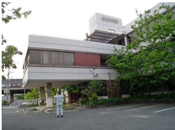
写真 4.4.30 病院のピロティ柱の損傷
