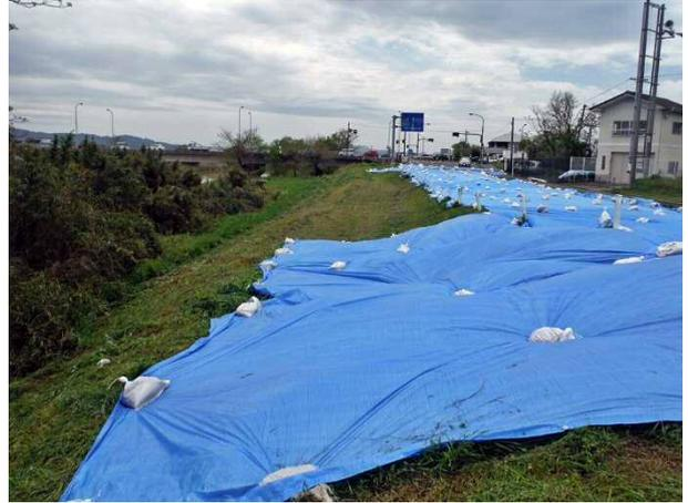
写真 4.3.40 本震後の被災状況(川表側へのすべりが進展)
