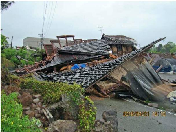
写真 4.4.22 瓦屋根・土壁の古い家屋の倒壊
