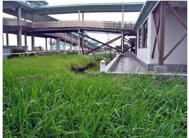
写真 4.2.9 フェリー待合室裏手の盛土の陥没
