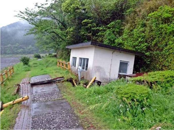
写真4.6.6 左岸法面の変位と操作小屋の傾斜
