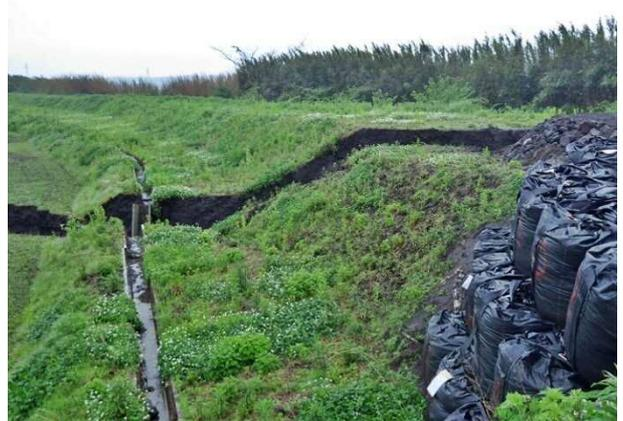
写真 4.5.56 乙姫川堤防を横切る段差
