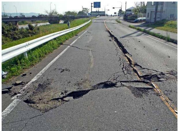
写真 4.3.38 前震後の被災状況（川表へのすべり）
