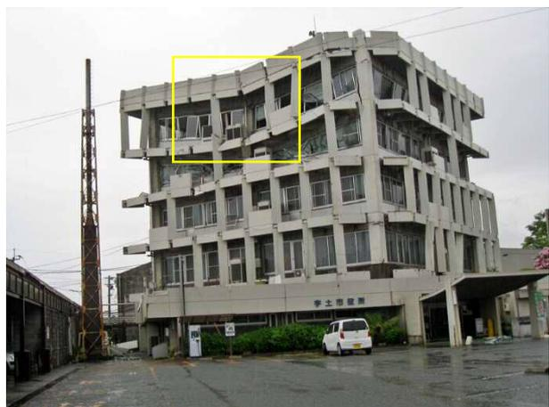
写真 4.4.38 宇土市庁舎南西側の被害状況
