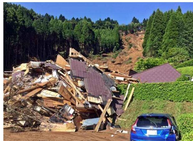
写真4.5.45 背後斜面の崩壊によって破壊した建物の残骸
