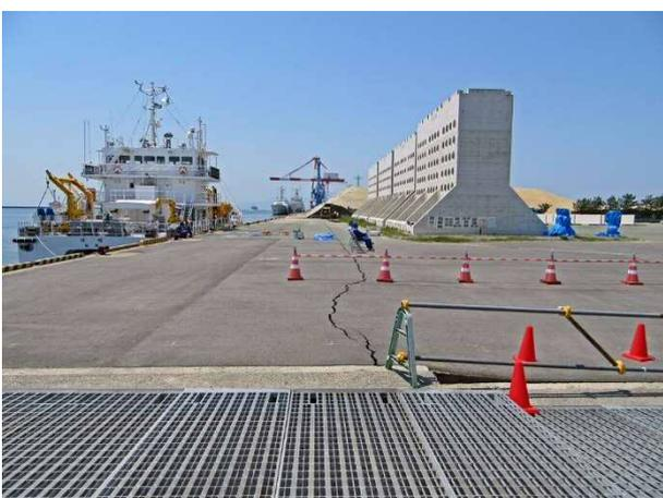
写真 4.2.12 岸壁背後のクラック (-4.5m 岸壁)
