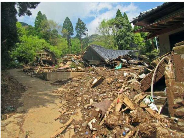
写真 4.5.32 崩壊土に破壊された家屋
