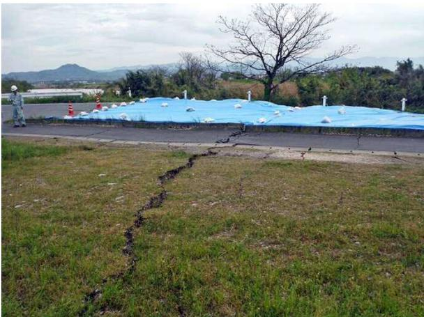
写真 4.3.41 本震後の被災状況。堤防横断方向の亀裂
