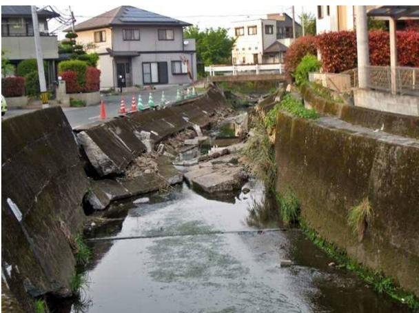
写真 4.3.49 妙見川右岸護岸（調査最奥部）の崩壊
