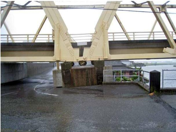
写真 4.1.51 中洲の橋脚の沈下
