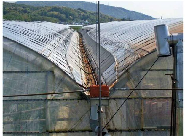
写真 1.4.5 直下を通った断層のため変形したビニールハウス(益城町下陳)
