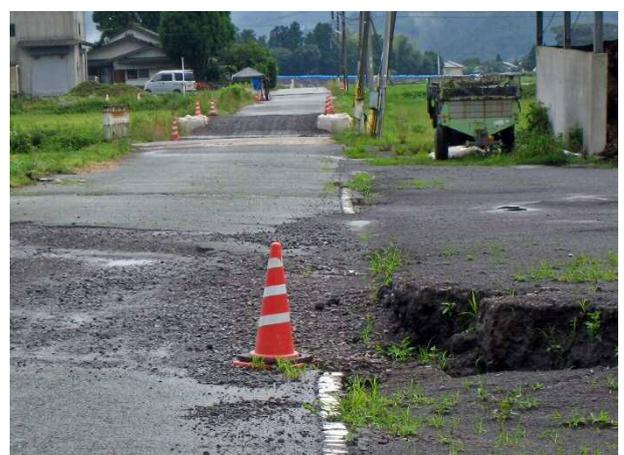
写真 4.5.53 近傍で見られた道路の横ずれ変位。白線が若干ずれている
