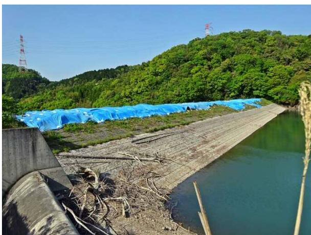
写真 4.6.22 鎧ヶ鼻下池の縦断亀裂
