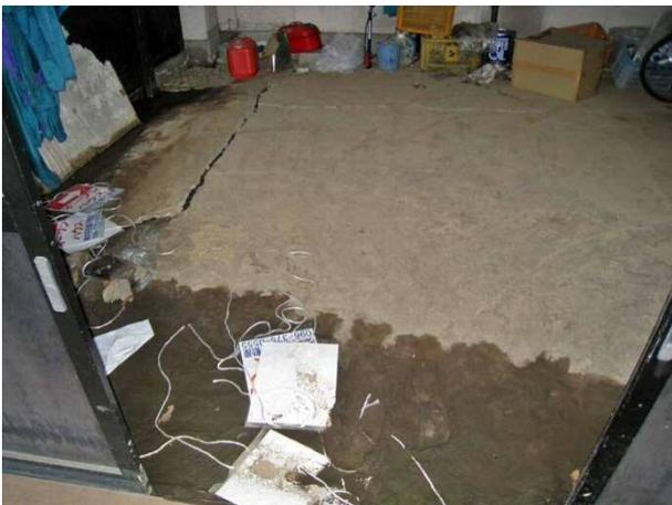
写真 4.7.3 めり込み沈下した建物の1階床の亀裂と噴砂（刈草）
