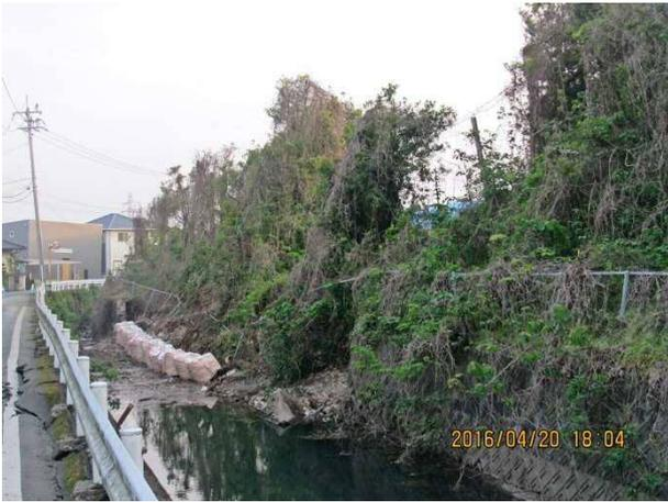
写真 4.1.1 高速道路法面の崩壊
