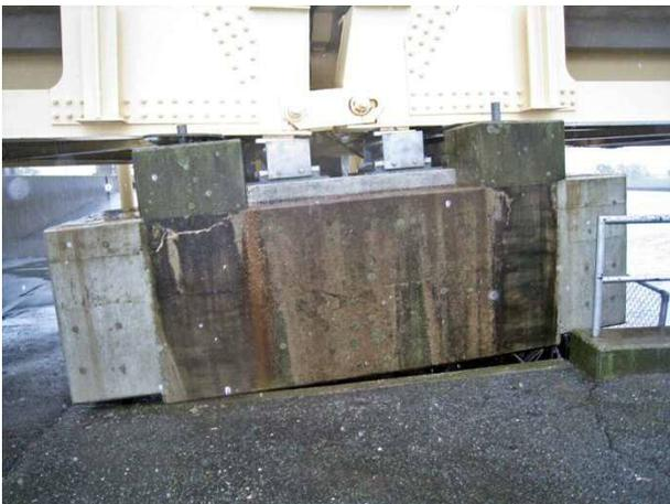
写真 4.1.53 同左の近景。橋脚はやや傾いて沈下しているように見える
