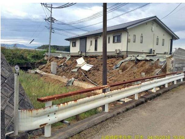
写真 4.4.58 擁壁・盛土の崩壊（甲佐町）
