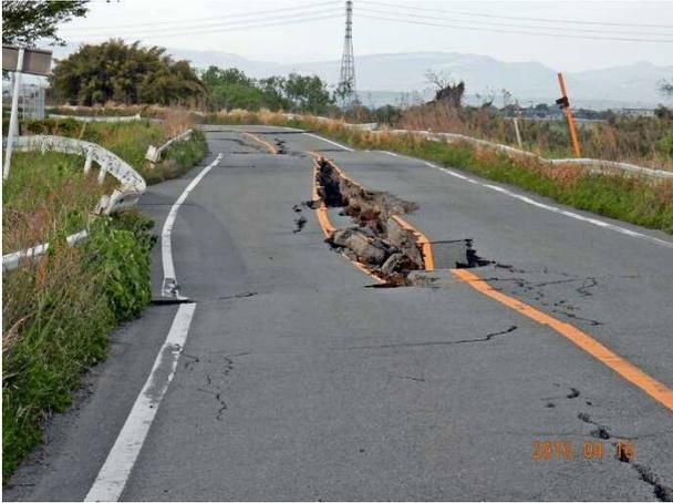
写真 4.3.21 被災③天端に生じた段差(東京電機大学石川先生提供)
