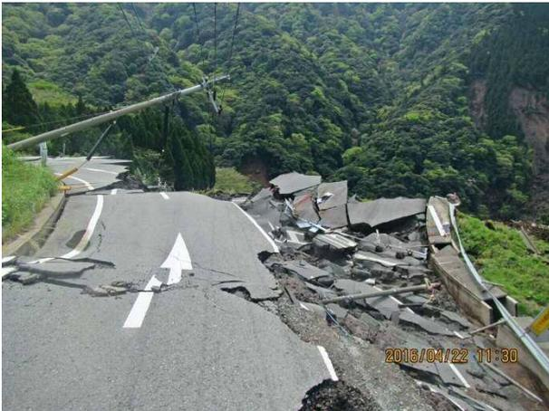
写真 4.5.21 地すべりによる道路の崩壊
