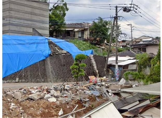
写真 4.4.21 同左近景 上段の擁壁が崩れているのが分かる
