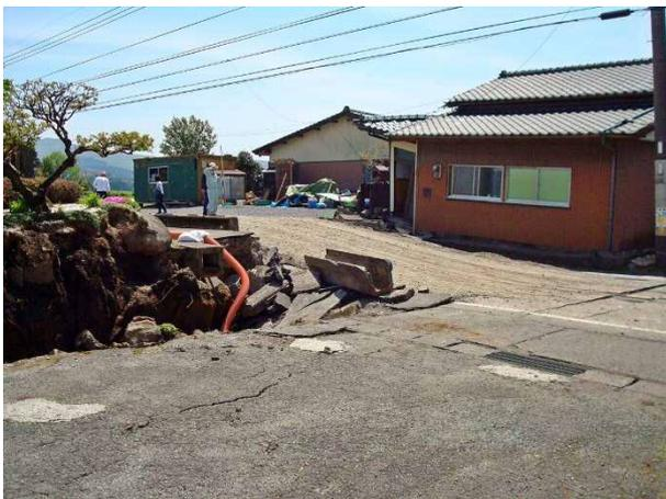
写真 4.5.50 県道 175 号を東西方向に切断した段差（南側）
