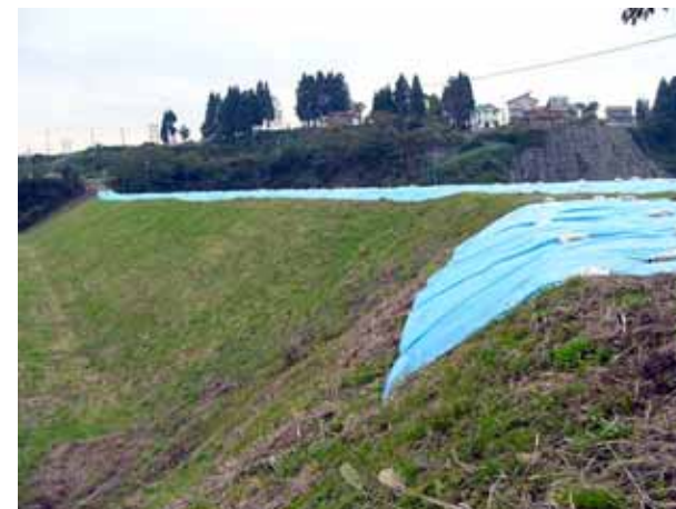
写真 3-10 頂部にシートがかけられた堤体
