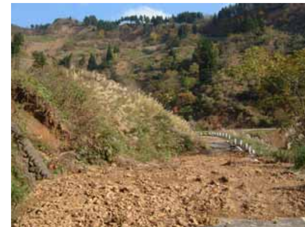
写真9-9 道路を遮断したすべり土塊
