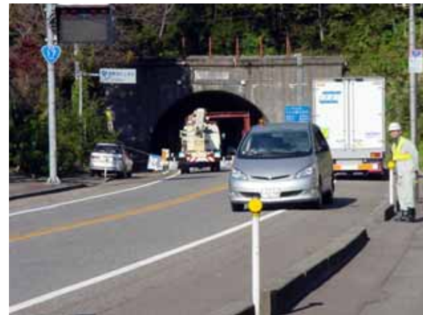
写真 5-13 和南津トンネル南側坑口
