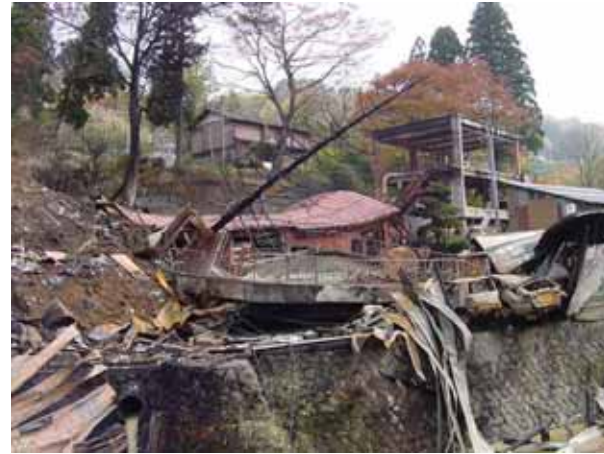
写真9-2 斜面崩壊により崩壊した家屋
