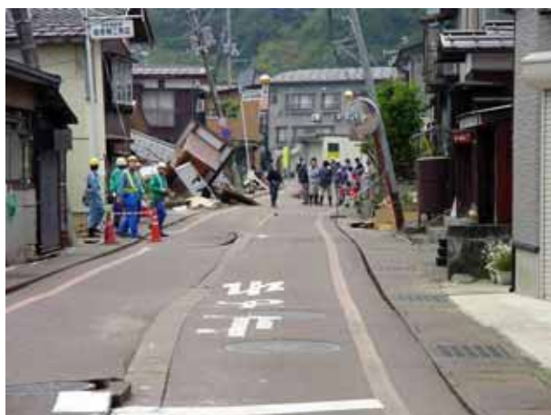
写真 8-4 家屋が倒壊し、道路が波打った地区
