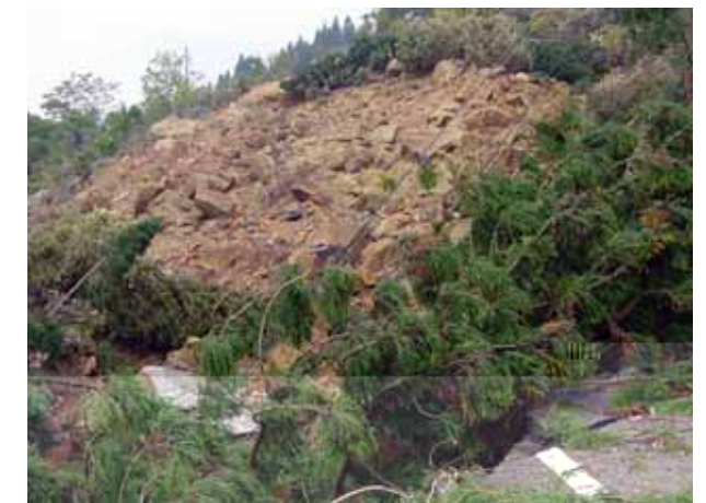
写真 7-10 県道途絶部の近景。崩壊土砂には岩塊が多く含まれている
