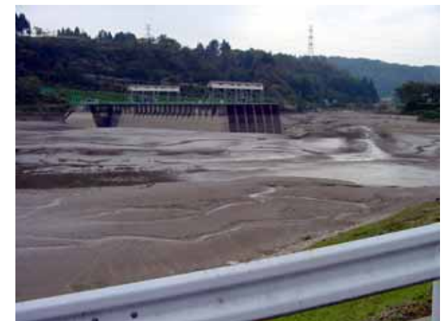
写真 3-9 調整池内は空の状態となっていた
