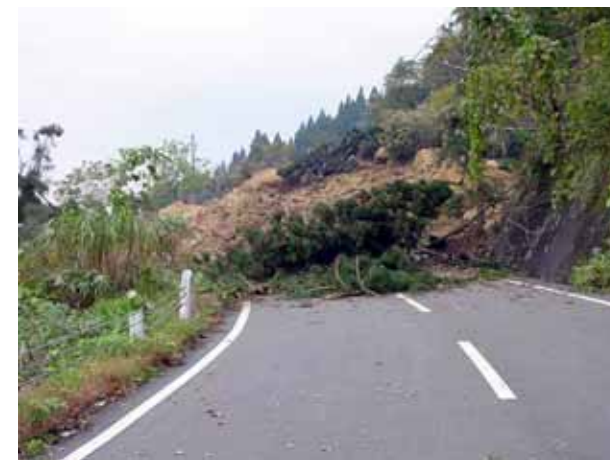
写真 7-9 斜面崩壊によって県道が削り取られた
