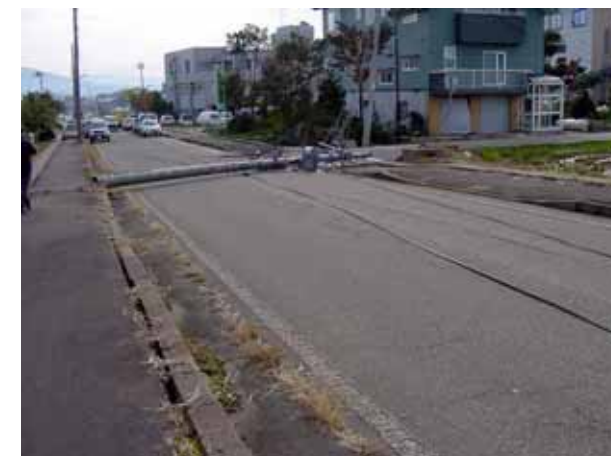
写真 6-10 根元から切損して倒壊した配電柱
