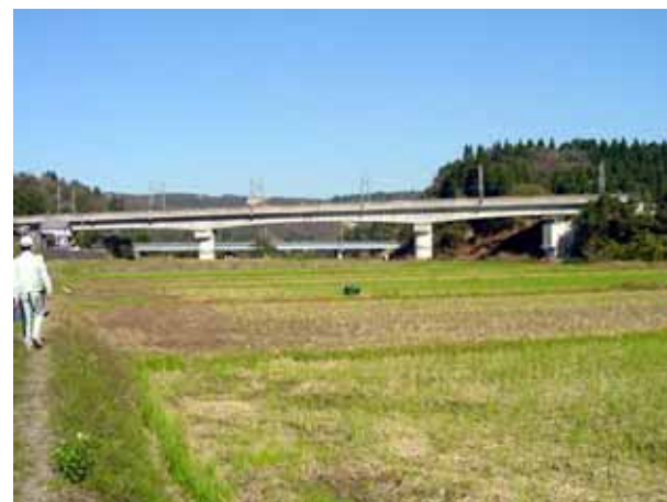
写真 4-5 魚野川に架かる新幹線橋梁の全景
