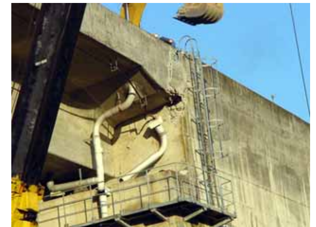
写真 5-8 橋台と橋桁連結部の亀裂・剥落
