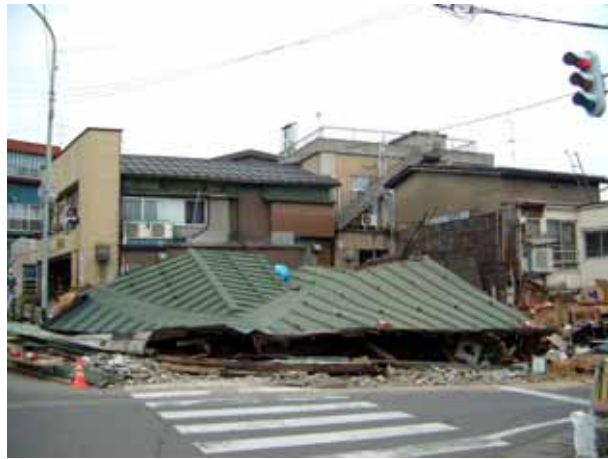
写真 8-1 倒壊した木造家屋(元町)
