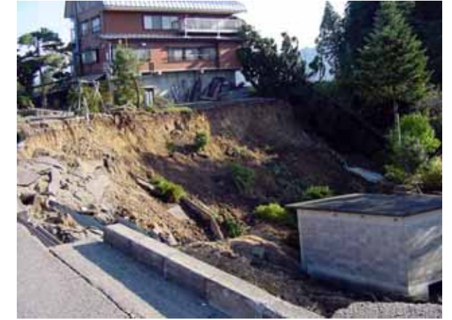
写真 5-15 家屋は危うく滑落を免れた。右方は崩壊土砂とともに滑り落ちた物置
