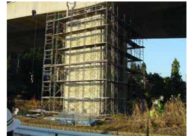
写真 5-6 補修を始めた橋脚の全景
