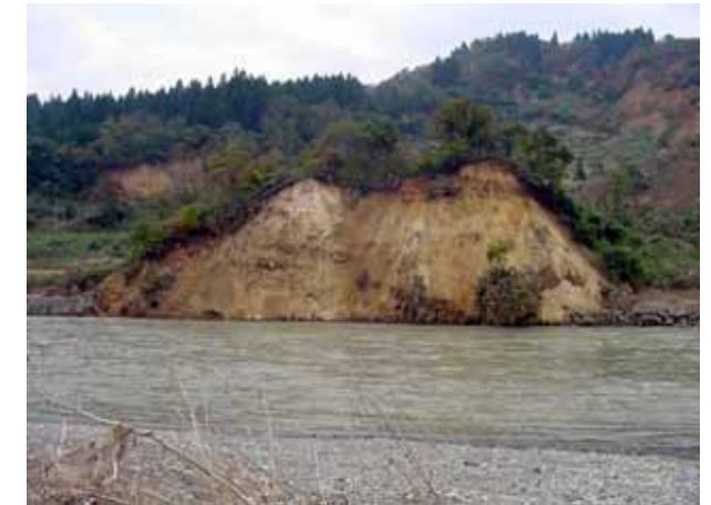
写真 7-8 崩壊地のうち信濃川に面した部分
