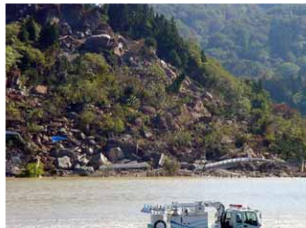
写真 7-5 崩壊の中心部の近景
