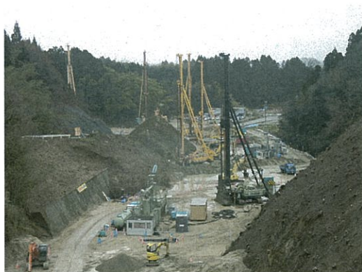
図-4 改良杭の打設状況
