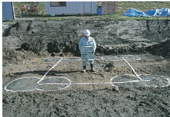
図-5 改良杭の出来形
