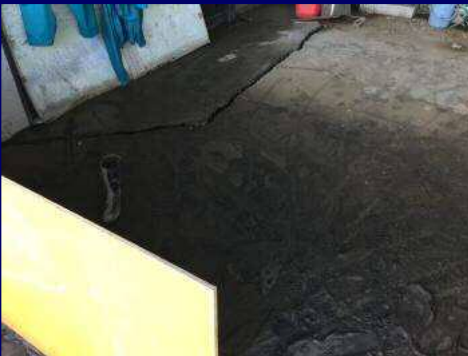
同上 1階床の亀裂と噴砂
