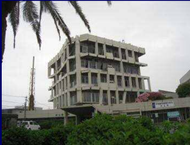
宇土市役所庁舎の被害
