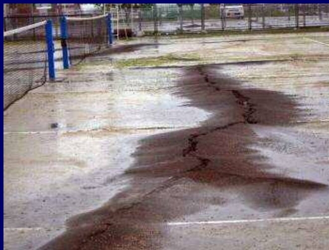
テニスコートと隣接する畑の噴砂。テニスコートと隣接する畑に同じ方向の噴砂列が生じている。
