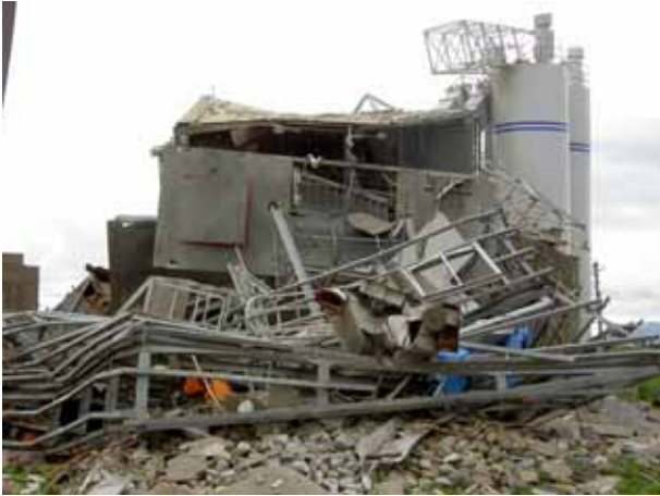
写真4.4.33 西側から見た被害状況
