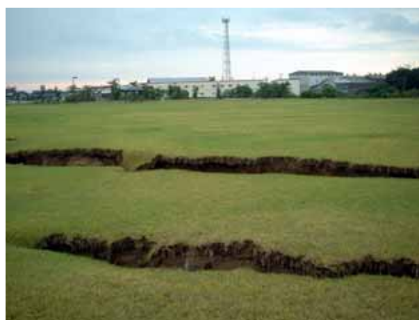
写真4.7.14 段差（30～45cm）を伴う地割れ
