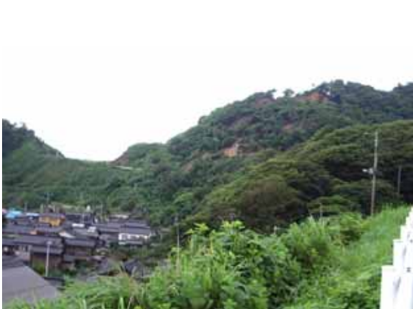
写真4.6.17 米山町集落側の地すべり
