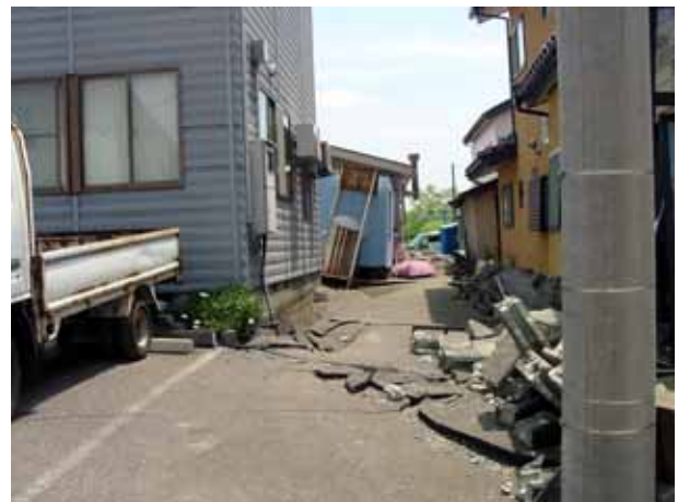
写真4.4.12 ブロック塀の倒壊および路面の破壊
