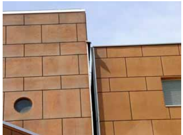
写真4.5.11 同左。建物反対側のエクspansionジョイントの開口
