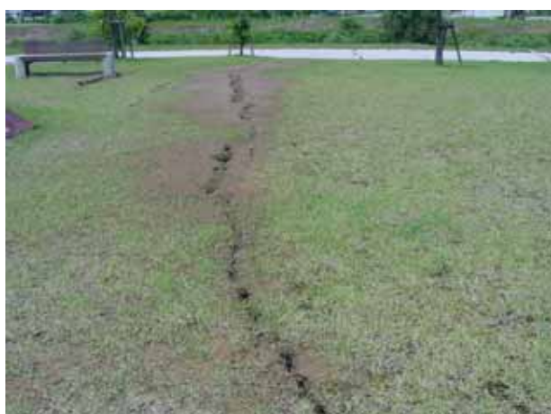
写真4.7.13 亀裂から生じた噴砂
