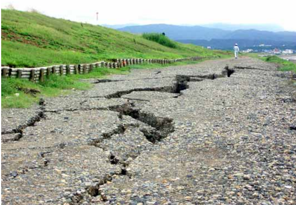
護岸の前傾と背後地盤の沈下・噴砂（同上）
