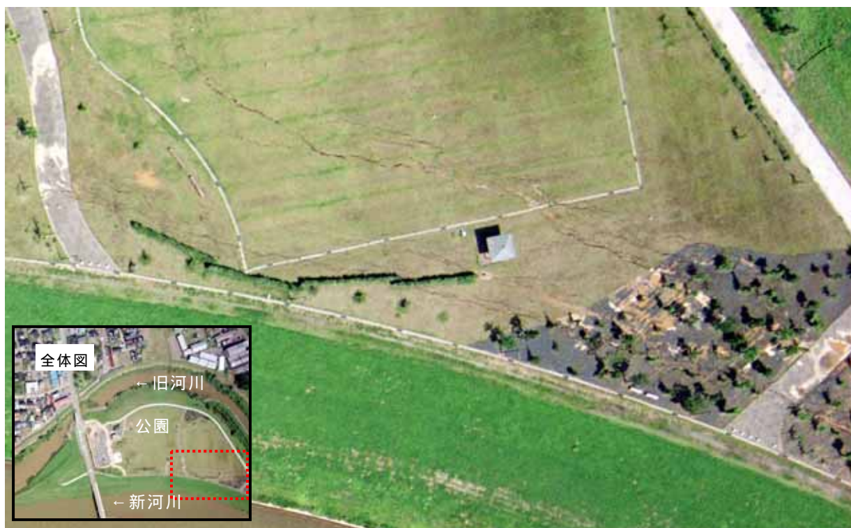
写真4.7.12 鯖石川改修記念公園のグラウンドに生じた地割れ
