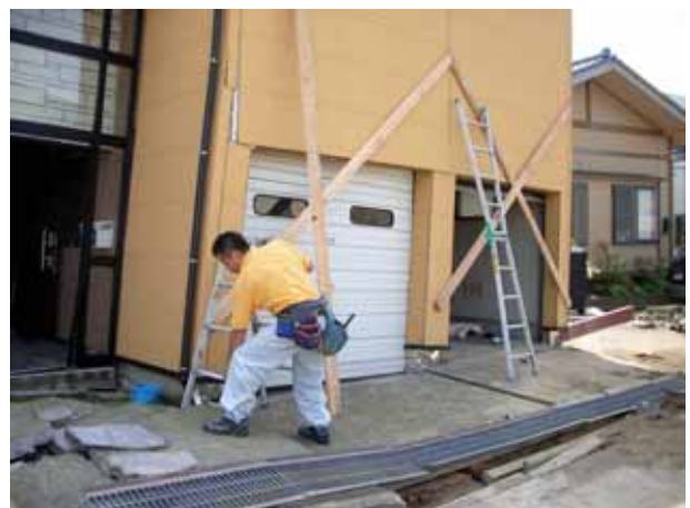
写真4.7.10 傾斜した木造家屋
