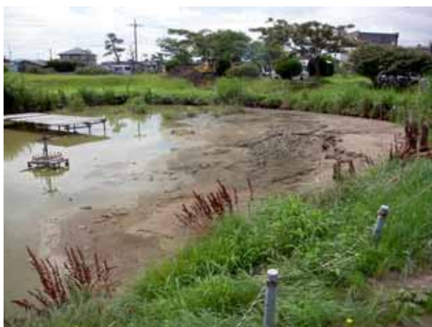
写真4.5.29 池の底が盛り上がり水面に顔を出した様子
