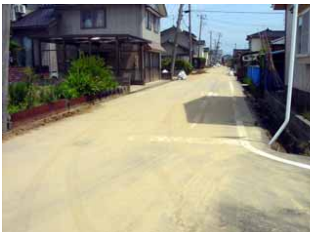
写真4.7.9 道路に残っていた噴砂の痕跡
