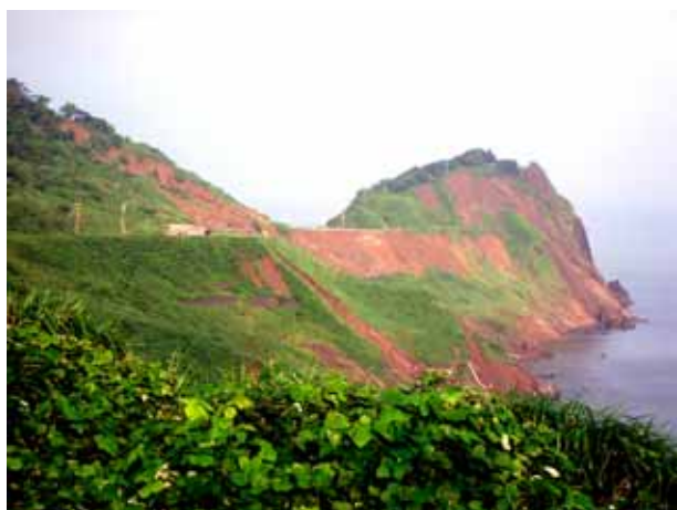
写真4.6.11 海蝕崖の地すべり型崩壊
