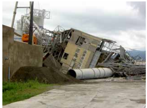
写真4.4.32 落下した輸送パイプ
