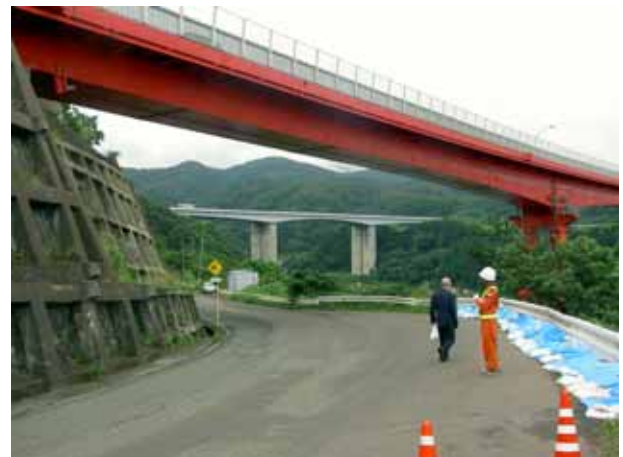
写真4.1.30 無被害の道路擁壁と橋梁（青海川）
