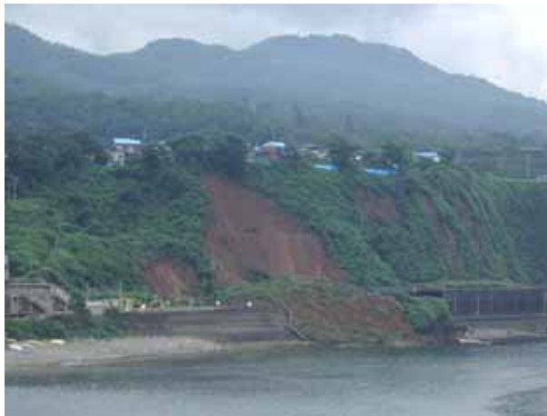
写真4.6.7 海蝕崖の崩壊地全景
