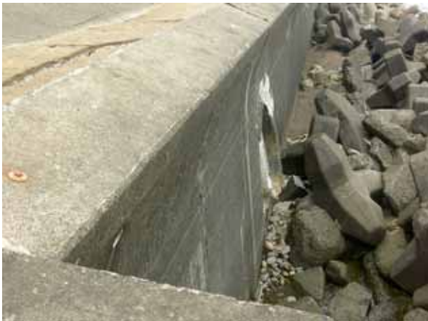
写真4.3.31 同上の樋管の出口。土の流出は見られない
