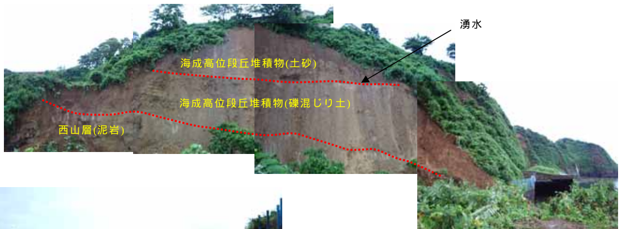
写真4.6.9 崩壊地の状況
