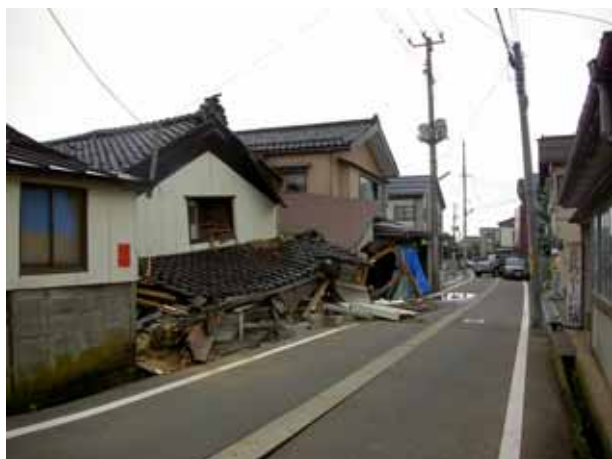
写真4.4.29 瓦屋根家屋の倒壊（柏崎市西本町）
