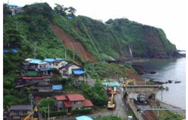
写真4.6.8 側面からの崩壊地の状況
