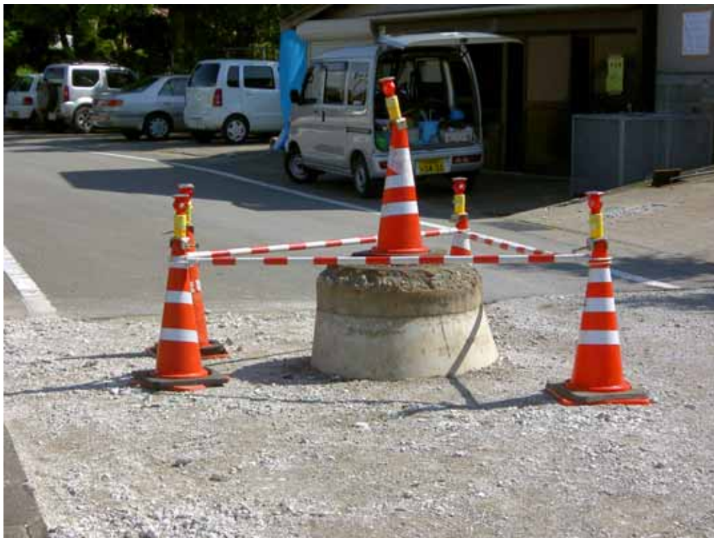
下水処理施設周辺地盤の沈下と噴砂（柏崎市安政町）
