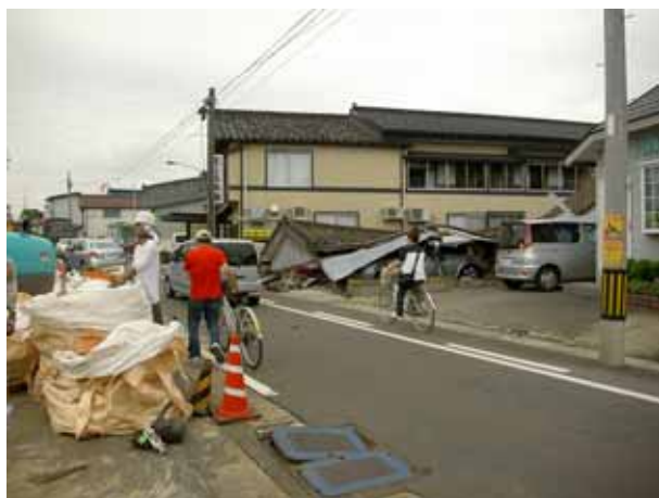
写真4.4.30 瓦屋根家屋の倒壊（柏崎市新橋）
