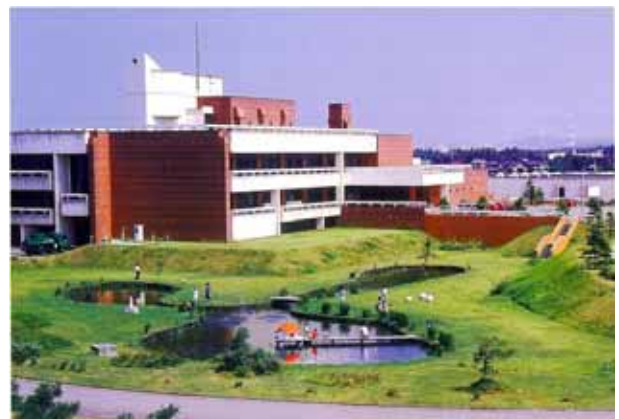
写真4.5.2 中央管理棟の全景 8)
