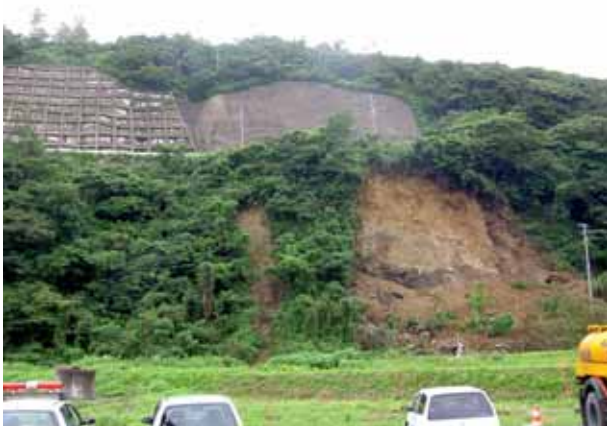
写真4.1.29 斜面の表層崩壊と無被害の道路擁壁（青海川）
