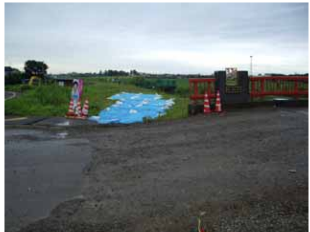
写真4.3.6 開運橋左岸下流側
