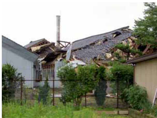
写真4.4.28 瓦屋根の酒造工場の倒壊（柏崎市新橋）
