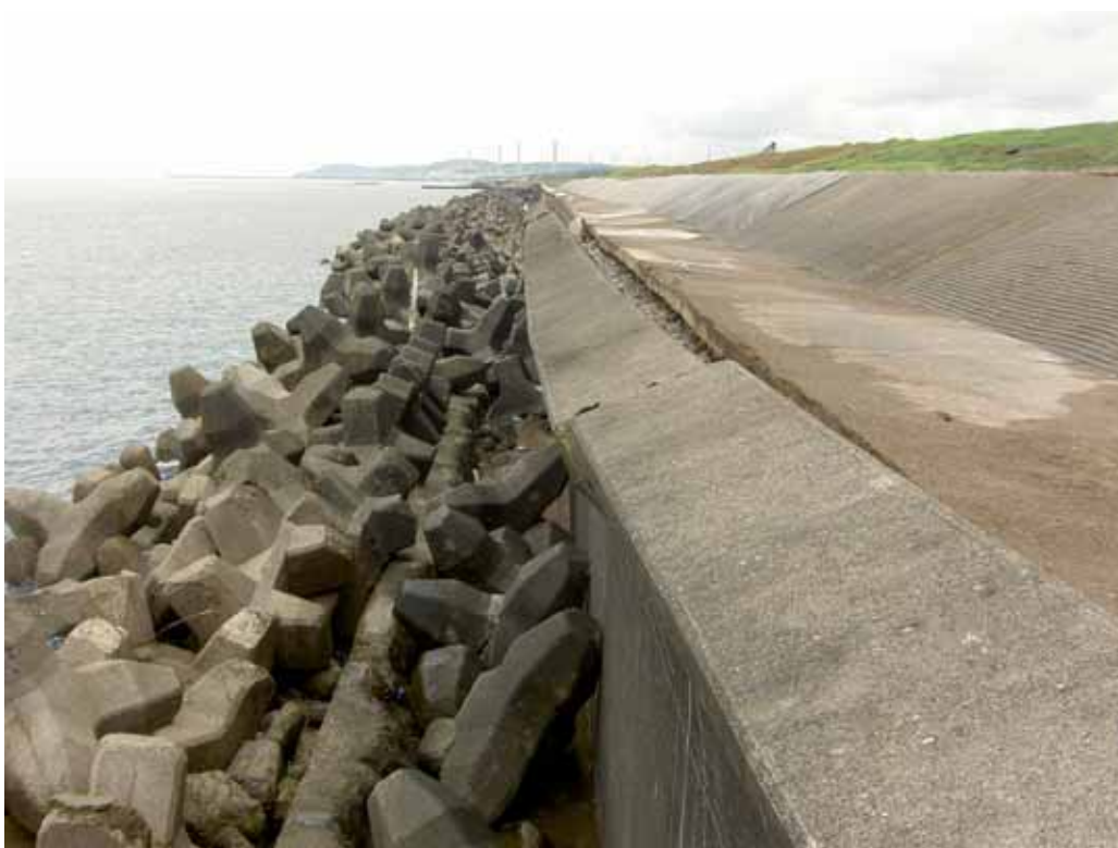
護岸の前傾と背後地盤の沈下・噴砂（同上）
