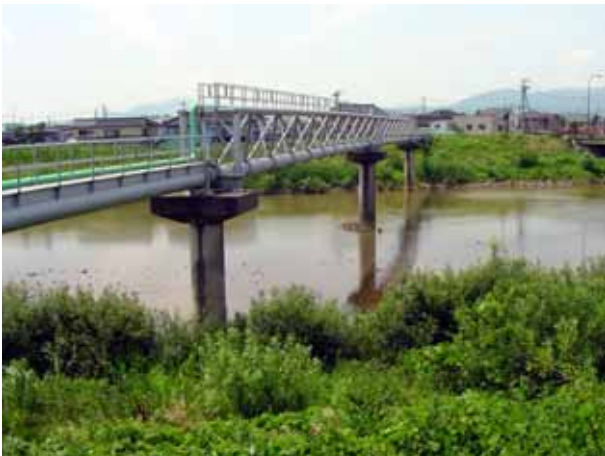
写真4.5.35 水管橋の全景
