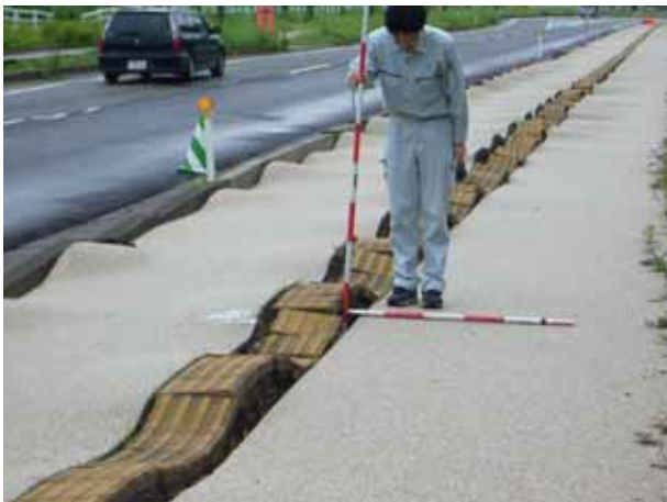
写真4.1.2 起伏は約10cm程度
