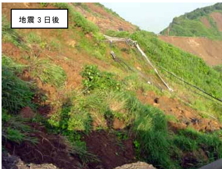
写真4.6.14 斜面の流れ盤崩壊の状況（崩壊 A）
