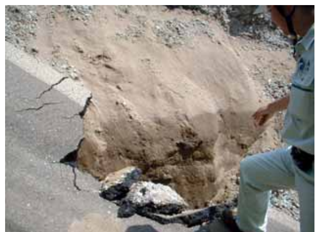
写真4.1.12 道路崩落面の近景。全面的に砂でできている
