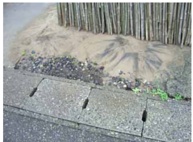
写真4.3.16 地盤の液状化による噴砂
