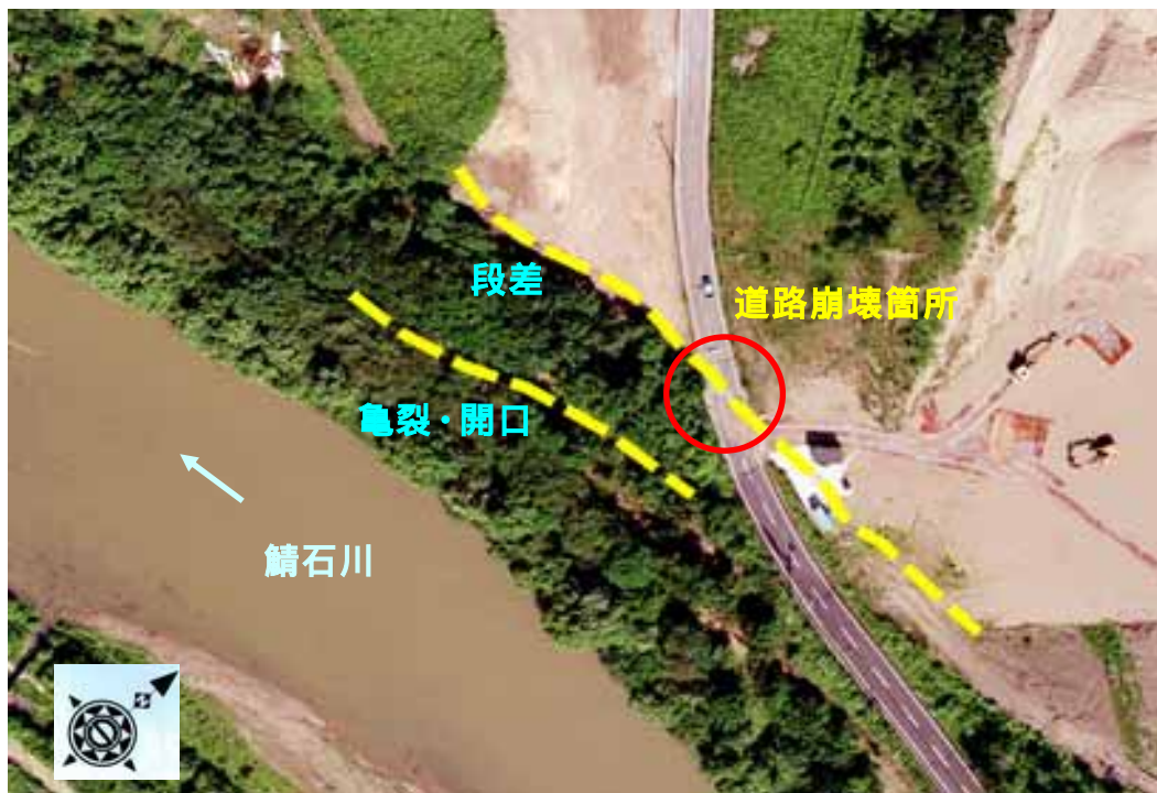
写真4.1.10 道路崩壊地点の空中写真と推定崩壊亀裂線
