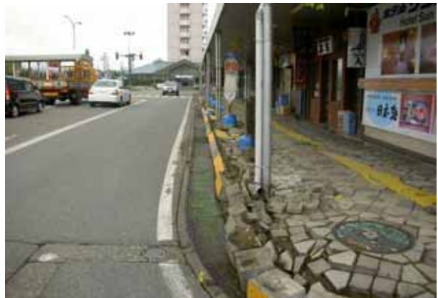
写真4.1.9 柏崎駅前の歩道マンホール周囲ブロックの損傷
