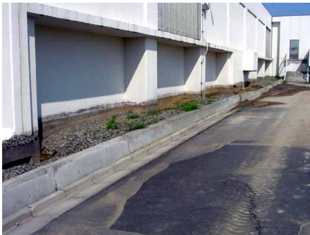
下水処理施設周辺地盤の沈下と噴砂（柏崎市安政町）
