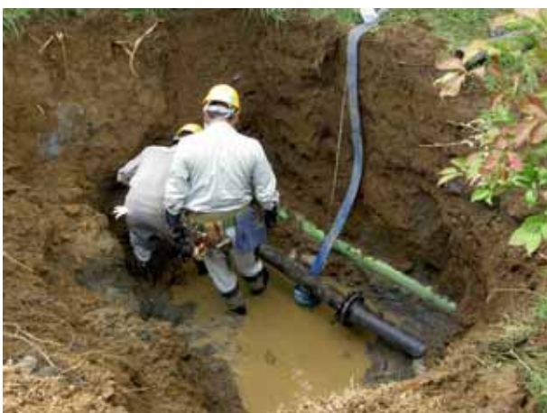
写真4.5.28 構内の水道管補修工事の様子。隣の薄緑色の管はガス管
