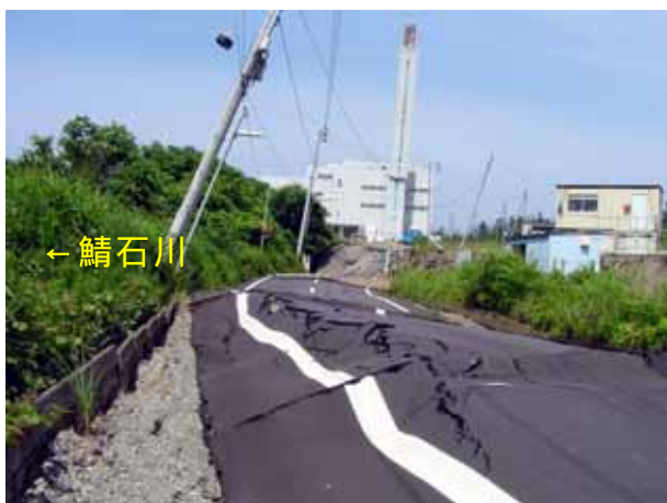
写真4.1.13 道路崩壊箇所東側から見た路面の変状
