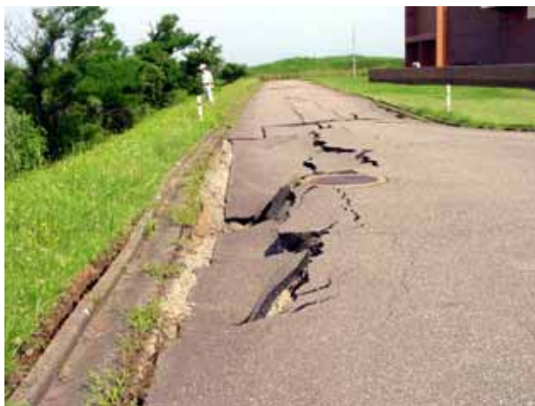
写真4.5.16 浄化センターの南西側境界。盛土のり面となっている
