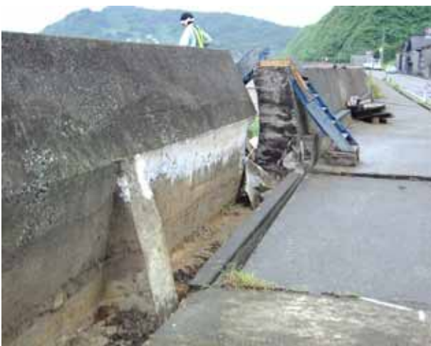
写真4.3.15 防波堤のせり出し
