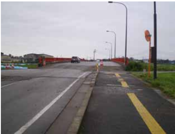
写真4.3.5 開運橋左岸橋台取付部の段差の補修跡
