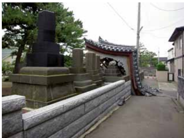
写真4.4.25 山門の倒壊（柏崎市東本町）
