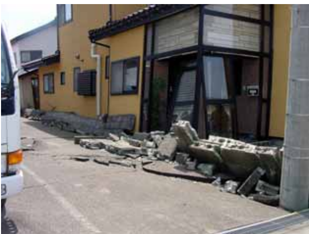
写真4.4.13 ブロック塀の倒壊
