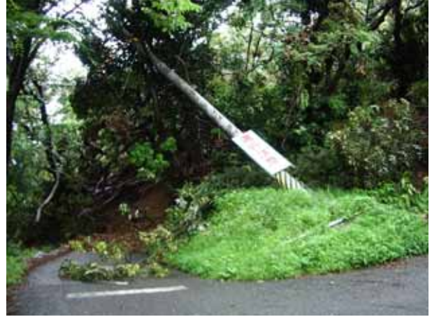
写真4.6.20 移動土塊により損壊した道路
