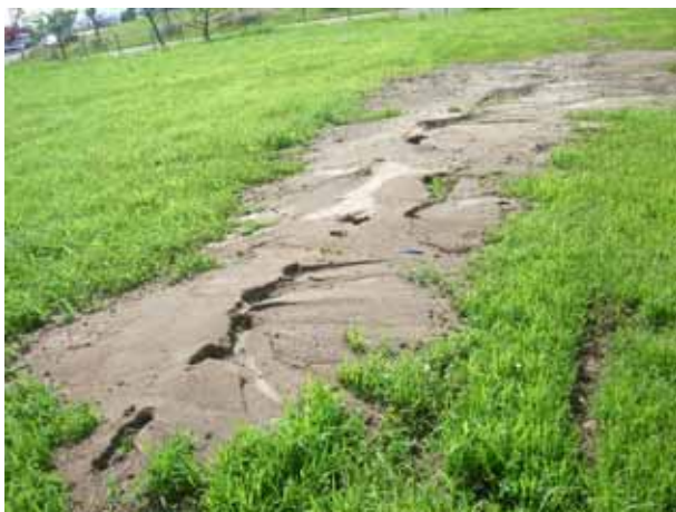
写真4.7.5 浄化センター内の噴砂丘
