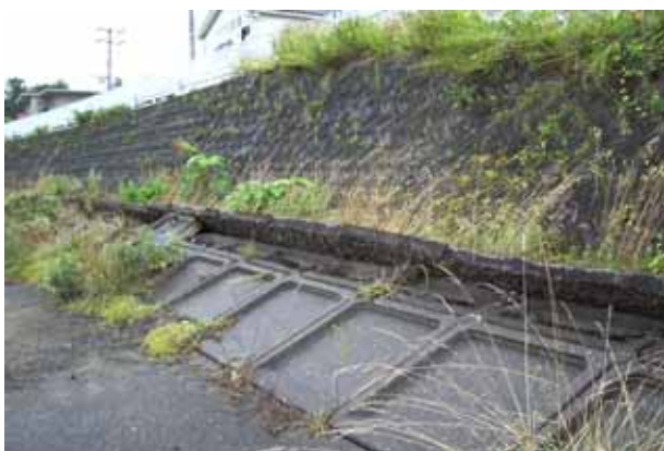
写真 4.3.3 鵜川護岸のり先
