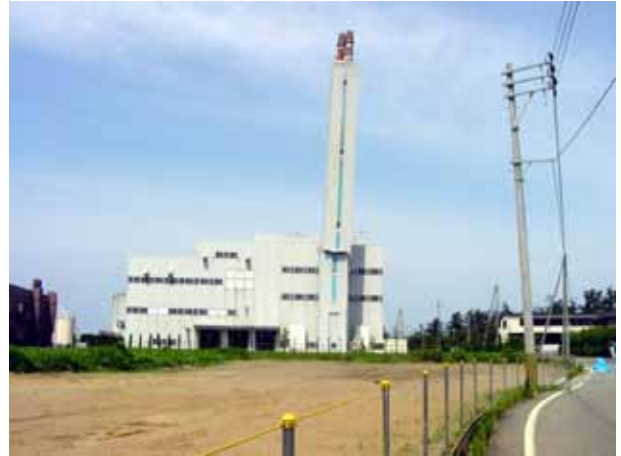
写真4.4.3 クリ - センター柏崎の全景（南東側より撮影）
