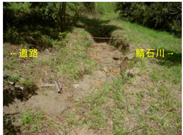
写真4.1.16 道路から川へ続く斜面の小段に見られた大きな開口亀裂と噴砂
