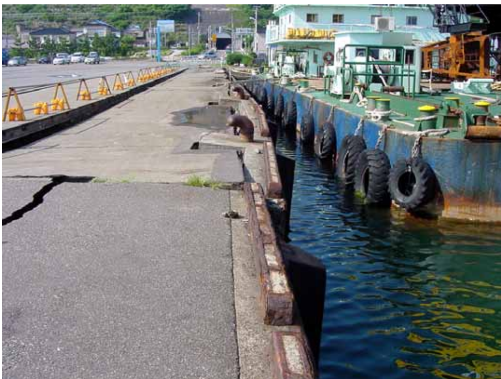
岸壁のはらみ出しと沈下（柏崎港中央埠頭）
