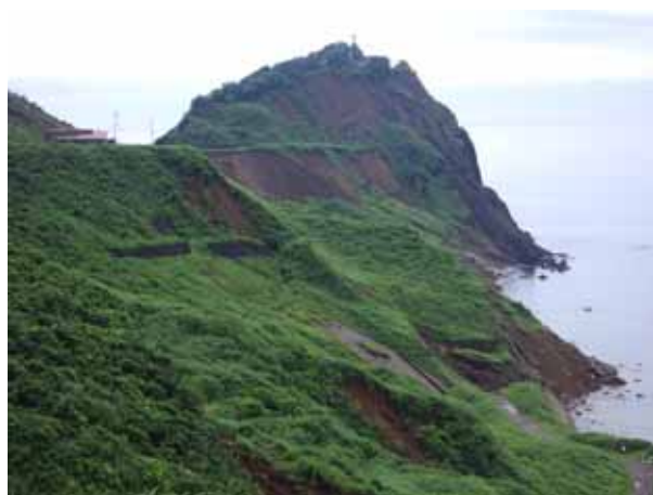
写真4.6.2 地すべり型の崩壊。明瞭な滑落崖を伴い自然斜面を保存したまま土塊が移動（米山町聖ヶ鼻）
