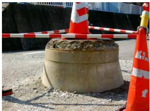
写真4.5.34 同左近景。突出量は約50cm
