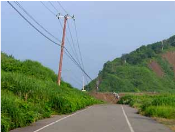
写真4.5.39 道路の左側の電柱は前方の道路崩壊によって陥没し、電柱の頭部だけが見える
