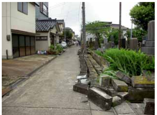
写真4.4.24 石積塀の倒壊(柏崎市西本町)
