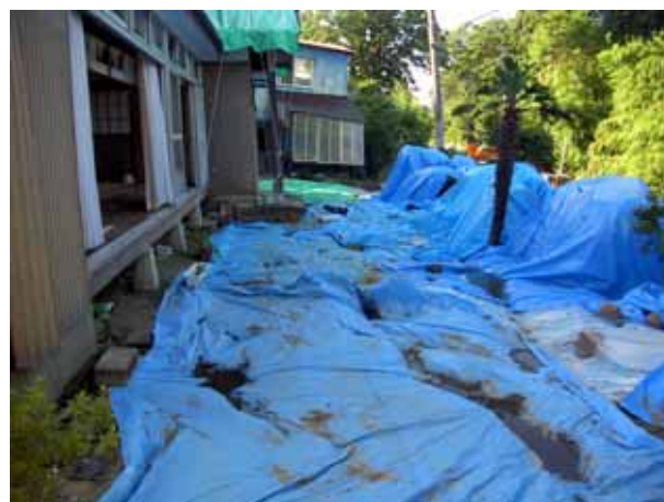
写真4.4.8 道路上の宅地の亀裂
