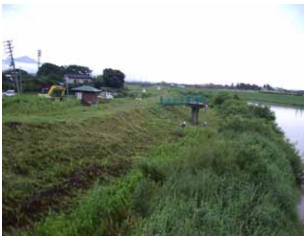
写真4.3.7 開運橋左岸下流側
