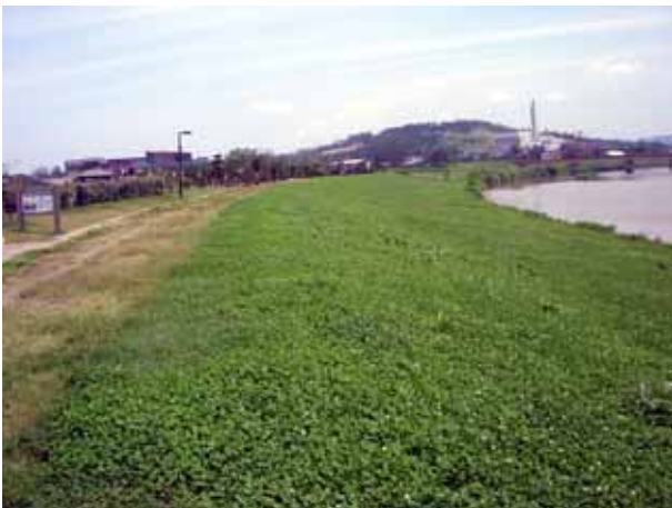
写真4.7.19 新河川側のり面
