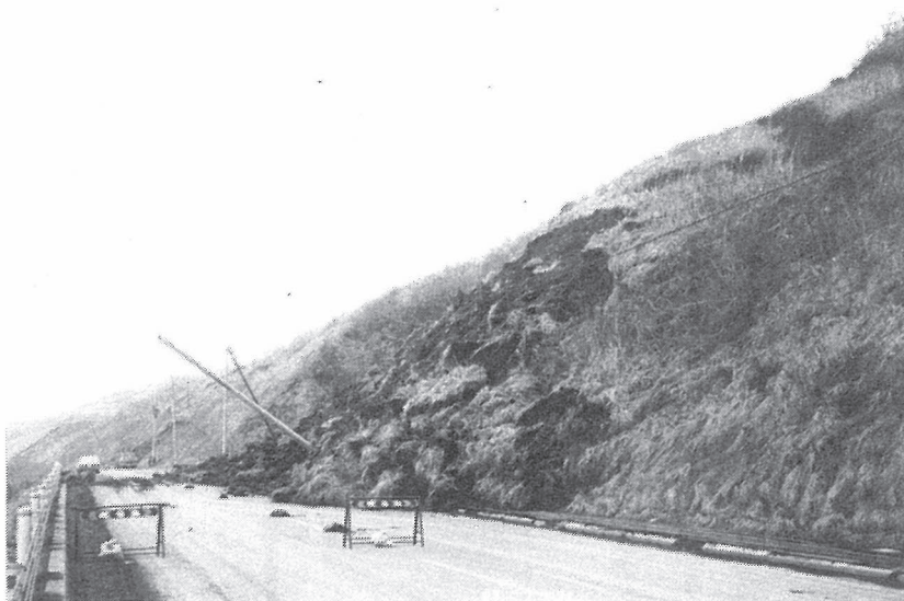
写真 4 - 10 静内町真歌における国道 235 号の斜面崩壊
