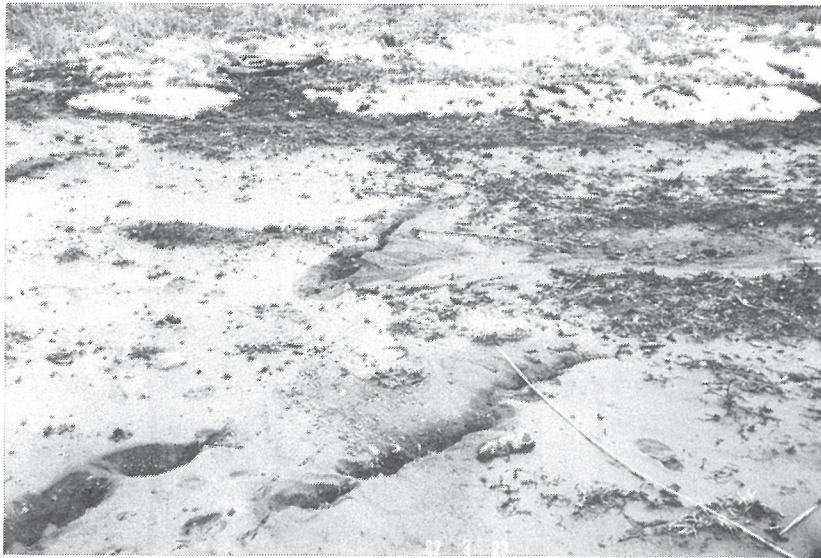
写真 7 - 3 静内川河口水門付近の噴砂跡
