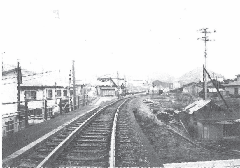
写真 4 - 2 4 浦河町地内乳呑川鉄道盛土の沈下状況
