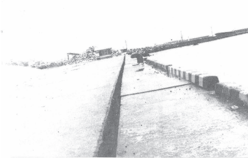
写真 6 - 11 浦河港岸壁の変状
