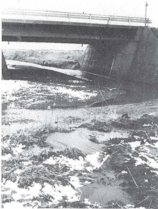
写真 7 - 5 アザミ橋右岸における噴砂跡
