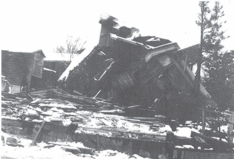
写真 3 - 2 浦河町常盤町家屋の倒壊
