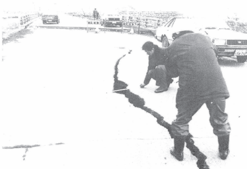
写真 4 - 4 路面の縦断クラック
