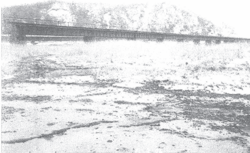
写真 7 - 2 静内川橋梁（国鉄）噴砂跡
