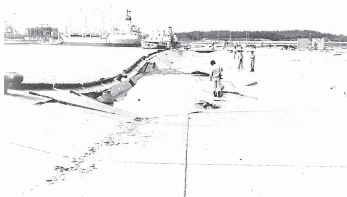
秋田港（大浜地区） エプロンの陥没，護岸の倒壊
