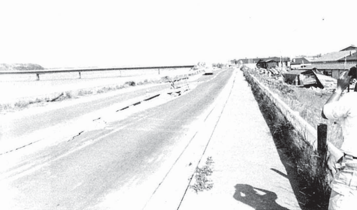
米代川下流左岸堤防 能代橋下流 200m 付近
