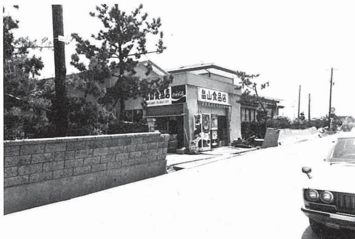
南秋田郡若美町（五明光） 一般住宅被害集中箇所 （液状化）
