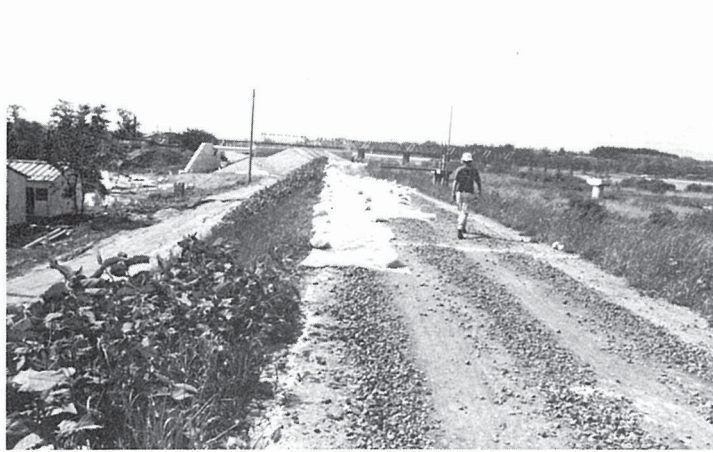
米代川下流左岸堤防 国鉄五能線橋梁上流 500m 付近 (堤内側)
