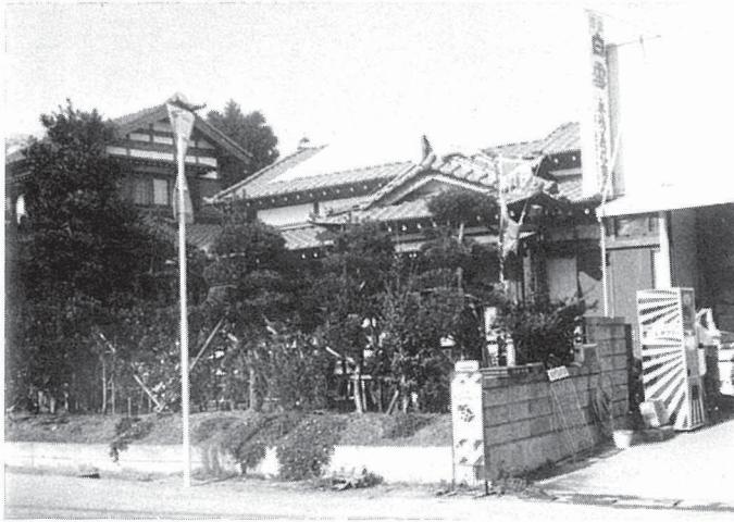
写真5-1 屋根瓦の被害
