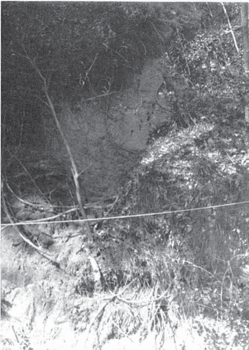
写真4-2 松尾町浅間神社の崖崩れ
