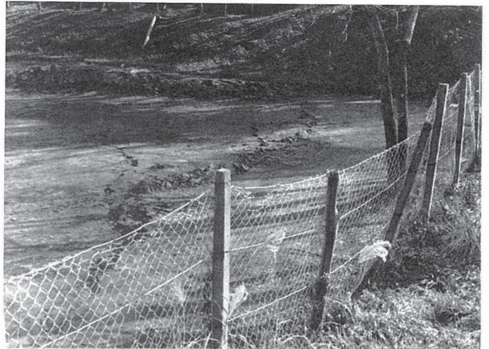
写真 3 - 5 隆起部のそばに生じた 亀裂
