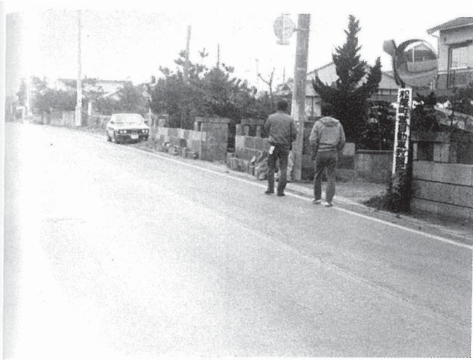
写真7-1 石積み塀の倒壊
