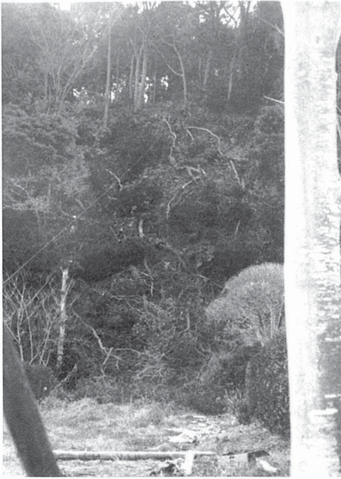
写真4-4 成東町津辺の崖崩れ 頂部に亀裂が入り危険な ため伐採しているところ
