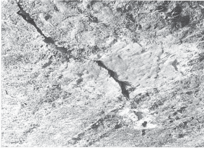
写真1-7 付近（県道より西側へ 約200m程度離れた畑） の亀裂と噴砂
