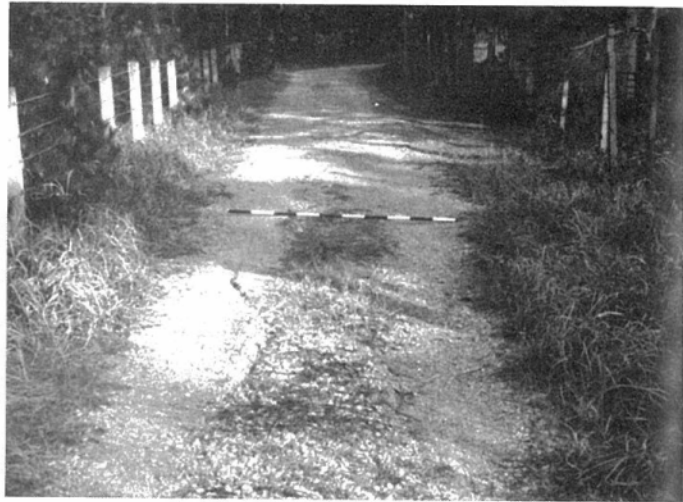
写真1-5 県道付近の道路の亀裂 (幅約1cm, 県道と直交)
