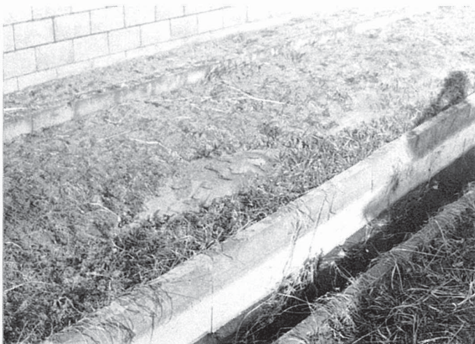
写真7-6 側溝脇の噴砂
