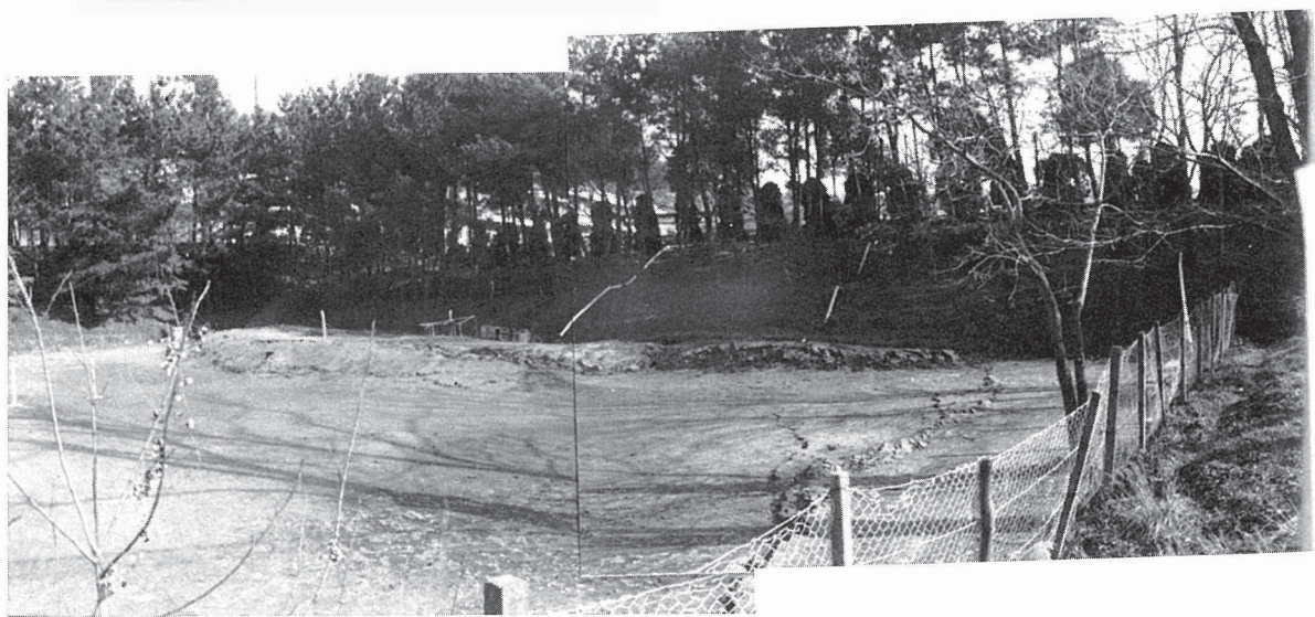
写真3-3 道路（斜面）の崩壊による 法尻部の隆起 テニスコートのポール がいっしょに持ち上が っている。
