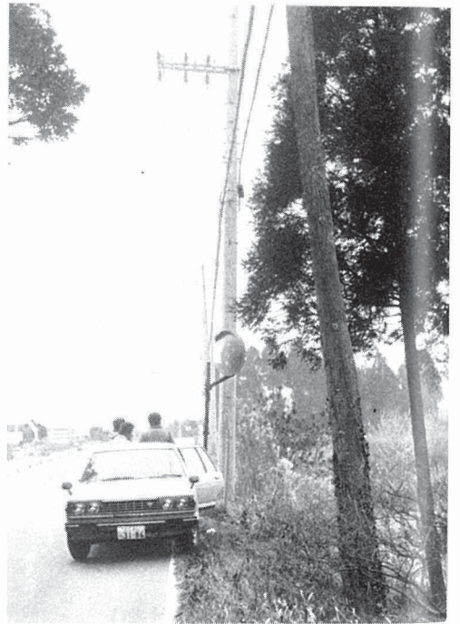
写真7-10 電柱の傾斜 （下傍止橋）
