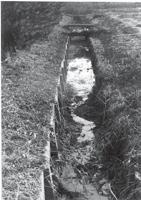
写真1-9 水路の変状 水路が両側から押され て底の土が押し上げら れている状況
