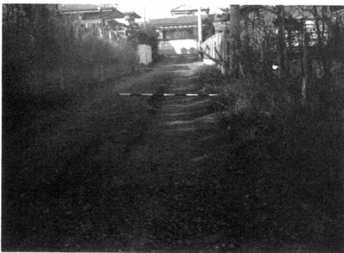
写真1-6 県道付近の道路の陥没 (約30cm沈下, 県道と平行)
