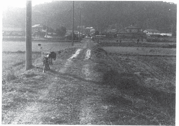
写真1-9 水路の変状 水路が両側から押され て底の土が押し上げら れている状況
