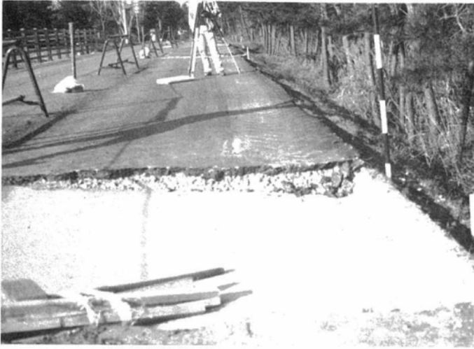
写真1-5 県道付近の道路の亀裂 (幅約1cm, 県道と直交)
