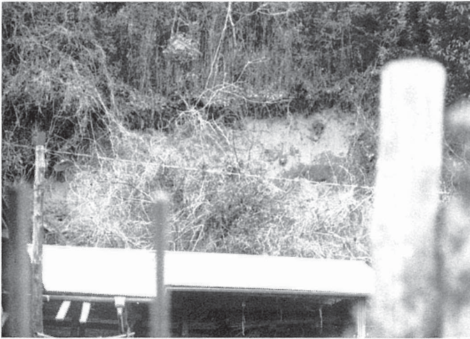
写真4-1 松尾町田越の崖崩れ
