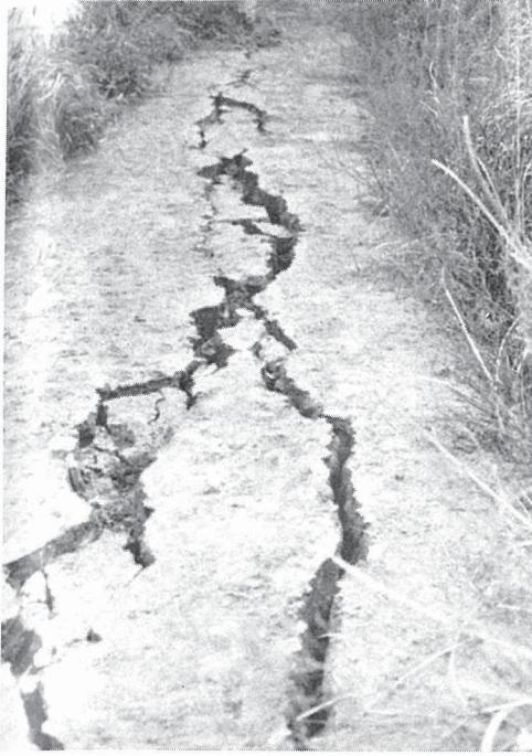
写真2-10 真亀橋右岸の横断亀裂
