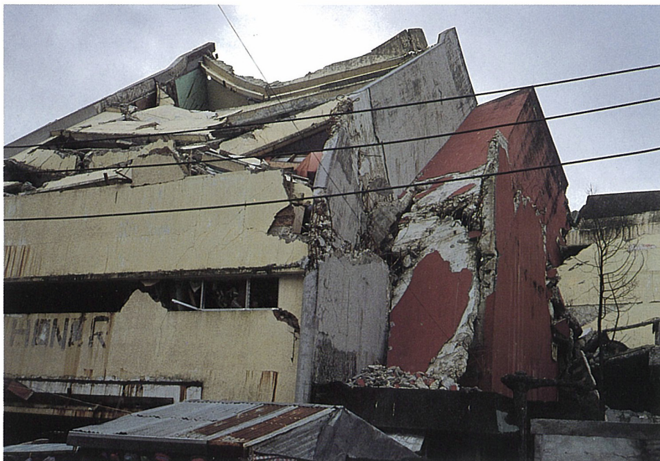
バギオ市「ヒルトップ」ホテルの倒壊
