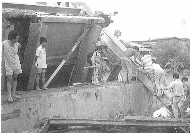
写真 8 - 5 P12橋脚をG12トラス側か らみた様子。
