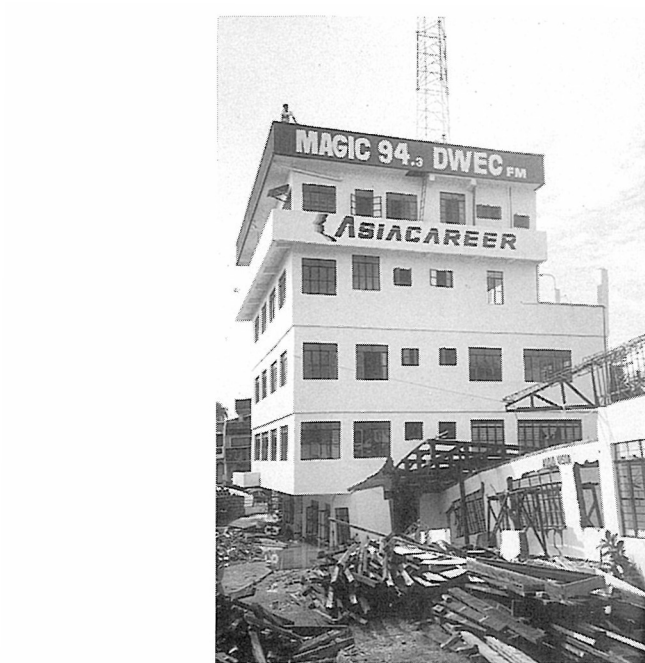
写真5-8 液状化により沈下・傾斜した放送局。2階以上には被害がみられない。
