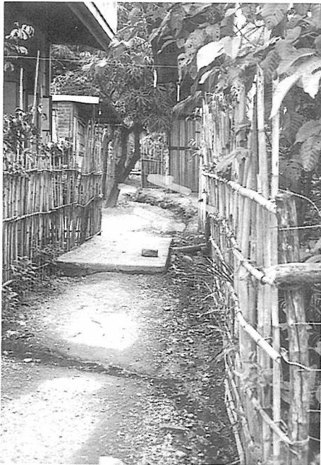
写真7-1 道路の左横 ずれ(水平2.6m 鉛直0.6m)
