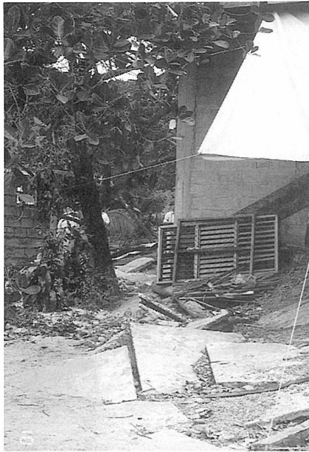
写真7-12 断層上の家屋の被害 手前のコンクリート壁の 家は倒壊したが、奥の家は 倒壊を免れた。
