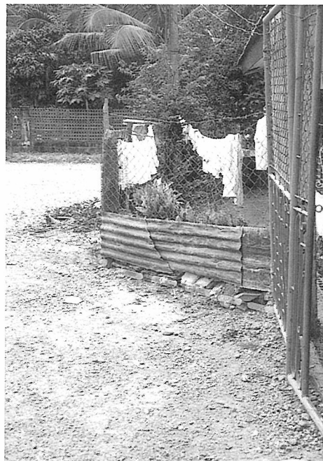
写真7-2 フェンスの 左横ずれ
