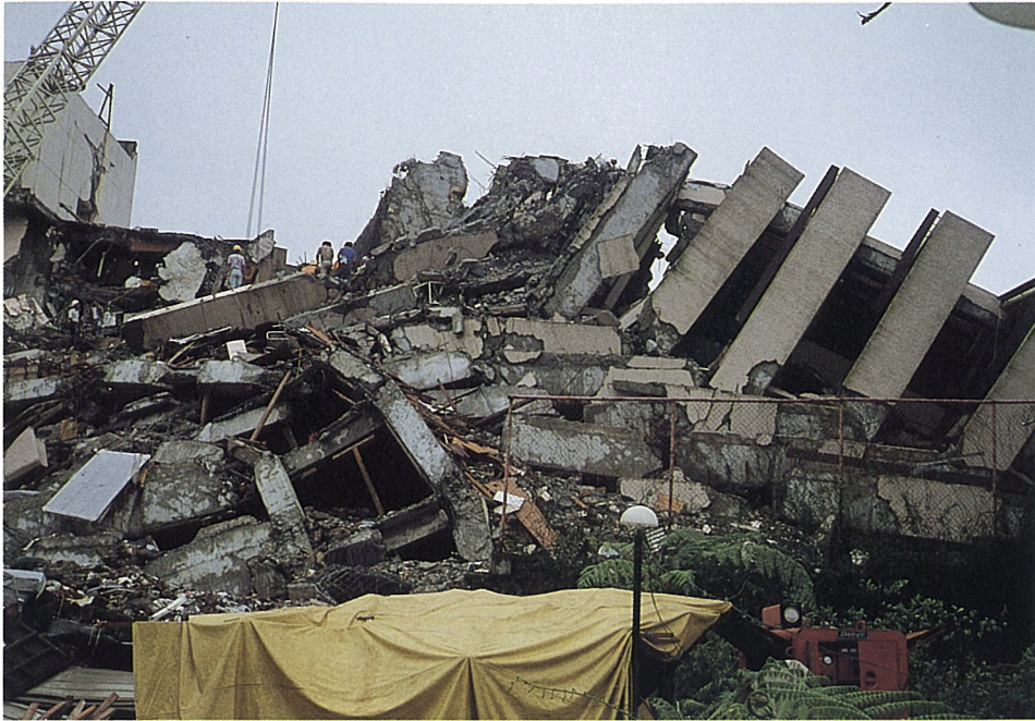
バギオ市ホテル「ハイアットテラス」の新館棟の倒壊
