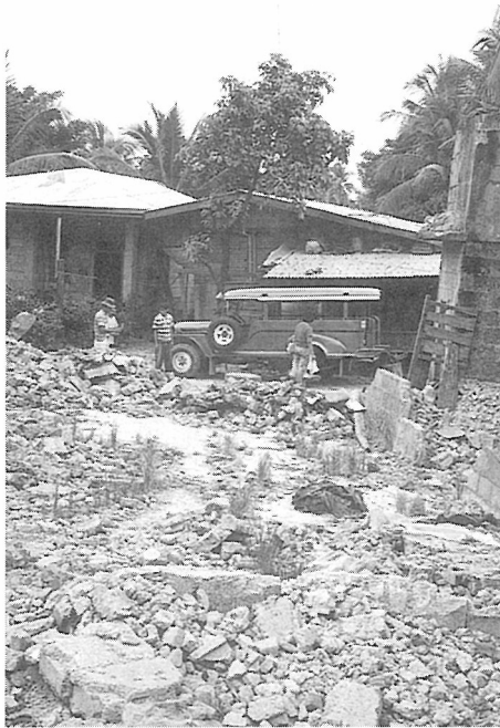
写真7-3 破壊された断層直上の コンクリートブロック 造の家屋
