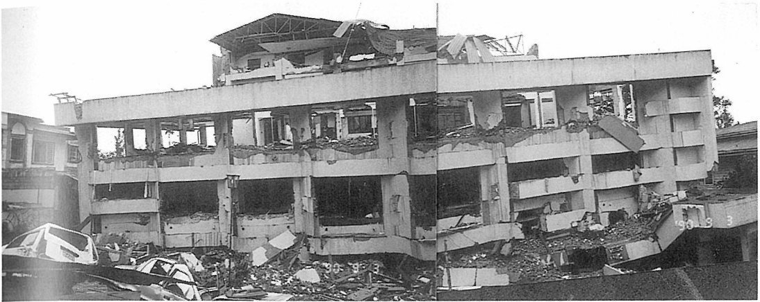
写真6-7 下層部分が崩壊したネバダホテルの全景
