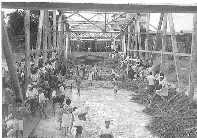
写真 8 - 6 両端とも橋脚からはずれ たG12トラス。
