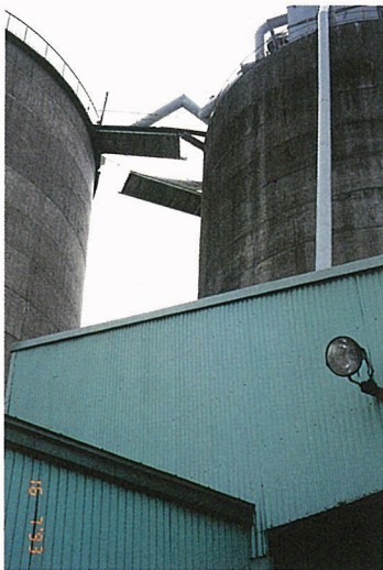
写真7-28 傾斜のため頂部は約1.5m開いた
