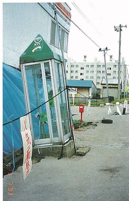
写真7-3 地盤の不同沈下により傾い た電話ボックス
