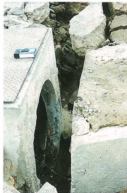
写真7-35 カルバートボックスの開口 (森港)
