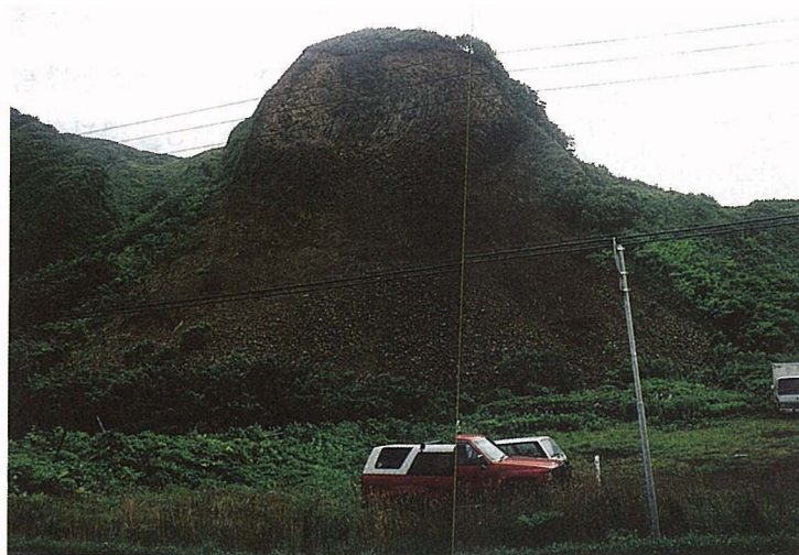
写真4-41 瀬棚町三本杉 柱状節理が小片化して崩落 A shallow-seated landslide
