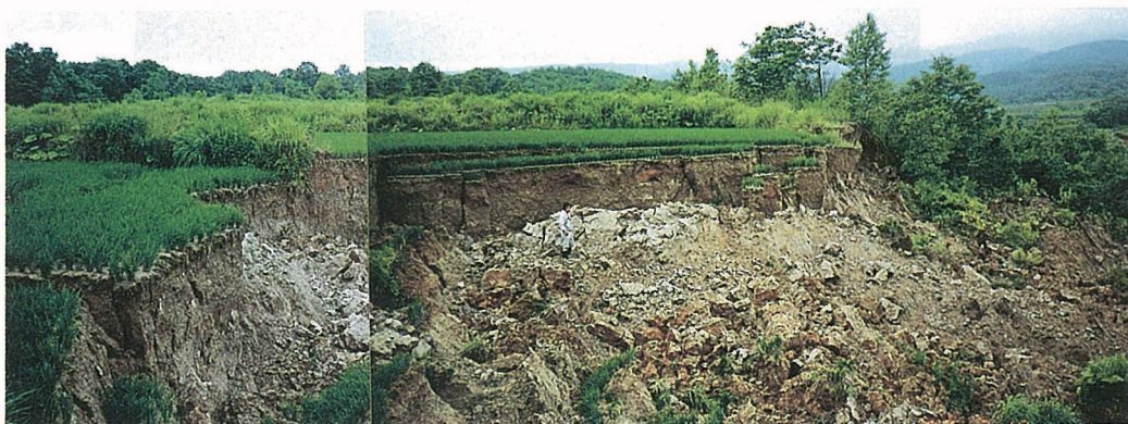
写真4-44 蘭越町三笠地区 火山灰の自然斜面の崩壊
