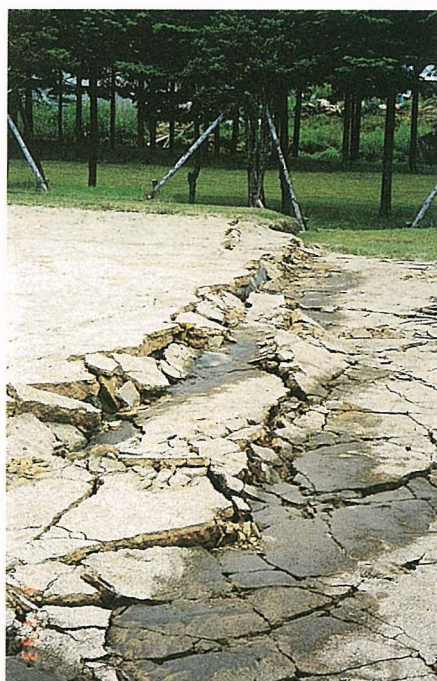
写真7-17 グラウンド地盤の隆起 Subsidence in the playground
