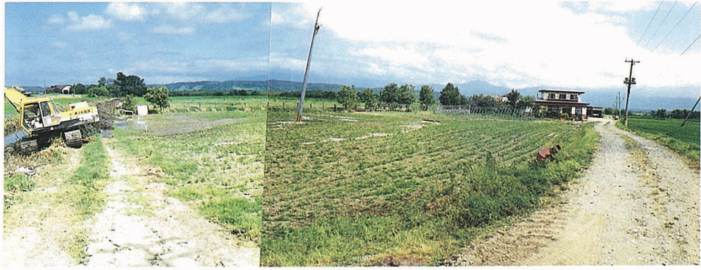
写真5-7 後志利別川沿線地区における液状化による側方流動（瀬棚町豊田） Lateral displacement due to liquefaction near siribeshi toshibetsu river
