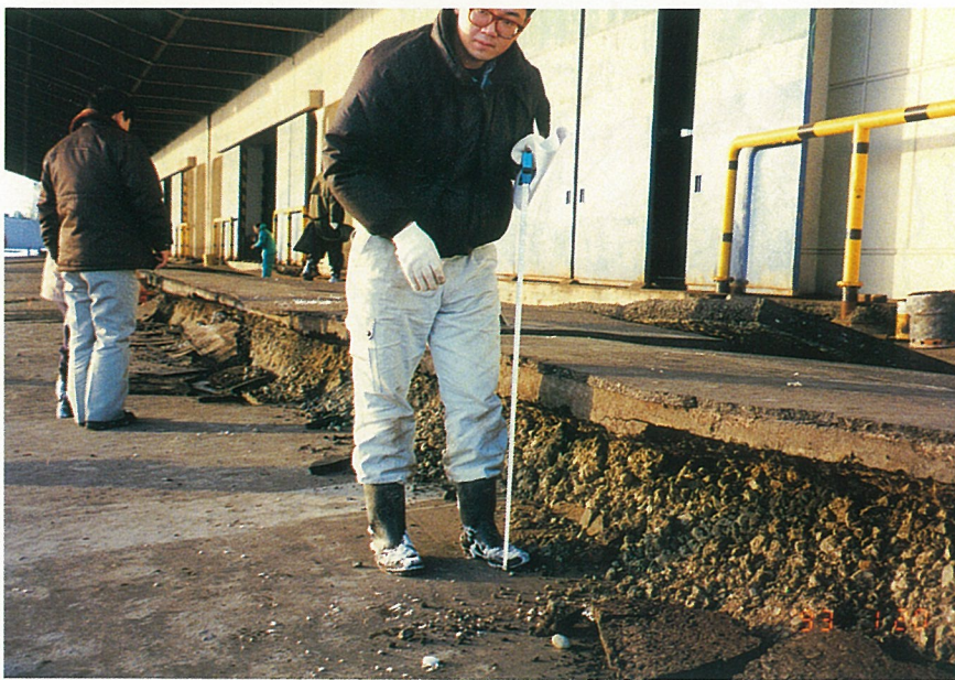
液状化によって沈下・陥没した岸壁（釧路港東港区漁業埠頭-7.5m岸壁）
