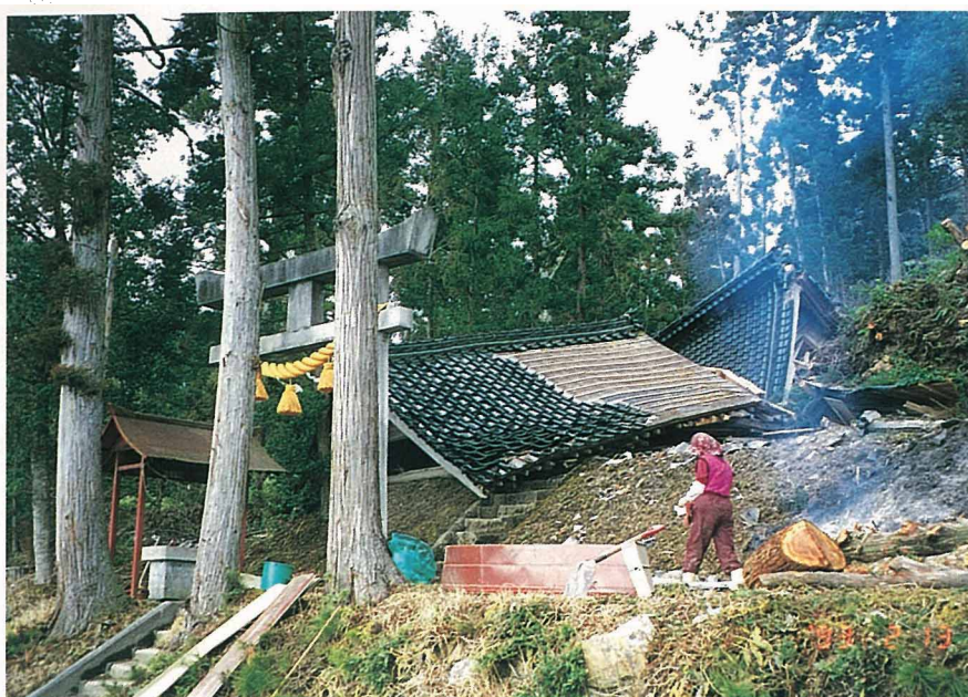
① 背後の斜面崩壊によって全壊した火宮神社の社殿（珠洲市正院町飯塚）
