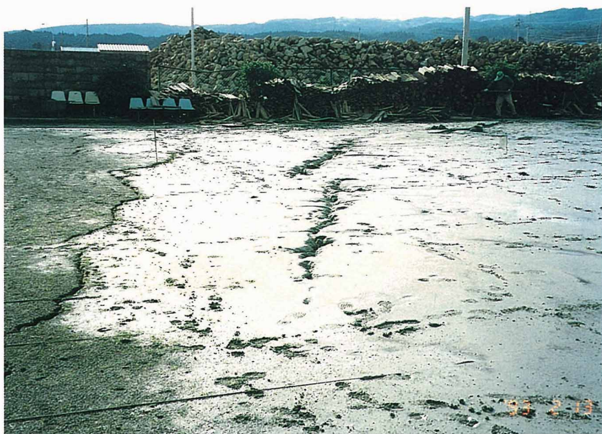
④ 護岸背後のゲートボール場（埋立地）に生じた噴砂（珠洲市飯田）
