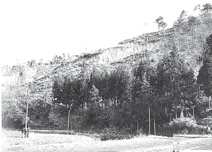
写真 4-2 県道より上部 自然斜面の崩壊 (柳田村久田)
