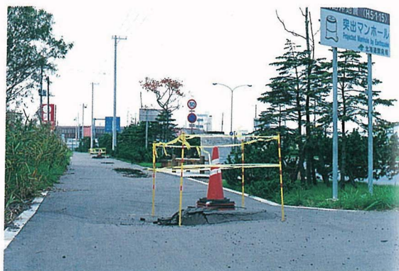
写真-9.8 釧路町マンホールの突出量の比較
