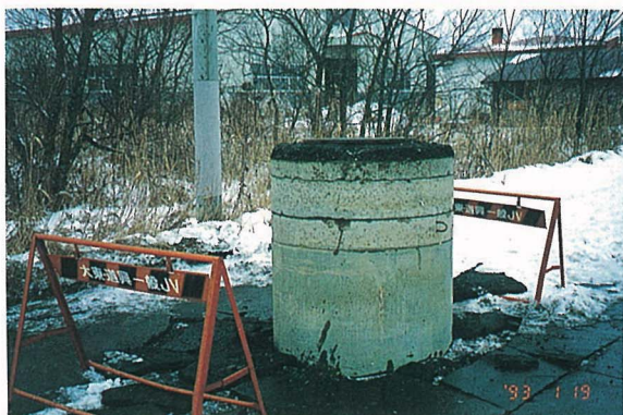
写真-9.8 釧路町マンホールの突出量の比較
