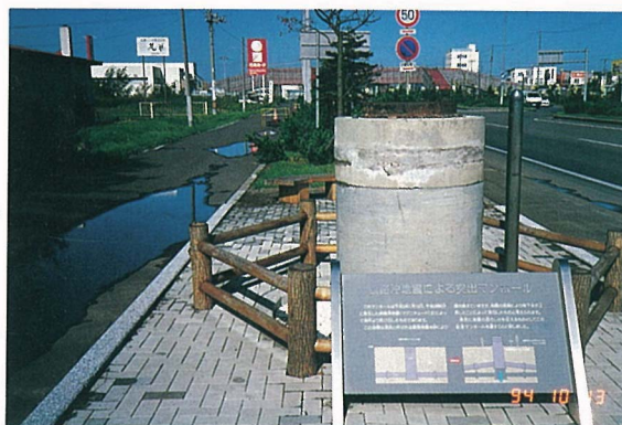
写真-9.7 記念保存されているマンホール
