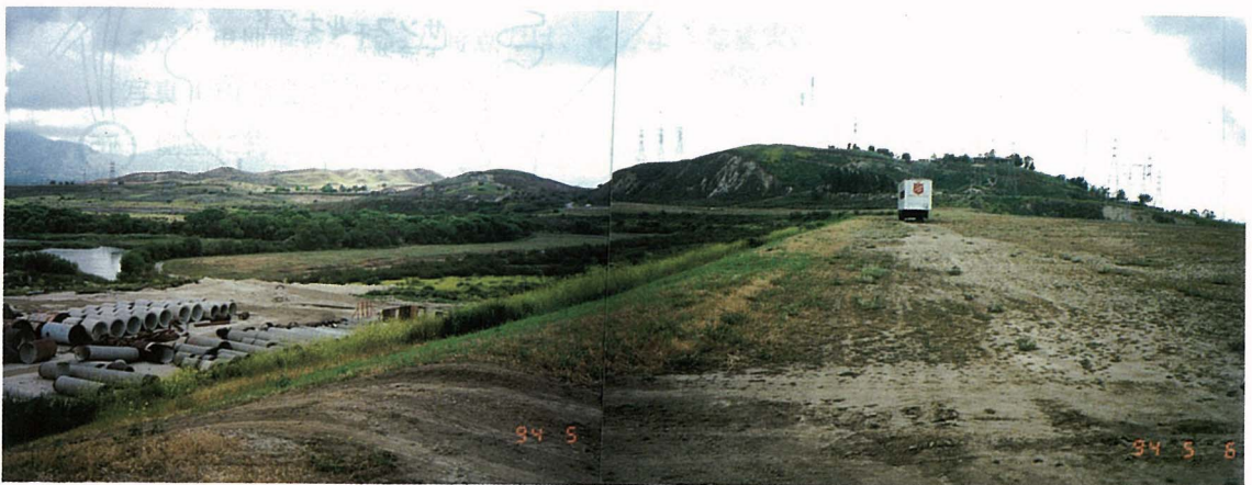
写真 4. 9 サンフェルナンド上流ダムの堤体
