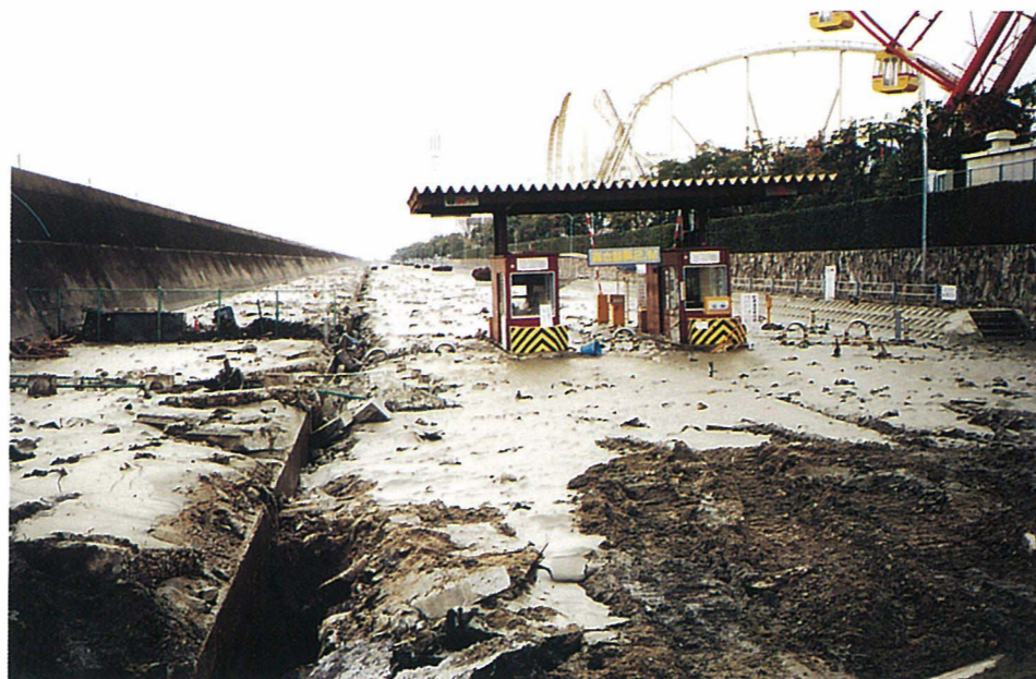
4. ポートアイランド第Ⅰ期 南側護岸の噴砂
