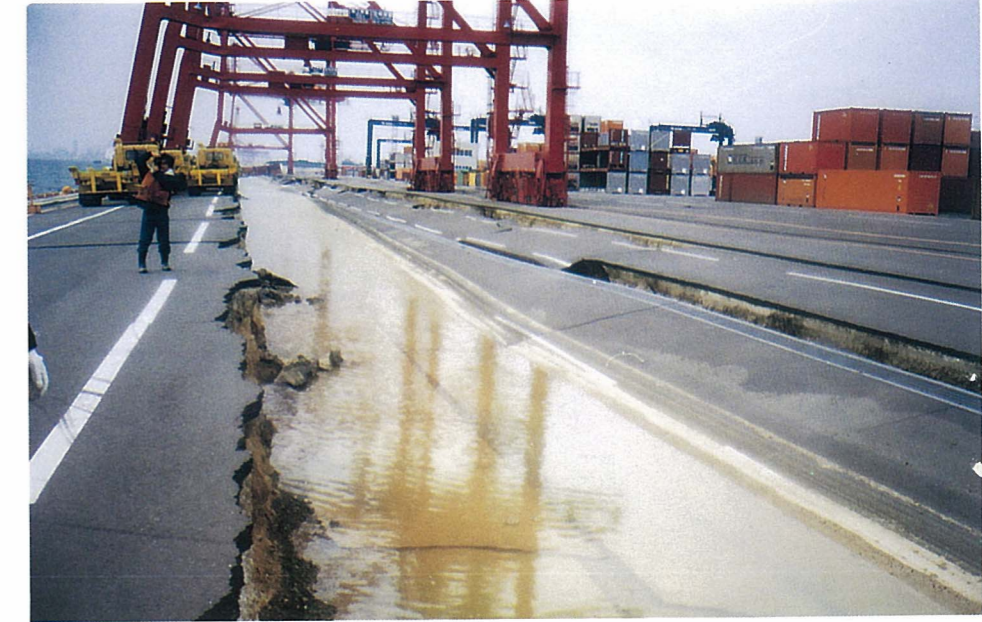
17. 六甲アイランド南側護岸の崩壊
