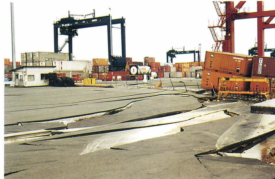
14. 六甲アイランド南側の液状化
