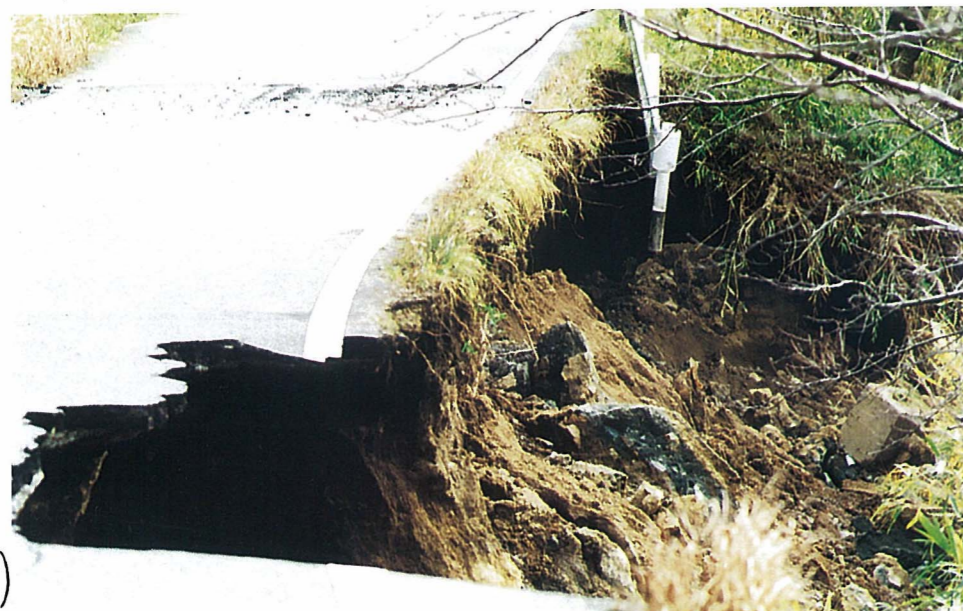
淡-17 送電鉄塔の裏山に生じた 野島断層による割れ目
