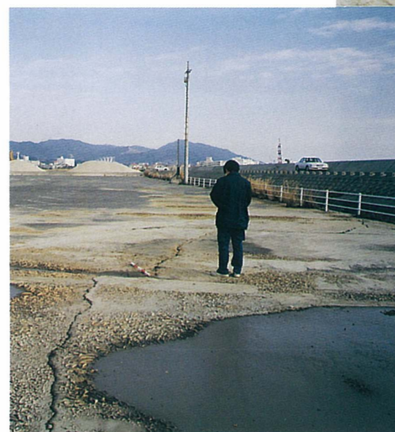
淡-4 「おのころ愛ランド」に隣接した埋立地の液状化現象及び噴出した砂礫
