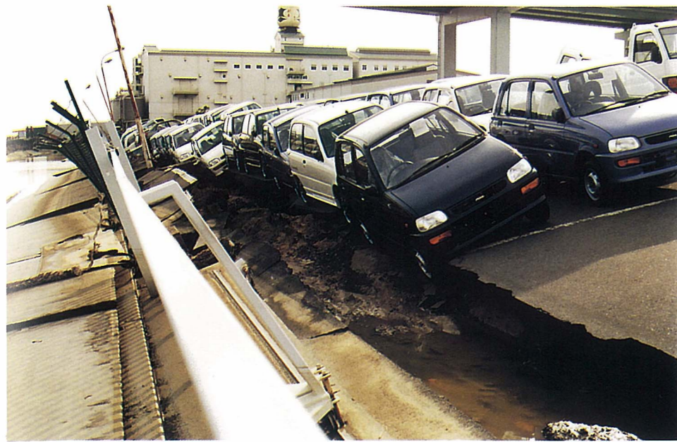
9. 深江浜東側背後地盤の沈下に伴う車の被害
