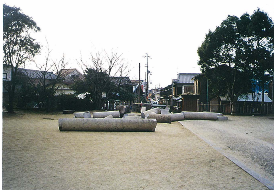
淡-6 郡家地区の神社鳥居の倒壊状況
