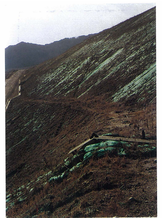
淡-20 → 花崗岩のり面中に 発生したずれ (N40°E)
