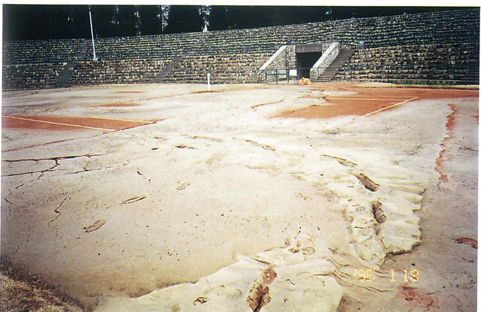
28. 鞠公園センターコートでの噴砂
