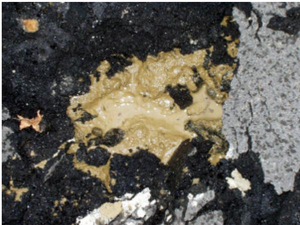
写真-4.4.35 道路陥没部で見られた噴砂
