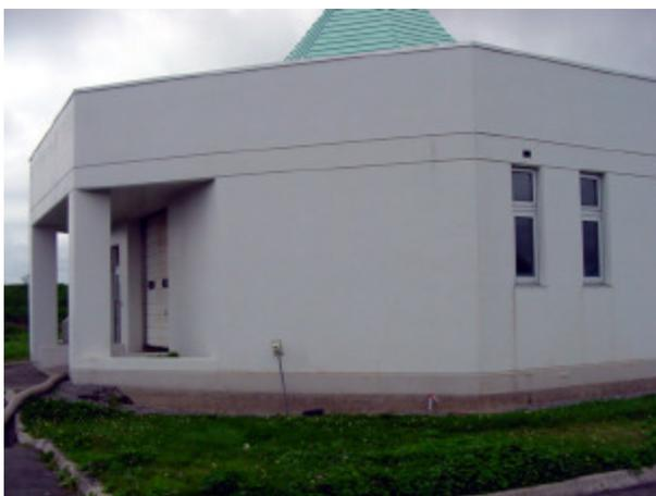
写真-4.4.13 建物周辺地盤の沈下
