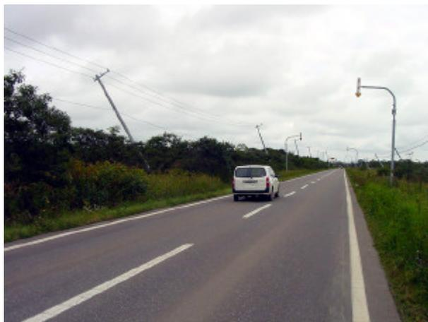
写真-4.2.18 電柱の傾斜（大津地区）
