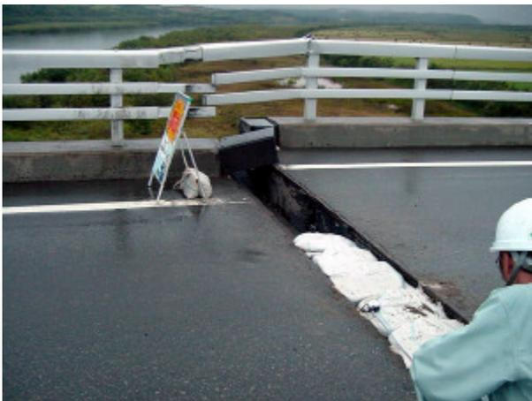
写真-4.2.16 河川横断部との境界では開口と段差が生じている（同上）
