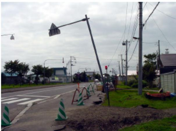
写真-4.4.5 下水管理設箇所の陥没
