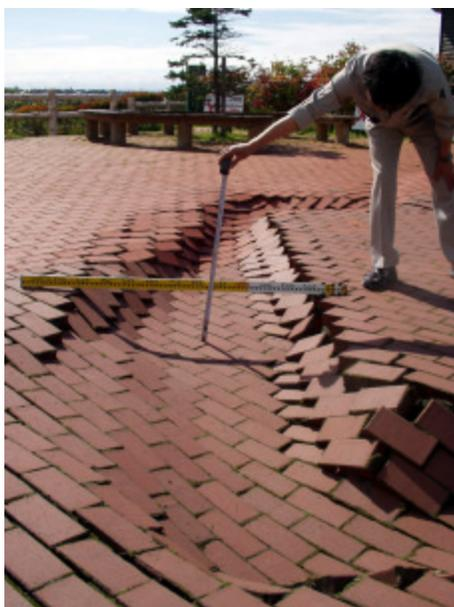
写真-4.4.38 浄化槽周辺地盤の沈下
