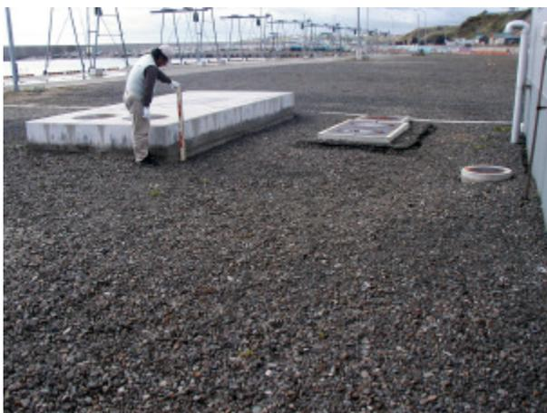
写真-4.3.47 岸壁背後用地の沈下
