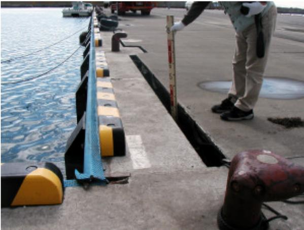
写真-4.3.43 岸壁のはらみ出しによるエプロンとの開口（千代の浦漁港）
