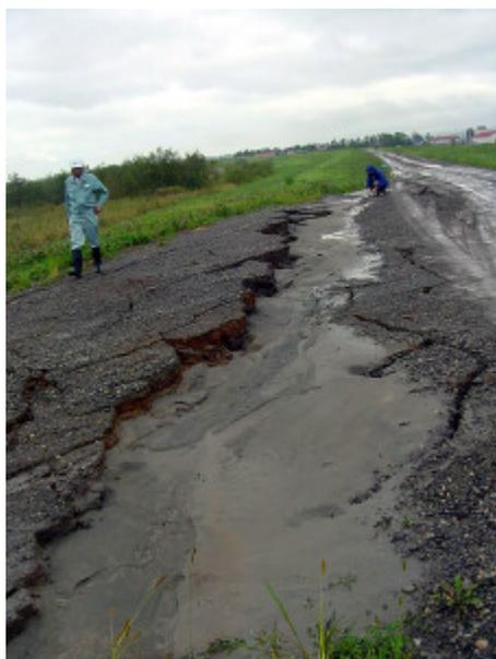
写真-4.1.18 堤防天端の取付道路に生じた噴砂（同上）
