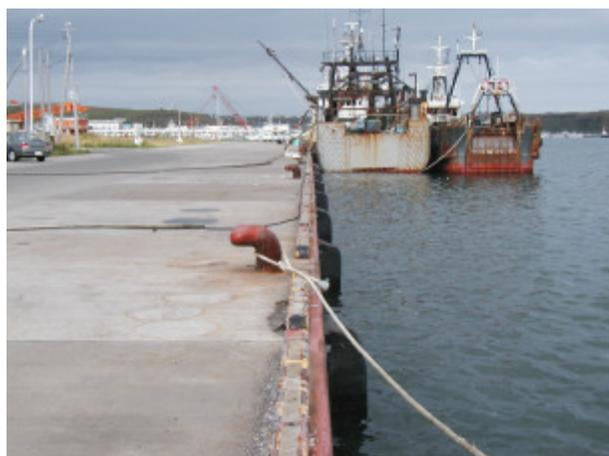
写真-4.3.38 岸壁法線の若干のせり出し（花咲港中央地区-5m岸壁）
