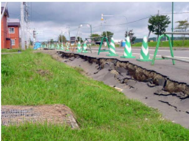
写真-4.4.6 下水管理設箇所の陥没
