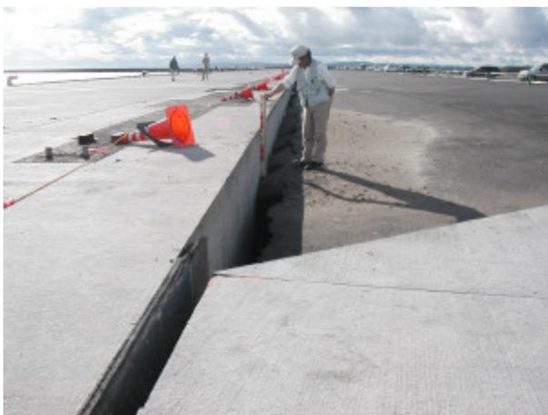
写真-4.3.12 南側-14m 岸壁隅角部エプロンの沈下
