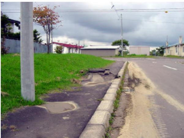
写真-4.5.12 下水道マンホールの突出と噴砂（同上）
