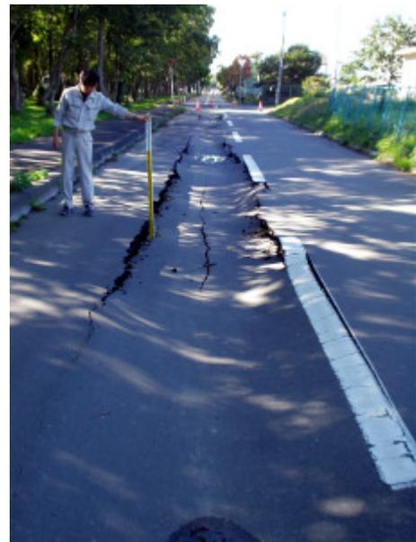
写真-4.4.36 管路埋設道路の陥没
