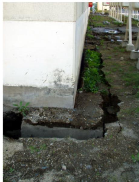
写真-4.5.24 建物周辺地盤の沈下
