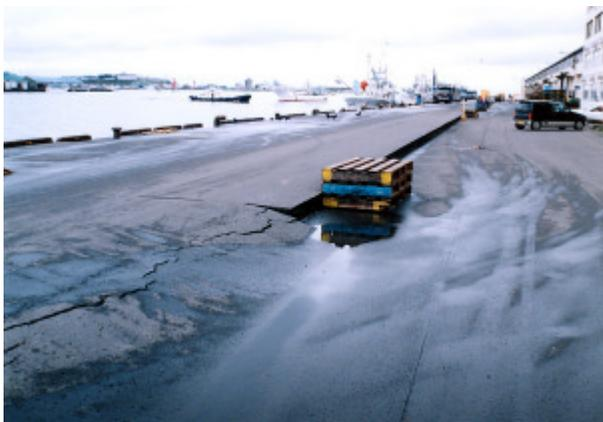
写真-4.3.7 東側岸壁エプロンの段差（漁業埠頭東側岸壁）
