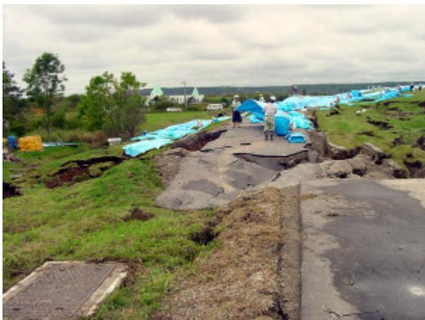
写真-4.1.5 やや下流側の堤防すべり崩壊によって寸断された道路（同上）
