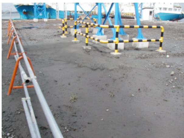
写真-4.3.9 南新埠頭岸壁背後地盤の噴砂
