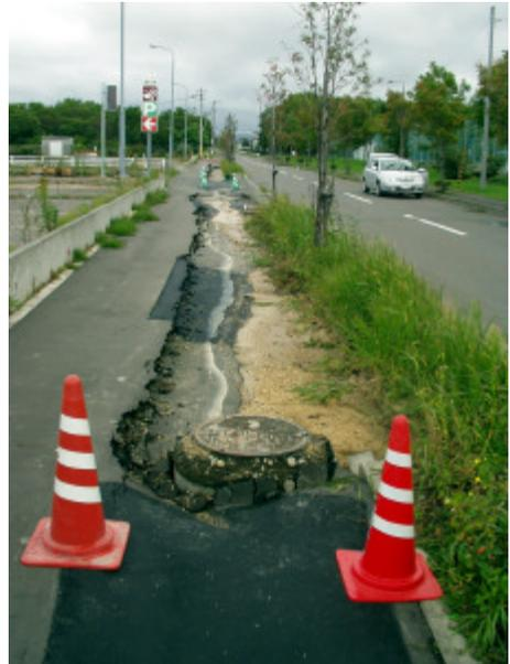
写真-4.4.34 管路埋設道路の陥没
