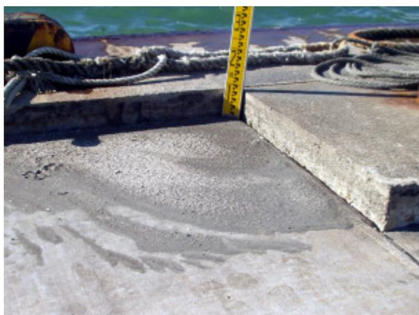
写真-4.3.40 上部工とエプロンの段差（鶴川漁港）
