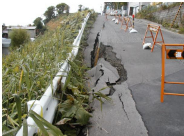
写真-4.2.27 台地斜面の道路崩壊
