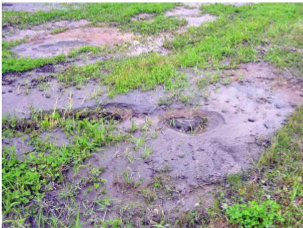
写真-4.1.10 堤外側のり尻に生じた噴砂（同上）
