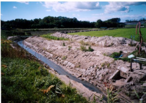
写真-4.6.6 噴出土砂が流入した水路。すでに排土されている
