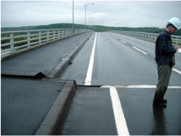
写真-4.2.14 河川横断部との境界における橋桁のずれ（総65cm）（十勝河口橋）
