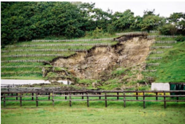
写真-4.2.26 海成段丘崖の表層風化部の滑落（静内町駒場）
