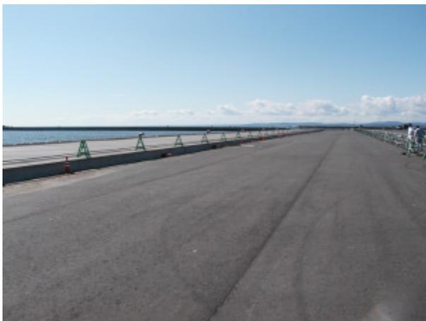
写真-4.3.11 南側-14m 岸壁エプロンの沈下
