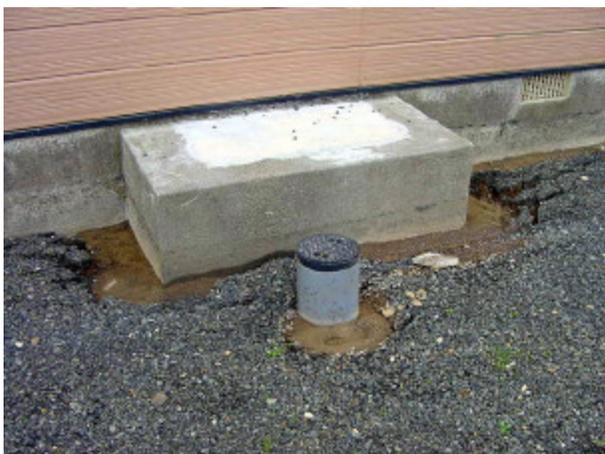
写真-4.4.9 住宅の基礎地盤の沈下と
