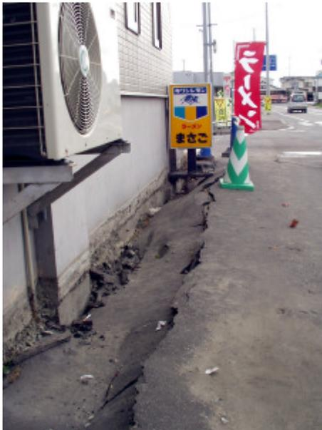
写真-4.5.23 建物周辺地盤の沈下
