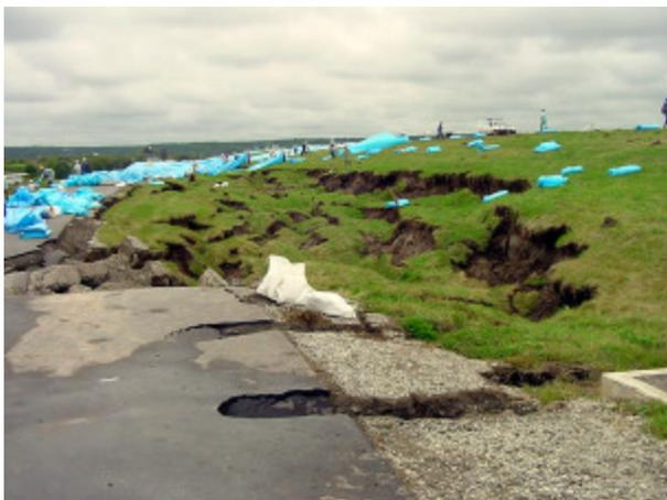
写真-4.1.6 やや下流側の堤防すべり崩壊（十勝川右岸堤防大津地区）
