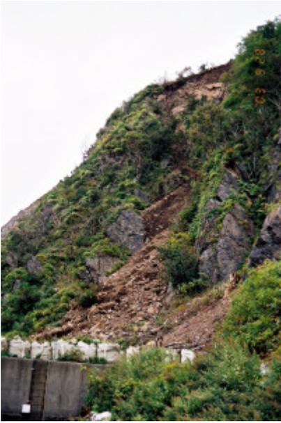
写真-4.2.24 崖上部の表層風化部の崩落（目黒の南1）
