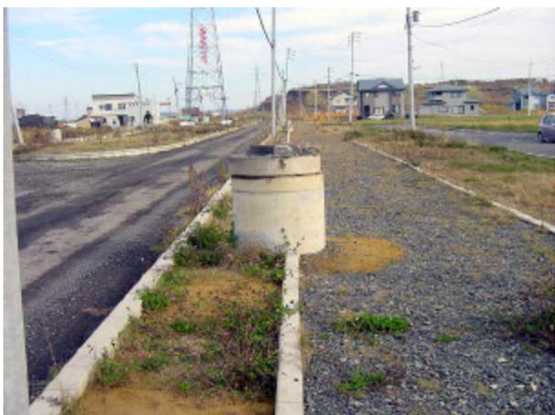
写真-4.4.26 東側で最も突出したマンホールと噴砂（同上）
