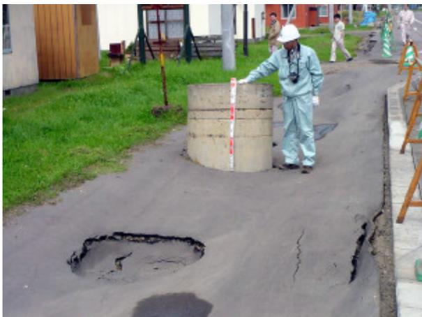
写真-4.4.4 約1m突出した中間のマ
