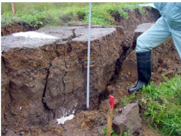
写真-4.1.23 天端のり肩のすべりによる段差（同上）
