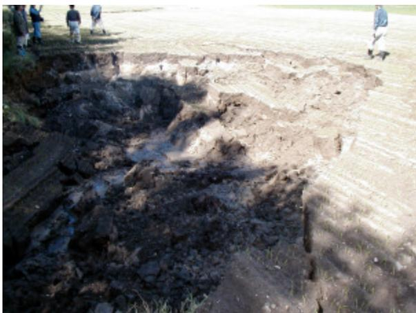
写真-4.6.9 傾斜地の地すべり滑落崖（地点 ）
