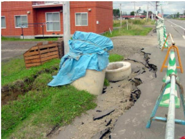
写真-4.4.7 約 1.5m 突出した北側のマンホール（音別町川東地区）
