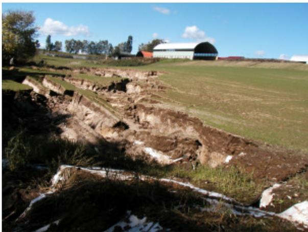
写真-4.6.10 傾斜地の地すべり滑落崖（地点）
