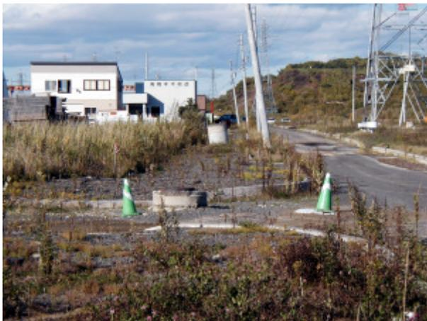
写真-4.4.23 最大1.26m 突出した道路西側のマンホール列と傾斜した電柱（東陽団地）
