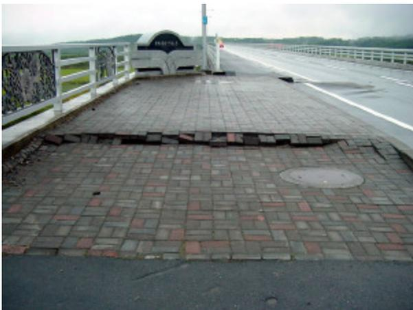
写真-4.2.7 左岸橋台部背後地盤の沈下による段差（同上）
