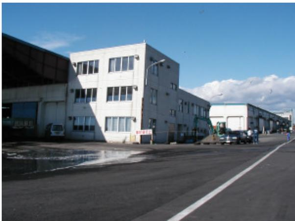
写真-4.3.5 南側岸壁に面している沈下したままの魚荷捌所建屋。以前の地震で傾いたまま使用されている
