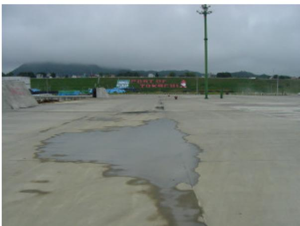
写真-4.3.28 エプロンの沈下による水
