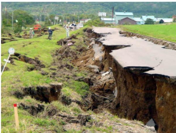
写真-4.1.2 堤防のすべり崩壊 ( 同上 )
