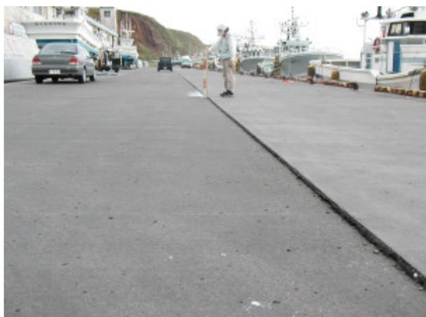
写真-4.3.39 裏込め部の沈下（花咲港中央地区-4.5m岸壁）
