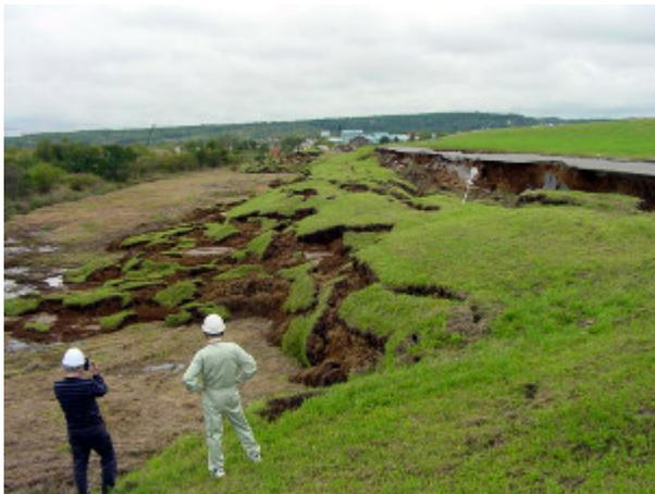
写真-4.1.3 崩壊末端部（十勝川右岸堤防大津地区）
