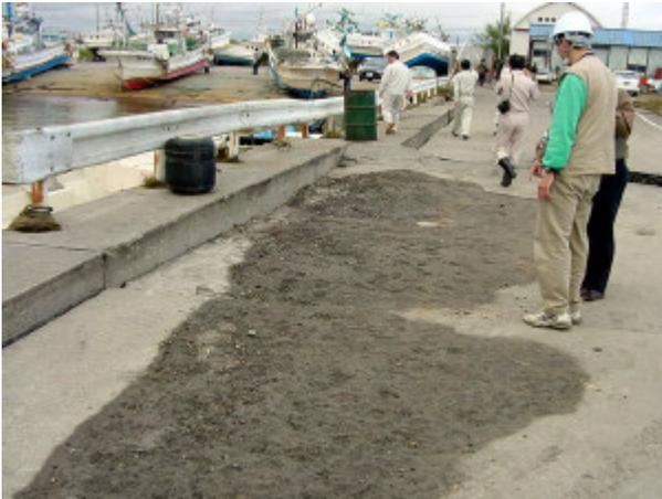
写真-4.3.42 岸壁のはらみ出しと背後地盤の沈下と噴砂（大津漁港）
