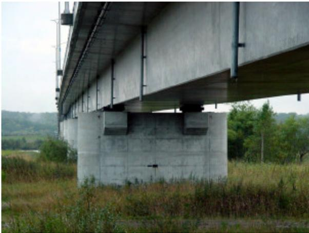
写真-4.2.11 橋桁が弧状に移動したため、折れ曲がっている（十勝河口橋）
