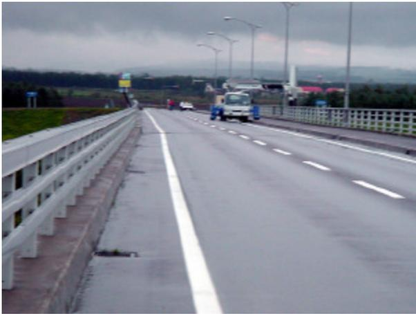
写真-4.2.12 橋桁が弧状に移動したため、折れ曲がっている（同上）
