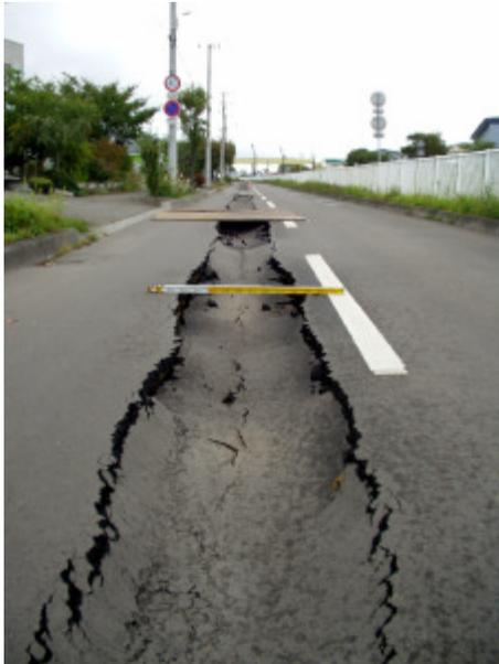
写真-4.4.33 管路埋設道路の陥没
