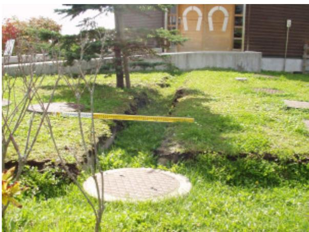
写真-4.4.39 浄化槽周辺地盤の沈下
