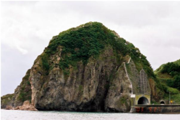
写真-4.2.25 岬の先端が高さ約 20m にわたり海上へ崩落（塩釜トンネル海側）
