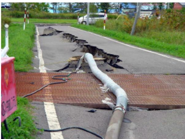
写真-4.4.15 マンホールの突出のためポンプにて下水を処理している
