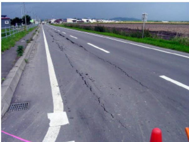
図-4.4.32 下水管路埋設地盤の沈下（同上）
