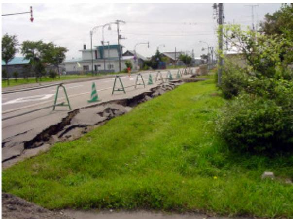
写真-4.4.3 下水管理設箇所の陥没
