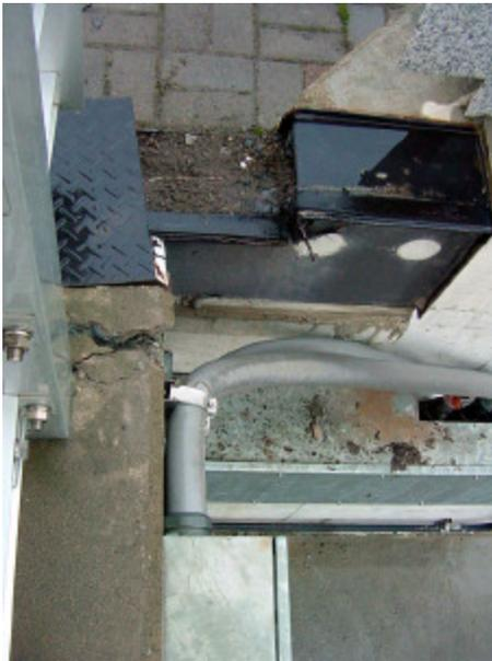
写真-4.2.6 左岸橋台と橋桁のずれ（約60cm）（同上）
