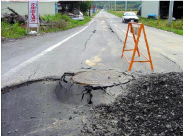
図-4.4.30 マンホールの突出と埋設地盤の沈下（豊頃町茂岩）
