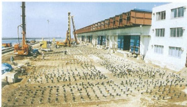
写真-4.3.49 北海道東方沖地震後の対策工法（プラスチックドレーン）<sup>4)</sup>
