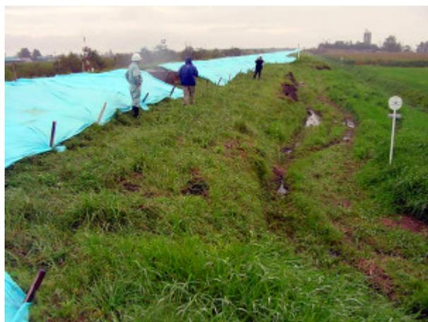
写真-4.1.21 下頃辺川右岸堤防の滑りとはらみ出し
