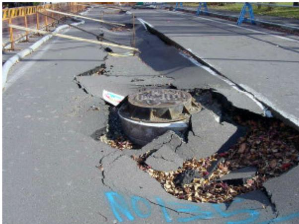
写真-4.4.28 阿寒町役場脇の下水道埋設道路（未対策区間）の陥没
