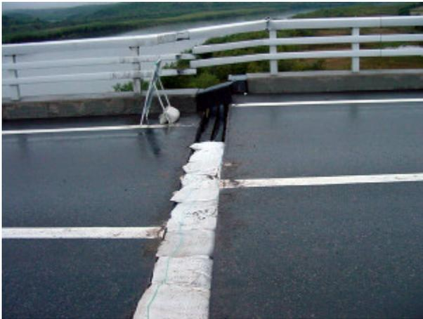
写真-4.2.15 河川横断部との境界における橋桁のずれ。弧状に移動したため、開いている（同上）
