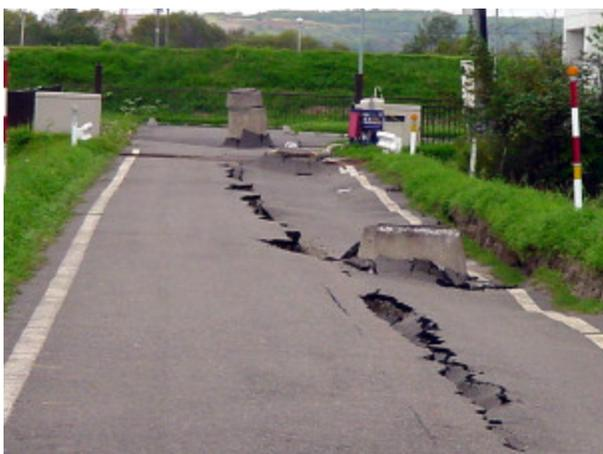
写真-4.4.14 管路埋設道路の陥没
