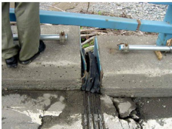
写真-4.2.2 橋桁の段差の近景（同上）
