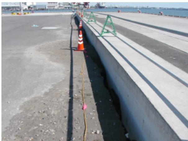
写真-4.3.13 岸壁ケーソン背後エプロンの沈下の近景（南側-14m 岸壁）
