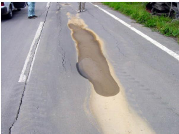
図-4.4.31 下水管路埋設地盤の沈下及び噴砂と見られる細粒の砂（同上）
