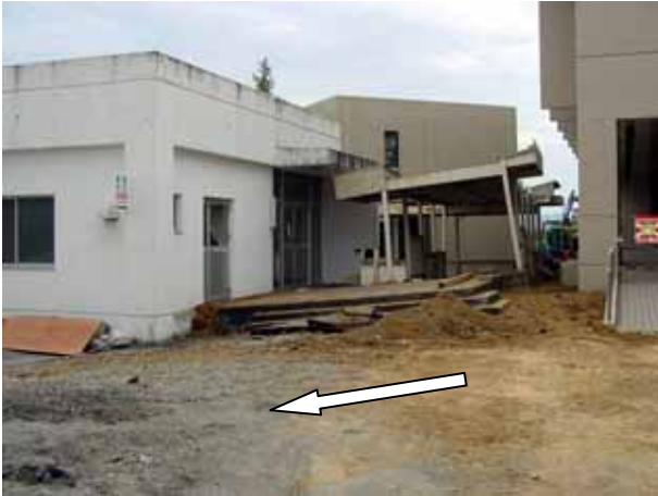
写真4.6.26 連絡通路の開口
