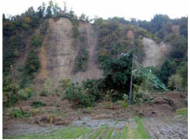
写真4.2.16 崩壊した崖の全景（並行する国道17号線より撮影）
