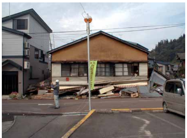
写真4.6.12 建物の1階部分が崩壊
