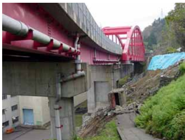
写真4.3.29 斜面上に建設された山辺橋のアプローチ部の橋脚。右側は崩壊した斜面、左側は信濃川発電所である
