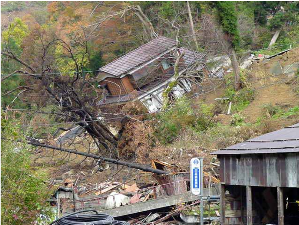
斜面上の家屋の滑落（長岡市濁沢）
