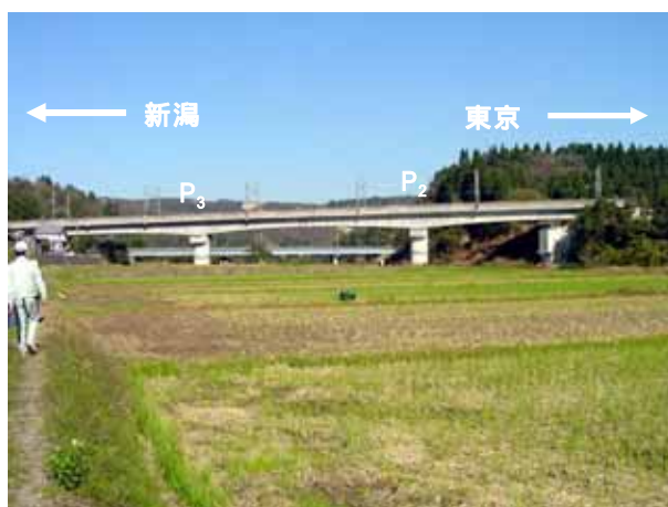
写真4.2.7 上越新幹線魚野川橋梁の全景。背後は上越線の橋梁
