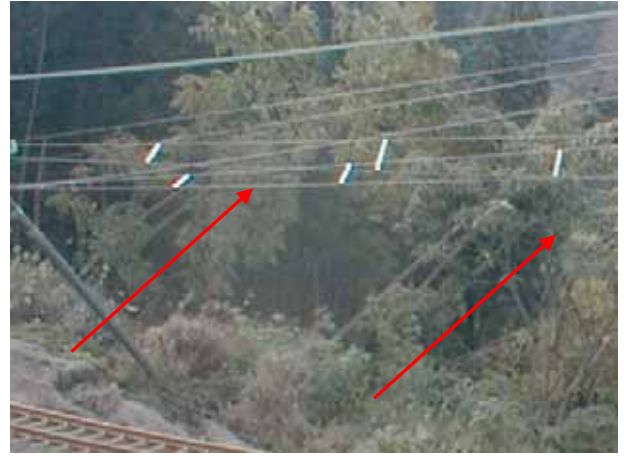
写真4.3.14 木の先端が崩壊側に傾いている
