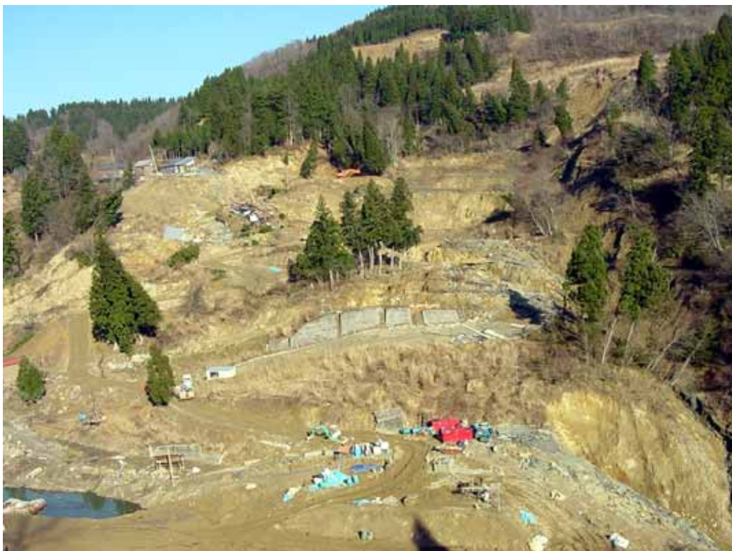
河道を閉塞した大規模な地すべり（山古志村寺野）
