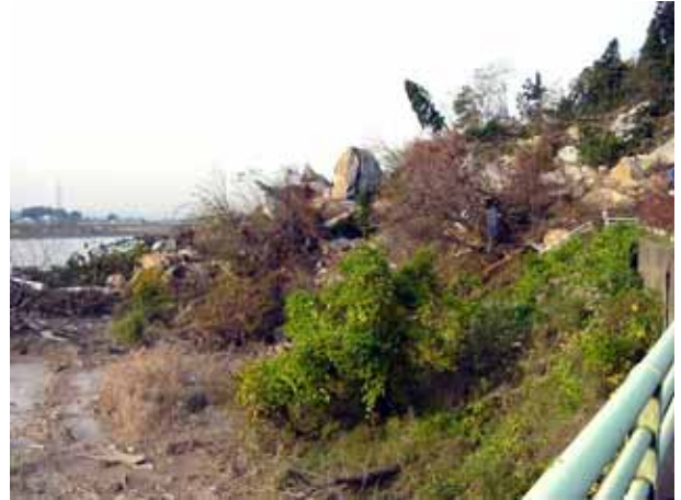
写真4.5.3 同左。崩壊土砂は道路を埋没して信濃川に押し出している
