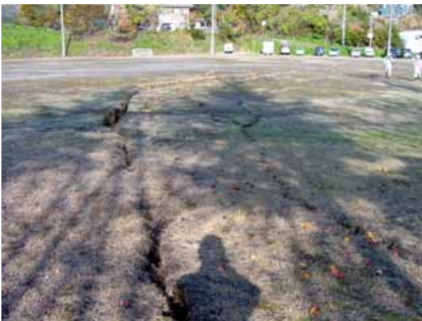
写真4.6.44 グラウンドに出来た亀裂
