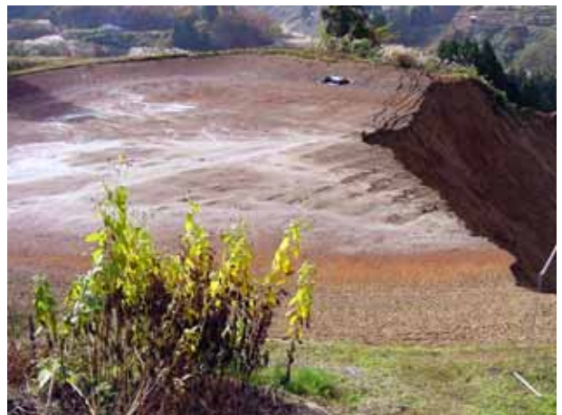
写真4.5.22 崩壊頂部の養殖池。崩壊のため水が抜けている
