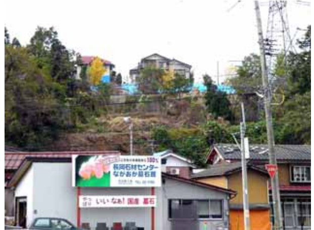
写真 4.6.3 下方から見た高町1丁目東斜面の崩壊（位置）
