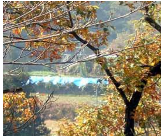
写真4.4.9 鉄塔基礎地盤が被害を受けてビニルシートで覆われている(十日町市樽沢付近)
