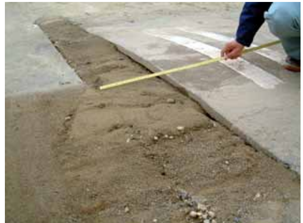
写真4.7.6 噴砂の様子。礫も点在している
