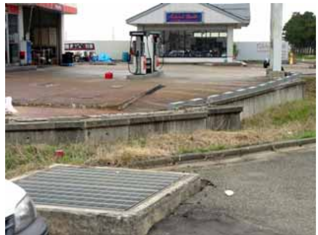
写真4.4.4 ガソリンスタンド地下タンクの浮上（長岡市高畑）
