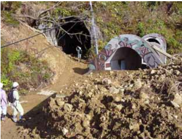
写真4.5.28 羽黒トンネルと隣接する歩行者用トンネルの西側入口
