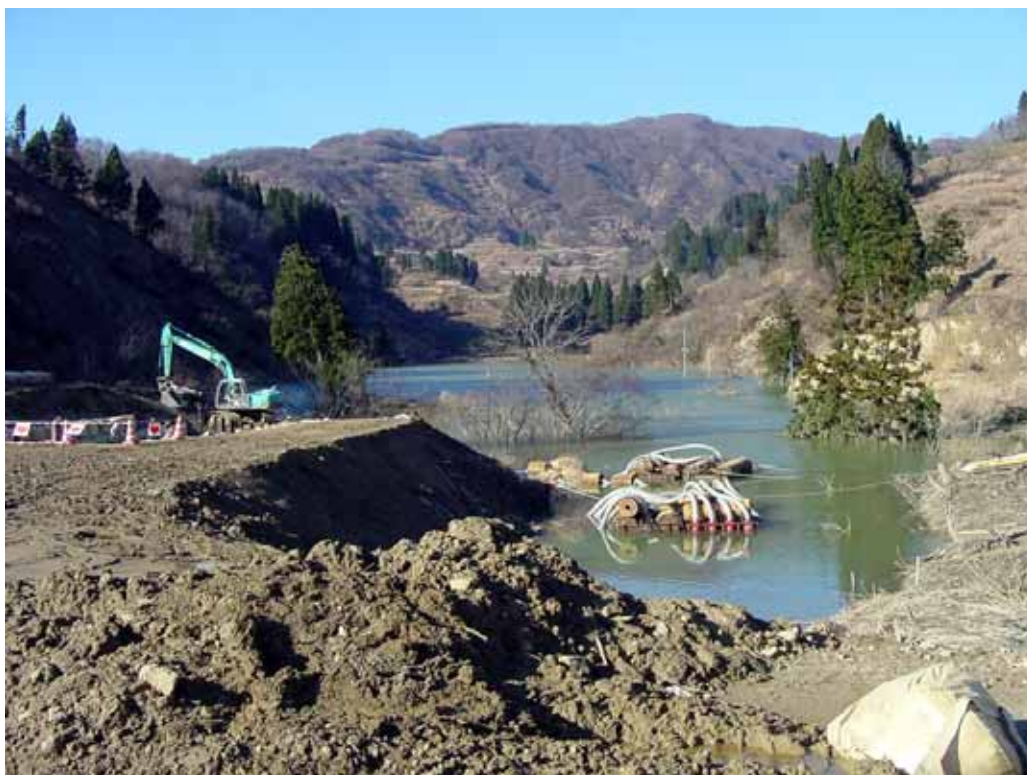
芋川を閉塞した崩壊土砂（山古志村寺野）
