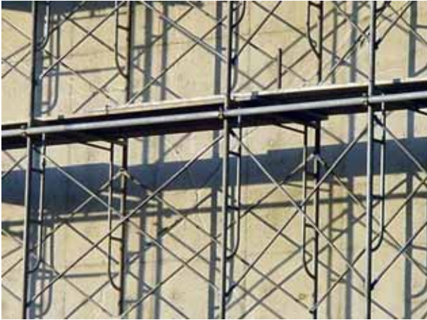
写真4.3.9 橋脚表面の亀裂の近景
