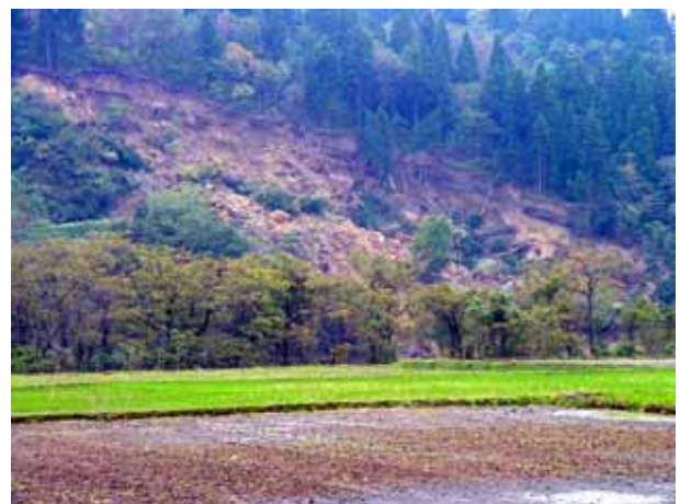
写真4.5.9 南側の規模の小さい方の崩壊(対岸より見る)
