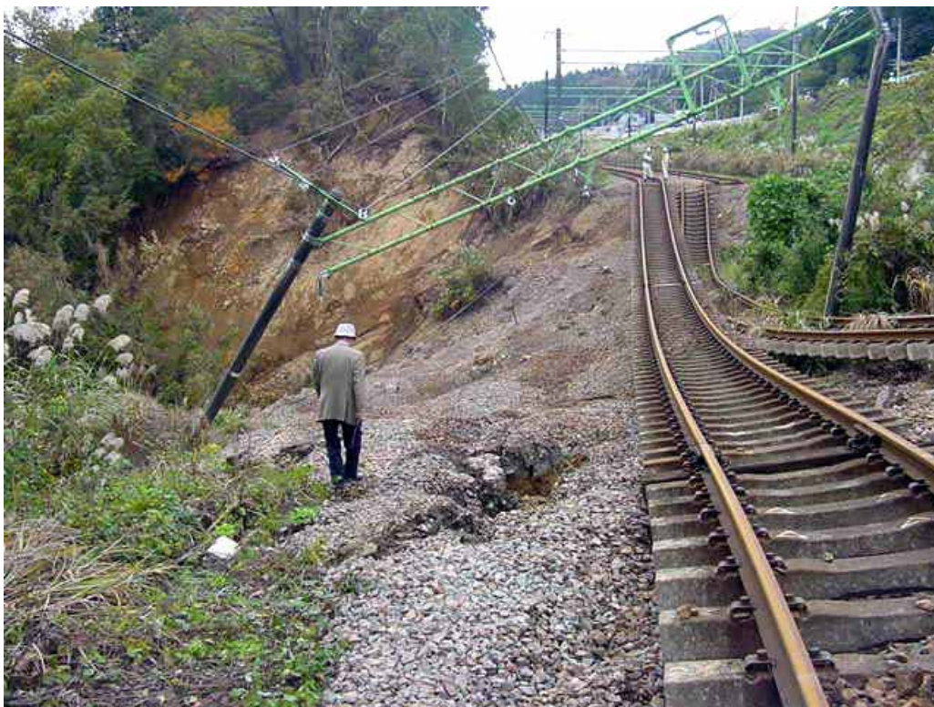
線路路盤の崩壊（JR 上越線 小千谷 - 越後川口間）
