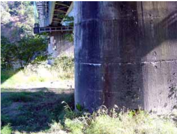
写真4.2.12 新幹線に隣接する上越線の橋脚。無被害である
