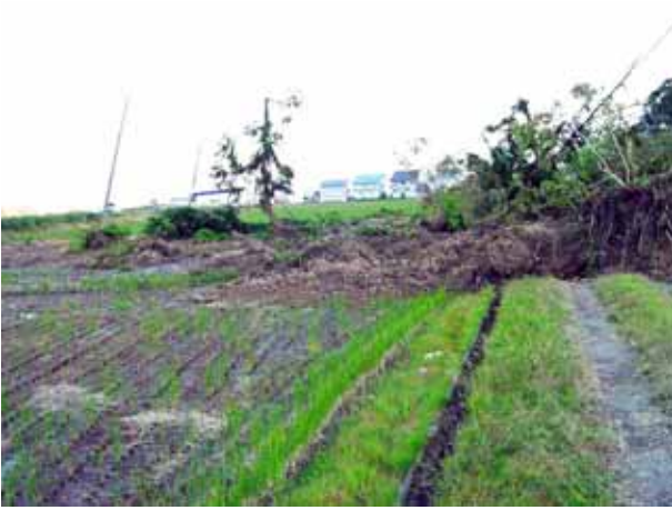
写真4.2.15 崩壊土砂は線路を乗り越えて水田にまで達した
