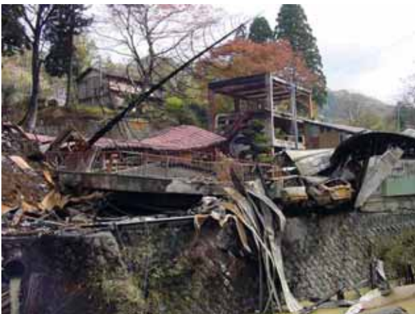
写真4.5.15 川沿いの建物の崩壊
