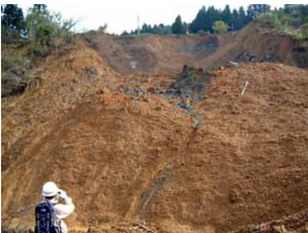
写真4.5.17 県道より見た崩壊地点
