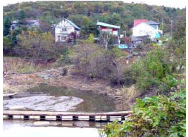
写真4.6.40 ため池沿いの斜面崩壊
