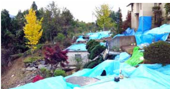
写真4.6.32 高町団地1丁目の東側斜面崩壊(位置 )
