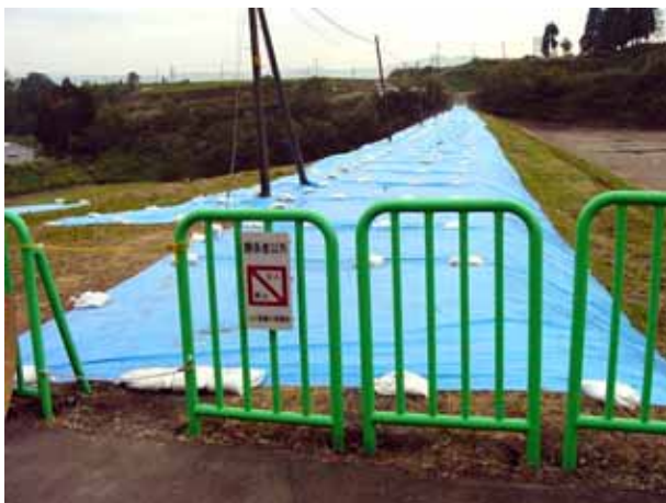
写真4.1.11 堤体の頂部にかけられたシート
