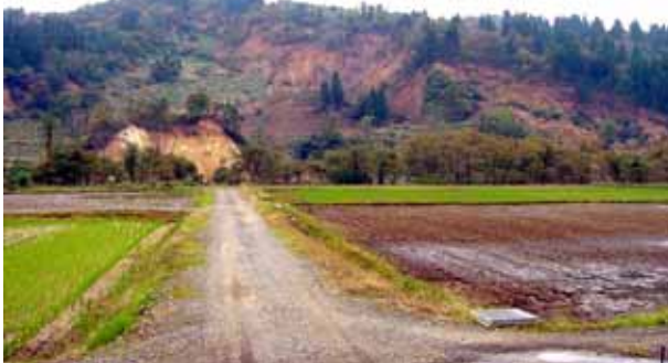
写真4.5.8 信濃川左岸より見た崩壊地点。中央と右側の2箇所の崩壊が生じている
