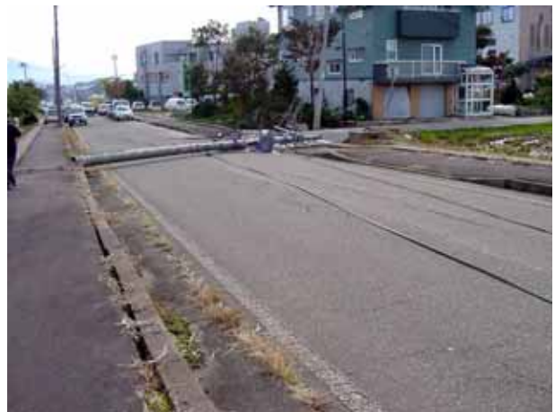
写真4.4.11 倒壊した電柱(同左)
