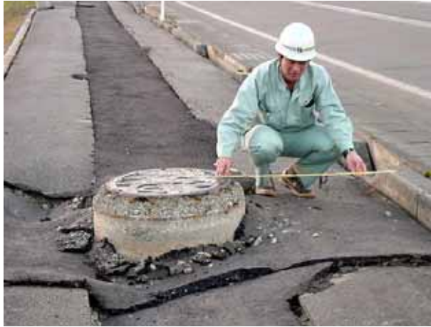
写真4.4.3 国道291号沿線（小千谷市桜町）の下水道マンホール浮上
