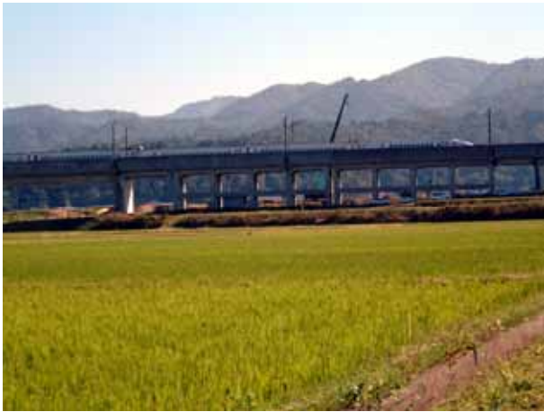
写真4.2.1 脱線して停車した上越新幹線「とき325号」
