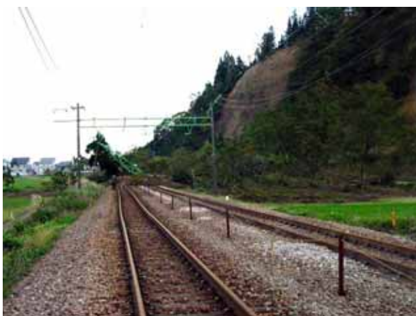
写真4.2.13 崩壊土砂によって埋没した線路
