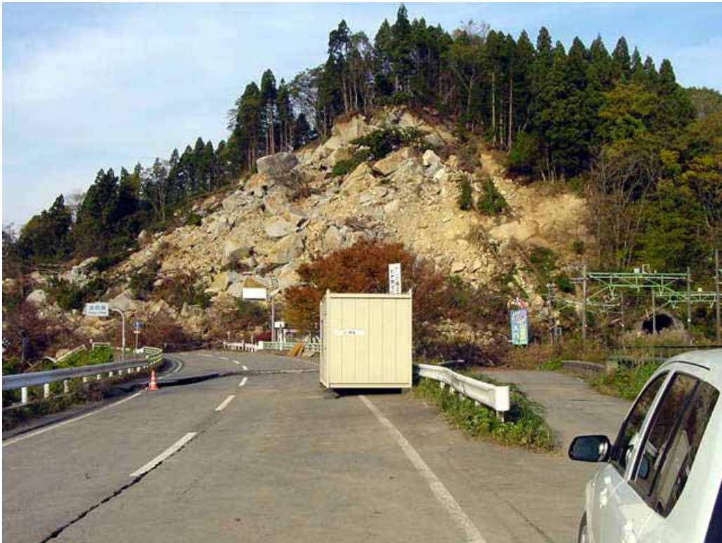
車を埋没した斜面崩壊（長岡市妙見町白岩）
