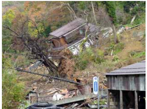
写真4.5.14 同左。滑り落ちた民家の近景
