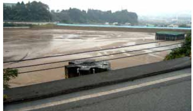
写真4.1.14 調整池内は空の状態となっていた
