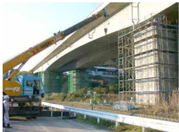
写真4.3.8 補修を始めた橋脚の全景
