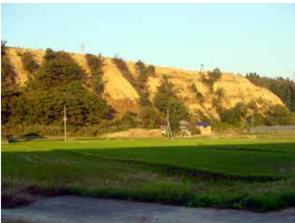
写真4.3.47 堀之内町竜光地区。崩壊土砂により埋没した県道23号線。
