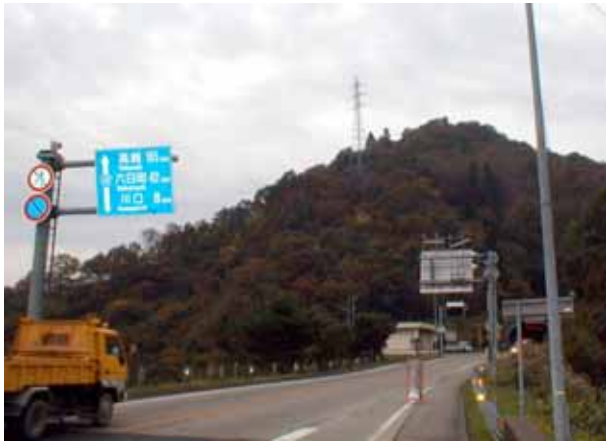
写真4.4.7 座屈した送電鉄塔。下は国道17号小千谷第二トンネル北側坑口
