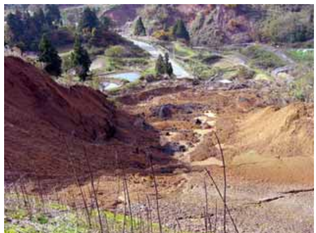
写真4.5.18 崩壊頂部より見おろした崩壊地点
