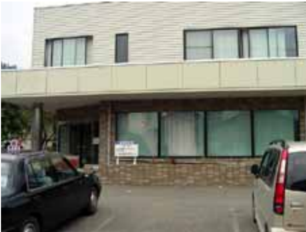
写真4.6.13 新しい建物は窓ガラスが割れる程度で外見的には被害は見られなかった
