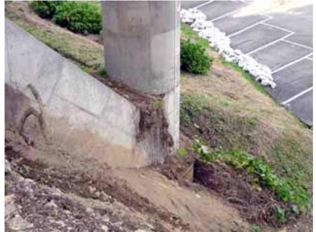
写真4.3.31 橋脚下部の近景
