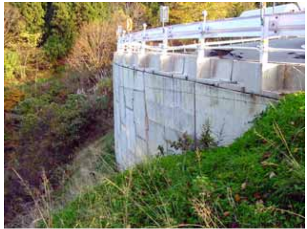
写真4.3.58 同左。補強土工法で作られている擁壁
