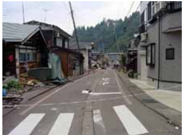
写真4.6.8 旧街道沿いの住宅の被害。道路も中央の消雪管付近で段差ができています
