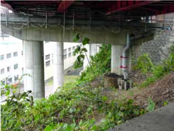
写真4.3.30 山辺橋西側アプローチ部分の橋脚
