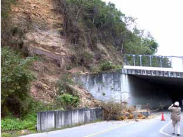
写真4.3.45(1) 十日町市石橋。崩落土砂がスノーシェッド前の道路を塞ぐ（県道49号線）
