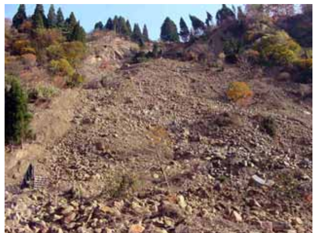
写真4.5.25 下から見た崩壊斜面の近景
