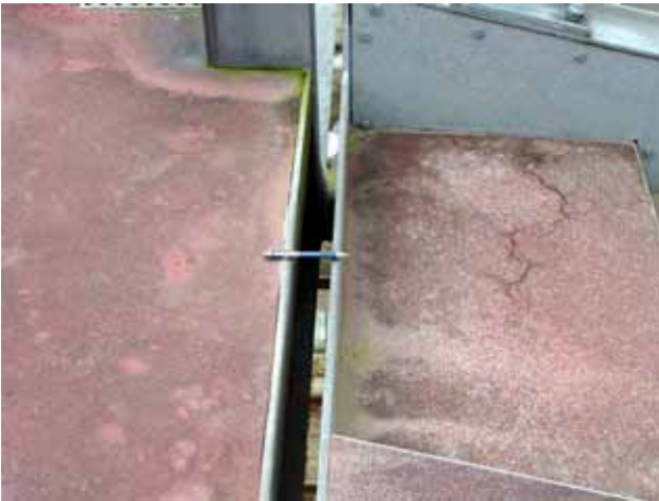
写真4.2.26 駅に隣接する跨線橋の開口
