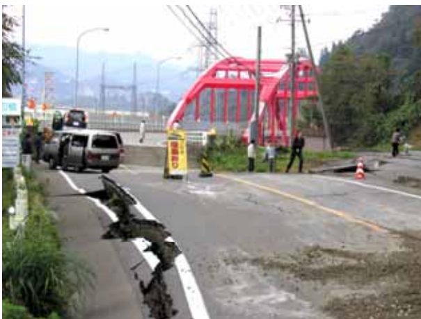
写真4.3.32 取付道路の沈下に伴う段差
