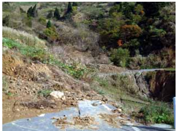
写真4.3.52 道路沿いの斜面崩壊による道路の埋没(位置)
