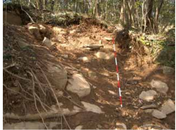
写真4.3.23 落石の抜け跡（同左）
