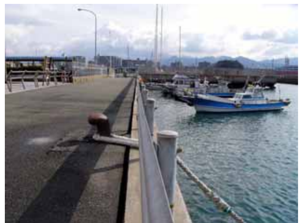
写真4.1.29 姪浜漁港の岸壁
