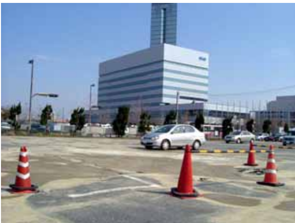
写真4.4.13 駐車場での噴砂(百道浜 福岡タ ワー付近)
