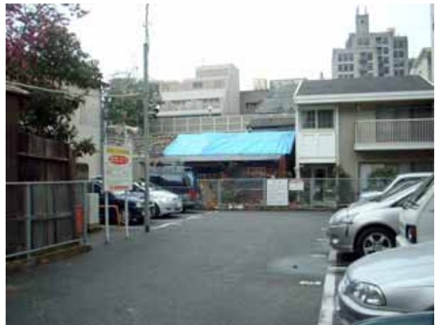
写真4.5.6 木造家屋の被害
