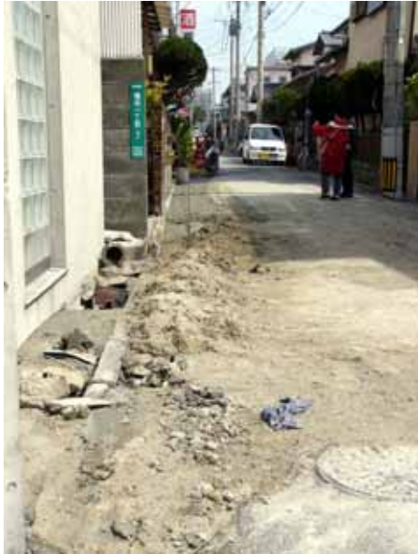
写真4.4.11 住宅地での噴砂(福 浜一丁目)
