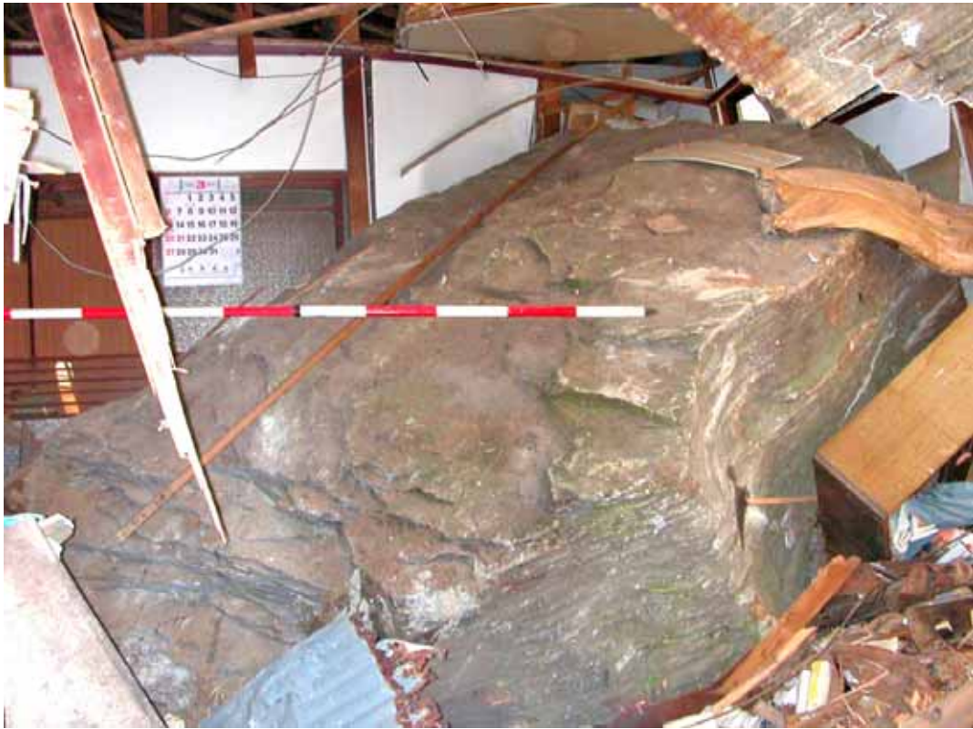
民家を直撃した巨大落石(能古島のこ)
