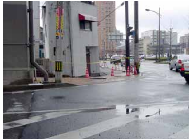
写真4.5.20 博多埠頭付近の傾いた建物。沈下も生じている
