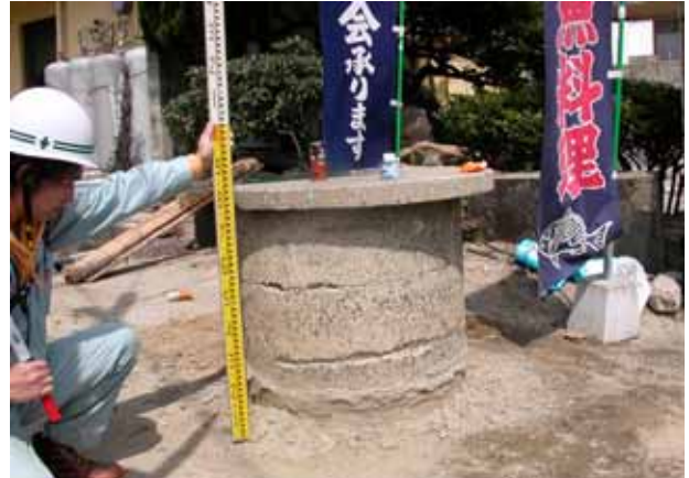
写真4.3.9 井戸の抜け上がり
