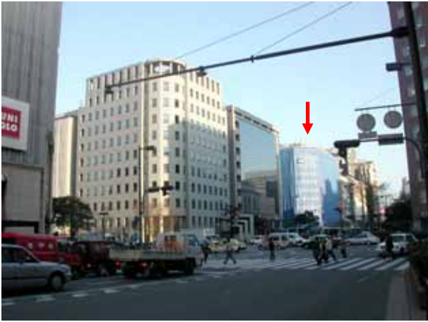
写真4.5.19 ガラスが割れて落下した天神のビル
