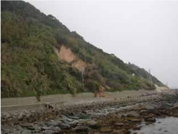
写真4.3.27 まさ土斜面の崩壊。崩壊は道路まで達している
