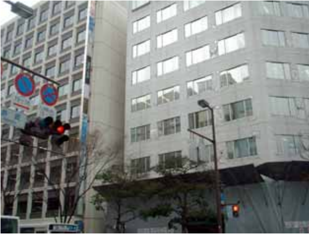
写真4.5.14 RC造の被害
