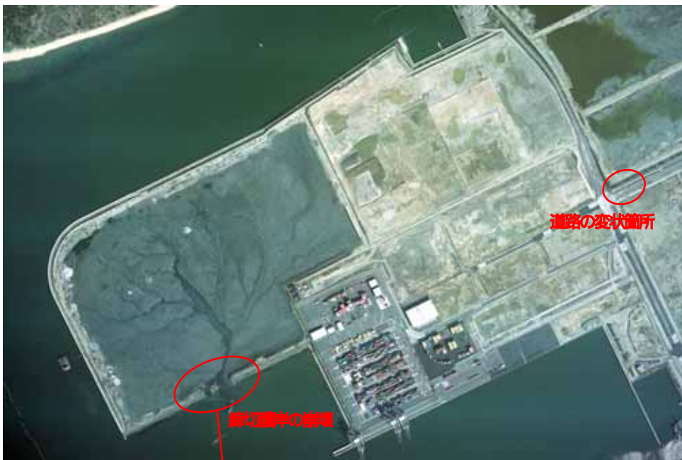
写真4.2.20 地震後のアイランドシティの空中写真(国土地理院撮影)
