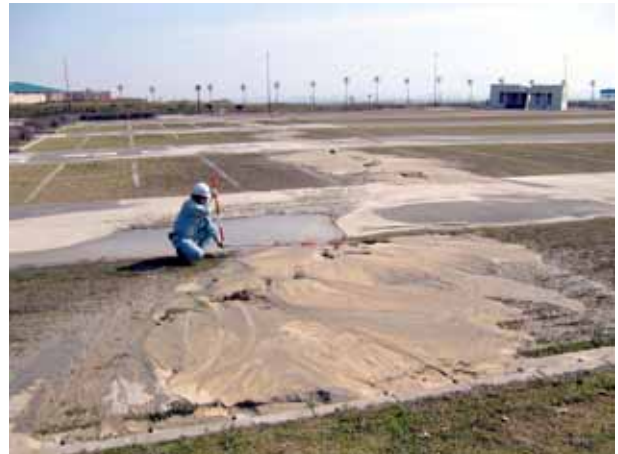
写真4.4.2 奥は傾いたトイレ（海の中道海浜公園）
