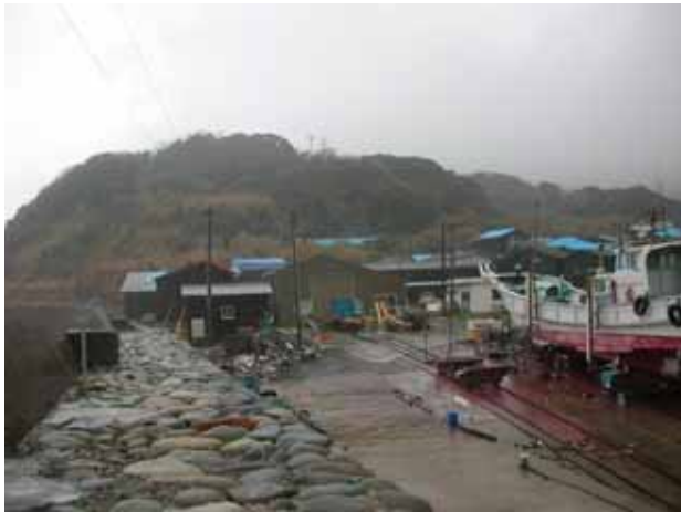
写真4.3.14 港民家背後の斜面崩壊(西浦漁港)
