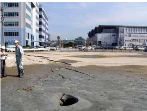
写真4.4.9 埠頭中央付近での噴砂（中央埠頭）
