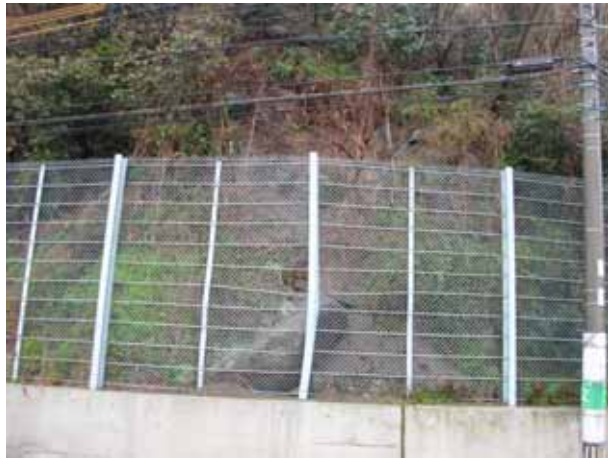
写真4.3.10 花崗岩コアストーンの抜け落ち
