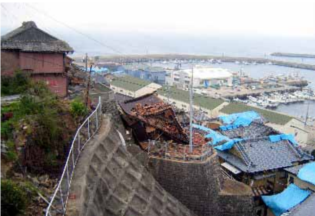
写真 4.5.1 玄海島の家屋崩壊
