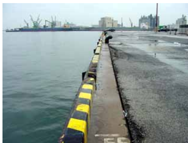
写真4.1.22 箱崎埠頭岸壁前面の状況
