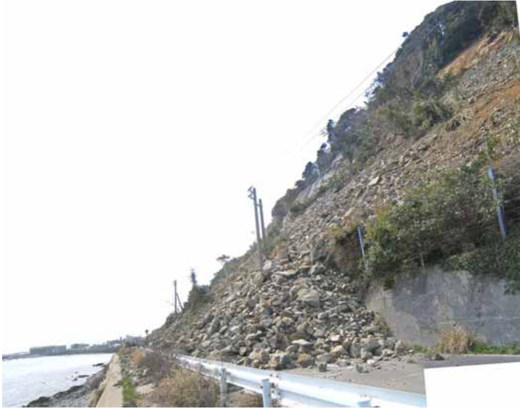
斜面崩壊により埋まった志賀島の外周道路
