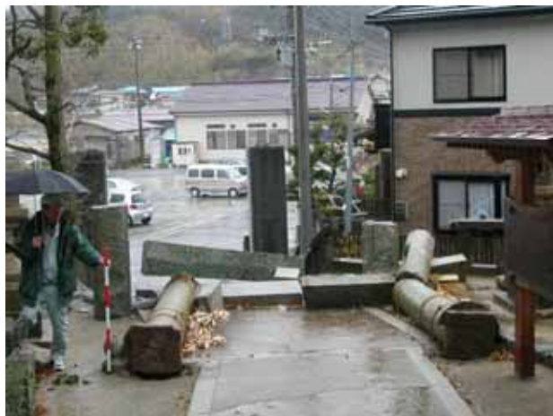
写真4.3.16 鳥居の倒壊(宮之浦漁港)
