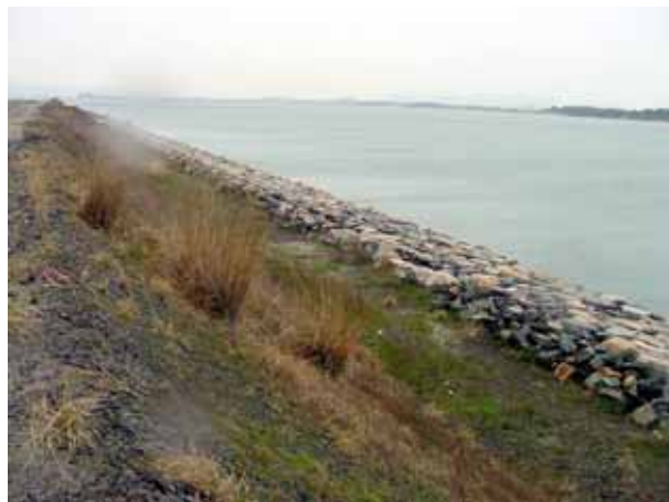
写真4.2.26 第4工区北側の護岸は無被災であった。
