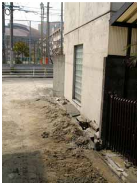
写真4.2.18 福浜の住宅地で生じた噴砂
