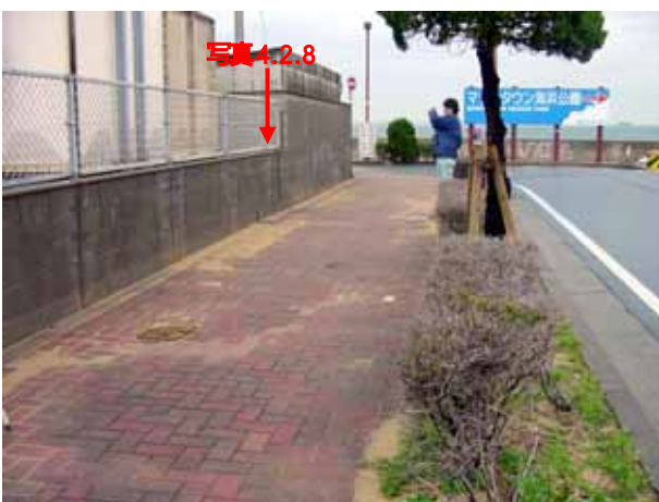
写真4.2.7 歩道に生じた噴砂(能古島渡船場付近)
