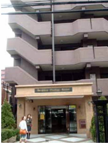
写真4.5.9 RC造の被害。要注意（黄色）の張り紙があった
