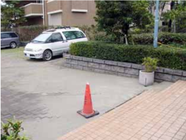
写真4.4.17 海岸近くのマンション内の噴砂（愛宕浜）
