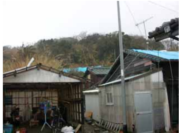
写真4.3.15 民家の被災状況(同左)
