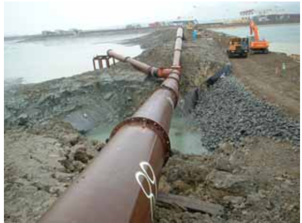
写真4.2.23 崩壊箇所の復旧状況
