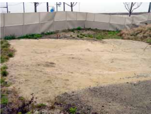
写真4.4.3 道路変状箇所での噴砂（アイランドシティ）
