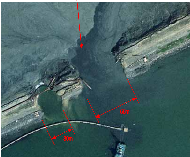
写真4.2.21 アイランドシティ締切護岸崩壊箇所の拡大(国土地理院撮影)
