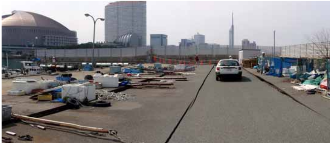
写真4.1.28 護岸の頂部に不陸が生じている（伊崎漁港）
