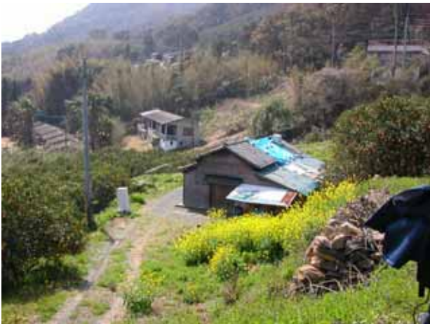
写真4.3.18 巨大落石が突入した民家
