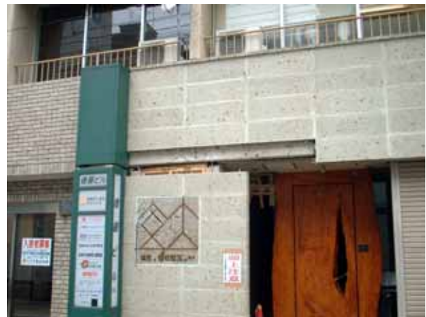
写真4.5.18 外壁の破損
