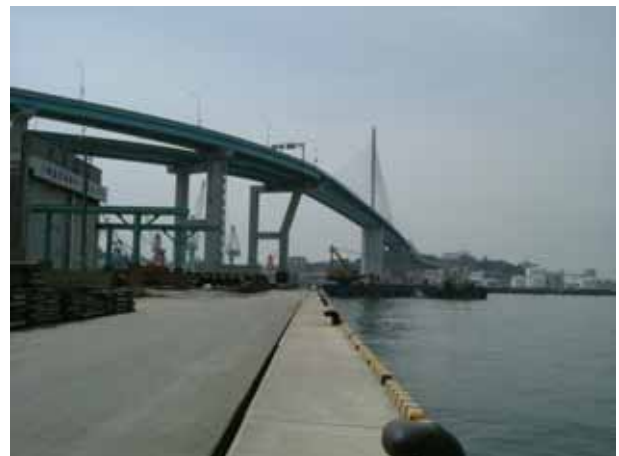
写真 4.1.2 岸壁の変状 (須崎埠頭)
