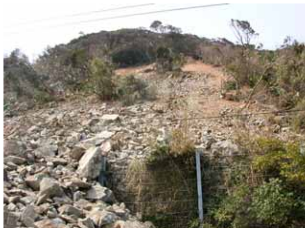
写真4.3.2 同左正面より望む
