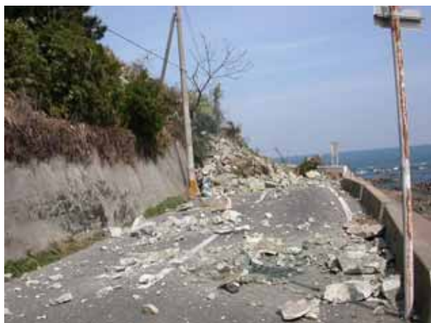
写真4.3.3 本震翌日の崩壊状況
