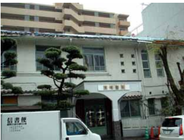
写真4.5.7 木造家屋の被害
