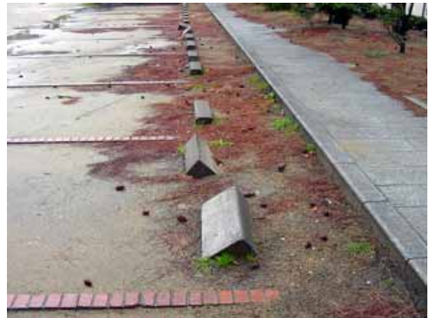
写真4.2.2 車止めの傾斜・沈下(愛宕浜地区)
