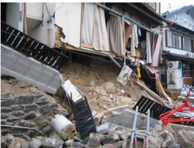
写真 4.5.2 同上。石積みの崩壊による家屋の被害
