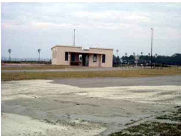
写真4.2.36 公園内のトイレで生じた不等沈下
