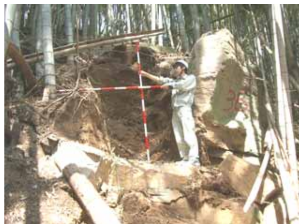
写真4.3.21 落石の抜け跡
