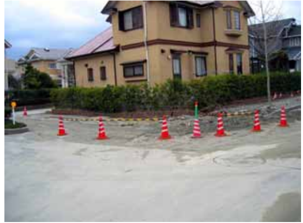
写真4.4.18 住宅地での噴砂（愛宕浜4丁目）
