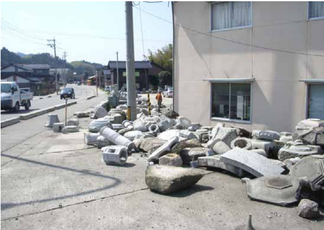
石灯籠の倒壊（輪島市小伊勢町）
