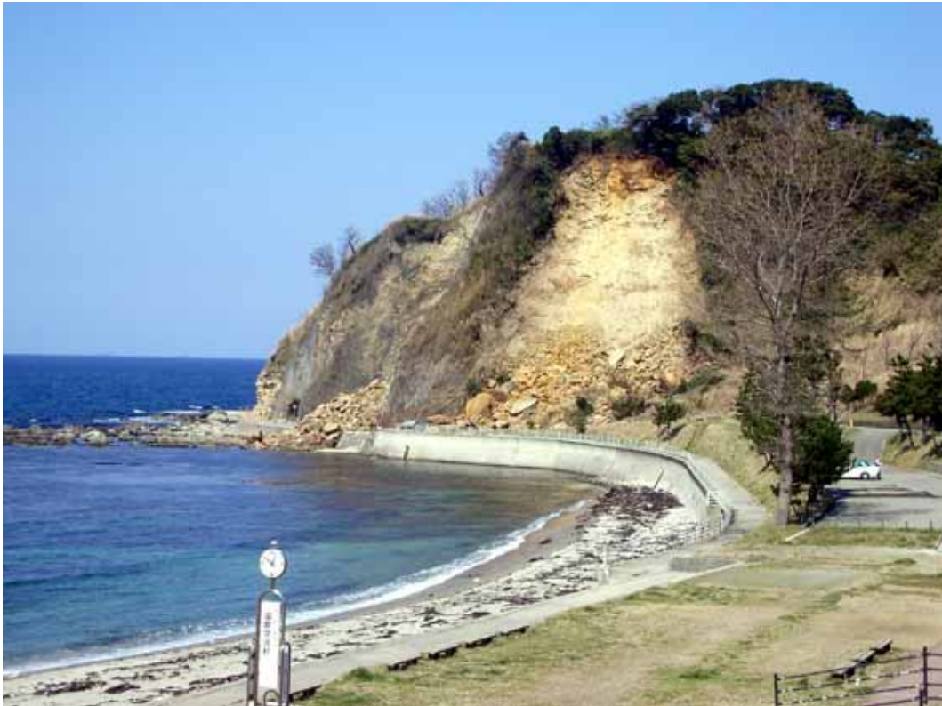
斜面崩壊（輪島市竜ガ崎灯台付近）
