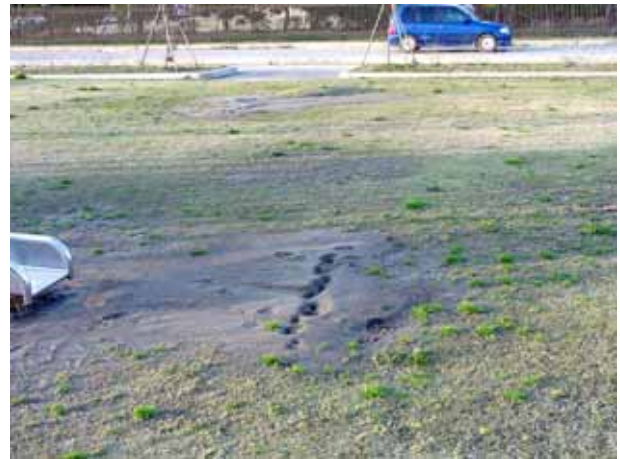
写真 4.5.10 道下地区西側の公園で見られた噴砂
