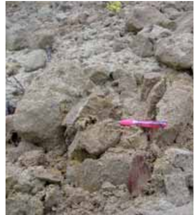
写真 4.3.9 崩積土近景。固結度の低い砂岩で、指圧で砂状化する程度の硬さで
