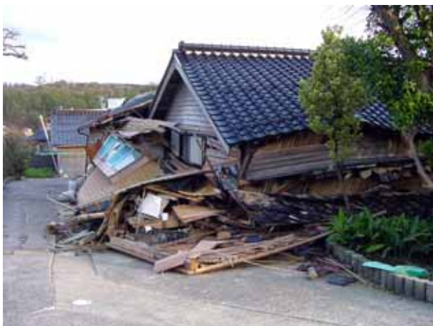
写真 4.4.17 古い木造家屋の倒壊
