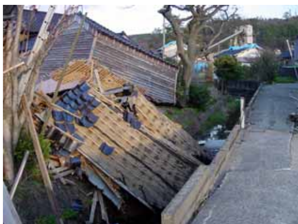
図 4.4.16 倒壊して水路に崩れ落ちた家屋
