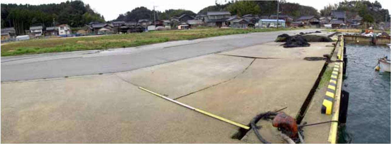
写真 4.2.13 鵜浦港被災箇所全景。鵜野浦漁港は水産庁所轄(管理:七尾市産業部農林水産課)の漁港である。護岸のはらみ出し・路面の開口クラック等の変状が認められる。写真奥の緑地帯には液状化跡(噴砂)が確認される。近隣の漁民によると「地震の時に砂が噴き出てきた」とのことである
