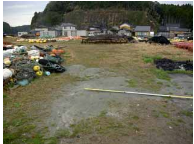
写真 4.5.5 漁港内の噴砂跡（鶴浦漁港）
