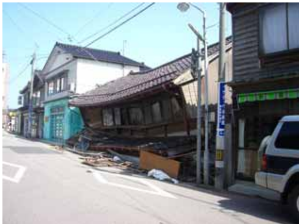
写真 4.4.23 古い木造家屋の倒壊（河井町）
