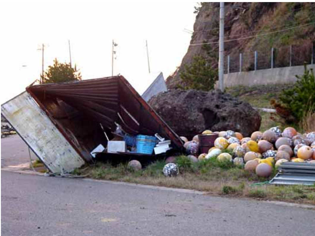
落石による物置の破壊（門前町鹿磯）
