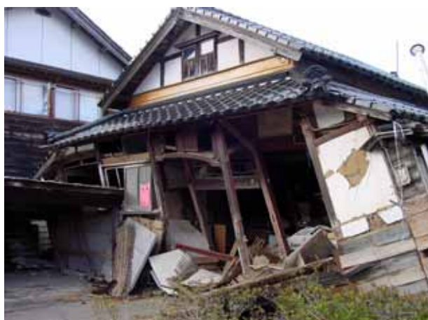
写真 4.4.3 大きく傾斜・変形した家屋
