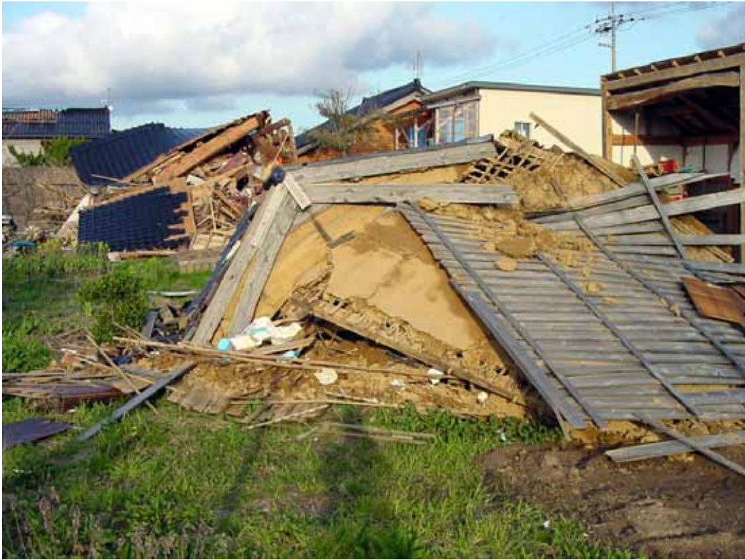
家屋の倒壊（門前町道下）
