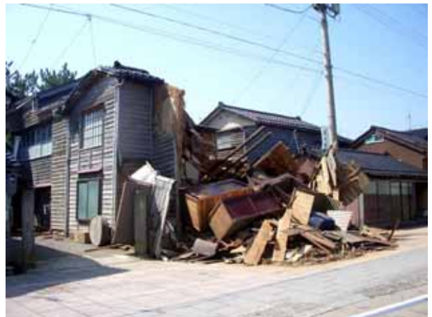
写真 4.4.24 古い木造家屋の倒壊（河井町）
