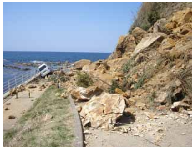
写真 4.3.5 数mの岩塊が崩落し、通行中の車両を直撃
