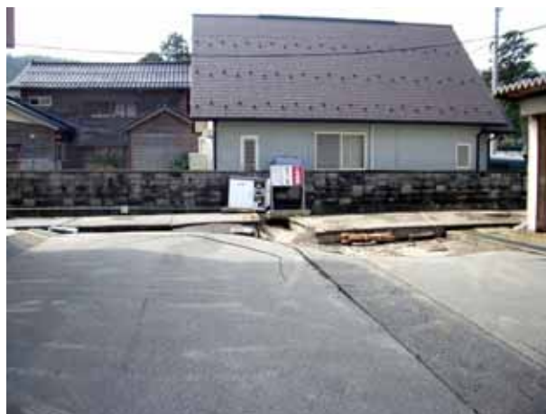
写真 4.4.12 地下貯槽の浮き上がり
