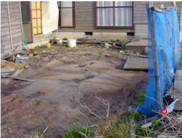
写真 4.5.9 住宅の庭先で見られた噴砂 (門前町道下)
