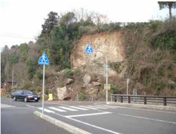
写真 4.3.1 岩盤崩壊。最大 3m 程度の岩塊が崩
