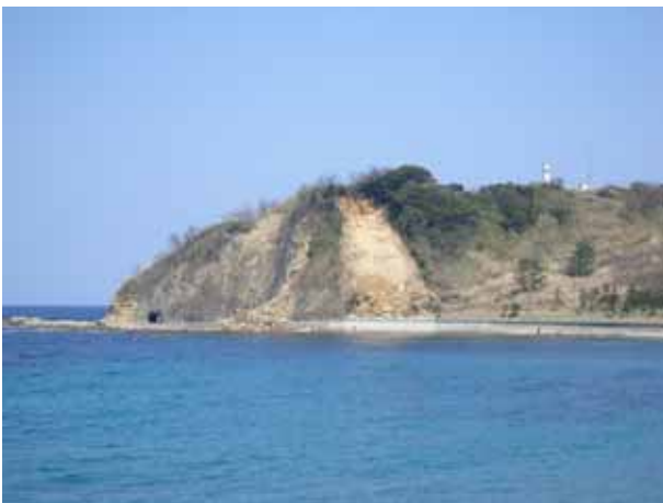
写真 4.3.4 崩壊箇所遠景（輪島市竜ヶ崎灯台付近）
