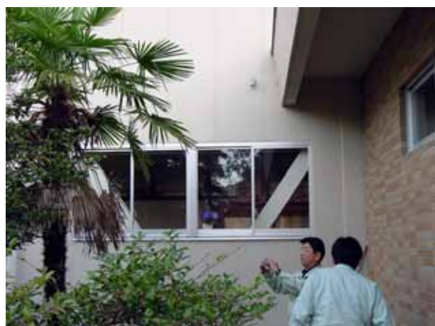
写真 4.4.9 耐震補強が施されている建物（門前高校）
