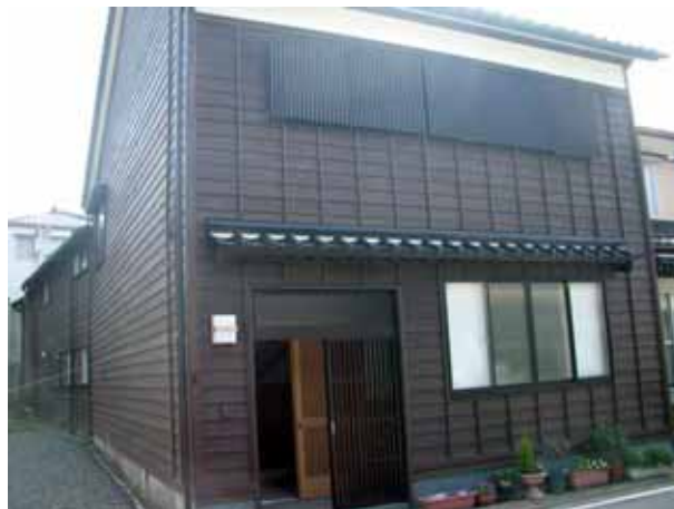
写真 4.4.8 全壊した寺院の向かい側の建物。外見上の被害は見られない
