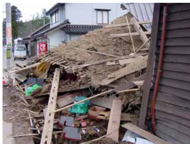
写真 4.4.6 全壊した家屋。土壁である
