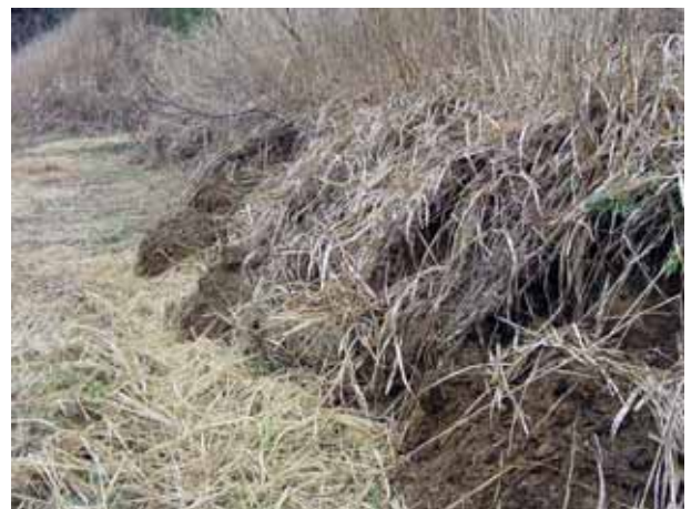
写真 4.1.4 のり尻にたまつた崩壊土
