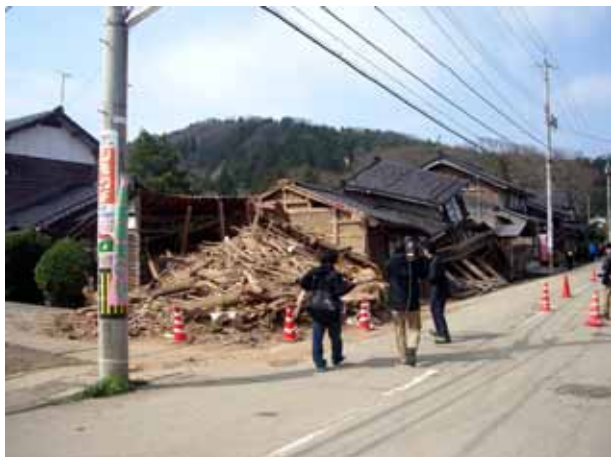
写真 4.4.1 家屋被災状況。倒壊した家屋
