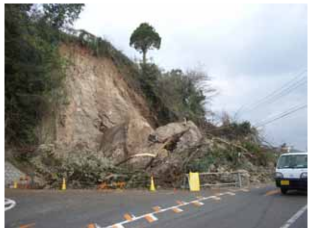
写真 4.3.2 同左写真の西側からの状況
