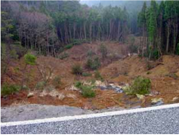
写真 4.1.11 谷部下流側の崩壊土の流出
