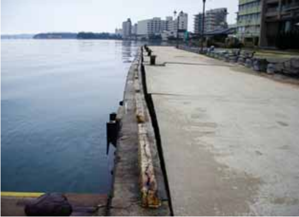
写真 4.2.11 護岸のせり出し, エプロン部での噴砂, 目地部の開口・沈下
