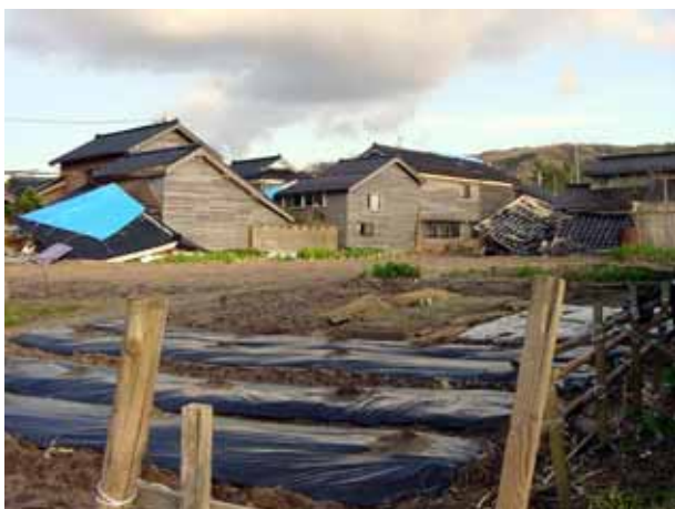
写真 4.4.13 古い木造家屋の倒壊
