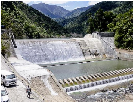
6月から通水が始まる取水堰
