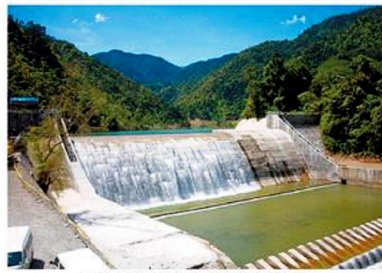
アシガ川小水力発電所の取水堰
