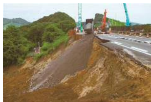
既設河川堤防の液状化対策として地盤改良を行っている
