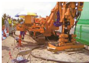
超低空頭削孔機
