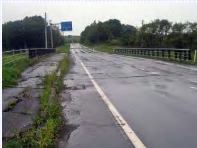
北進橋（ニッタポロ川、安平町）の全景
