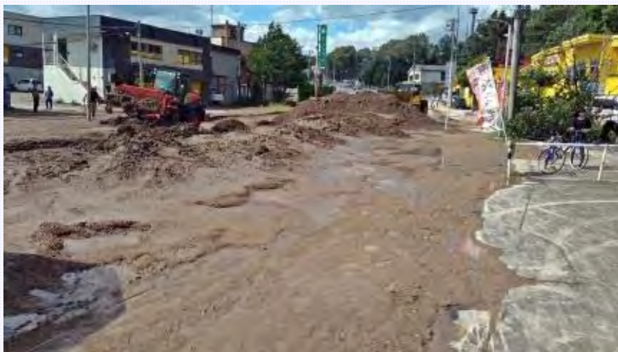
①-1地点 水とともに流出した大量の土砂（西方向を撮影）
