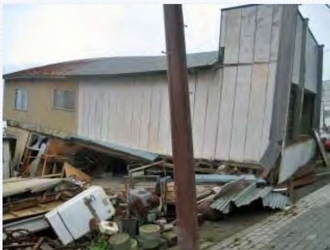
建物の層崩壊
