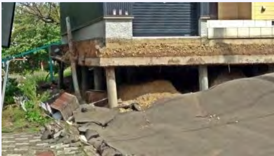
同上。杭基礎の近景（南西側より撮影）
