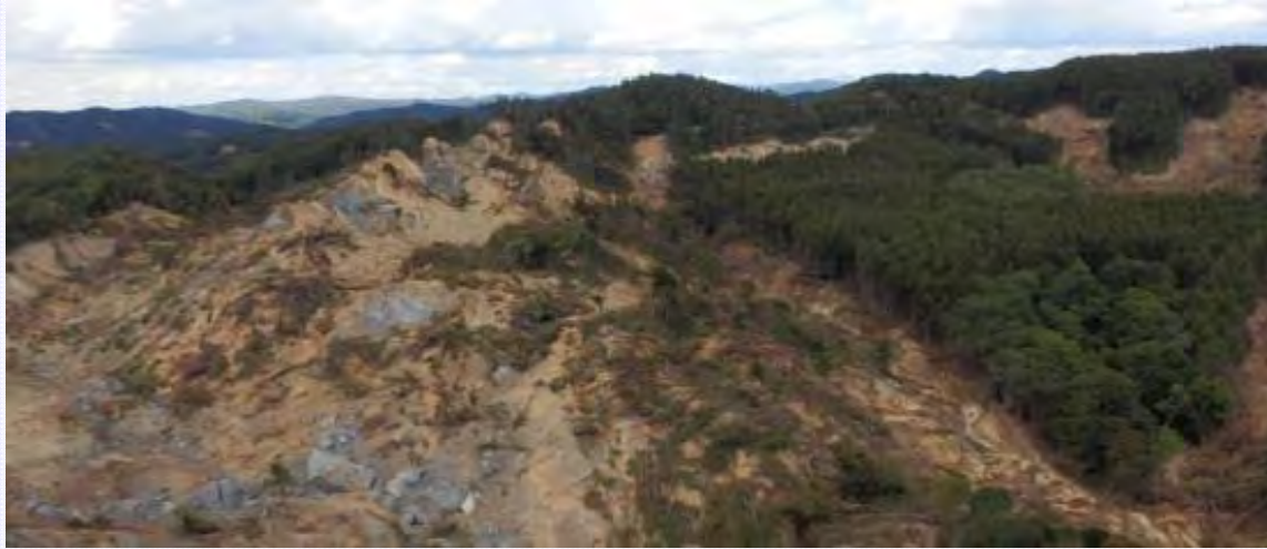
a地区 滑落崖付近（分離開口した巨大な岩壁が立ち並ぶ）
