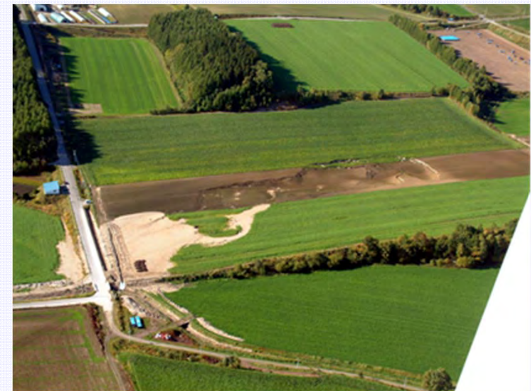
陥没・流出地域の全景（北見工業大学提供）
