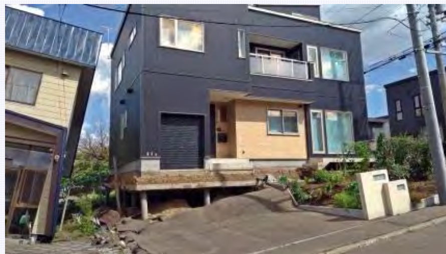
同左近景。右側の住宅は杭基礎のため沈下していないように見える（南西側より撮影）
