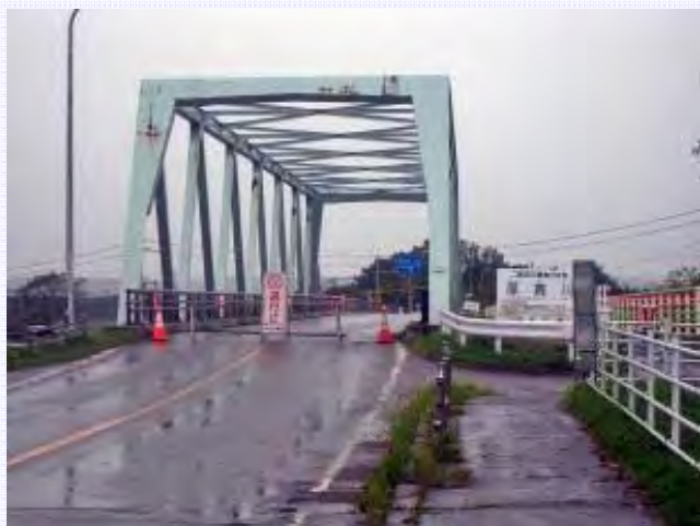
上厚真大橋（厚真川、厚真町）の全景（右岸側）
