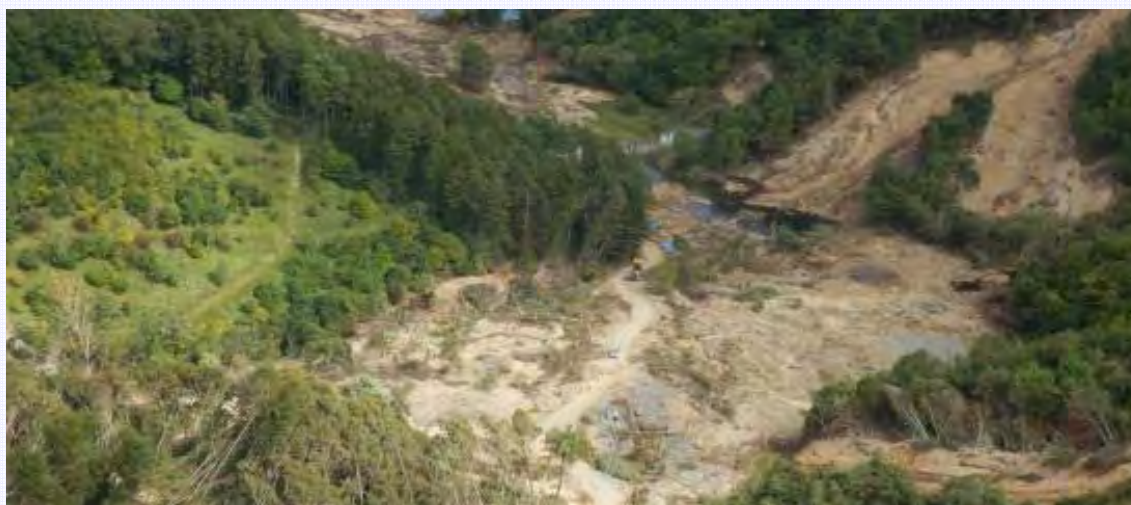
a地区 砂防ダムの下流側に土砂ダムが形成されている
