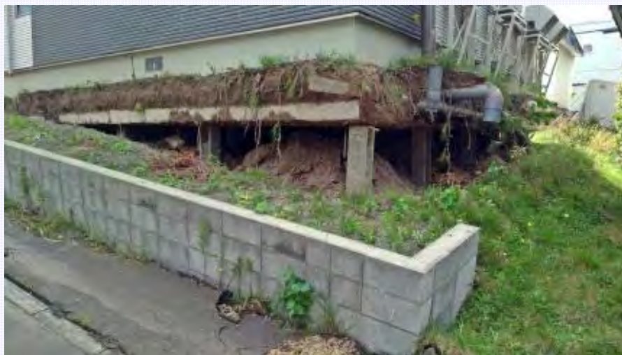
左の写真の向かいの住宅の基礎（北側より撮影）
