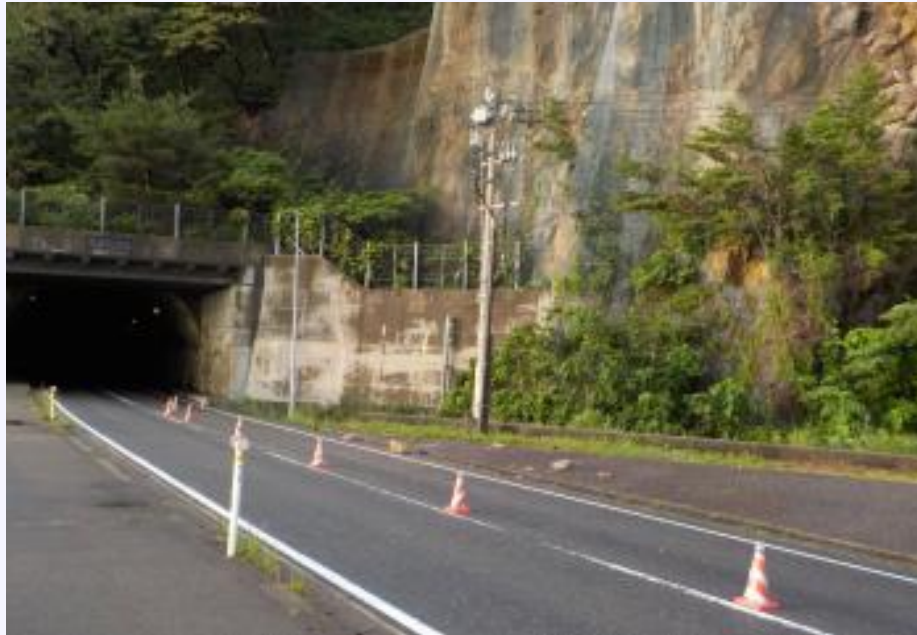
路面落石部近景
