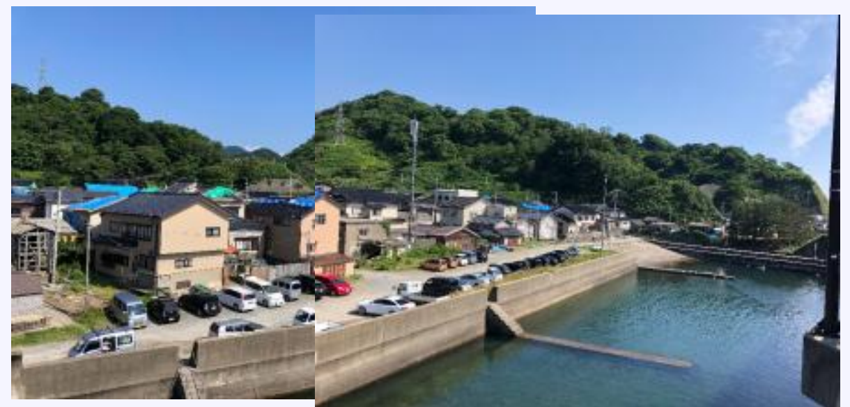
鶴岡市小岩川地区の屋根瓦被害(南側)
