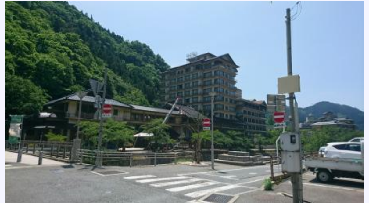
温泉旅館の屋根瓦の被害
