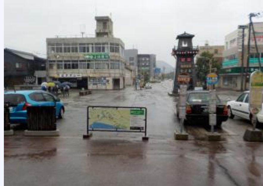
JR村上駅から市内方向を望む。被災は認められない
