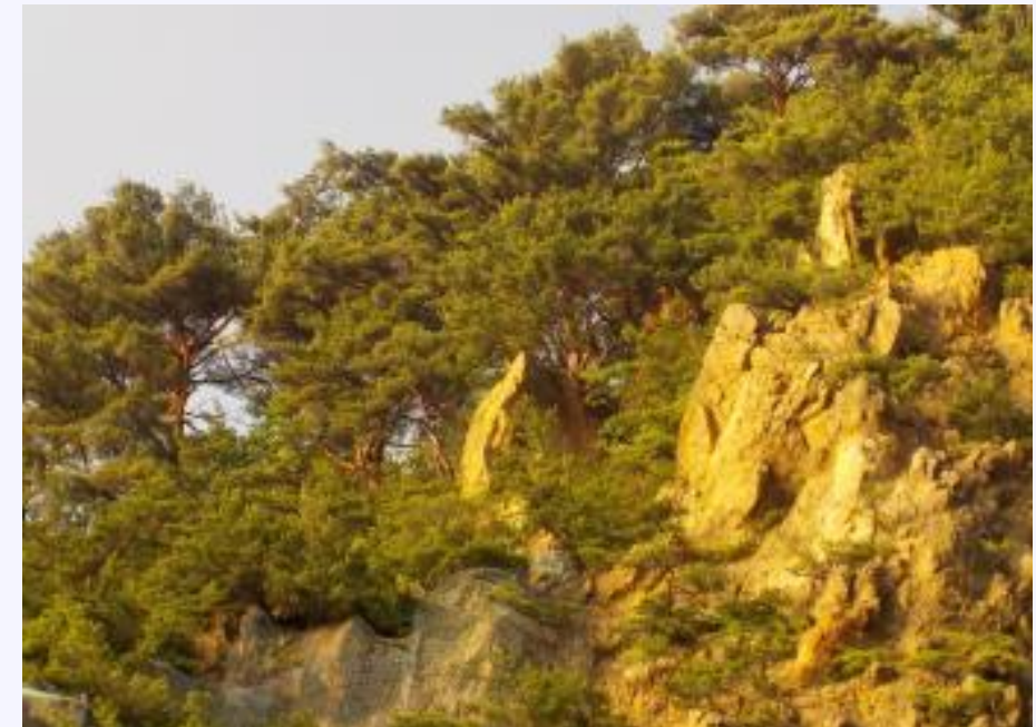
斜面上部の不安定岩塊
