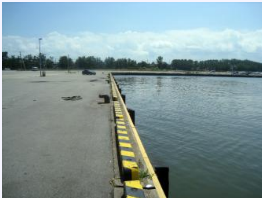
岸壁法線にも変形は認められない
