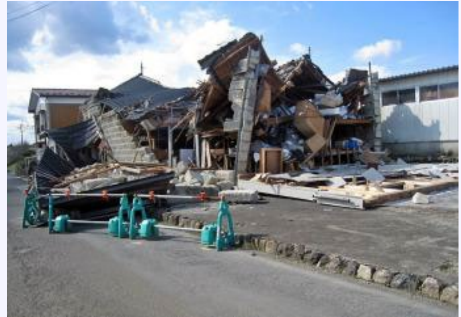
石積みと直交した面は木造で同様に倒壊した（同左）。
