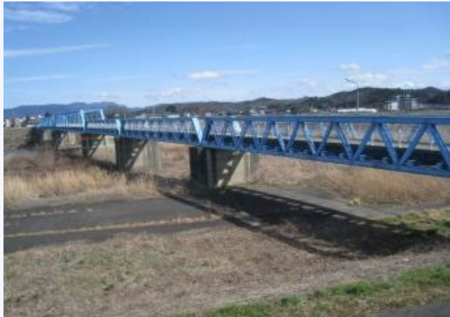
伊達橋の全景（右岸(東)側より望む）
