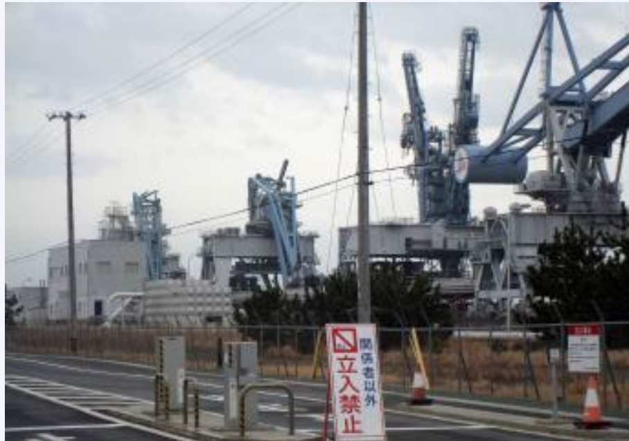
倒壊した揚炭機（奥の2基）
