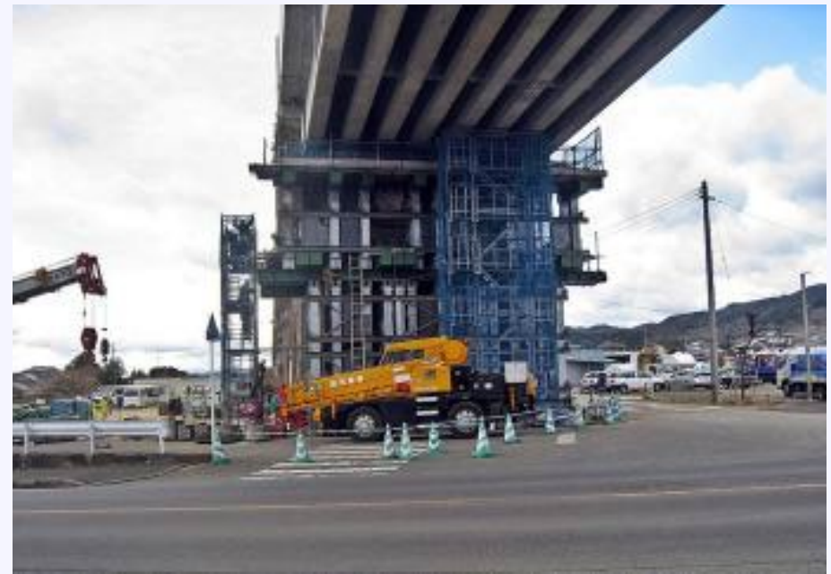
桁のジャッキアップ作業（手前の道路が県道46号）
