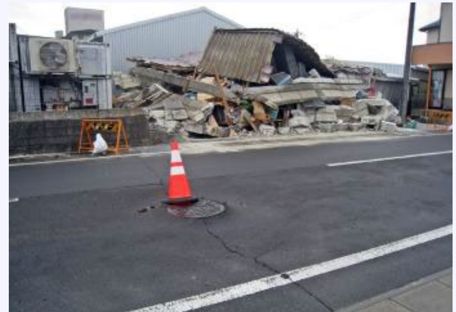
下水道人孔の浮き上がり（約10cm）
