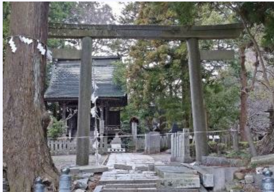
鳥居の貫が落下した相馬中村神社
