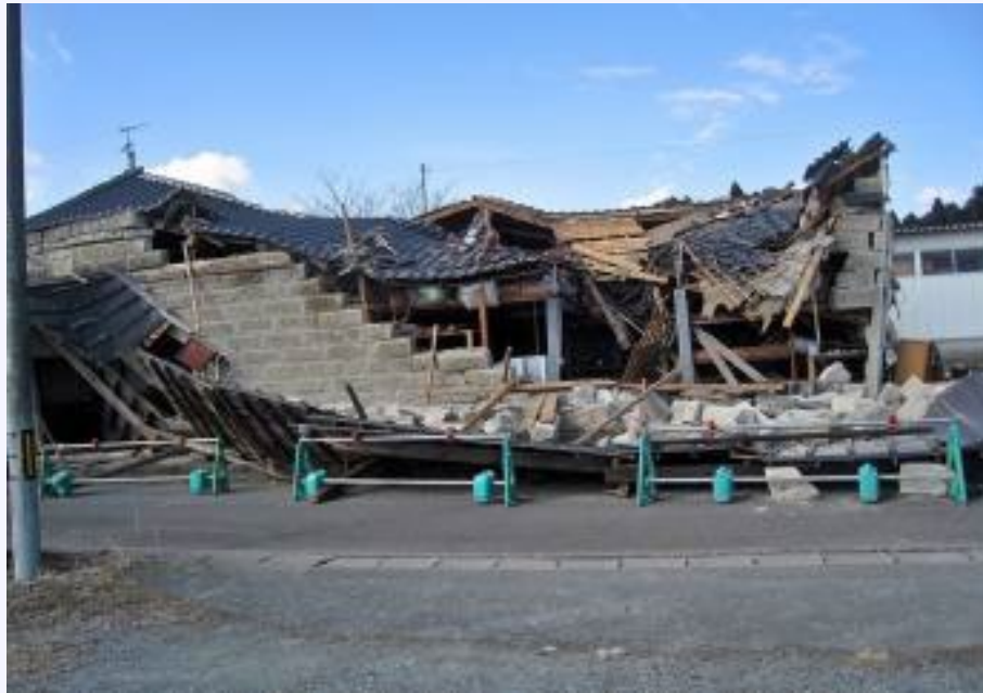
組積造建物の倒壊（JR日立木駅近傍）
