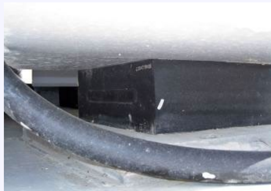
左岸橋台のゴム支承。異常は見られない。
