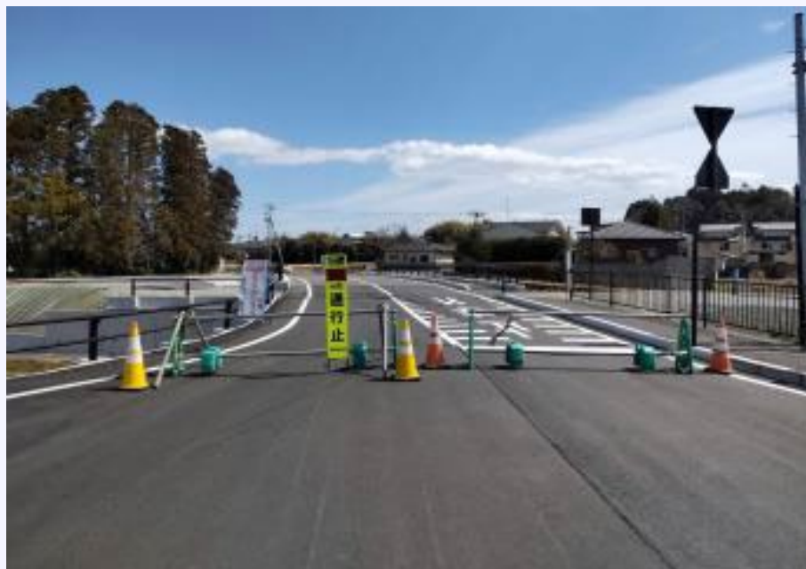
取付盛土の変状により通行止めとなった樋掛橋
