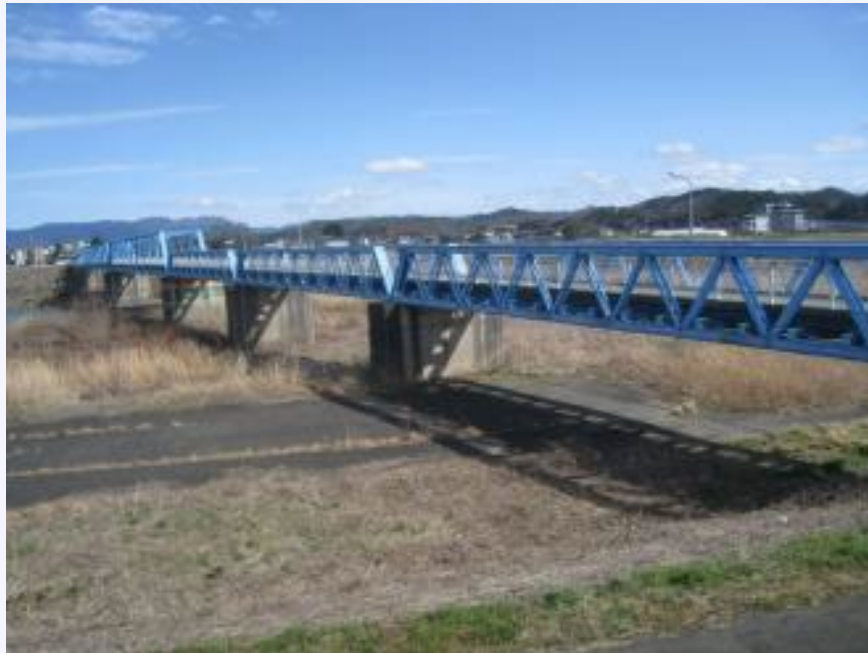
伊達橋歩道橋の全景（左岸側より）
