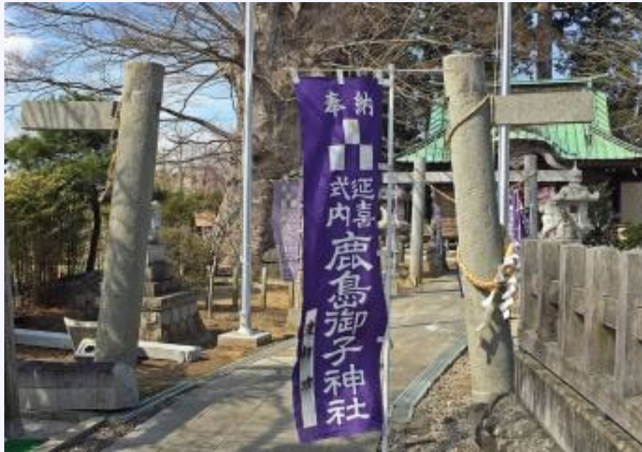
倒壊した鳥居の貫（鹿島御子神社）
