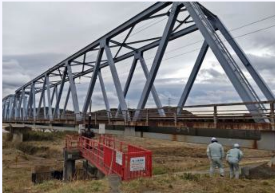
第一阿武隈川橋梁の下流の樋管に異常は見られない
