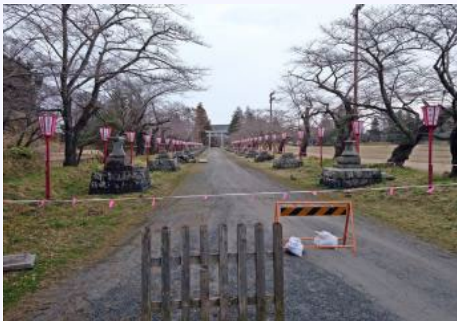
参道の燈籠の倒壊。東側に落下している
