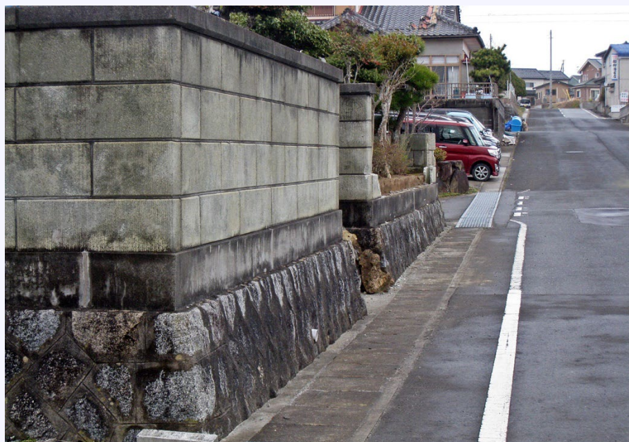
石塀の倒壊（相馬市尾浜）
