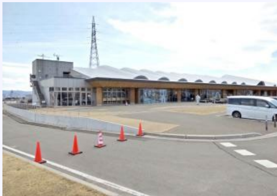
道の駅「あつかしの里」の建物。左側に擁壁が見える。
