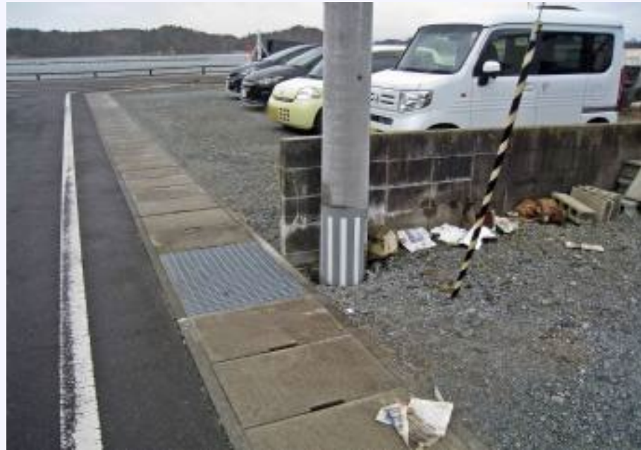
電柱の沈下
