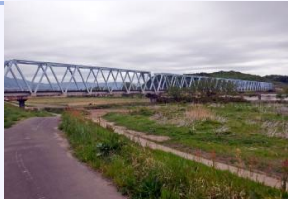
左岸側より見た第一阿武隈川橋梁
