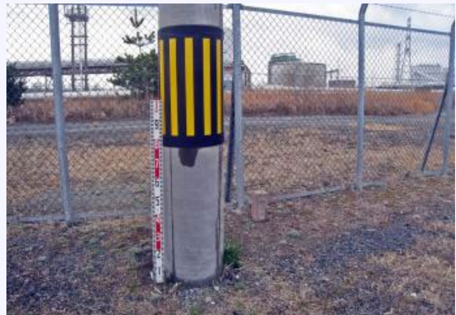
隣の電柱。噴砂は見られず、沈下の痕跡も見られない。
