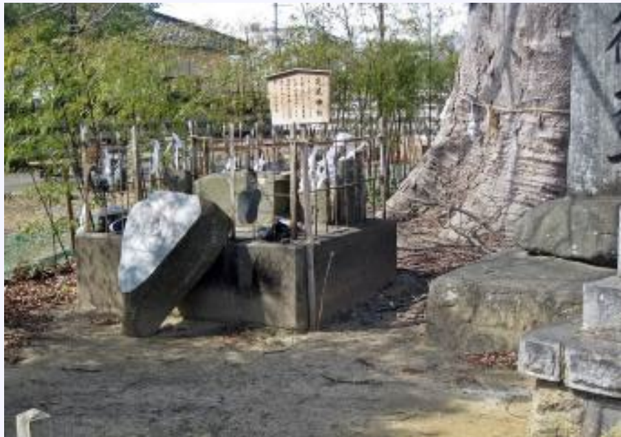
転倒した石碑（同上）
