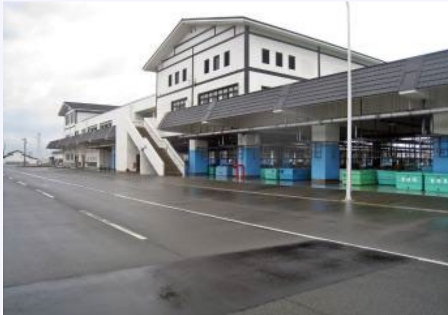
相馬原釜地方卸売市場の全景
