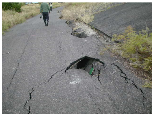
写真-4.5.2 大海崎堤防南側のり尻部の空洞
