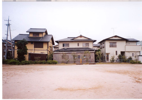
写真-4.2.10 傾いた住宅 (写真右の住宅は右方に、中央の住宅は左方に、左の住宅は右方に傾斜)
