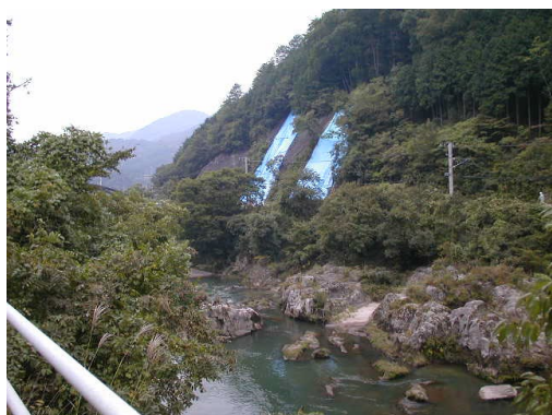
写真-4.6.1 JR 伯備線斜面崩壊
