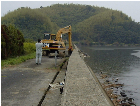
写真-4.5.7 堤防復旧中
