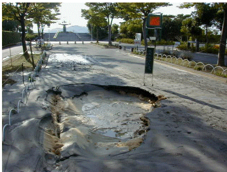
写真-4.2.6 陥没孔* (写真奥が護岸側、手前が児童文化センター)
