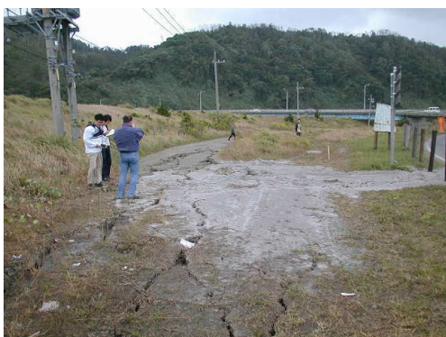
写真-4.5.1 大海崎堤防の中央部の亀裂
