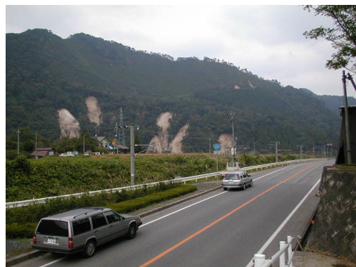
写真-4.6.3 日野町の斜面崩落群
