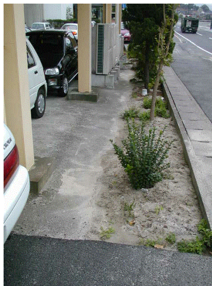
写真-4.3.12 背後地盤での噴砂
