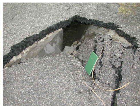
写真-4.5.2 大海崎堤防南側のり尻部の空洞
