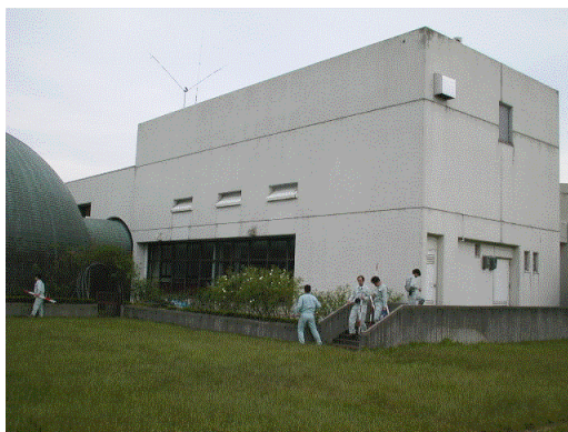
写真-4.2.1 建物の外観
