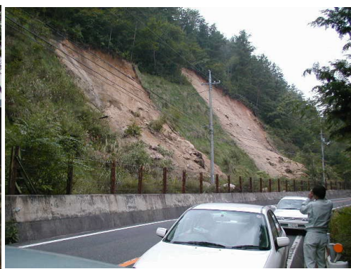
写真-4.6.4 日野町井ノ原の斜面崩落
