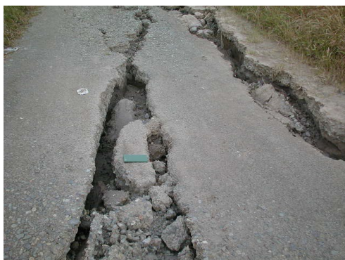
写真-4.5.1 大海崎堤防の中央部の亀裂
