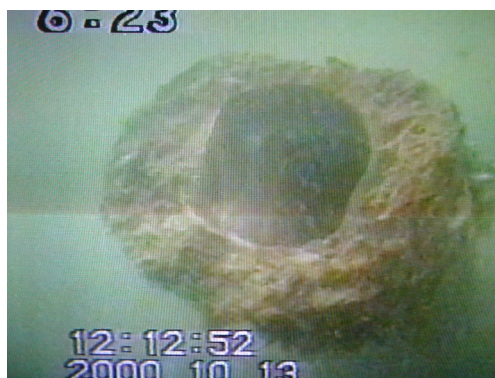
写真-4.4.17 破断した PC 杭の断面
