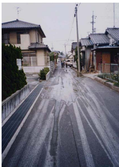
写真-3.20 液状化発生直後の写真
