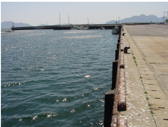
写真-3.8 草津漁港の岸壁
