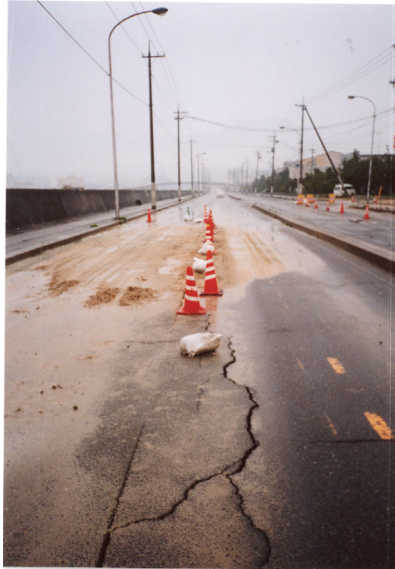
写真-3.2 道路陥没箇所の 応急復旧箇所
