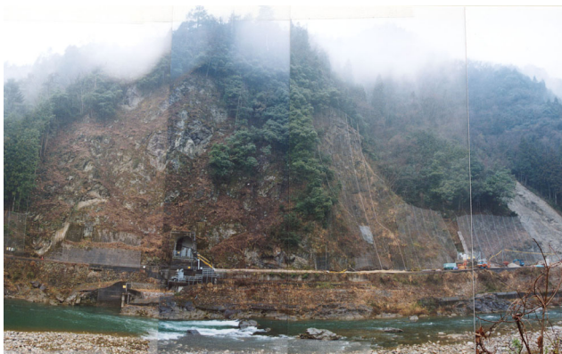
写真-3.23 A地点全景 (加計町中筒賀線下線)
