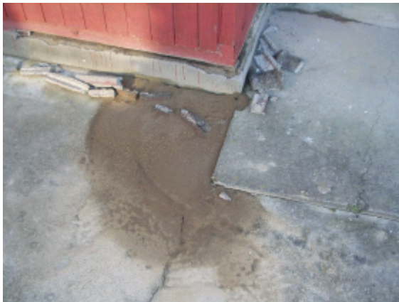
写真-4.7.7 民家敷地内の噴砂
