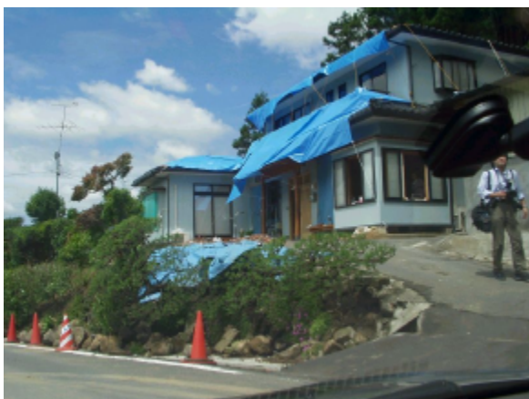
写真-4.3.25 集落の被災状況（その2）
