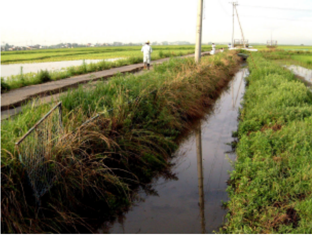
写真-4.7.9 付近の様子 写真中央に農道と水路、両側が畑
