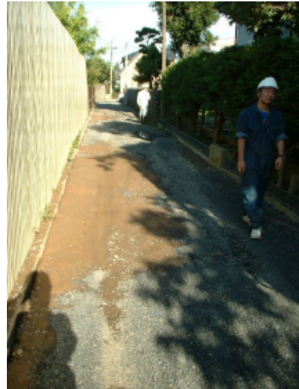
写真-4.7.8 道路脇での噴砂
