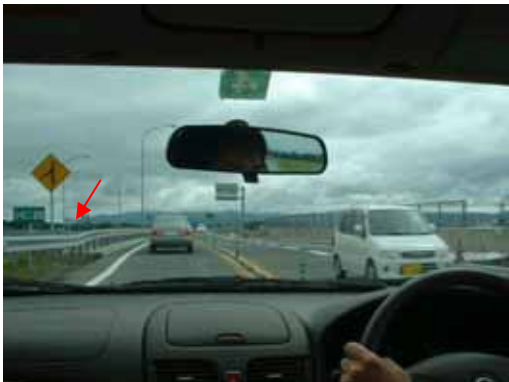
写真-4.1.1 橋台、ボックスと盛土の継目で段差が生じていた（ガードレールに段差）
