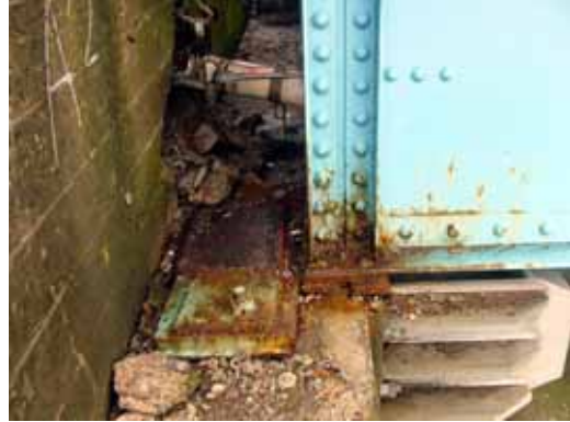
写真-4.5.6 小野橋右岸側橋台支承部
