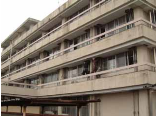
写真-4.2.7 公立深谷病院西棟 4階建のRC造建物 1969年に建設
