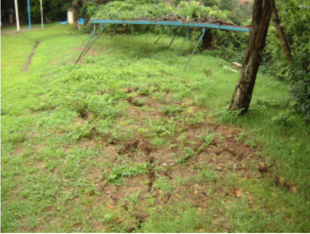
写真-4.3.21 北村小学校校庭 ・校庭際の法面の亀裂 （写真右側が法面）。 ・盛土の肩の部分に亀裂が入っ ている。 ・写真奥の藤棚も傾いている。
