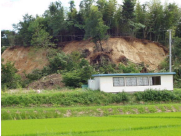
写真-4.3.13 土取り場での崖崩れ
