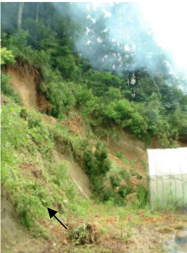
写真-4.3.11 民家裏での崖崩れ (崩壊1, 横からの写真)
