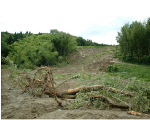
写真-4.3.3 崩壊堆積物先端付近から上流側を望む
