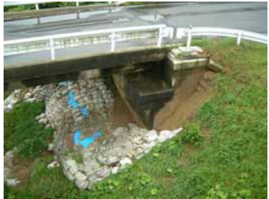
写真-4.5.12 西小野橋(吉田川) 左岸橋台付近
