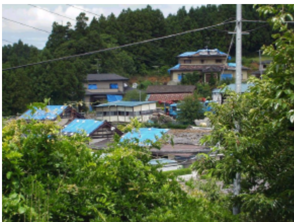
写真-4.3.24 集落の被災状況（その1）
