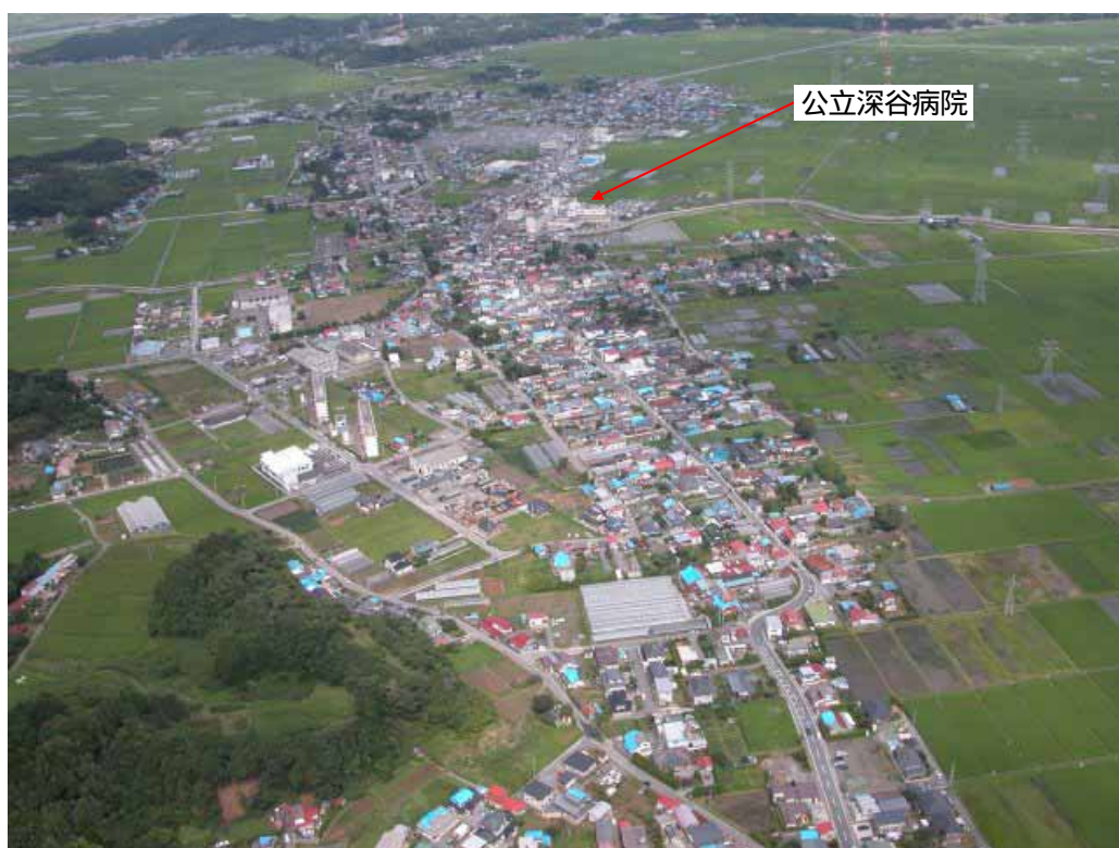
写真-4.2.1 地震後の広淵地区全景 ブルーシートで屋根を補修した家が目立つ 写真は集落を西側から空撮したもの
