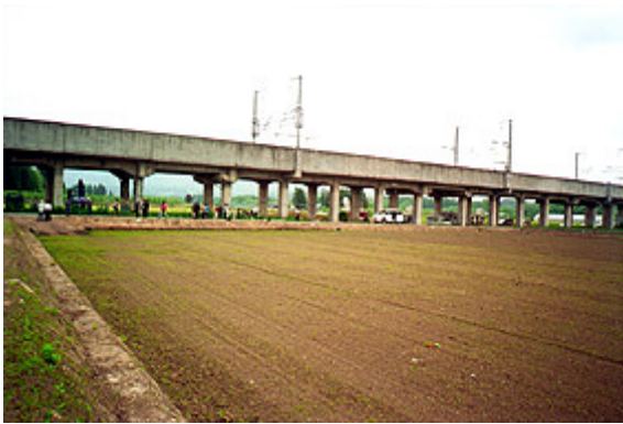
写真-4.3.1 被害箇所全景
