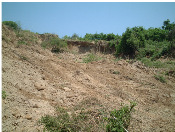
写真-4.2.4 滑落崖（崩壊上部）
