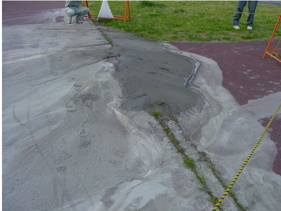
写真-4.1.16 公園内で噴砂（1）
