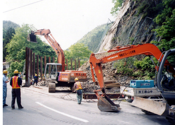
写真-4.4.7 対策として親杭(H鋼)を施工中
