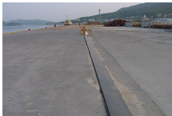
写真-4.1.5 野々田地区岸壁の全景（-7.5m 岸壁より-13m 岸壁を望む）
