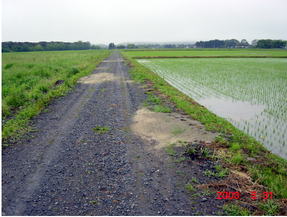
写真-4.4.1 噴砂跡(農道部)写真
