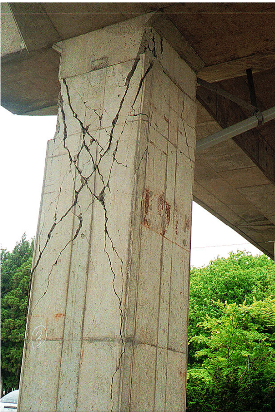
写真-4.3.6 脚柱のせん断亀裂の状況
