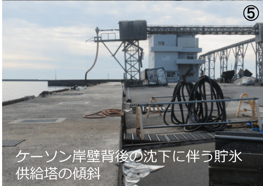
ケーソン岸壁背後の沈下
