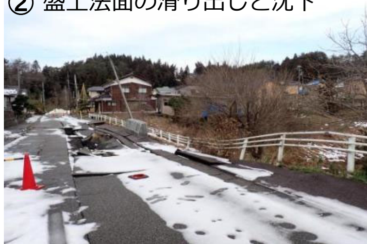
② 盛土法面の滑り出しと沈下
