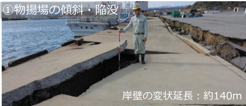
②物揚場の傾斜・陥没
