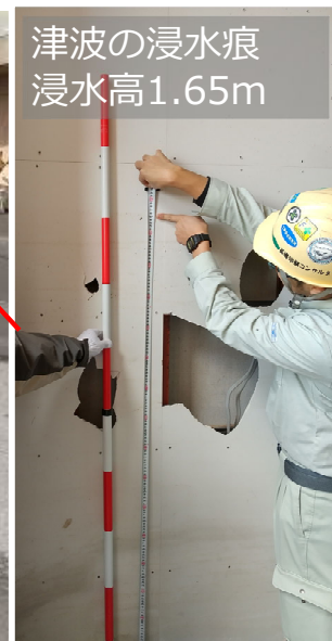
⑧津波による1階部分の損壊
