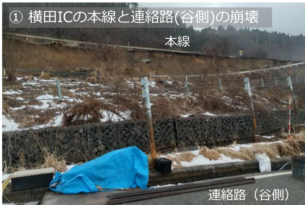
② 横田ICの本線と連絡路(谷側)の崩壊
