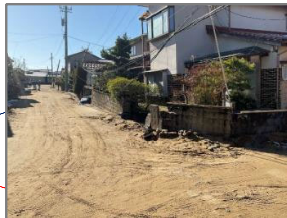
道路が前後より圧縮され突き上げている
