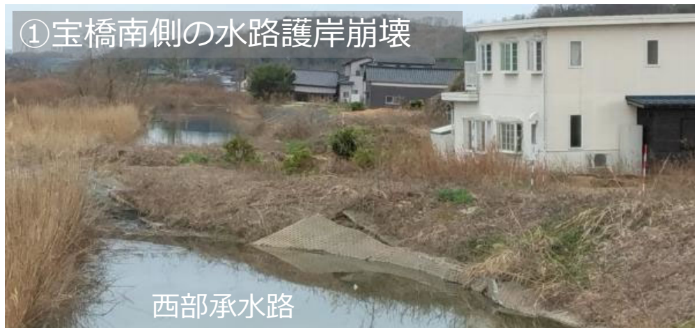
② 宝橋南部の水路護岸崩壊
