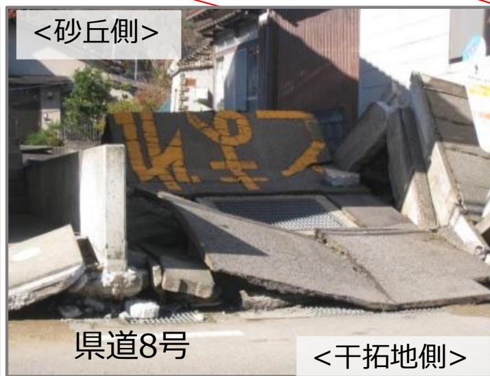
道路が前後より圧縮され突き上げている
