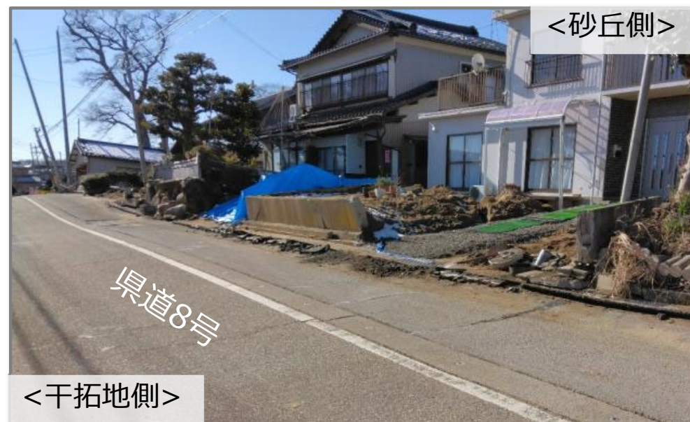
② 建物の沈下、擁壁のせり出し
