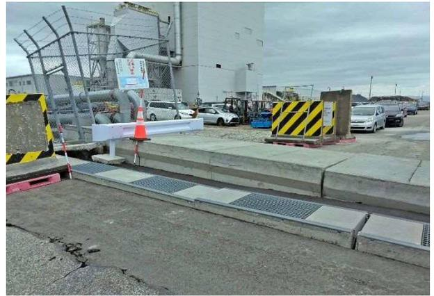
写真 4.5.90 道路を横断する配管ボックス
