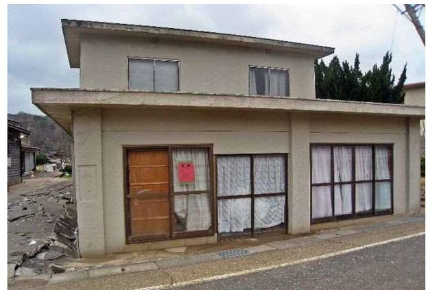
写真4.4.25 液状化により地中にめり込んだ建物
