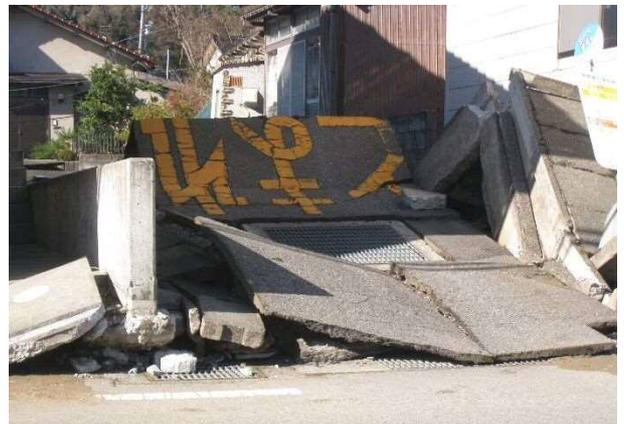
写真 4.5.66 県道に直交する道路の舗装の折れ曲がり（図 4.5.34 ⑥、手前が干拓地）
