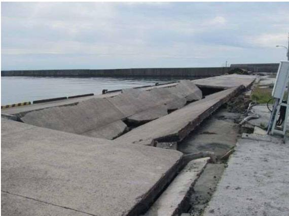
写真 4.3.16 護岸のせり出しと背後の陥没 (図 4.3.3 ②)
