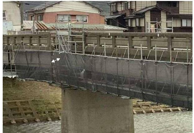
写真 4.1.14 橋桁の横ずれ
