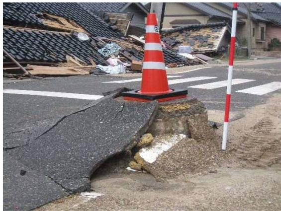
写真 4.7.11 下水道マンホールの突出
