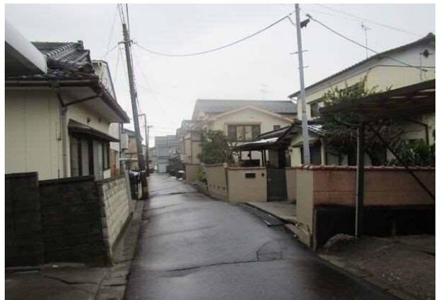
写真 4.5.78 波打つ（隆起・沈下）街路
