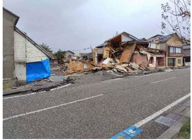
写真 4.3.25 マリントウン背後住宅地の家屋倒壊とマンホールの突出
