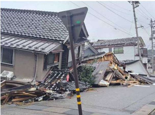
写真 4.4.15 木造住宅の倒壊 (図 4.4.3 ⑥)
