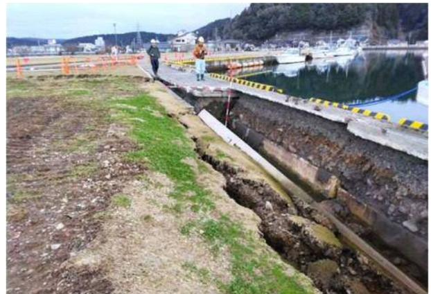
写真 4.3.34 北東側岸壁の損壊 (図 4.3.6 ②)
