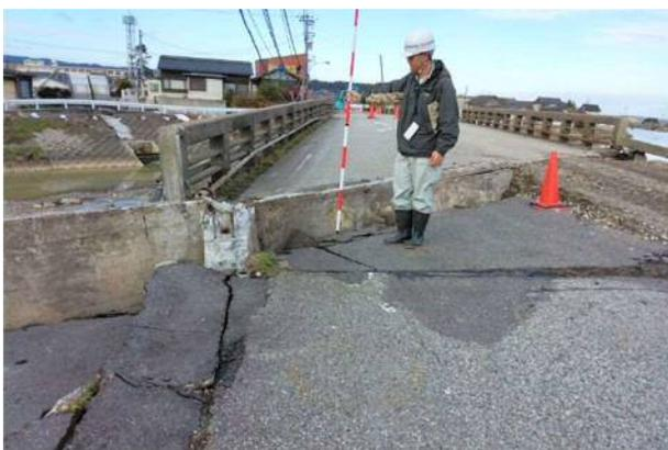
写真4.1.5 橋台裏の沈下に伴う段差
