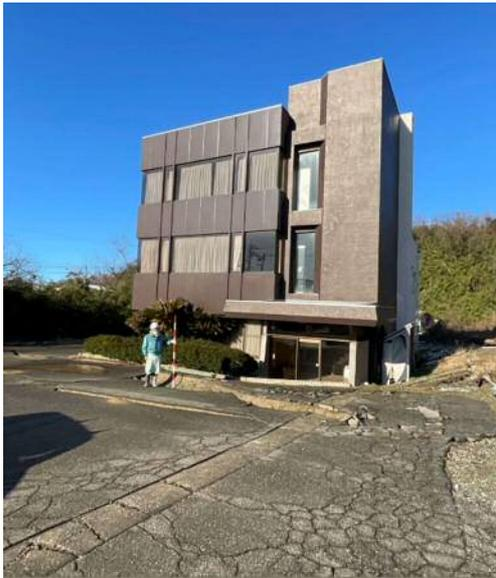
写真 4.5.67 3階建てビルのめり込み沈下 (図 4.5.36 ①、奥側が内灘砂丘)
