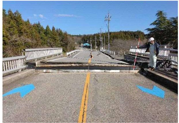
写真 4.1.16 能登島側A2橋台における段差(橋桁の沈下)
