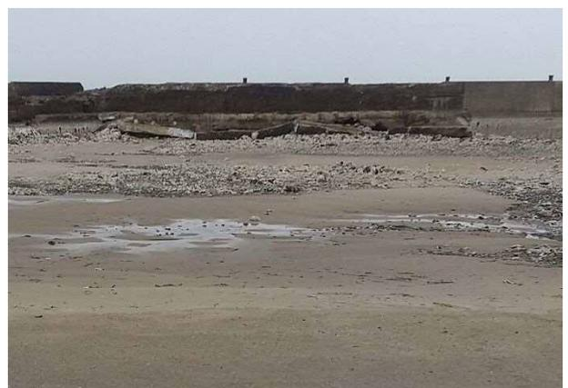
写真 4.3.59 防波堤の倒壊（図 4.3.13 ③）
