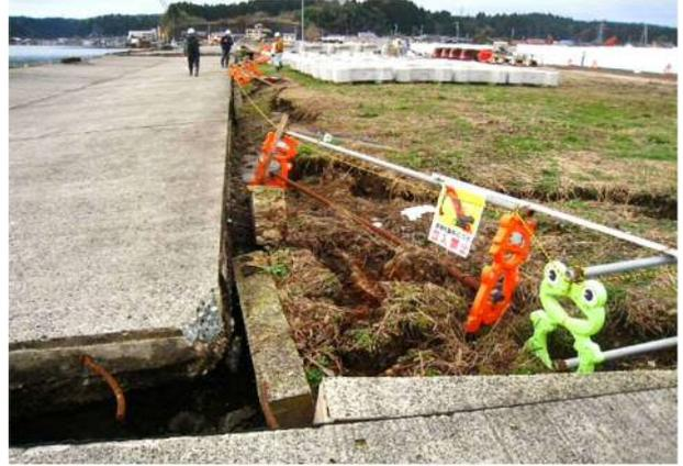
写真 4.3.32 南東側岸壁の背面地盤の段差
