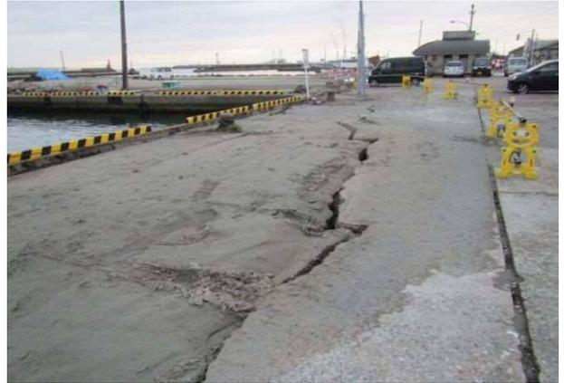
写真 4.5.86 新湊漁港のエプロンの噴砂と沈下
