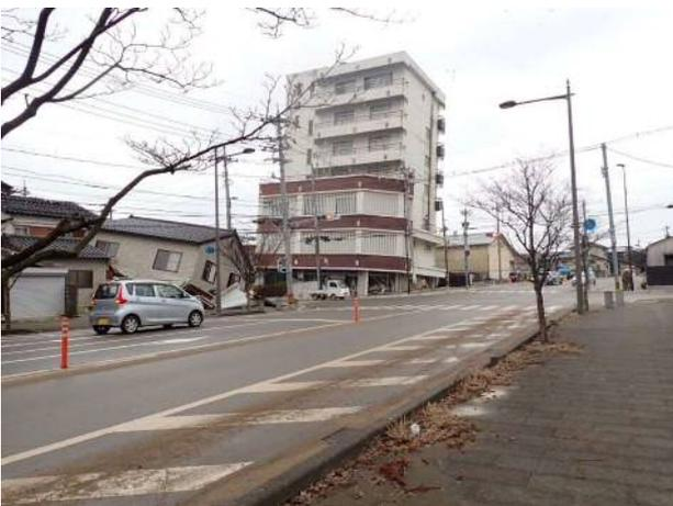
写真4.4.11 ビルの沈下および傾斜(図4.4.3 ②)
