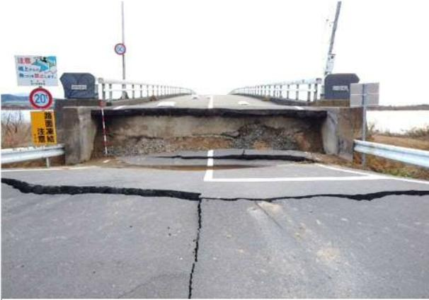
写真 4.1.19 北側橋台裏地盤の沈下と段差
