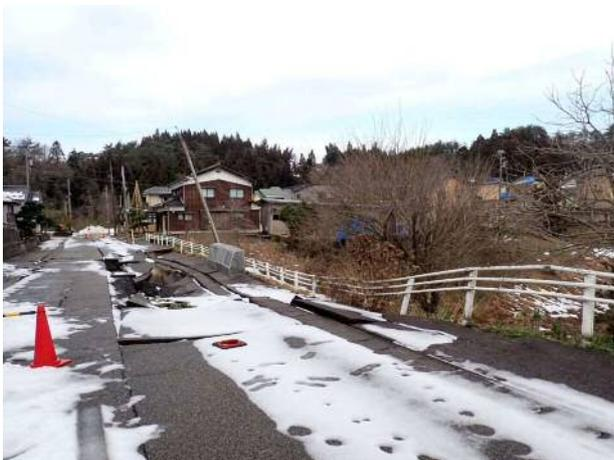
写真 4.5.22 盛土法面の滑り出しと背面道路の沈下 (図4.5.15 ②)
