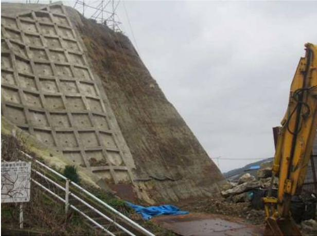
写真 4.5.24 法面保護工（吹付）の崩落
