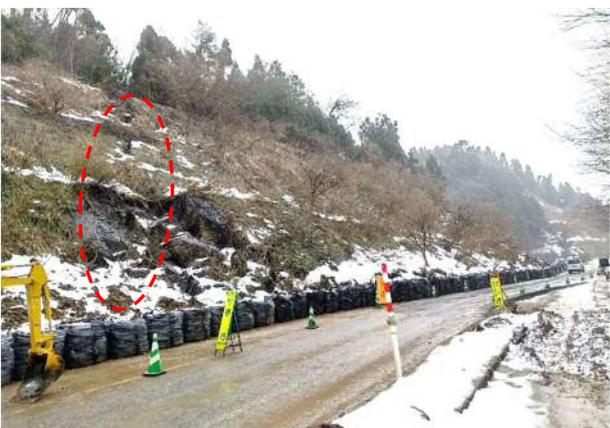
写真4.5.9 南側の道路法面崩壊(図4.5.9 ③)
