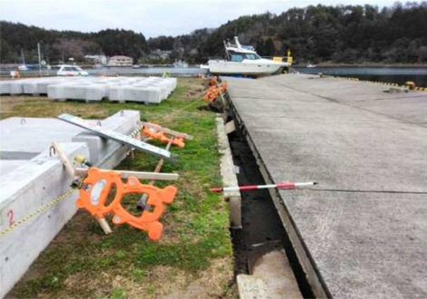
写真 4.3.31 南東側岸壁の背面地盤の開口
