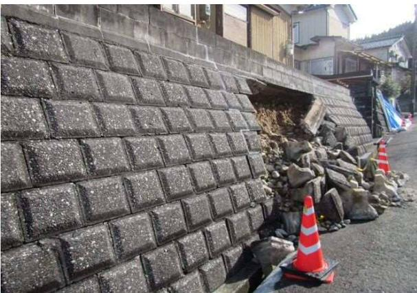
写真 4.5.29 練積擁壁のはらみ出しと崩壊
