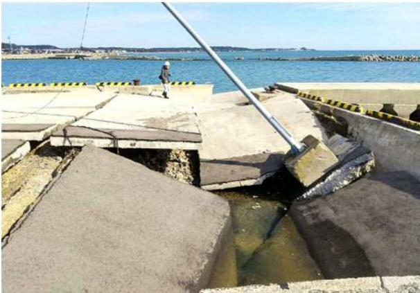
写真 4.3.3 物揚場先端の損壊（図4.3.1 ②）
