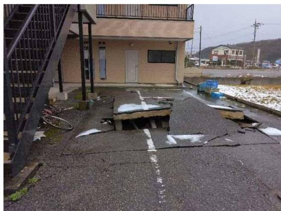
写真 4.7.13 浄化槽の浮き上がり (七尾市)
