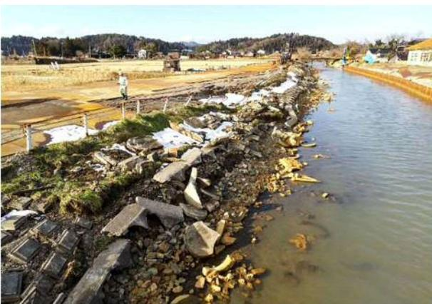
写真 4.1.3 上流右岸側の護岸の変形
