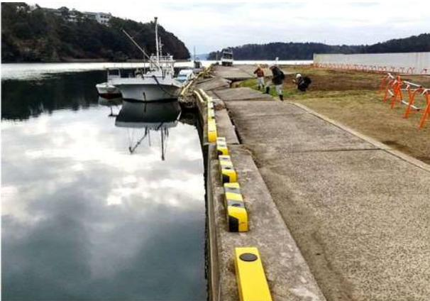
写真 4.3.33 南東側岸壁のせり出し (図
