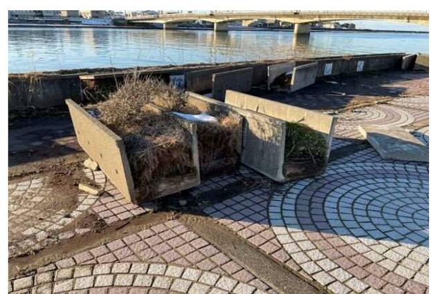
写真 4.6.17 中詰め土砂ごとブロックが流出
