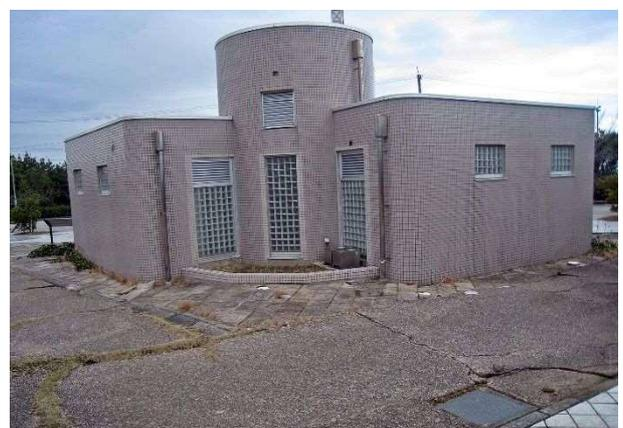
写真 4.5.88 めり込み沈下・傾斜した公衆便所
