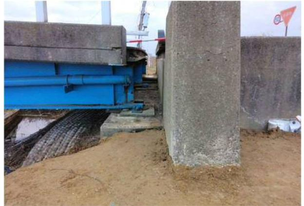
写真 4.1.20 北側橋台における橋桁の移動
