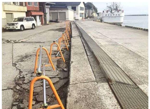
写真 4.3.14 岸壁のせり出しと背後の沈下
