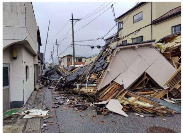
写真 4.4.16 木造住宅の倒壊 (図 4.4.3 ⑦)
