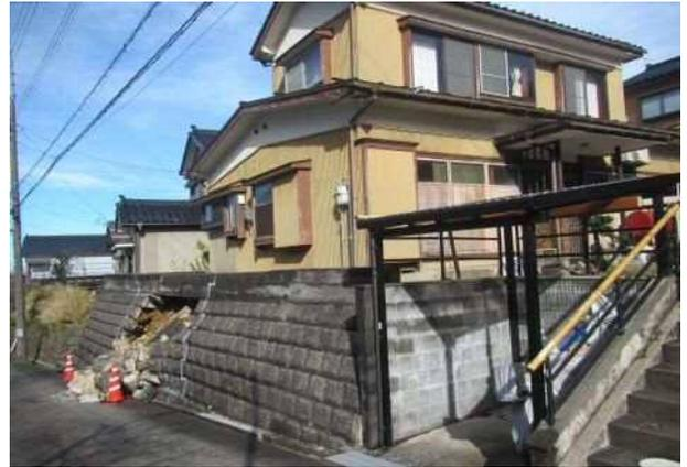
写真 4.5.28 擁壁崩壊による家屋の不等沈下
