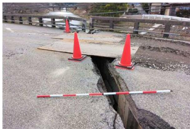
写真4.1.6 橋桁の横ずれ・開口変位
