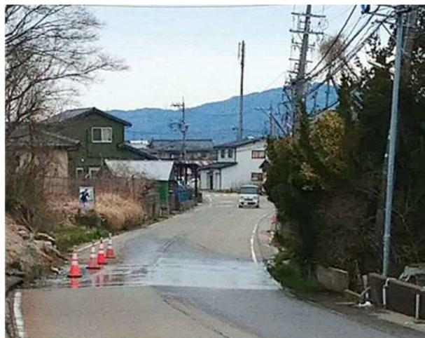
写真 4.5.72 西荒屋地区での水のしみ出し
