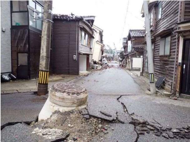
写真 4.4.13 木造住宅の倒壊と人孔の突出
