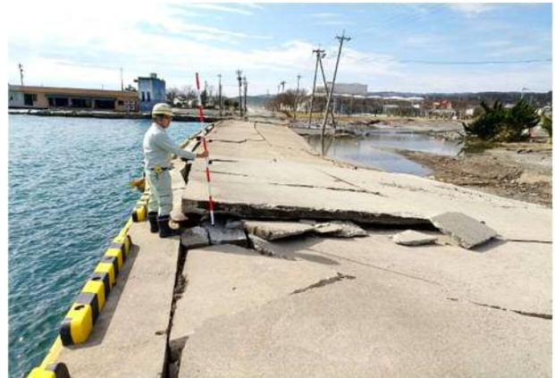
写真 4.3.4 物揚場のせり出しおよび段差（図4.3.1 ③）
