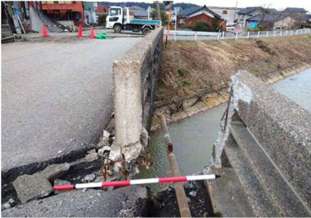
写真 4.1.7 橋桁の左横ずれ変位
