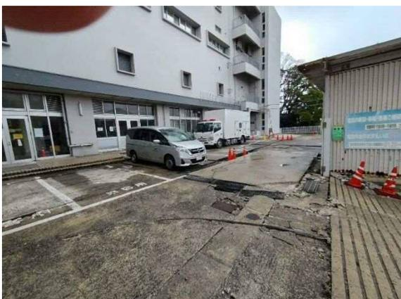
写真 4.7.12 浄化槽の浮き上がり (輪島市街)
