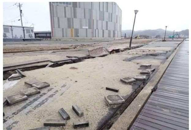
写真4.3.23 ケーソン岸壁背面の広範囲な沈下
