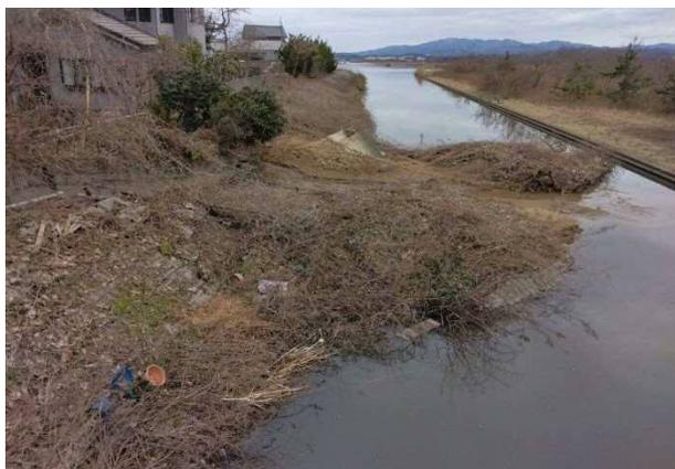
写真4.2.8 承水路護岸の崩壊(宝橋北側)
