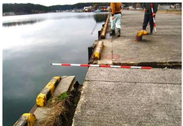
写真 4.3.30 南東側岸壁のせり出し（図 4.3.6 ①）
