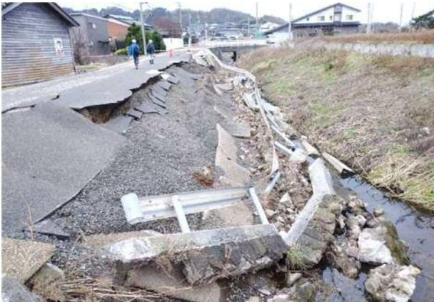
写真4.2.4 河川護岸の崩壊(図4.2.2 ①、北側から撮影)
