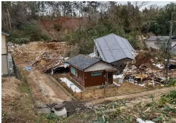
写真 4.5.14 由比ヶ丘 (北) の斜面崩壊全景
