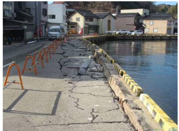
写真 4.3.12 護岸のせり出しと背後の沈下
