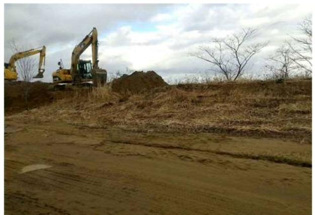
写真 4.2.15 東部承水路堤防の復旧工事
