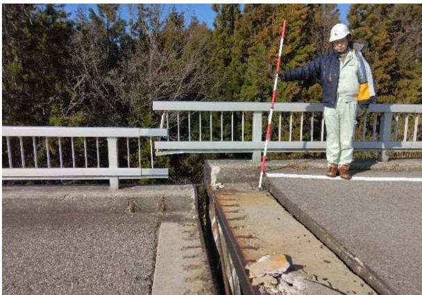
写真 4.1.17 A2橋台の開口と段差
