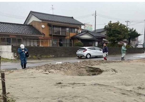
写真 4.5.79 直径 3.3m の噴砂孔
