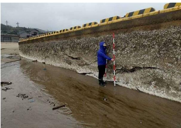
写真 4.3.58 物揚場側面の離水（図 4.3.13 ②）
