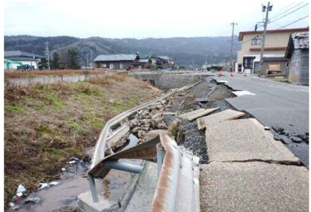
写真4.2.5 河川護岸の崩壊(図4.2.2 ②、南側から撮影)
