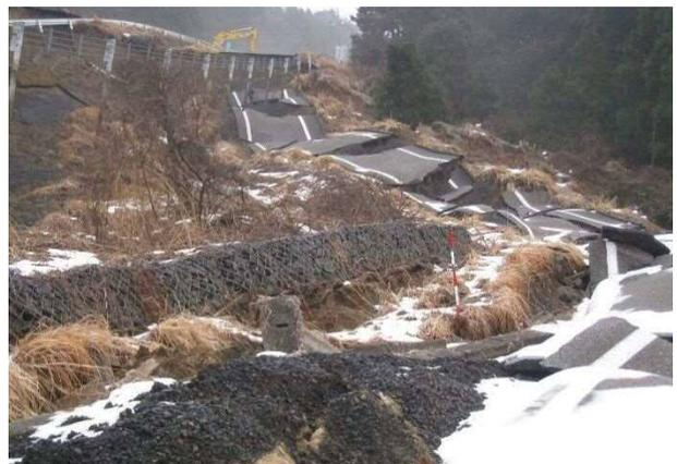
写真 4.1.31 谷側ランプの滑落状況(図4.1.12 ③)
