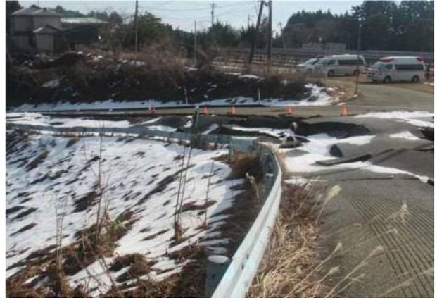
写真 4.1.23 法面のはらみ出しと法肩の沈下（西側より撮影）
