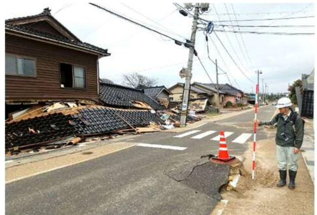
写真4.4.23 下水道マンホールの突出、電柱の沈下・傾斜
