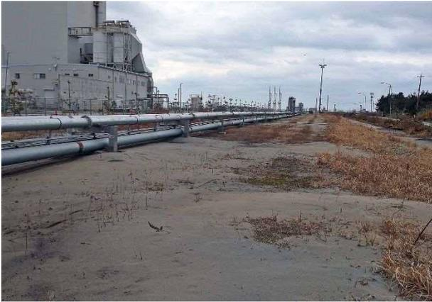
写真 4.5.89 配管ラック近傍で見られた噴砂
