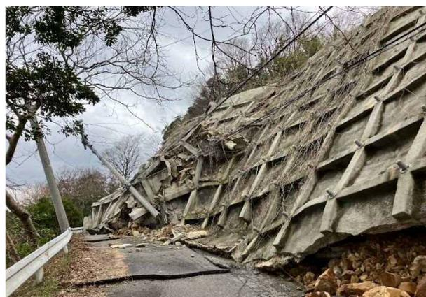
写真 4.5.20 法面保護工の崩落（図 4.5.14 ②）
