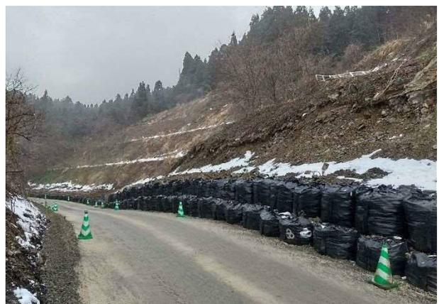
写真4.5.8 北側の道路法面崩壊(図4.5.9 ②)
