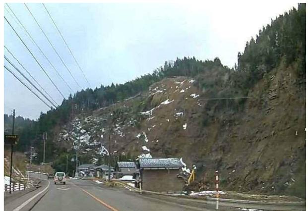
写真 4.5.5 河原田川左岸側斜面崩壊
