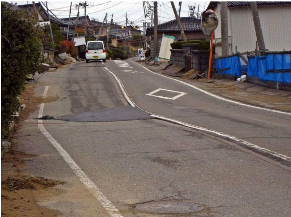
地盤の流動による道路舗装の折れ曲がり（内灘町西荒屋）
