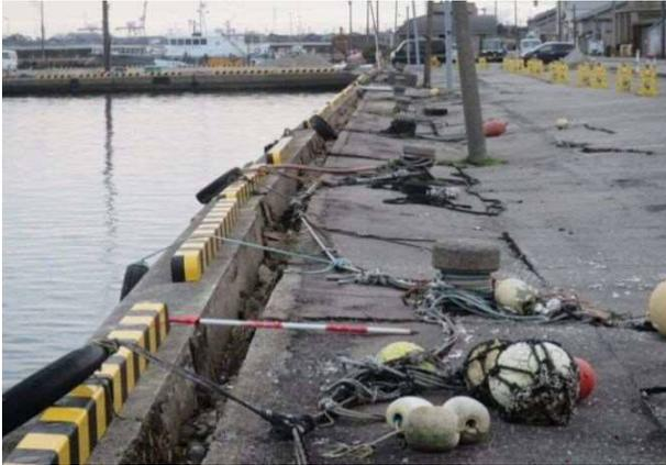
写真 4.5.85 新湊漁港の岸壁のせり出し
