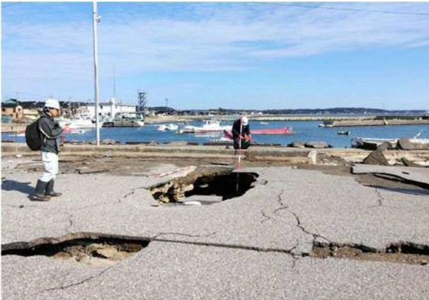
写真 4.3.1 物揚場の陥没（図4.3.1 ①）
