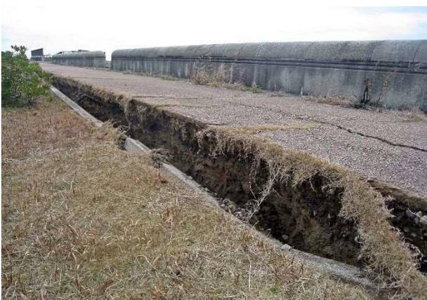
写真 4.5.87 護岸背後の沈下・段差
