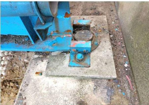
写真 4.1.21 北側橋桁の支承部からの脱落
