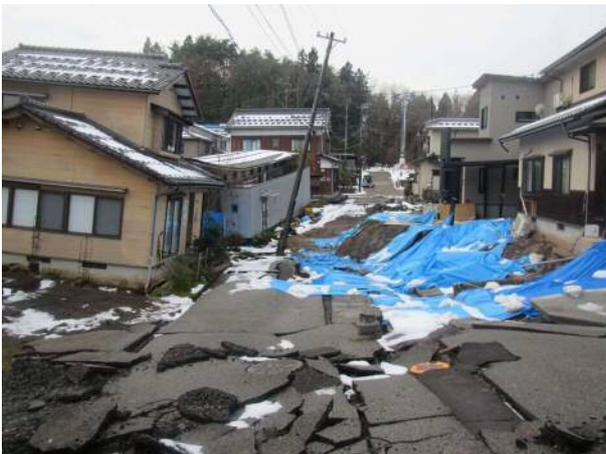
写真 4.5.21 盛土天端での道路および宅地被害 (図4.5.15 ①)
