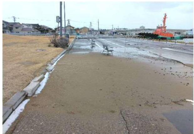
写真4.3.46 無量寺岸壁一般部背後の噴砂(図4.3.9 ②)
