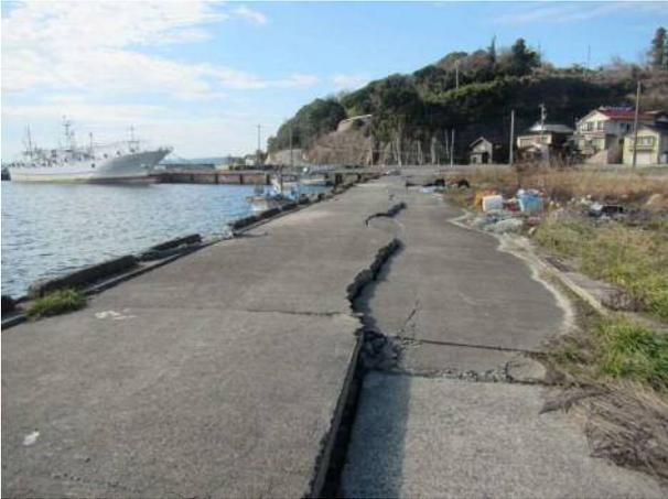
写真 4.3.53 岸壁背後の沈下・段差
