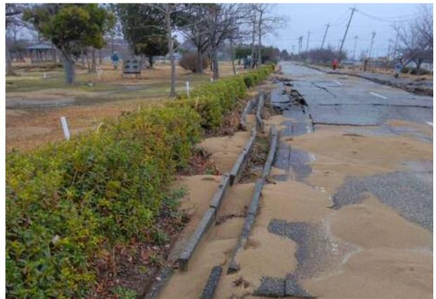
写真4.5.47 側溝のズレ・蛇行および噴砂 (図 4.5.27 ④、右側が長者川)
