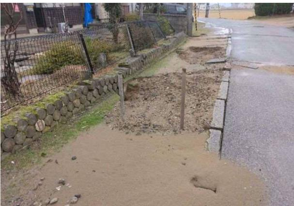
写真 4.5.42 地盤の流動範囲内の噴砂(手前が長者川)
