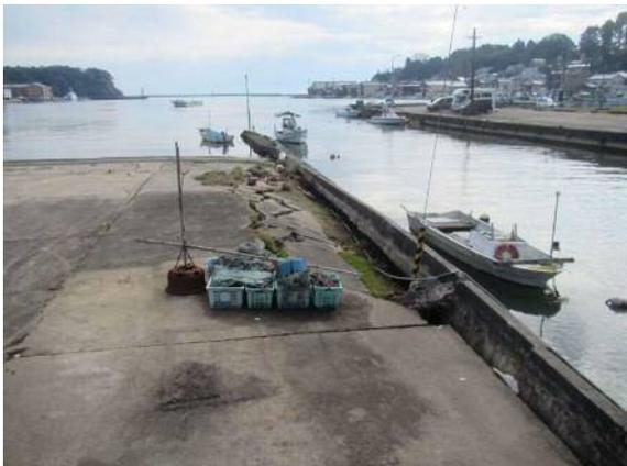
写真 4.3.18 護岸のせり出しとエプロンの沈下 (図 4.3.3 ④)
