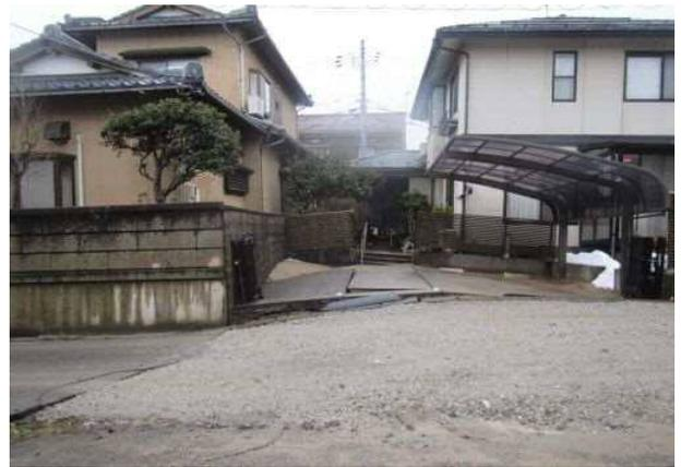
写真 4.5.76 流動による地盤の隆起と家屋の傾斜
