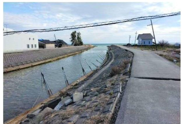
写真 4.1.4 下流右岸側の護岸の変形
