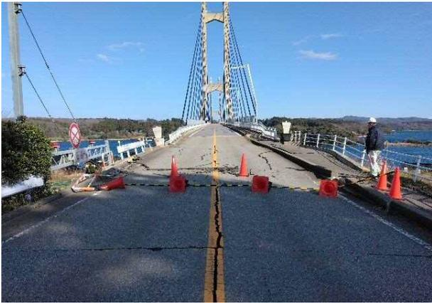
写真 4.1.15 中島町側A1橋台付近の路面のクラックと歩道部の段差
