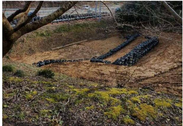
写真 4.5.35 北陸自動車道の盛土により止められた崩壊土砂 (一部撤去済み)
