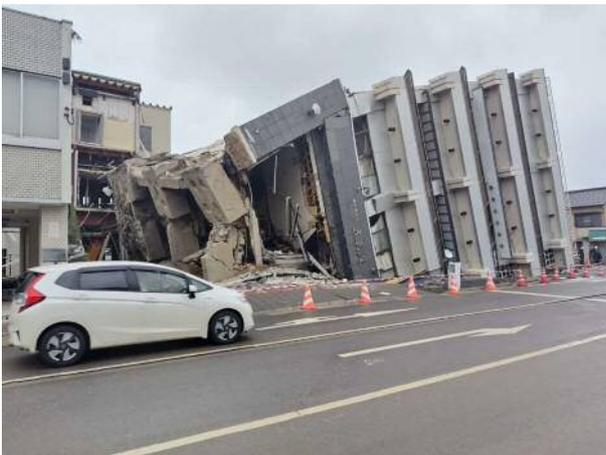
写真4.4.9 7階建ビルの倒壊(図4.4.3 ①)
