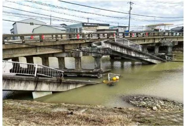
写真 4.1.8 併設の歩道橋の落下（上流側より）
