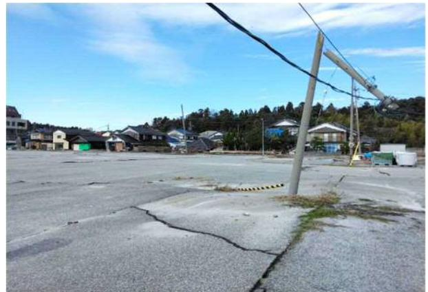
写真 4.3.52 液状化による電柱の沈下・傾斜および上部の折損
