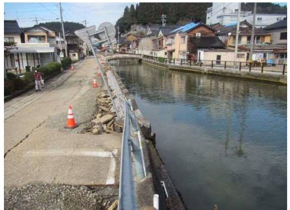
写真 4.3.19 河口護岸背面の沈下 (図 4.3.3 ⑤)
