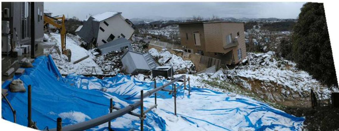
丘陵造成斜面の崩壊による家屋の移動・傾斜（能登町藤波）
