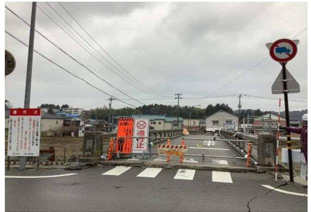
写真 4.1.12 橋台裏地盤の沈下による段差
