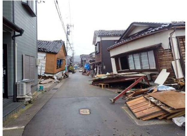
写真 4.4.14 木造住宅の倒壊 (図 4.4.3 ⑤)
