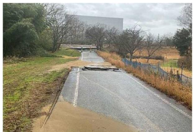
写真4.5.50 道路崩壊部手前の横断クラックと噴砂 (図 4.5.27 ⑧、手前が長者川)
