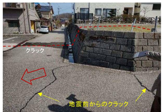
写真4.5.39 隣接の大規模盛土造成地内の変状
