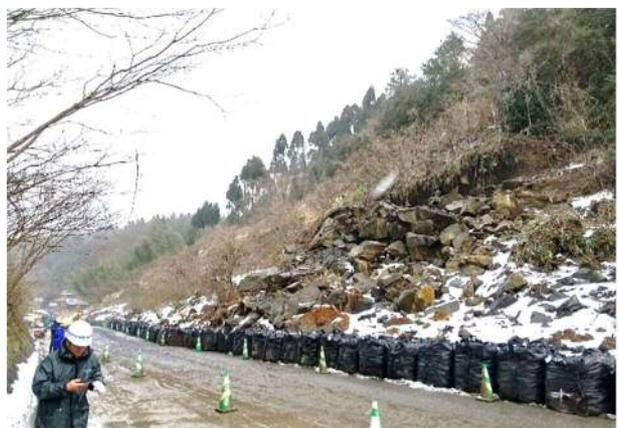
写真4.5.10 南側の道路法面崩壊(図4.5.9 ④)
