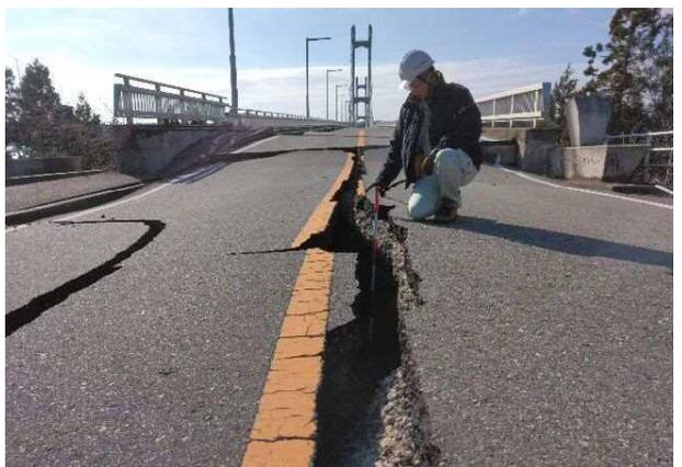
写真 4.1.18 A2橋台背後地盤の縦断クラック
