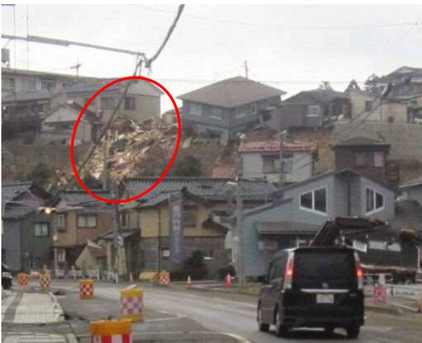
写真 4.5.25 ブロック積擁壁の崩落
