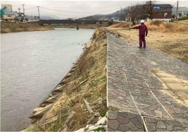
写真 4.2.1 河川遊歩道の天端の沈下
