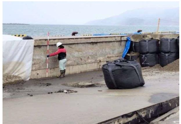
写真4.3.21 ケーソン岸壁背面の沈下
