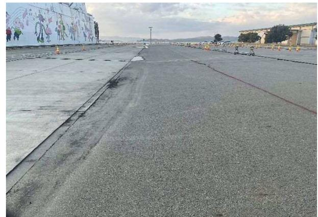
写真 4.3.42 耐震強化岸壁背後の沈下（矢田新地区③）
