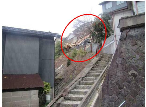
写真 4.5.26 ブロック積擁壁の崩落
