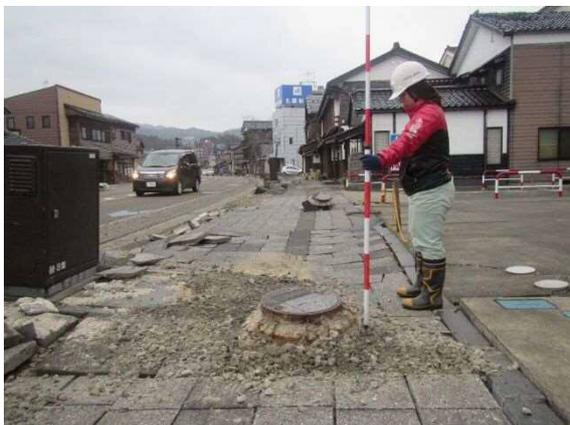
写真 4.7.10 下水道マンホールの突出
