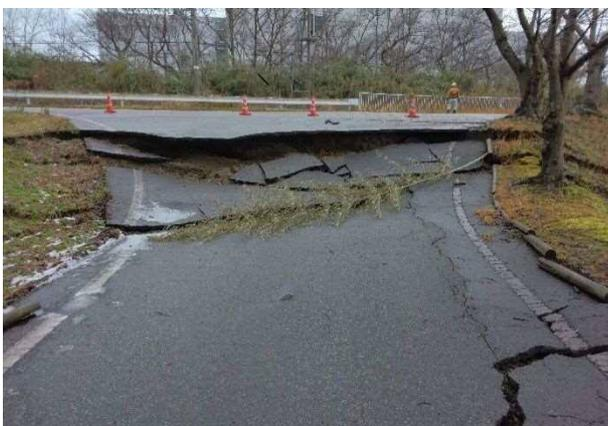
写真 4.5.49 道路丁字路部の崩壊によって生じた段差 (図 4.5.27 ⑦、奥が羽咋砂丘)
