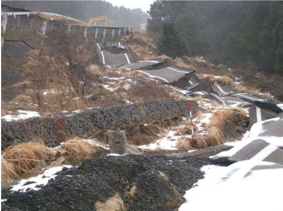
液状化に伴う地盤の流動で起こった路面の波打ち（内灘町西荒屋）
