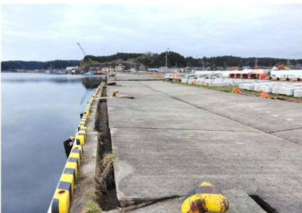
写真 4.3.29 南東側岸壁のせり出し（図 4.3.6 ①）
