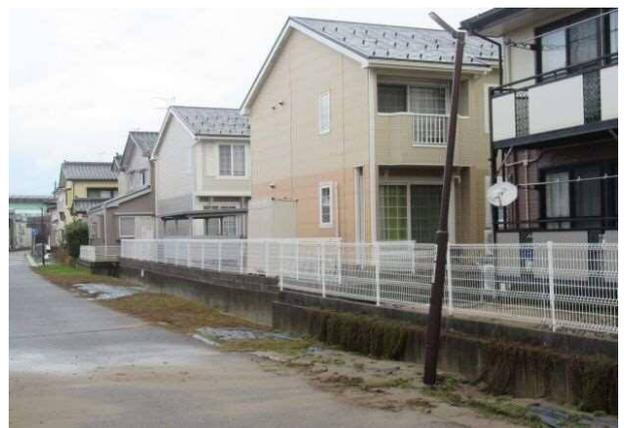
写真 4.5.80 液状化による家屋の傾斜
