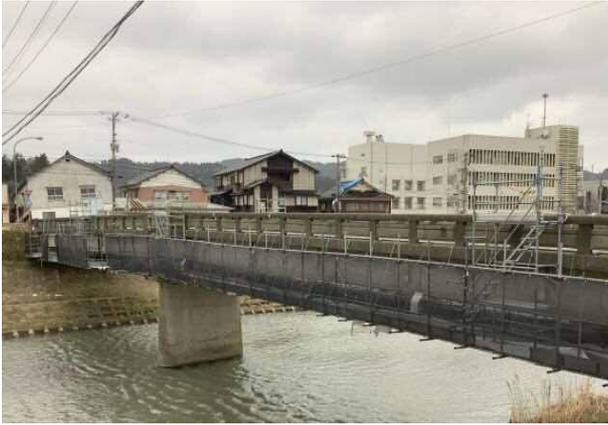
写真 4.1.11 ニツ屋橋全景（二径間単純桁橋）
