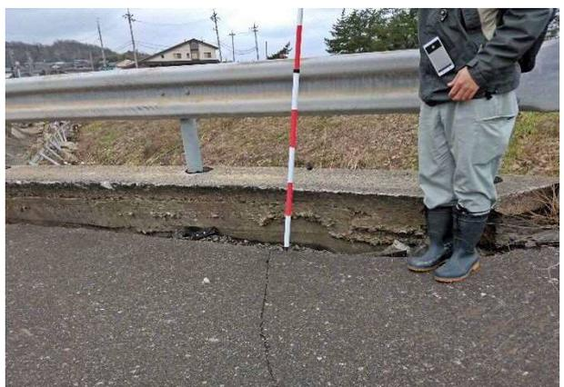
写真4.2.7 同左 路面の沈下(図4.2.2 ③)
