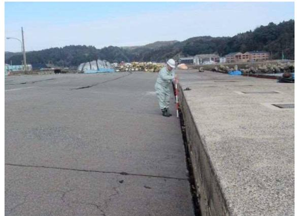
写真 4.3.17 ケーソン護岸背後の沈下 (図 4.3.3 ③)
