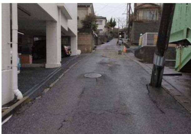
写真 4.5.73 傾斜方向の道路の隆起・沈下
