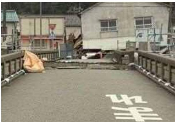
写真 4.1.13 橋桁の段差と横ずれ
