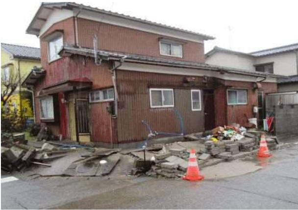
写真 4.5.75 流動による地盤の隆起と家屋の傾斜
