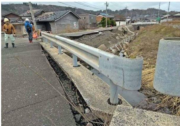
写真4.2.6 ブロック積擁壁の変状による路面の開口(図4.2.2 ③)
