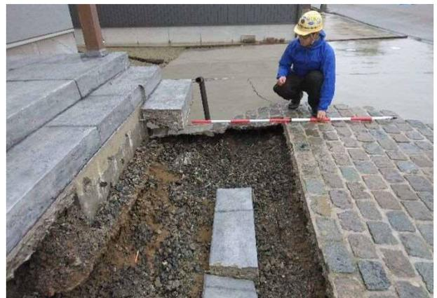
写真 4.5.43 推定1mの地盤の流動変位(右側が長者川)
