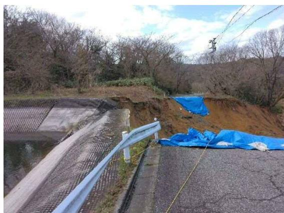
写真 4.7.9 決壊箇所および堤体上の市道の被害
