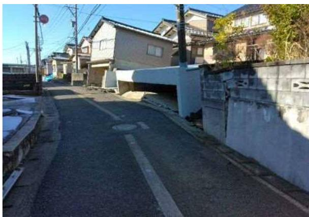
写真 4.5.70 旧道沿いの家屋の変状 (図 4.5.36 ④、右側が内灘砂丘)
