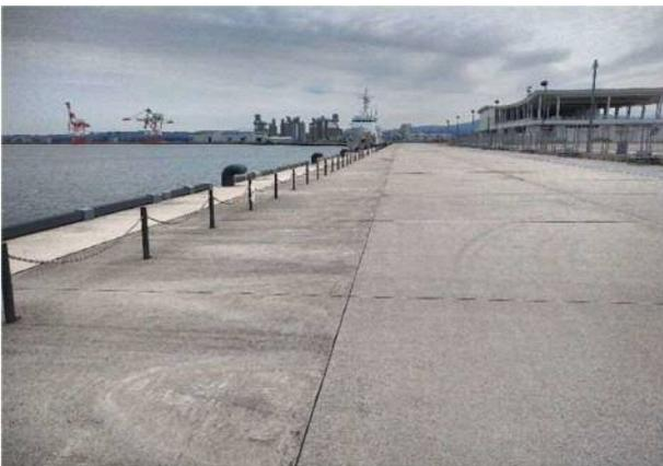
写真4.3.45 無被害の耐震強化岸壁(図4.3.9 ①)
