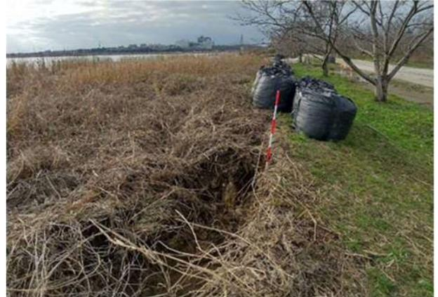
写真 4.2.11 正面堤防の沈下状況
