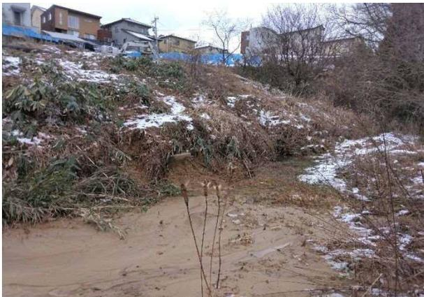
写真 4.5.32 崩壊した盛土の末端部の変状
