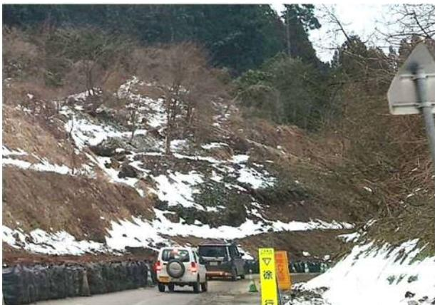
写真4.5.7 北側の道路法面崩壊(図4.5.9 ①)
