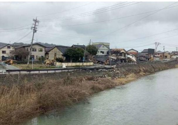
写真 4.2.2 護岸崩落と背面道路の沈下
