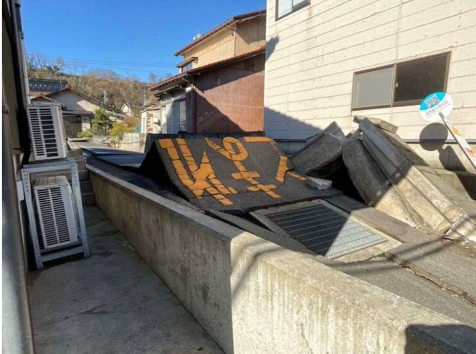
液状化により 1m 余めり込み沈下した 3 階建てビル（内灘町宮坂）
