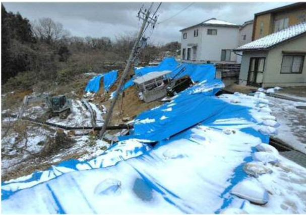
写真 4.5.31 谷埋め盛土上端部の崩壊
