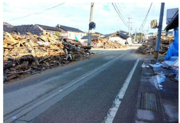
写真 4.4.4 沈下・傾斜した電柱
