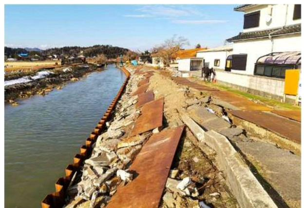
写真 4.1.2 上流左岸側の工事用敷鉄板の滑落
