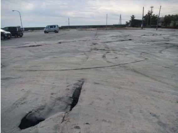
写真 4.3.15 駐車場全面の噴砂 (図4.3.3 ①)
