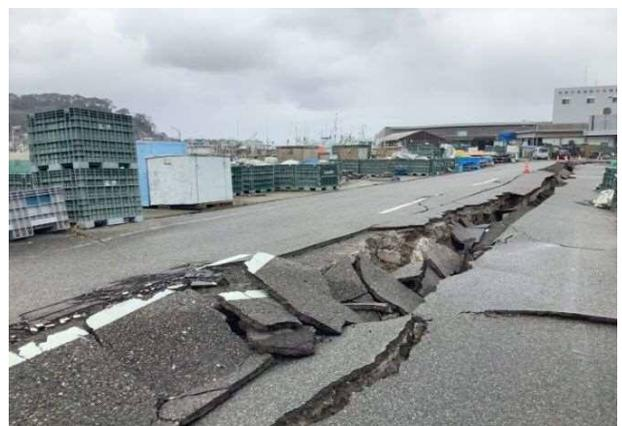
写真 4.3.28 輪島港河川突堤の路面の段差
