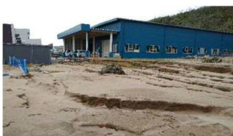
① 砂丘側での階段状の段差、開口、亀裂
