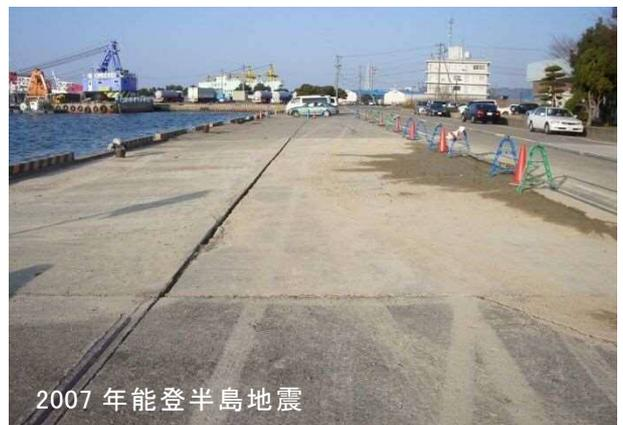
写真 4.3.44 2007年地震の際の一般部の岸壁の噴砂（矢田新地区④）
