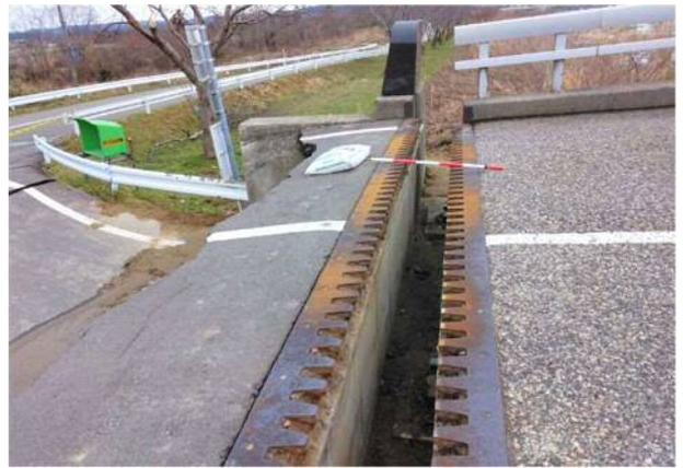
写真 4.1.22 北側橋台（左）と橋桁（右）間の開口および段差
