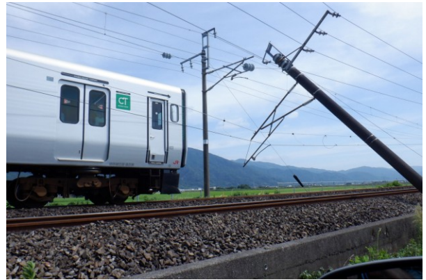
鹿児島本線の被害状況
