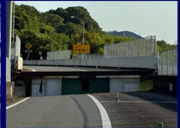
上り線の桁ずれ及び段差 (NEXCO西日本発表資料より引用)
