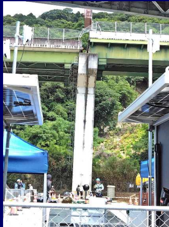
上り線の桁ずれ及び段差 (NEXCO西日本発表資料より引用)
