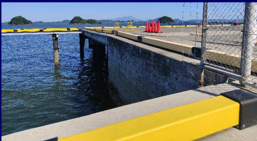
③,④ 鋼製ジャケット接続部の段差（砂利で応急復旧済）
