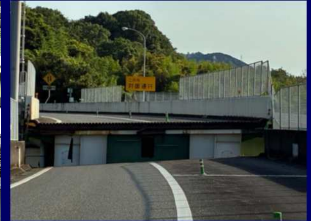
上り線の桁ずれ及び段差 (下記文献*より引用)
