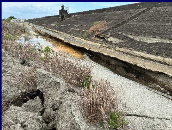
③ 法面はらみ出し・法尻沈下
