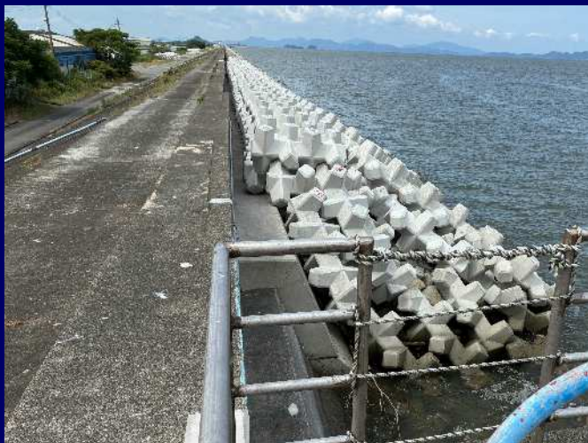
③ 法面はらみ出し・法尻沈下
