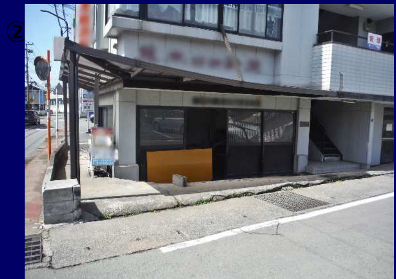
② 建物の沈下（2016熊本地震時撮影）
