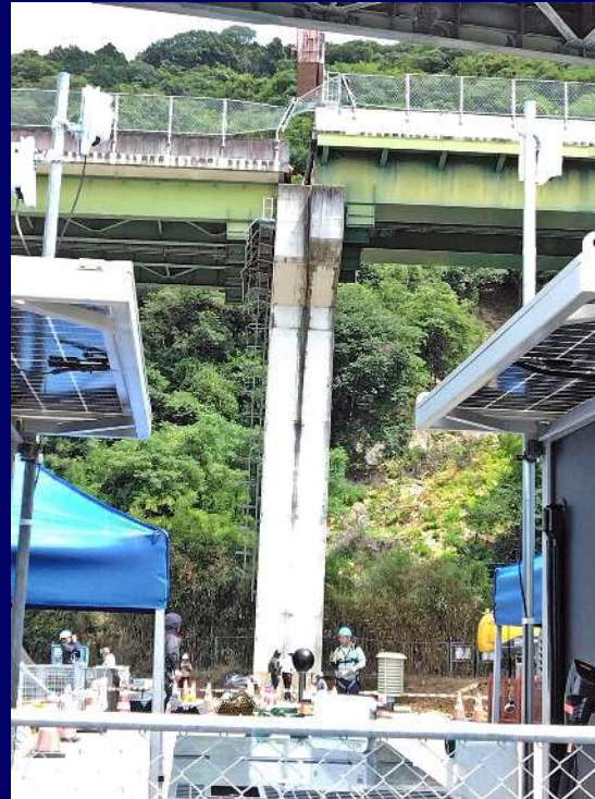
上り線の桁ずれ及び段差 (下記文献*より引用)
