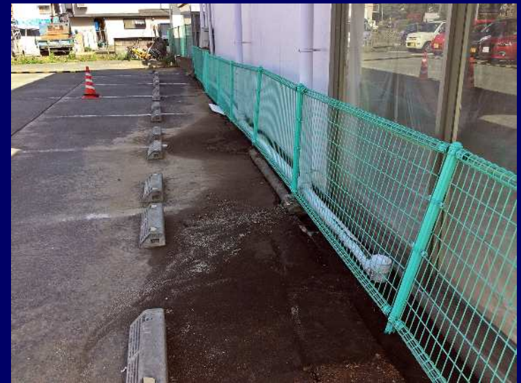
② 建物の沈下（2016熊本地震時撮影）
