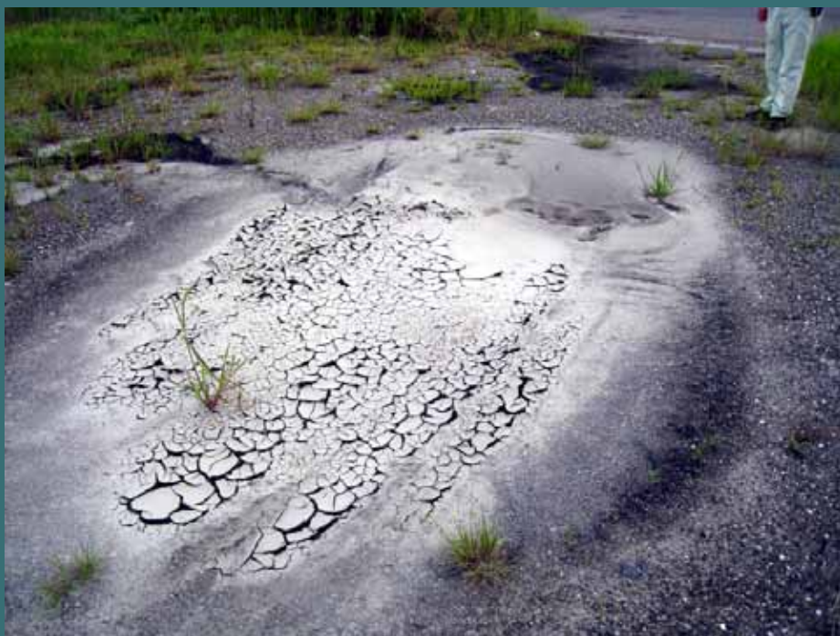
埠頭用地の未舗装地盤で見られた噴砂
