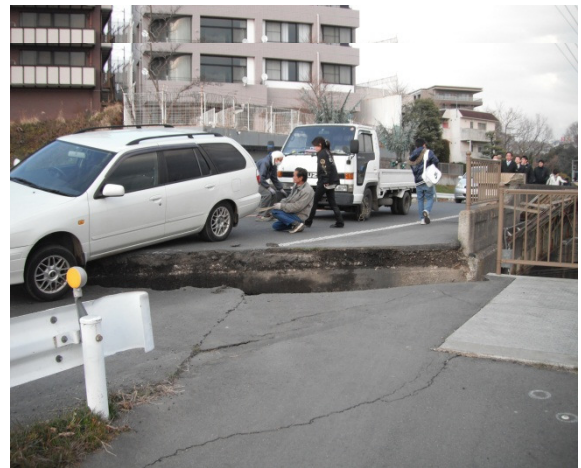
③ 水戸市桜川を渡る橋梁取付部で発生した道路面の段差
