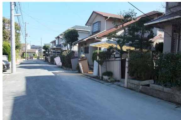
⑳ 住宅の不等沈下と塀の傾斜 (安田教授提供)
