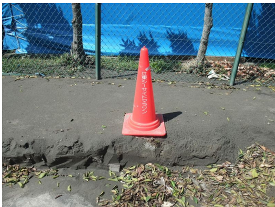
⑦ 液状化による噴砂厚は 20cm を越える
