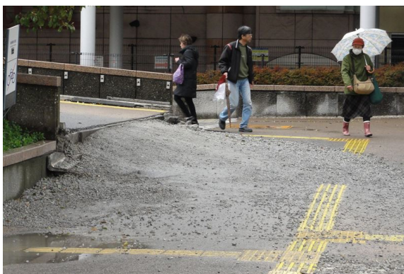
③ 新浦安駅前の液状化による段差
