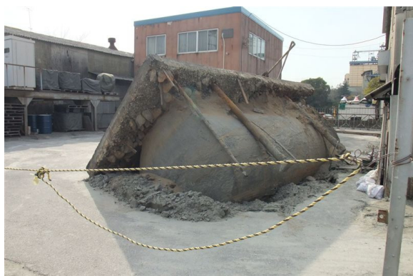
⑰ 船橋市日の出の重油タンクの浮き上がり (安田教授提供)
