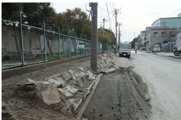
⑬ 厚く堆積した噴砂の状況 (安田教授提供)
