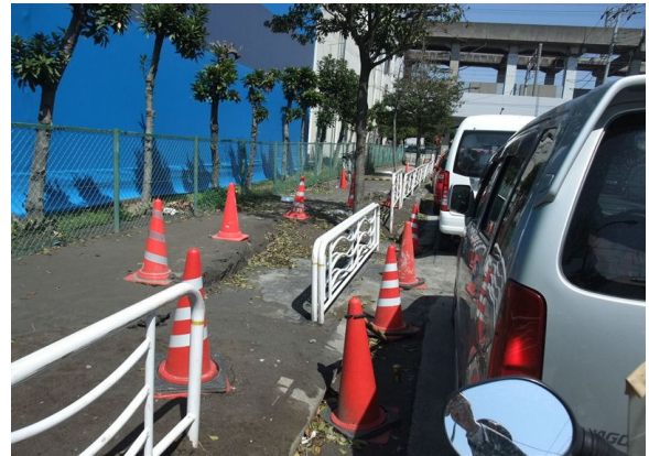
⑥ 歩道に堆積した噴砂 (安田教授提供)
