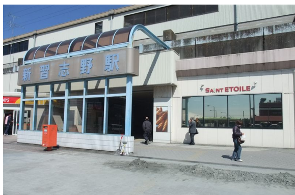
⑱ 液状化による習志野駅前の噴砂 (安田教授提供)
