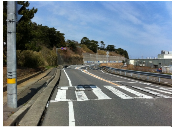
③⑪ 県道 6 号の盛土直下地盤の液状化による道路の崩壊・陥没
