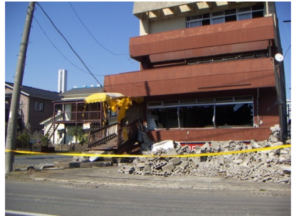
③⑦ ひたちなか市の1階部分が座屈したビル
