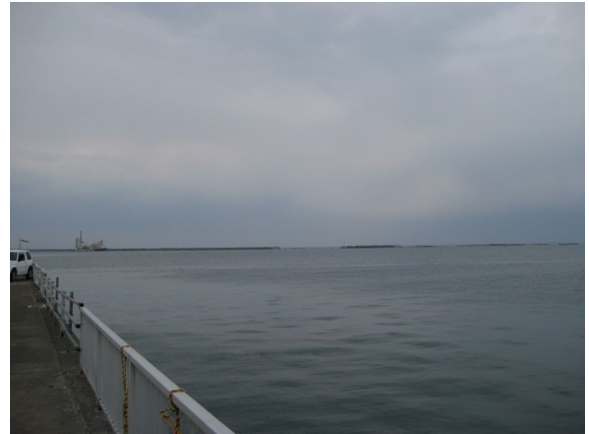
⑬ 八戸港防波堤の倒壊
