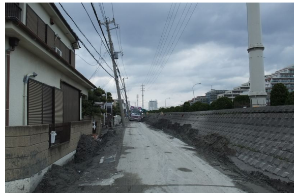
⑩ 激しく吹き上がった噴砂跡と電柱の傾斜 (安田教授提供)
