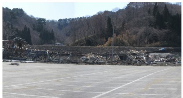
⑦ 宮古南 IC 付近における鉄道盛土の流出
