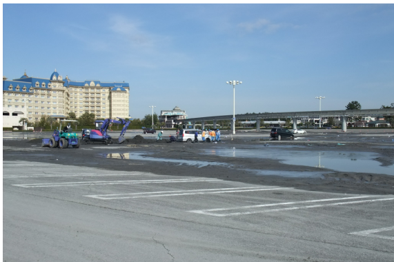
① 浦安ディズニーランド駐車場の液状化 (安田教授提供)
