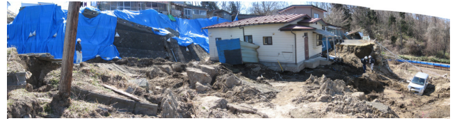
① 二戸市石切所杉ノ沢の盛土崩壊は火山灰質土の液状化と推察される
