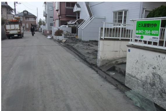
⑪ 新浦安の住宅地に厚く堆積している噴砂 (安田教授提供)
