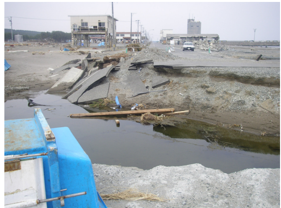
⑮ 津波による三沢漁港臨海道路の流出
