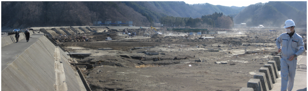
⑤ 田老町防波堤の内市街地の津波被害では堤防裏のり面が流出している
