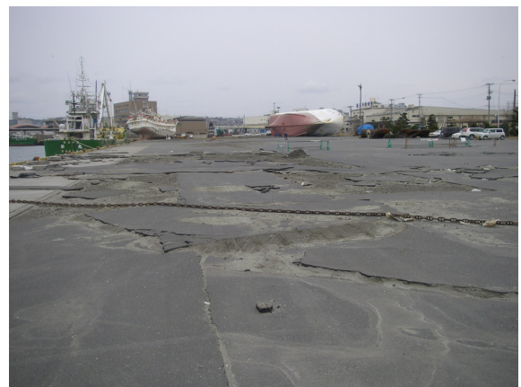
⑪ 八戸市湊町漁港エプロンの津波被害と再液状化跡（本震の墳砂跡は津波で流出）
