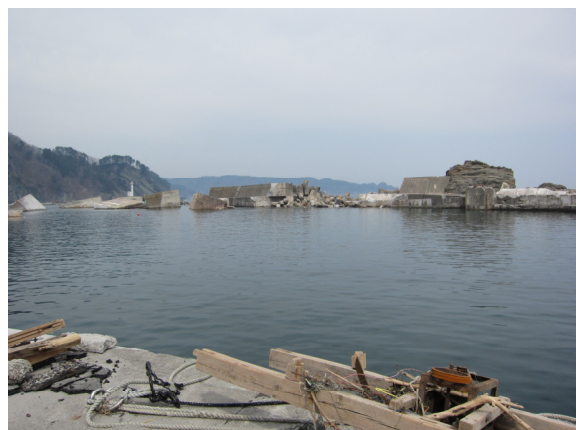
⑨ 山田漁港の防波堤の津波による倒壊
