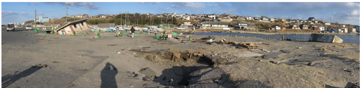
⑯ 八戸市蕪島神社付近の地盤は津波で流出している
