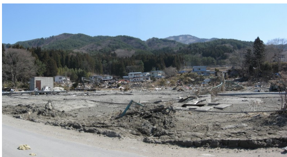
⑥ 宮古湾奥部の津波被害状況
