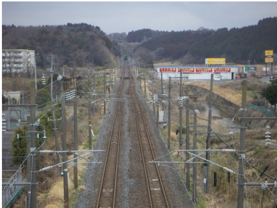
④② 高萩付近で生じた常磐線の軌道蛇行
