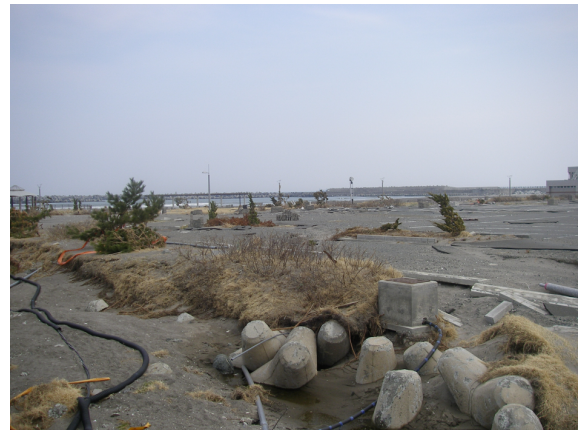
⑨ 三沢漁港駐車場の液状化被害で一面に噴砂と陥没が見られる
