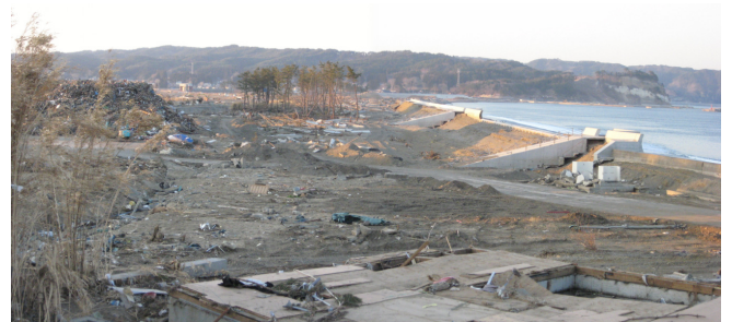
② 野田村十府ヶ浦の防波堤背後のり面が流出した
