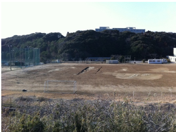
④⑩ 谷埋め造成によるグラウンドの液状化 (鹿嶋市)
