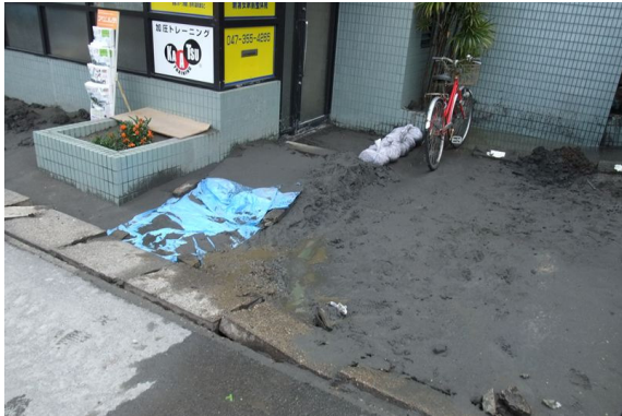
⑦ ビルの根元からの噴砂跡 (安田教授提供)
