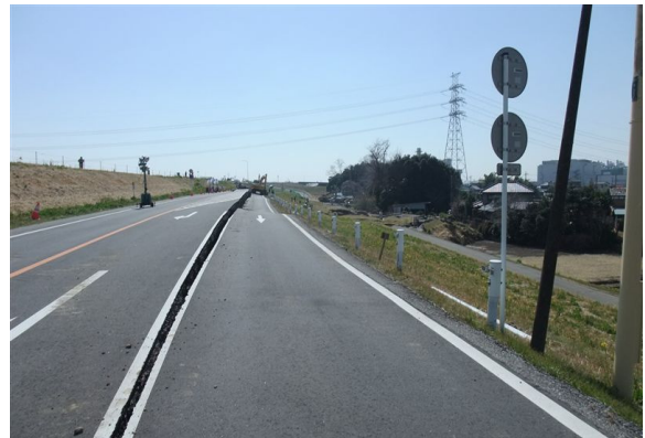
②⑧ 中腹道路から見た断面方向の変状 (江戸川右岸 57.8km 付近) (安田教授提供)
