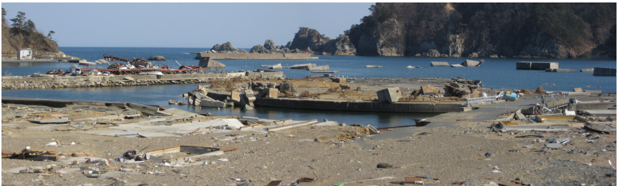
④防波堤が損失した田老町沿岸部
