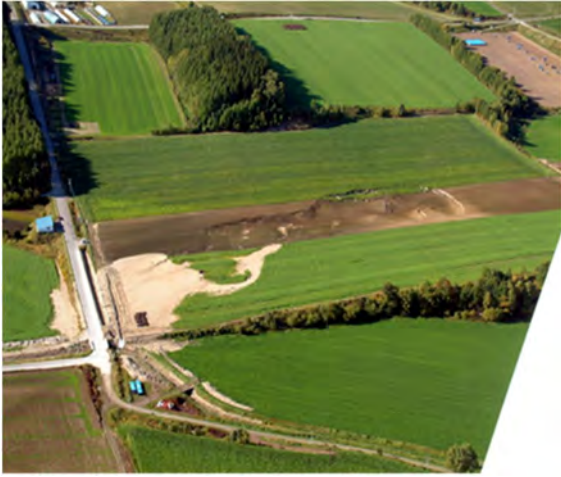
写真 4.3.13 陥没・流出地域の全景 10) (北見工業大学提供)
