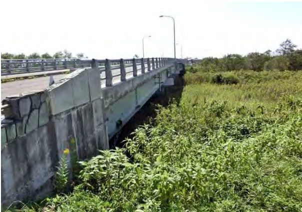
写真 4.2.1 豊川橋の全景
