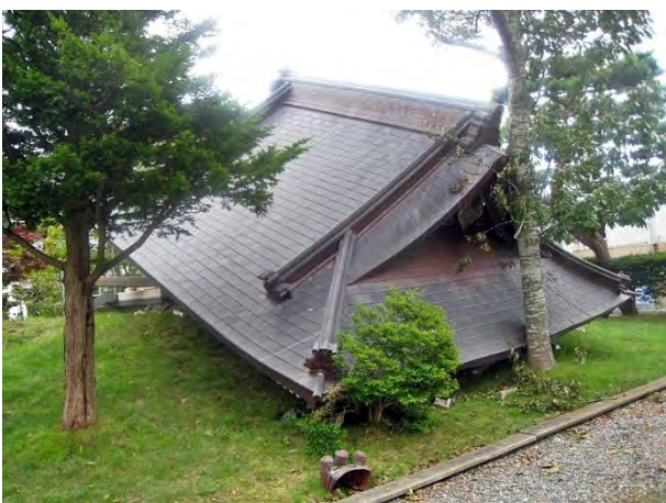
写真 4.3.40 寺院の鐘楼の倒壊 (範囲外 北方)
