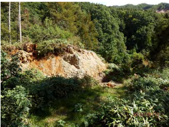
⑪移動地塊内中央部にみられる滑落崖
