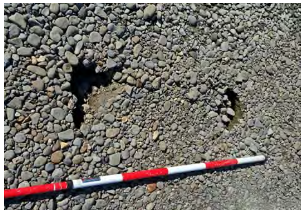
写真 4.5.39 液状化に伴う路面陥没（長さ 0.8m、変状箇所 B）
