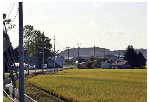
写真 4.1.30 道路際の家屋の倒壊により通行不能となった
