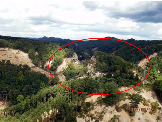
① 近隣で発生している岩盤崩壊
