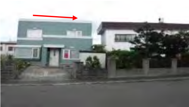
地点⑤ 建物の傾斜
