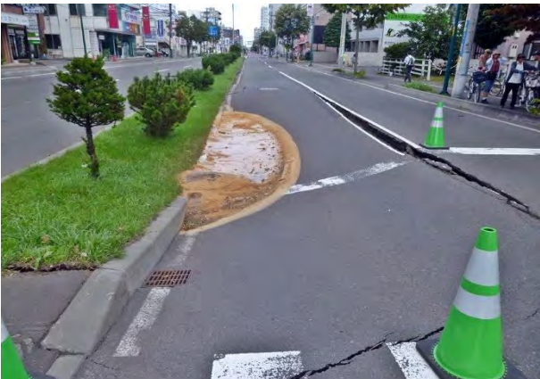
①中央分離帯の噴砂とセンターラインの段差
