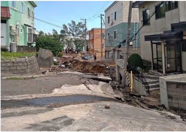
写真 4.3.6 土砂が地表に噴き出した付近の状況（地点④）
