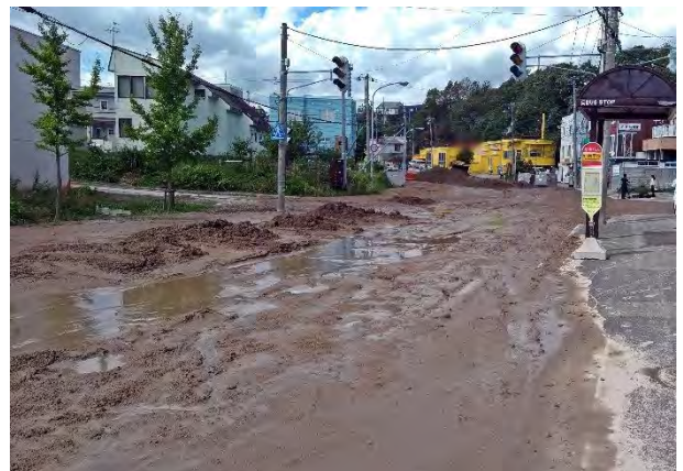
写真 4.3.3 道路に流出・堆積した土砂 (地点①-2)
