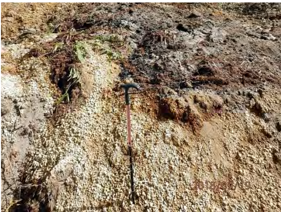
⑨崩壊による堆積物（火山灰主体）
