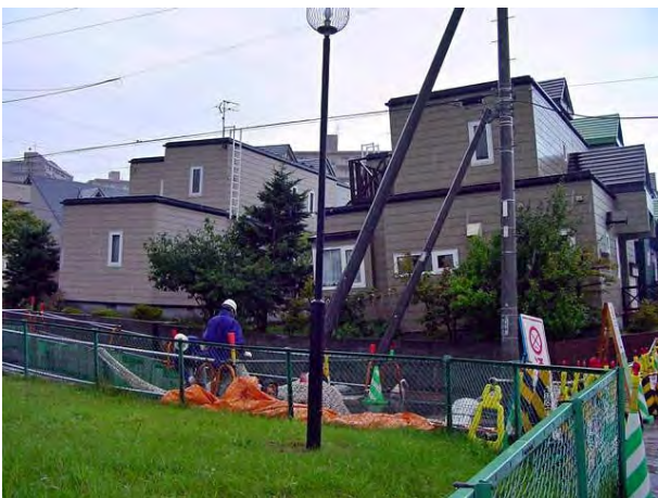
写真 4.3.15 家屋の傾斜(2003年十勝沖地震) 10)
