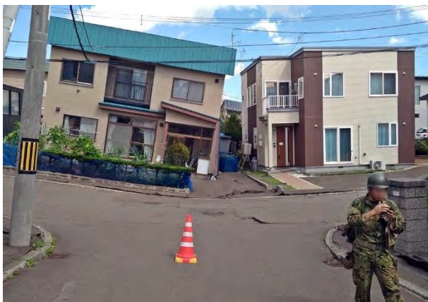
写真 4.3.10 地盤の陥没による家屋の傾斜（地点⑧）
