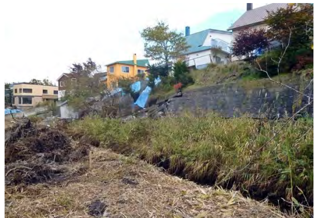
写真 4.3.21 河川側の擁壁 (A 地点のやや南より北側を見る)
