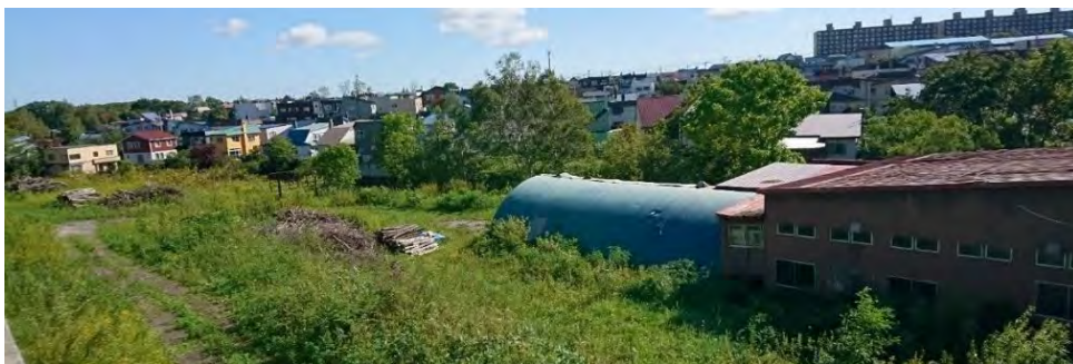
写真 4.3.17 大曲川左岸より右岸の被害住宅地を望む
