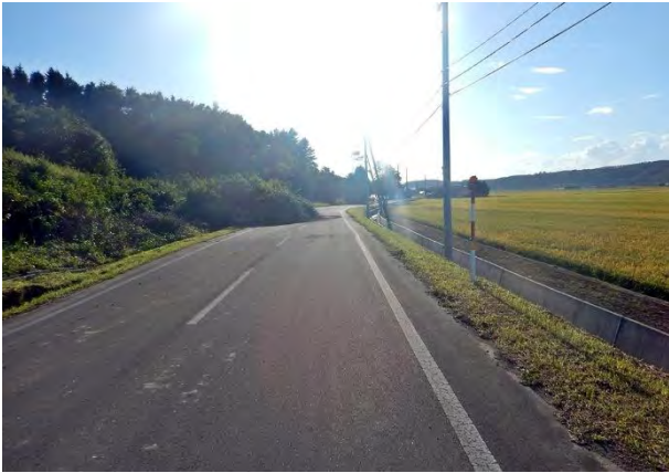
写真 4.1.25 斜面の崩壊土によって覆われた道路
