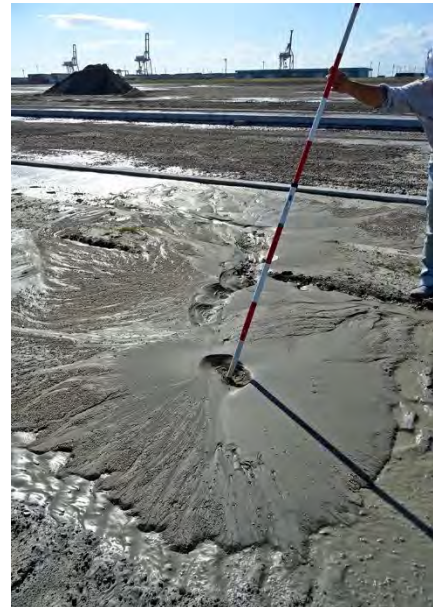
写真 4.5.37 同左近景（変状箇所 B）
