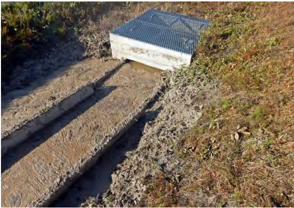
写真 4.5.26 水路は噴砂で満杯となっている
