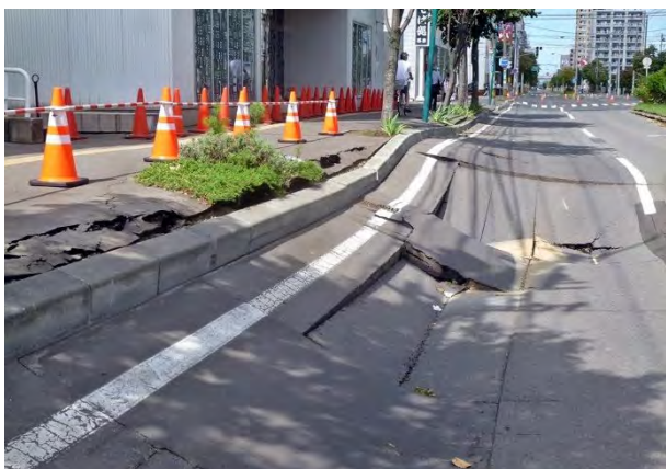
①道路の沈下・陥没・波打ち
