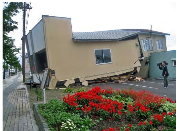
写真 4.3.35 2階建て建物の層崩壊 (地点②)
