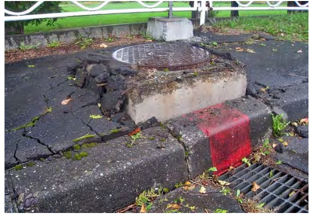
写真 4.5.41 同左マンホール近景
