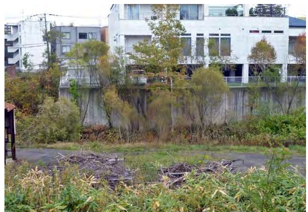
写真 4.3.28 河川側の健全な擁壁 (E 地点)
