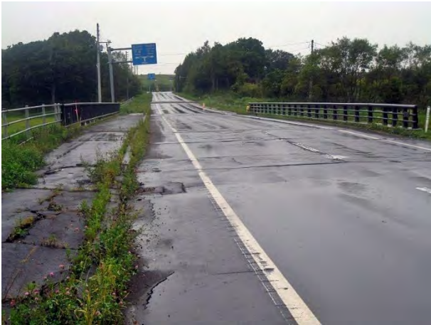
写真 4.2.9 北進橋の全景
