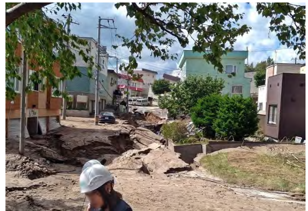
写真 4.3.5 土砂が地表に噴出・流出した状況 (地点②)
