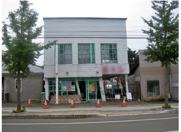
写真 4.3.39 2階建て建物のせん断変形 (地点⑥)
