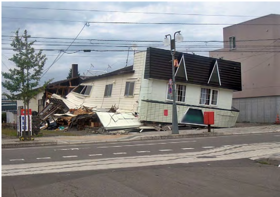
地震動による2階建て建物の倒壊（勇払郡むかわ町）
