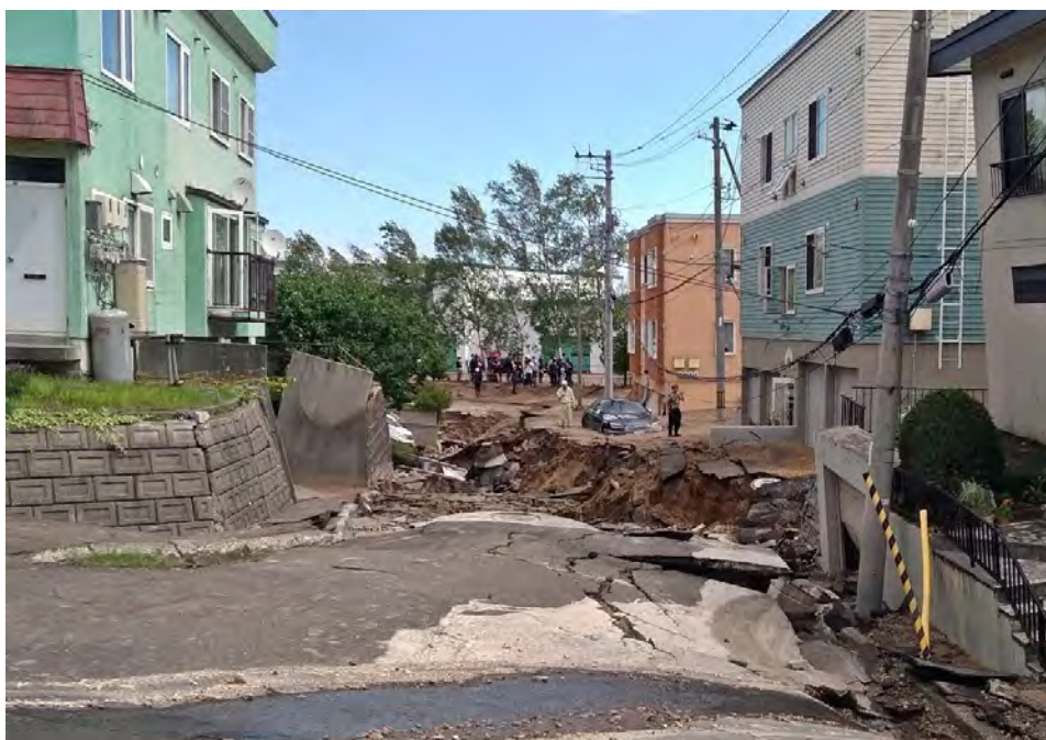
土砂の噴出・流出で洗掘された道路（札幌市清田区里塚地区）
