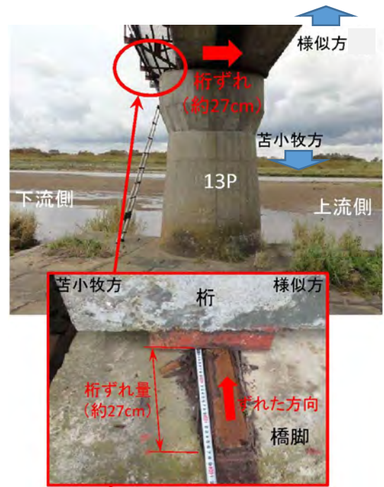
写真 2.3.3 JR 厚真川橋梁における橋桁のずれ 10)
