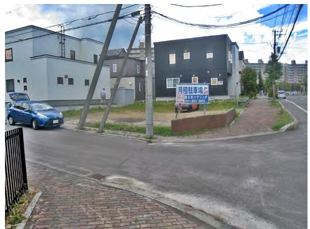
写真 4.3.16 空地となっている場所で見られた噴砂(胆振東部地震)
