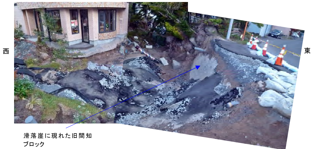
写真 4.3.31 滑落崖に現れた旧間知ブロック (①地点)
