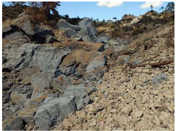
⑧崩壊による堆積物（岩塊主体）
