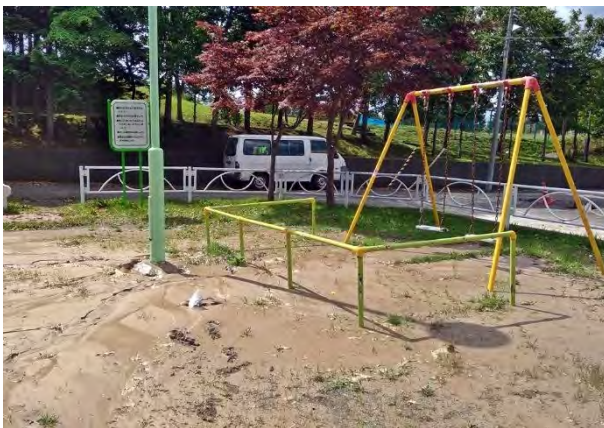
写真 4.5.7 清田区美しが丘 7 丁目公園内の噴砂
