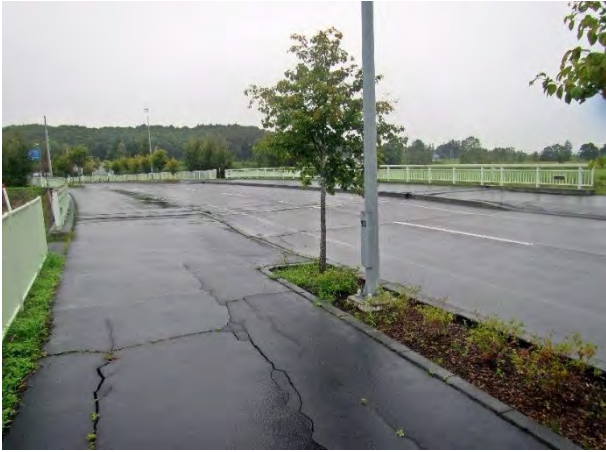
写真 4.2.13 咲来橋の全景
