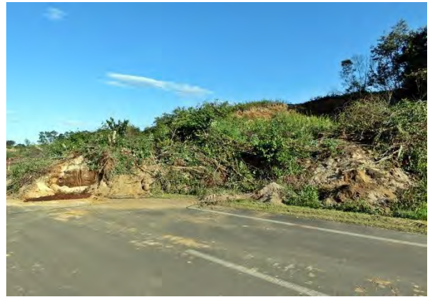
写真 4.1.26 道路を覆った崩壊土砂
