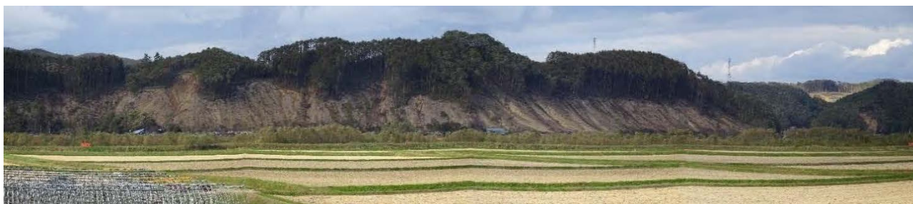
写真 4.4.2 吉野地区の斜面崩壊箇所の全景
