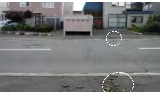
地点③ アスファルトの破損 (破線丸印)
