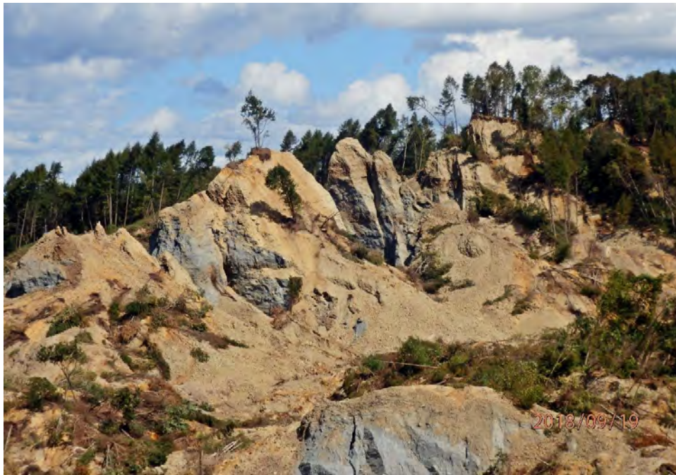
斜面崩壊により丸裸となった山地（勇払郡厚真町幌内）
