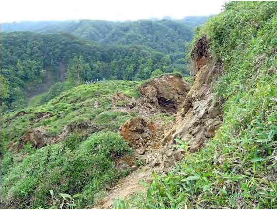
⑤ルベシベ川右岸の岩盤崩壊
