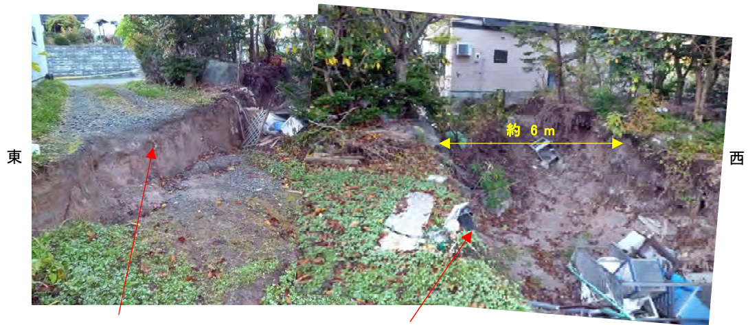
2 段目の滑落崖は開口に よるもの。移動量約 6m。
