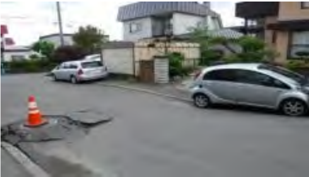
地点③ アスファルトの破損 (破線丸印)
