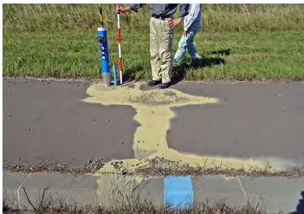
写真 4.5.32 消火栓の根元から噴出した噴砂（変状箇所 A）
