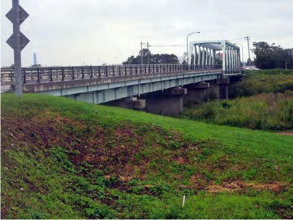
写真 4.2.5 上厚真大橋の全景
