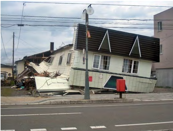
写真 4.3.36 2階建て建物の層崩壊 (地点③)
