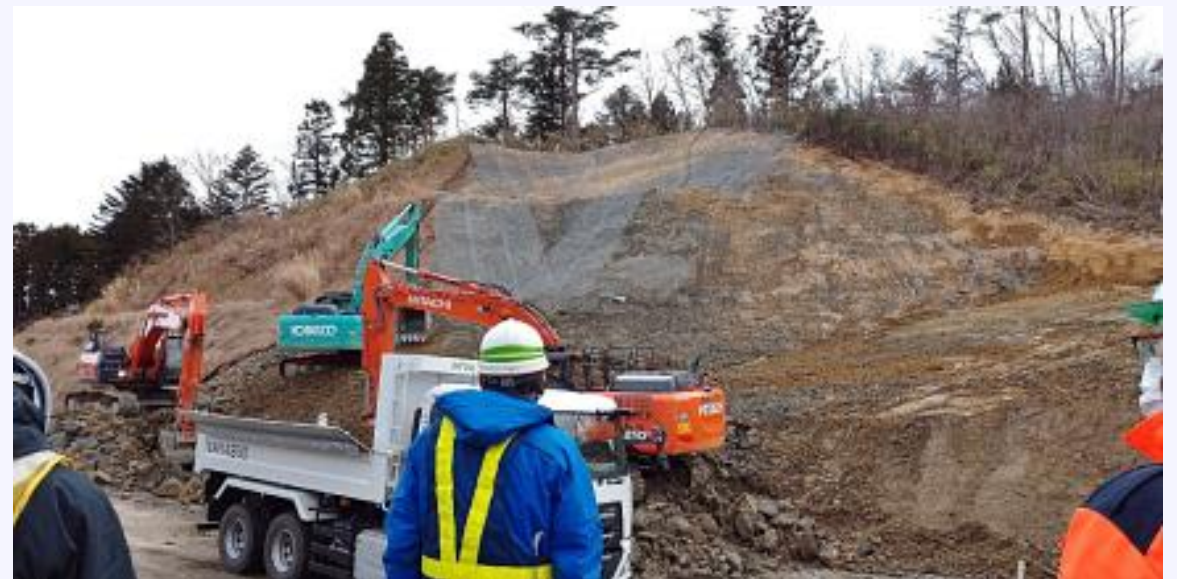
崩壊土が撤去・整形された斜面上部。左側が整形された斜面、右側が崩壊ブロック
