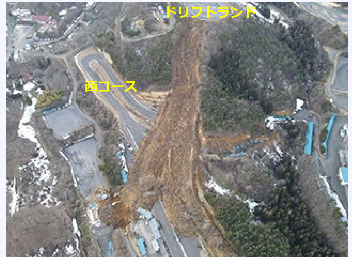
斜面崩壊の状況（出典1に加筆）
