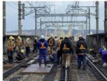
仙台～古川間 分岐器軌道整備
