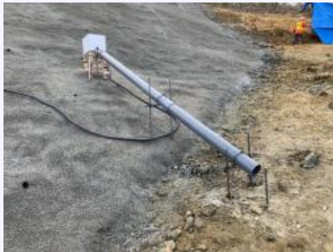
伸縮計 東日本高速道路(株)東北支社より提供
