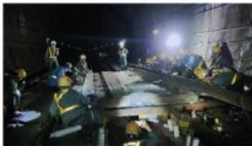
福島～白石蔵王間 スラブ低下施工
