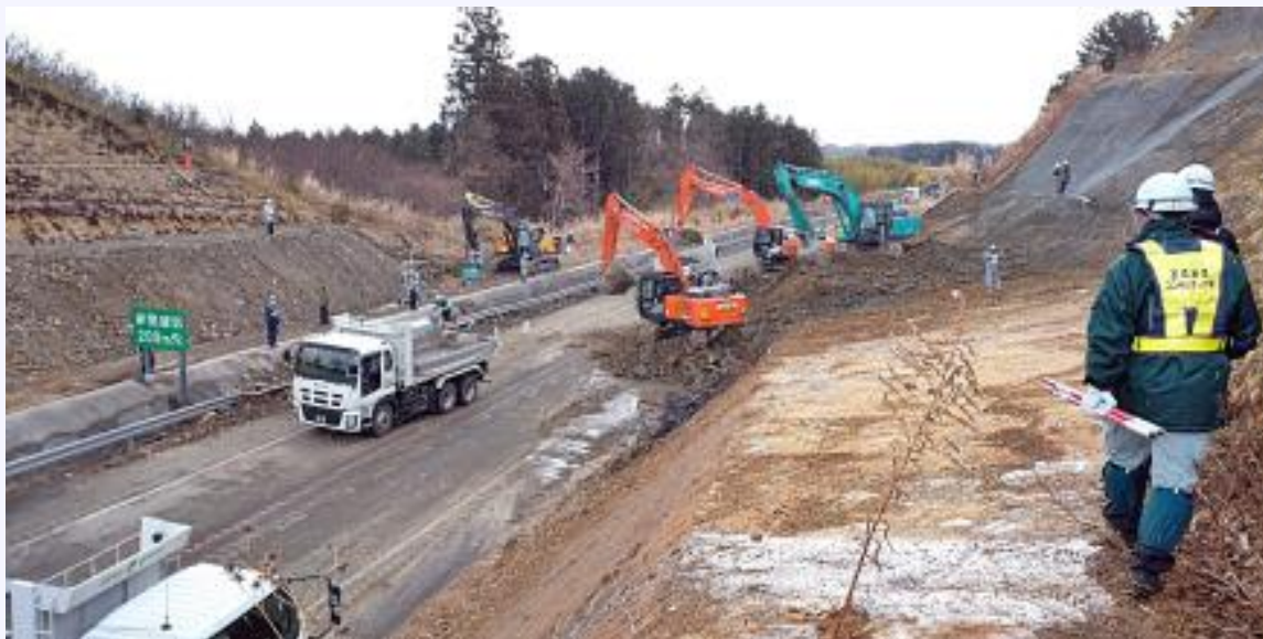
重機による崩壊土砂の撤去状況
