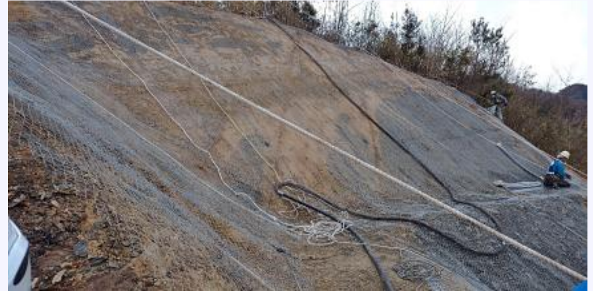
整形作業中の崩壊斜面。不安定な個所は排除し、モルタル吹付のラス網を施工中。
