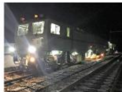
白石蔵王～仙台間 MTT施工
