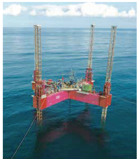
洋上風力に係る地盤調査(スパット台船オリオン)
