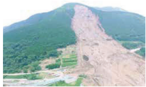
熊本地震による阿蘇大橋の落橋と斜面崩壊
