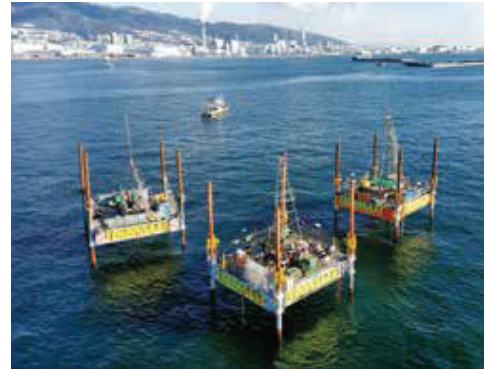
海上ボーリングの状況
