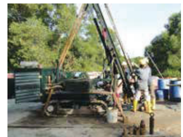
斜め深掘りボーリング調査
