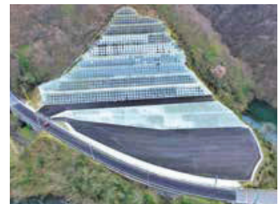
徳山ダム貯水池地すべり対策工完成状況
