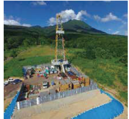
掘削調査ヤード全景（青森県弘前市岩木山）
