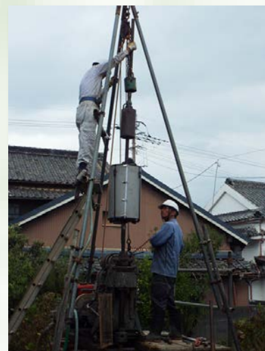
減音ボックス取付け状況
