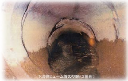
下水道ホーム管の切断(2箇所)
