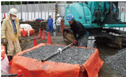
① D・Boxの袋を専用枠にセットし、上部より中詰め材（主にC40）を袋一杯になるまで投入する。
