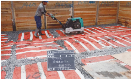
⑤ D・Boxの敷設後、ランマや振動コンパクタ等を用いて転圧する。
