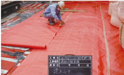
⑥ 転圧終了後、D・Box上面に透水シートを敷設する。
