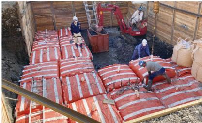
④ D・Boxを保管場所から敷設箇所まで運搬し、クレーンにて配置する。
