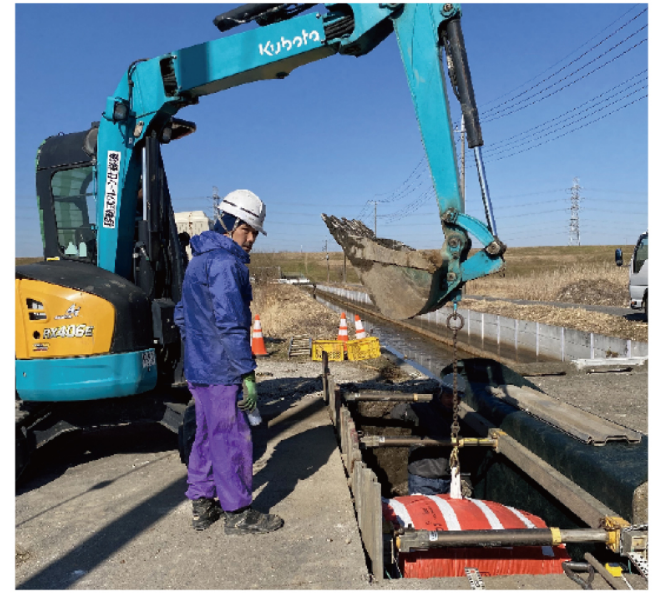
3 D・Boxの敷設(1段)
