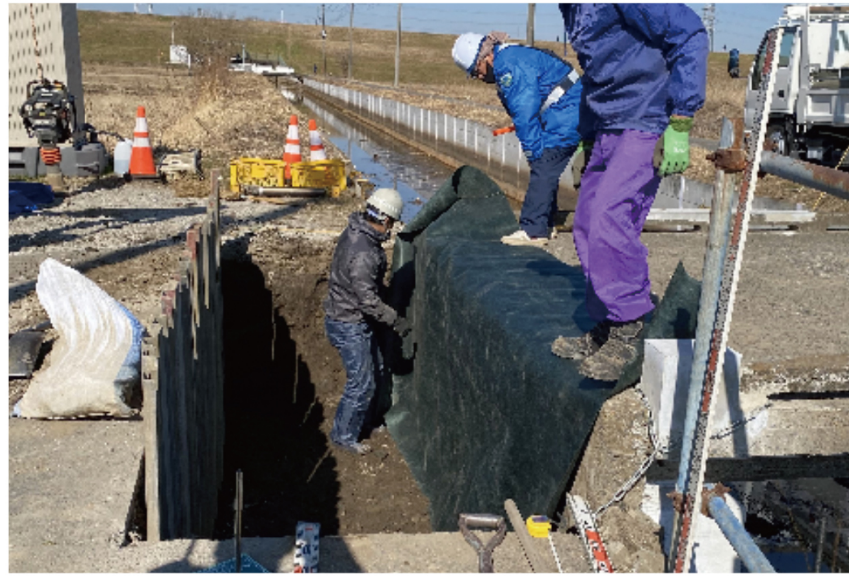
2 耐候性フィルターシートの設置
