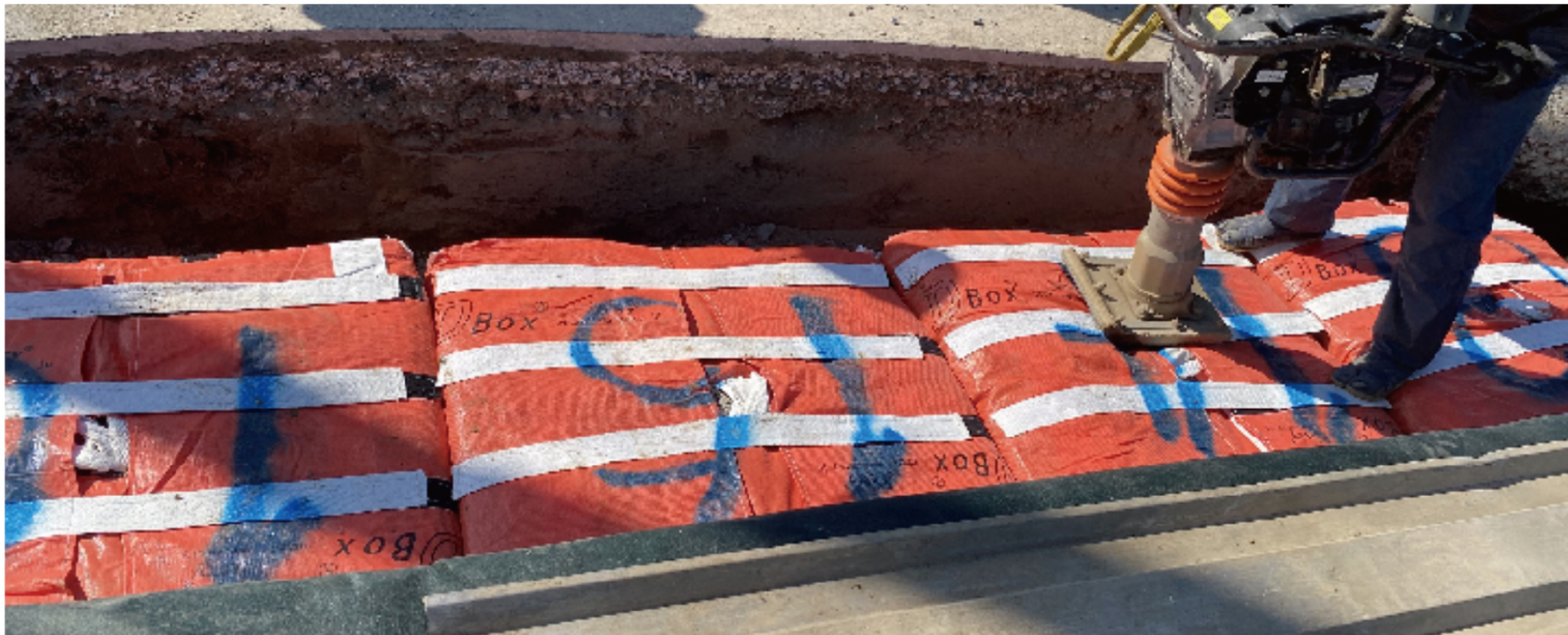
4 D・Boxの敷設(4段、ランマー転圧)
