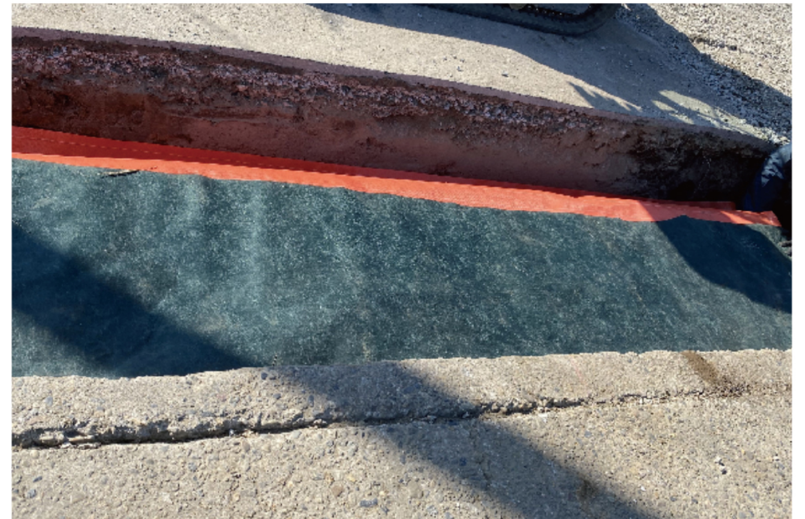
5 D・Boxを覆う透水シートと耐候性フィルターシートの敷設
