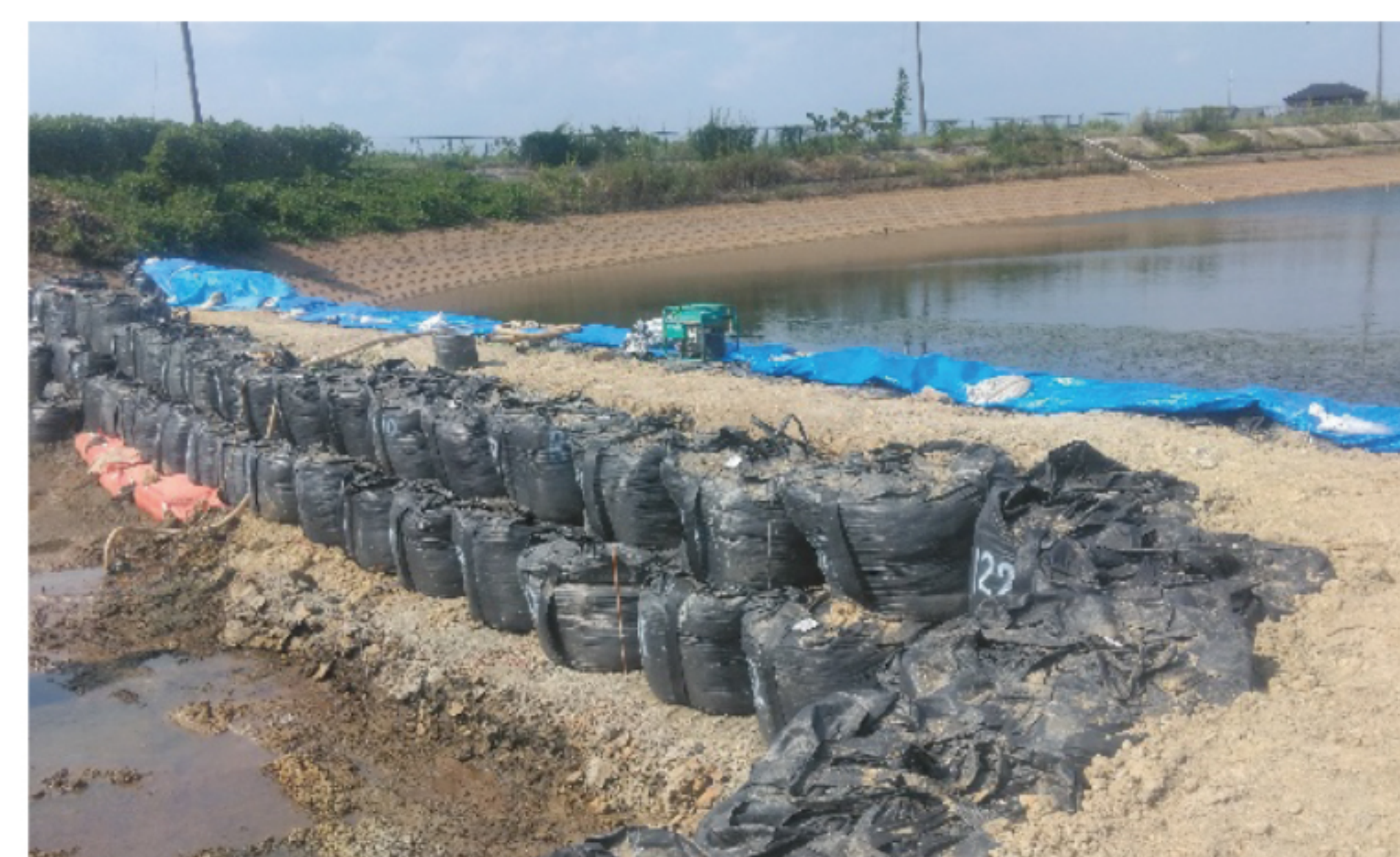
⑥ D・Box上面に透水シートを敷設する。その上にフレコンバッグを2列配置し、フレコンバッグの間を土砂で埋める。
