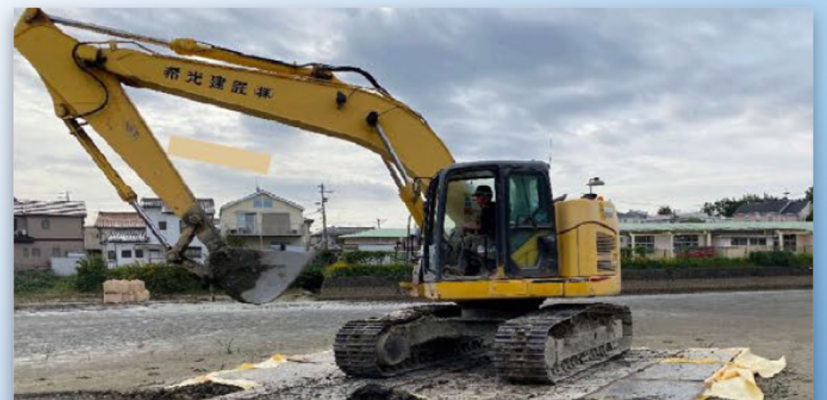
バックホウ(0.8m 3 、機械質量20t)による走行安定性の確認
