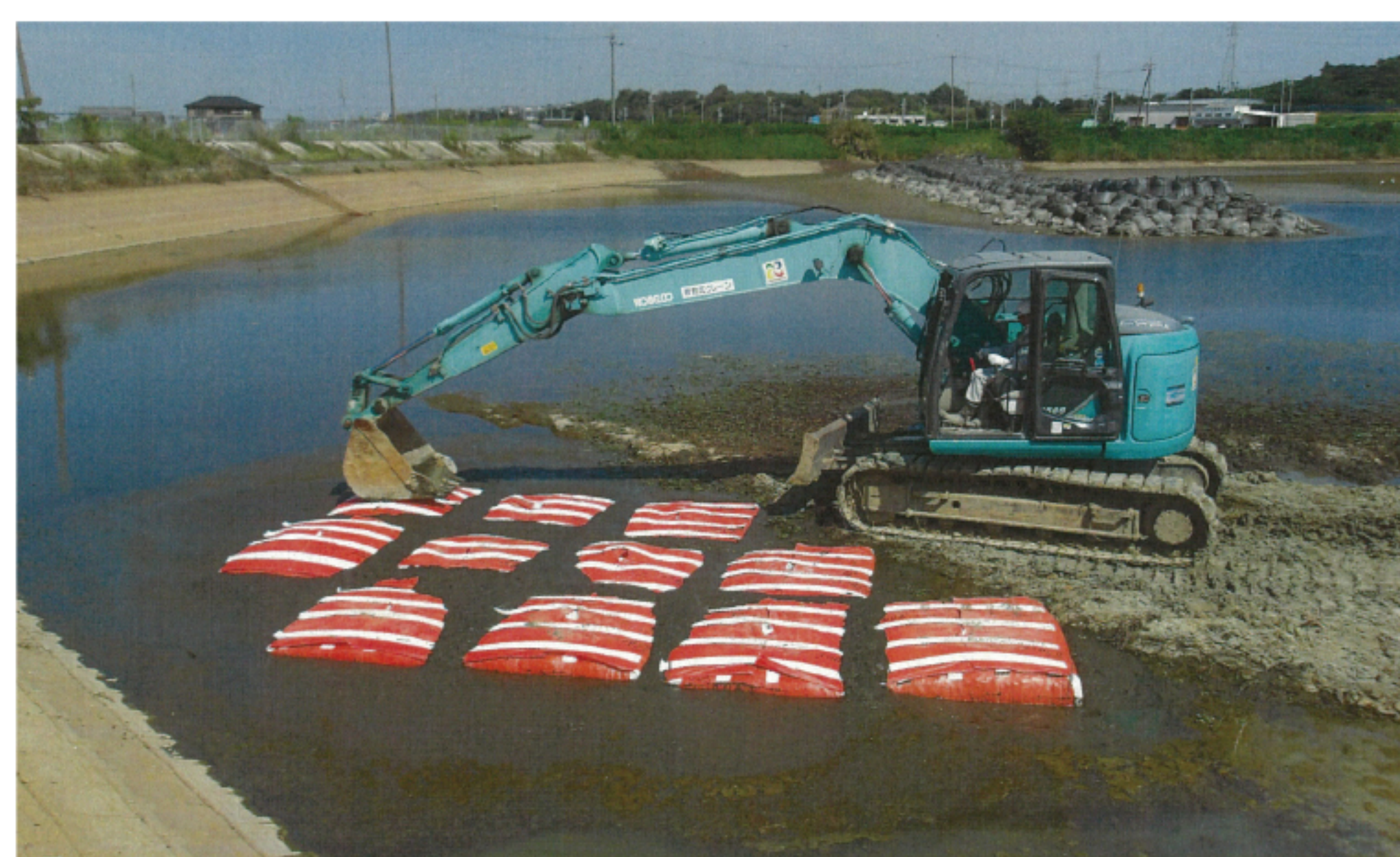
⑤ D・Boxの敷設後、重機(バックホウ)を用いて転圧する。
