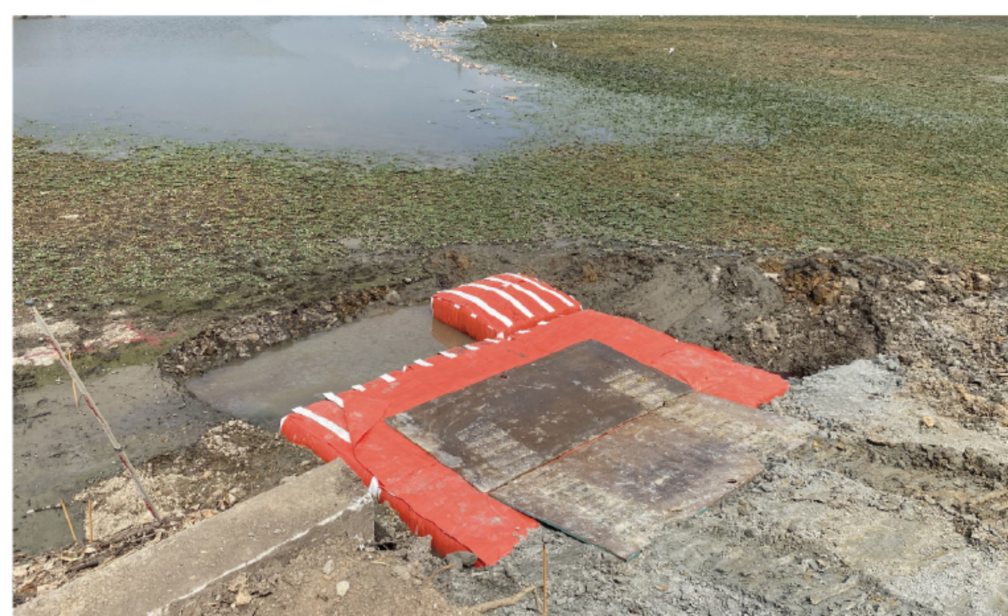
④ D・Boxを保管場所から敷設箇所まで運搬し、クレーンにて配置する。その上に敷き鉄板を置く。
