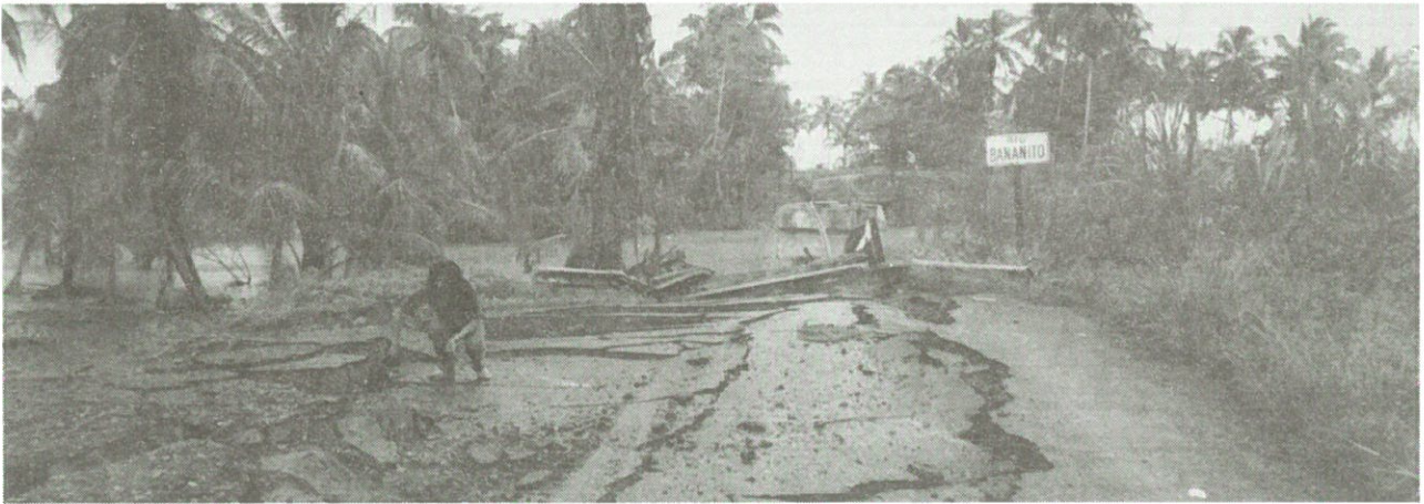
写真2.1 液状化による落橋 (Bananito川に架かる橋)
