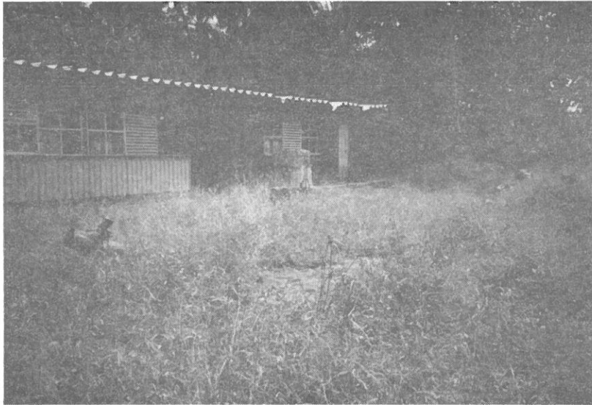
写真4.21 建物の裏側での噴砂
