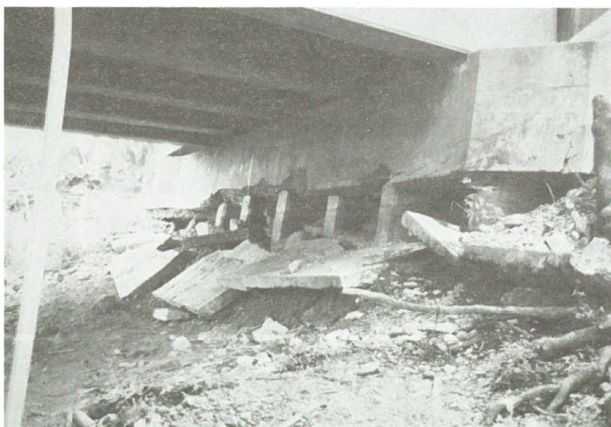
写真6.6 Chirripo Atlantica川に架かる橋の落橋部分の修復状況
