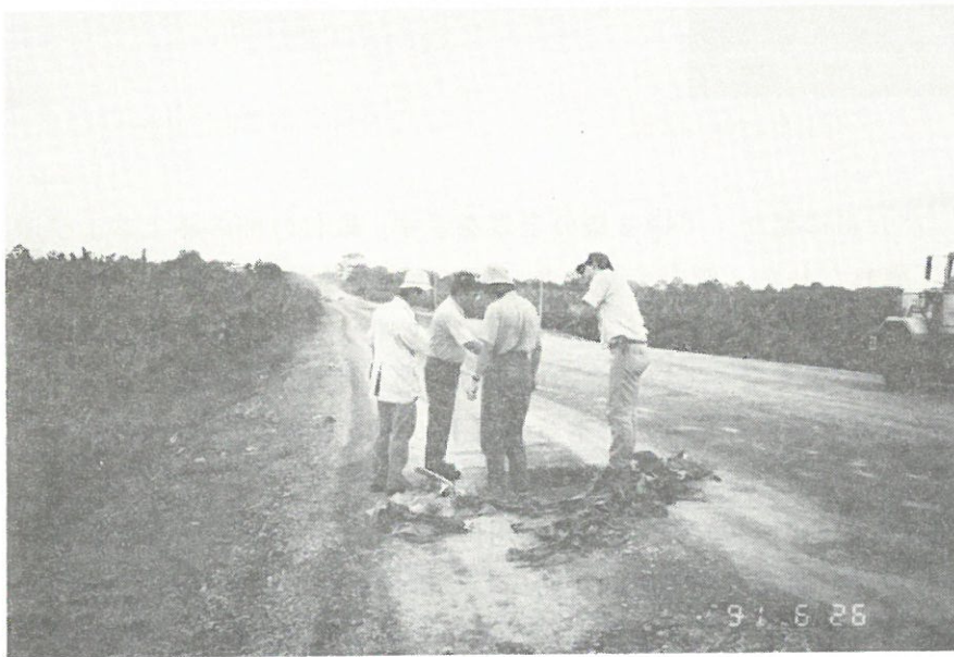
写真4.4 Chirripo川の東約500m での道路被害状況。 応急復旧はされている がまだ陥没した箇所も残 っている
