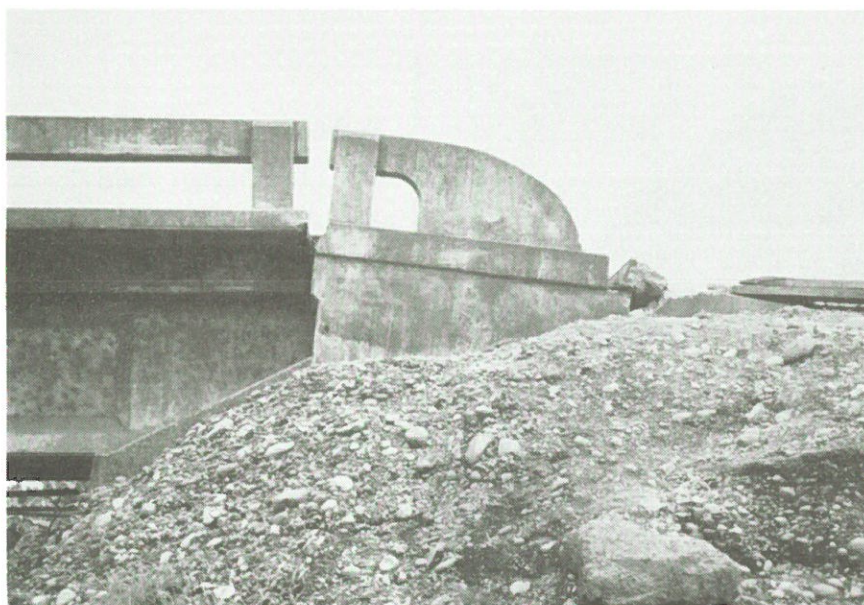
写真6.8 Cuba川に架かる橋のアバ ットメントの側方流動に よる傾斜
