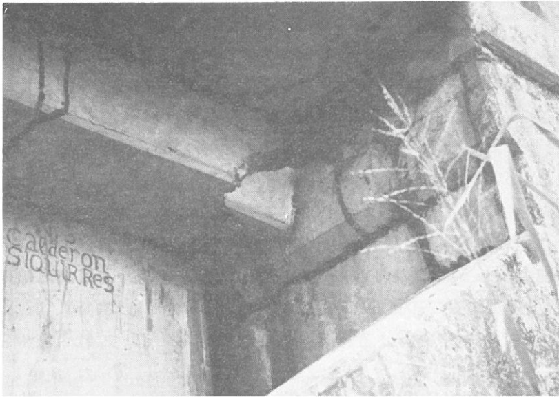
写真6.1 Quebrada Calderon川に 架かる橋
