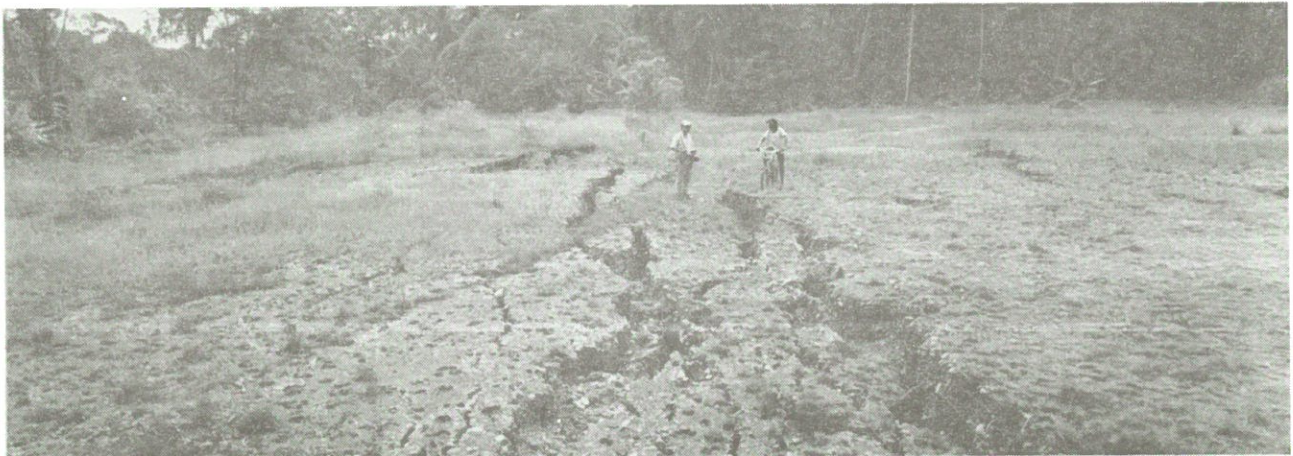
写真4.18 石油掘削用に盛土した箇所の被害（Matina川河口の少し南側） （写真6.10参照）
