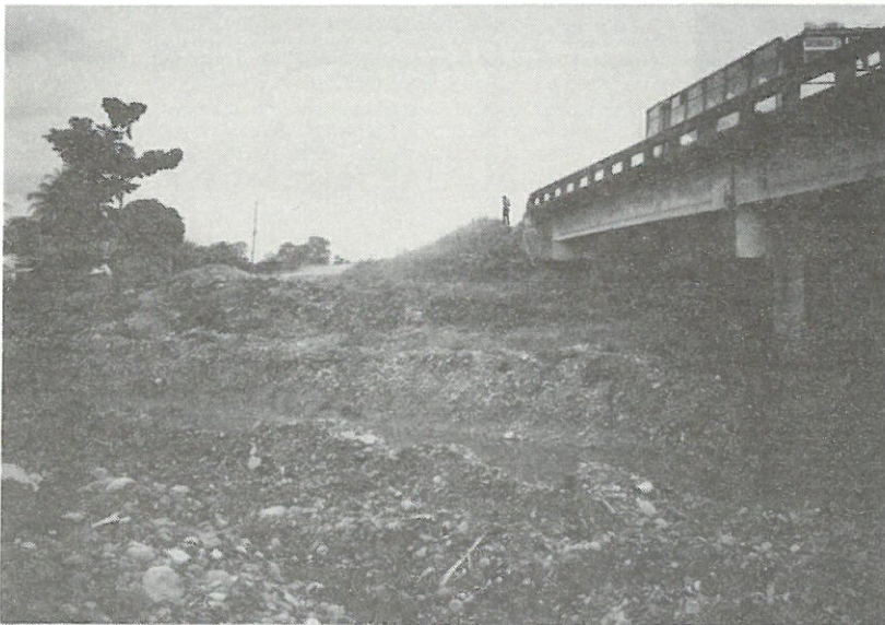
写真4.6 Cuba川に架かる橋の被害状況（とりつけ盛土は復旧されているが橋台は傾いたままである。写真6.7、6.8参照）
