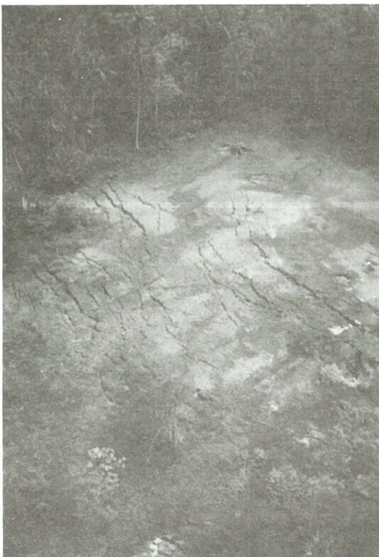
写真6.10 石油掘削基地の側方流動による亀 裂模様 (写真4.18参照)
