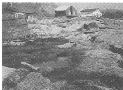
写真9.13 盛土部の被害（手前が図9.31(b)の住宅G、奥に見えるのが住宅HとI。崩壊部には水のたまっているのが見える。）
