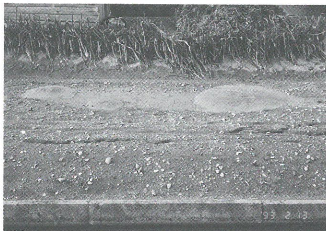
写真3.1 自然地盤と考えられる野々江町の噴砂
