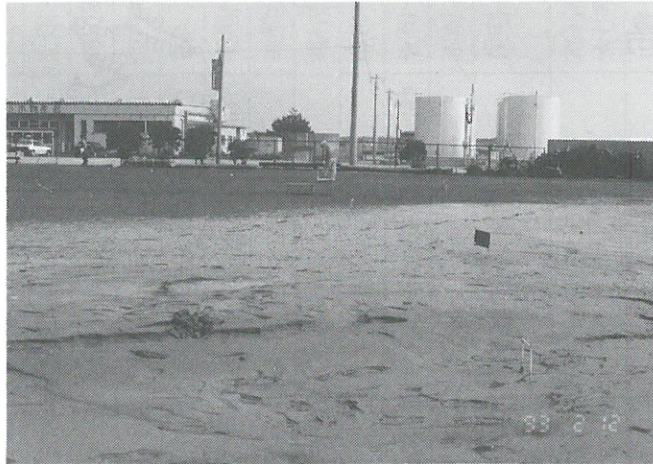
写真3.3 飯田港に隣接するゲートボール場の噴砂
