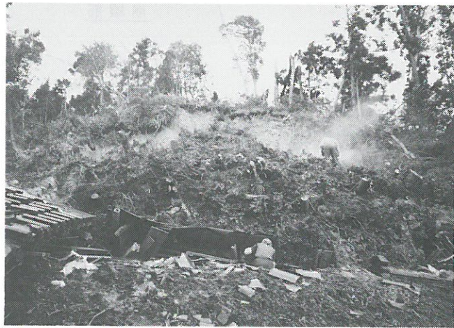
写真3.6 正院町飯塚の斜面崩壊状況
