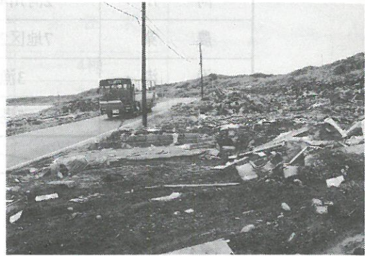
写真3.2 奥尻町初松前地区の津波被害 (Photo3.2 Tsunami Damage at Hatsumatsumae)
