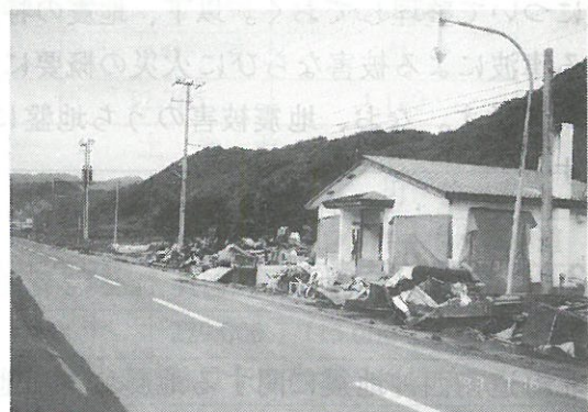
写真3.4 大成町平浜地区の津波被害 (Photo3.4 Tsunami Damage at Hirahama)
